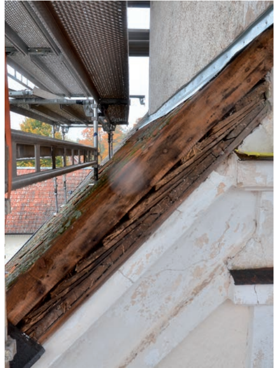
Bild 23. Spåntaket bakom den borttagna vindskivan på långhusets västra gavel. Foto 2021-10-06. SLM D2022-0087.
