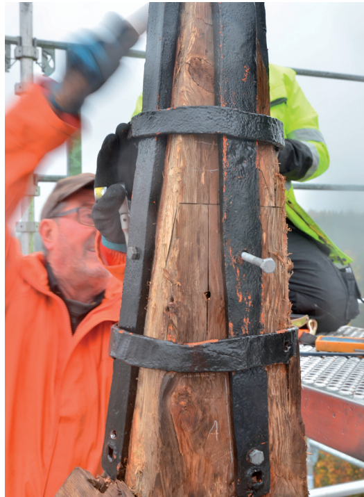
Bild 29. Spiran monteras tillbaka. Notera den nya järnarmen till vänster. Foto 2021-10-06. SLM D2022-0093.
