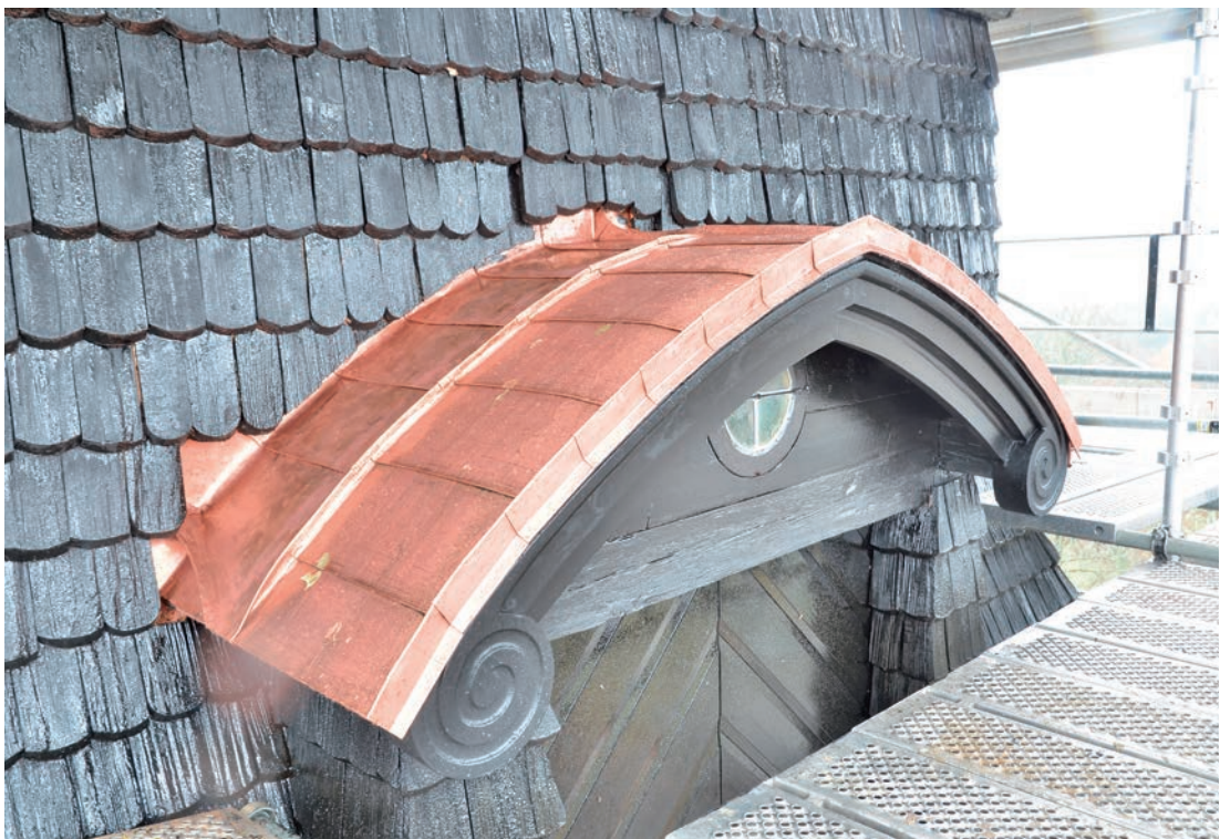
Bild 35. Takkupa och tornhuv efter renovering. Foto 2021-11-03. SLM D2022-0099.
