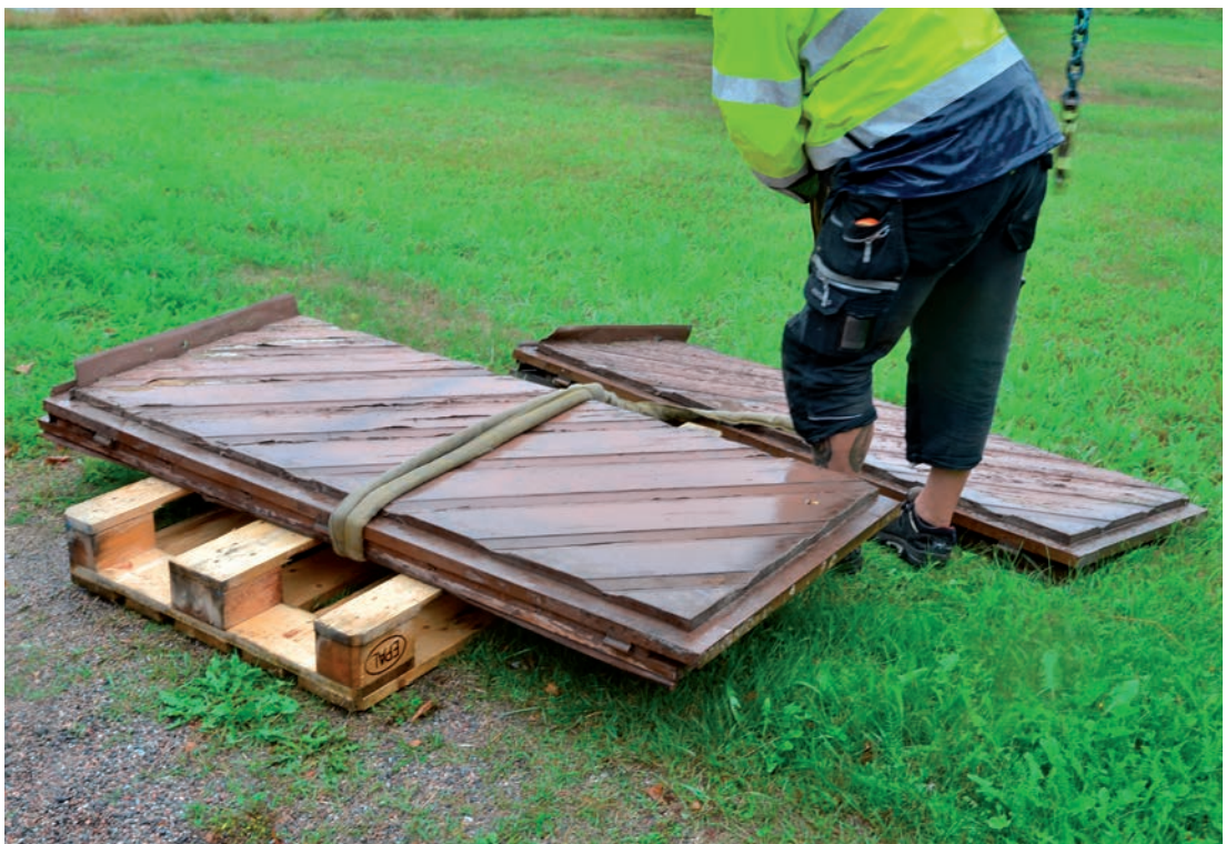
Bild 10. Befintliga ljudluckor togs ner med lyftkran och bedömdes senare vara i undermåligt skick, varför de byttes ut mot nya lika befintliga. Foto 2021-08-18. SLM D2022-0074.
