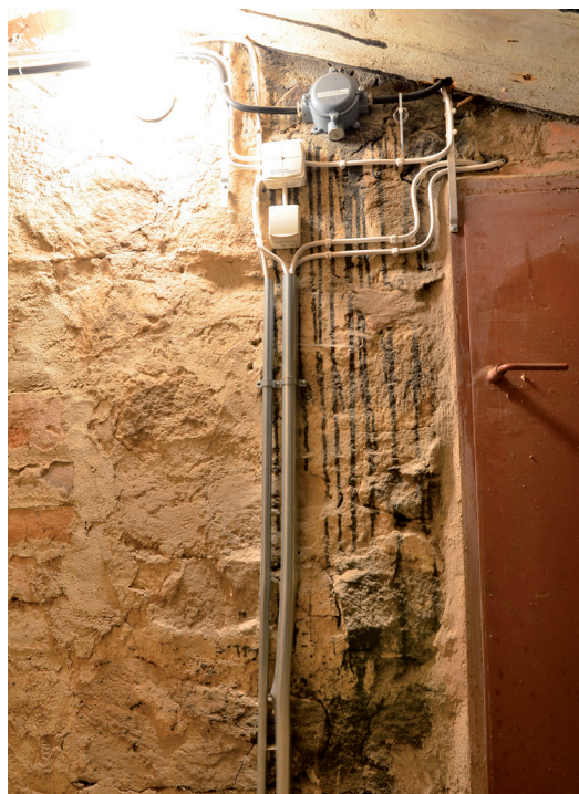
Bild 26. Kabeldragningar vid ingången till långhusvinden. Foto 2021-11-03. SLM D2022-0090.
