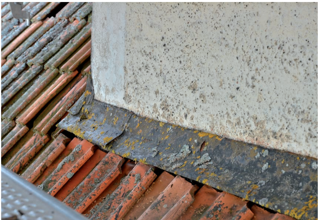
Bild 7. Ståndskivan vid fasad och takfall mot norr innan renovering. Foto 2021-08-24. SLM D2022-0071.
