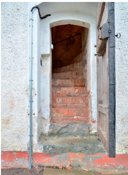
Bild 25. Kabeldragningarna vid torntrappans ingång efter renovering. Kabelskyddet bör målas in. Foto 2021-11-03. SLM D2022-0089.
