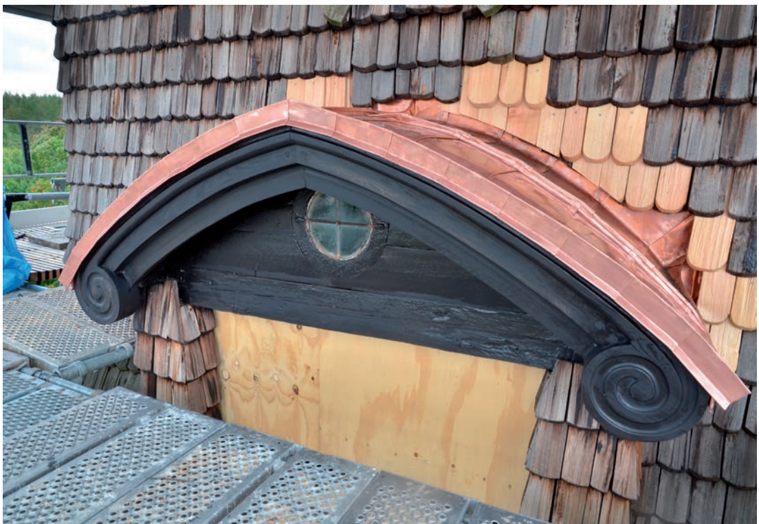
Bild 17. Takkupa och tornhuvens nedre del under pågående renovering. Foto 2021-09-16. SLM D2022-0081.
