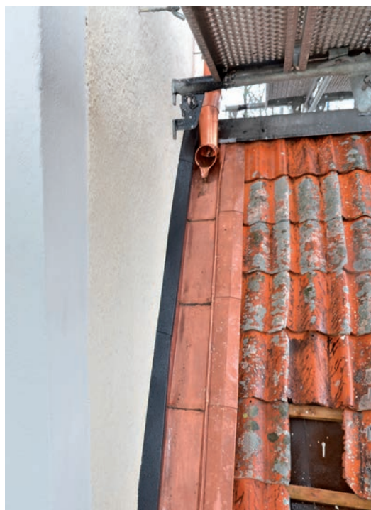
Bild 20. Stuprör, rännan och ståndskiva vid långhusets södra takfall efter avslutad renovering. Även fasaderna har renoverats. Foto 2021-11-03. SLM D2022-0084.
