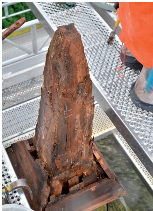
Bild 14. Timret för spirans infästning var i gott skick och täcktes över med takpapp och en kraftig sopsäck under tiden som arbetet pågick. Brädorna i bildens nederkant byttes ut till nya lika befintliga. SLM D2022-0078.
