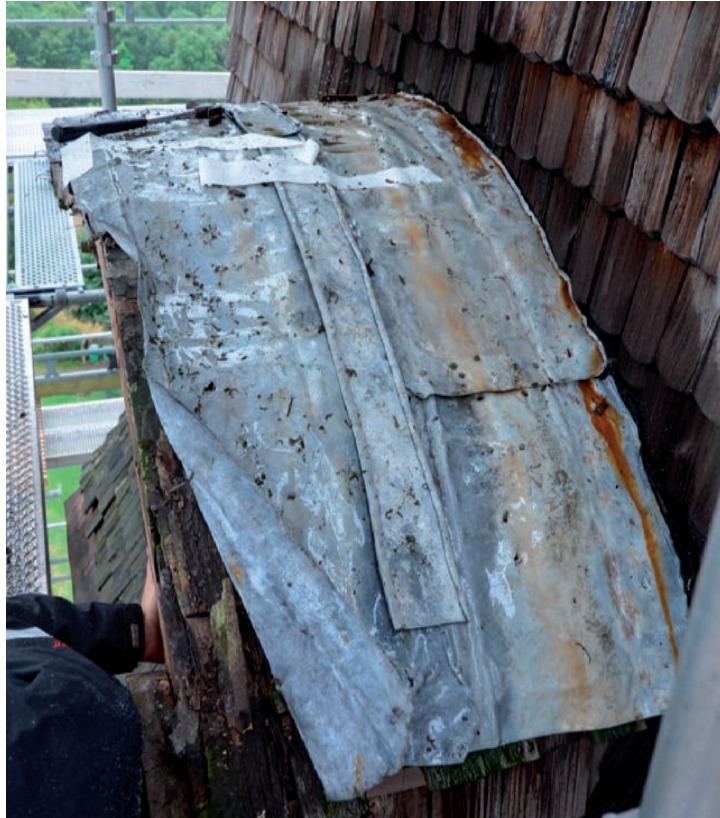
Bild 6. Takkupan mot öster innan renovering. Foto 2021-08-18. SLM D2022-0070.
