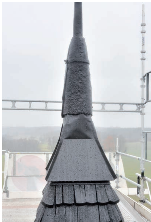
Bild 31. Spirans nederdel efter avslutad renovering. Plåten över takspånen är ny. Foto 2021-11-03. SLM D2022-0095.
