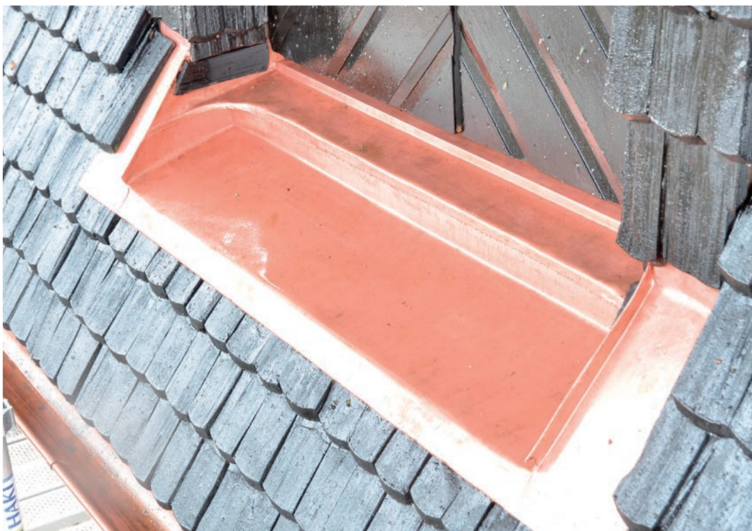
Bild 21. Kopparplåtbeklädd kupplatta efter avslutad renovering. Foto 2021-11-03. SLM D2022-0085.
