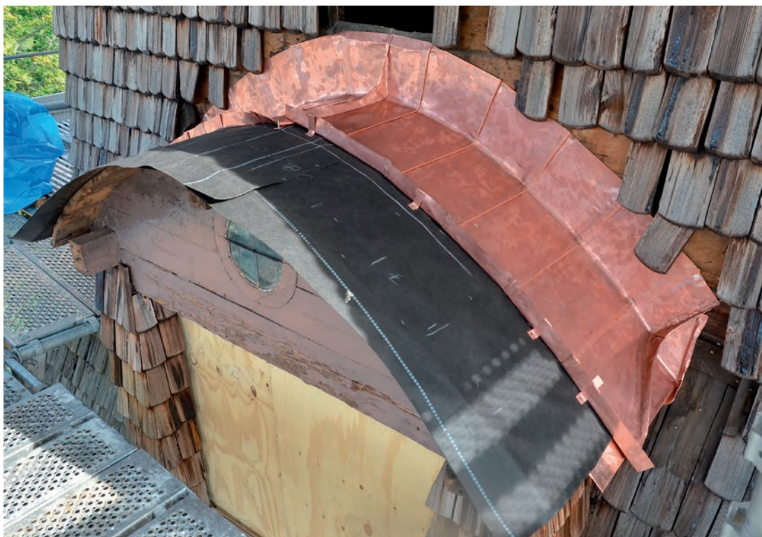
Bild 18. Takkupa och tornhuv under pågående renovering. Foto 2021-09-02. SLM D2022-0082.
