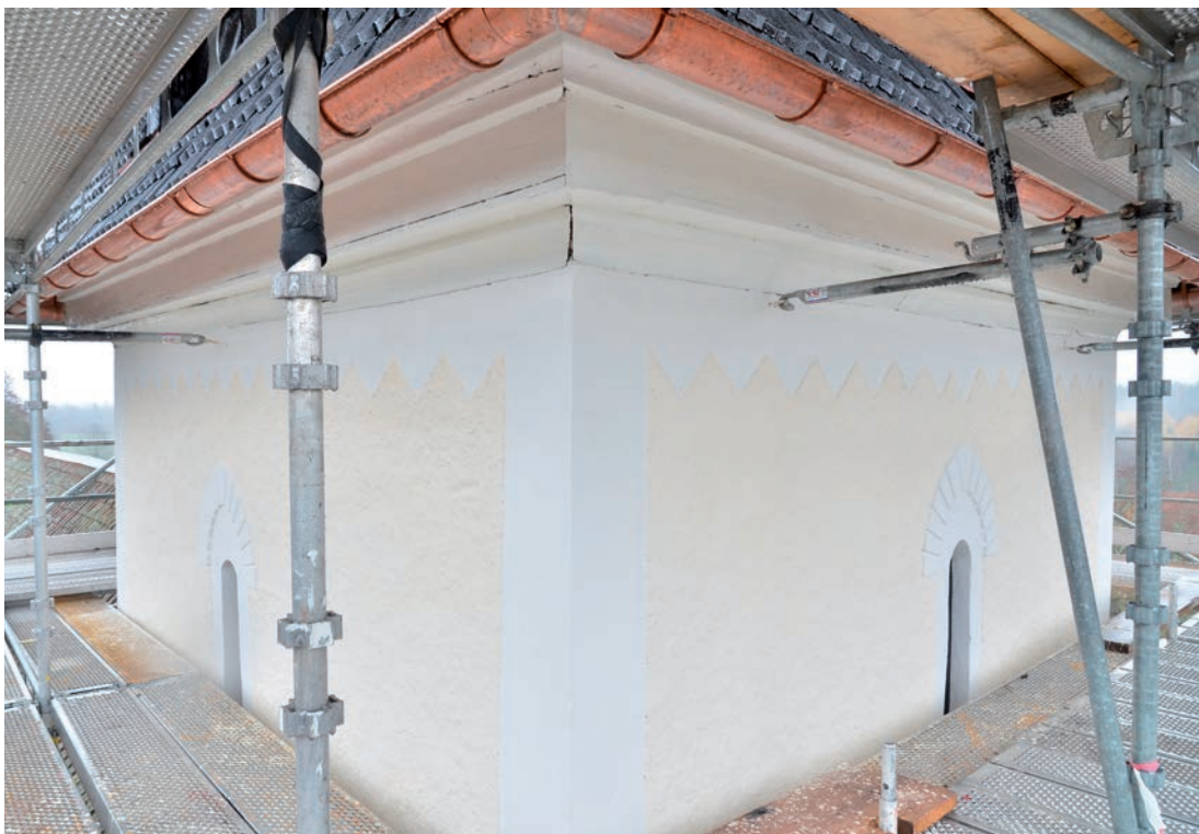
Bild 33. Tornets nordvästra fasader efter avslutad renovering. Foto 2021-11-03. SLM D2022-0097.
