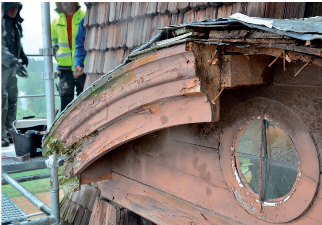
Bild 8. Takkupan mot öster innan renovering. Foto 2021-08-18. SLM D2022-0072.
