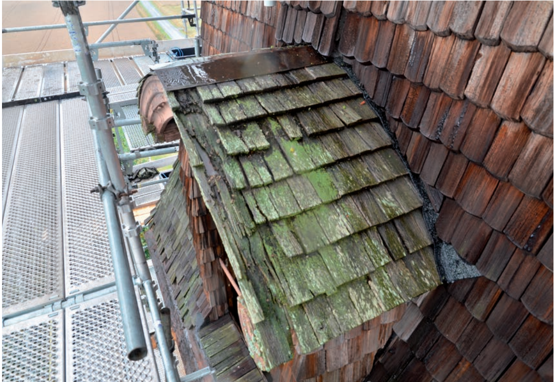
Bild 4. Södra takkupan innan renovering. Foto 2021-08-18. SLM D2022-0068.
