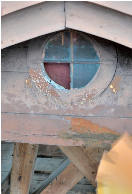
Bild 40. Äldre linoljefärgsskikt på takkupan mot norr. Foto 2021-08-18. SLM D2022-0104.
