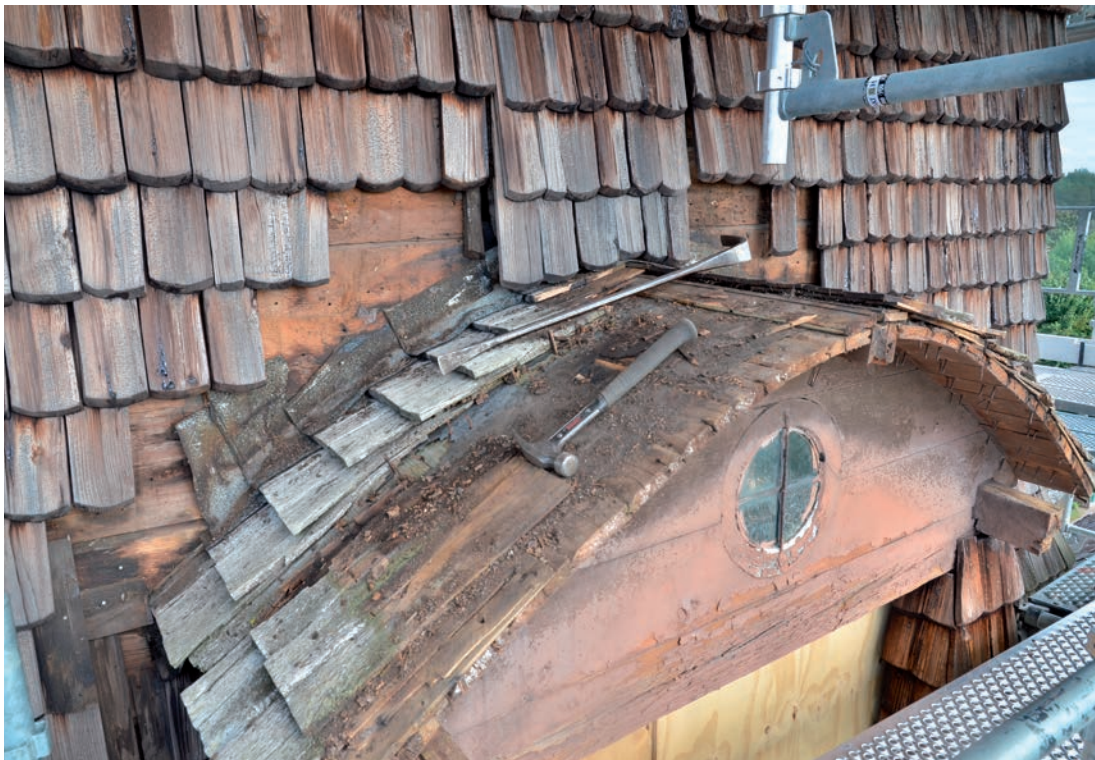
Bild 15. Takkupa och tornhuvens nedre del under pågående renovering. Foto 2021-08-24. SLM D2022-0079.
