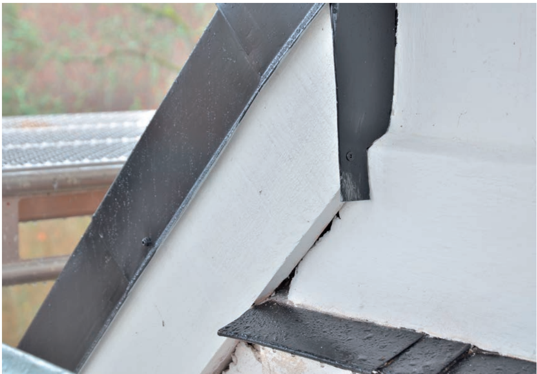
Bild 24. Vindskivan efter avslutad renovering. Foto 2021-11-03. SLM D2022-0088.
