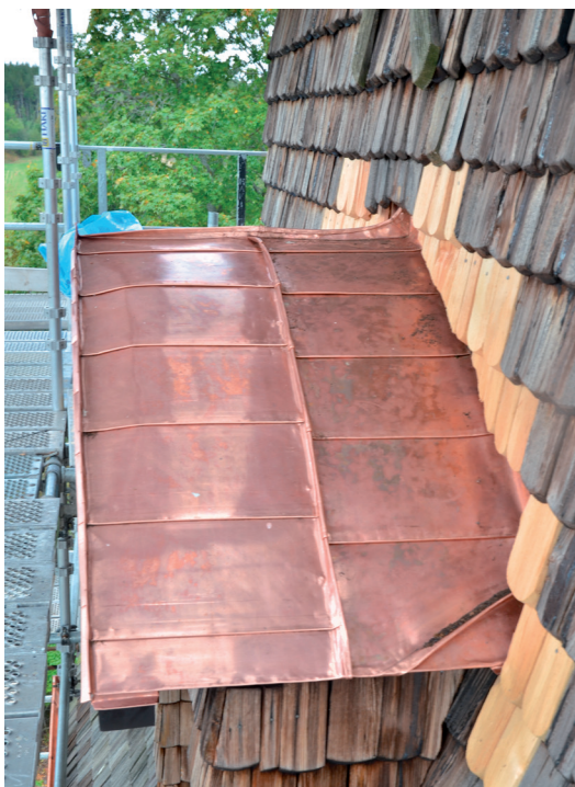
Bild 19. Takkupa och tornhuv under pågående renovering. Foto 2021-09-16. SLM D2022-0083.
