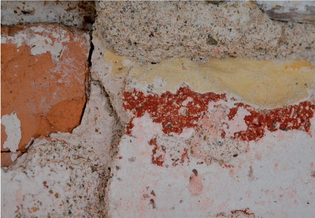
Bild 38. Gula och röda kalkfärgsrester under takfoten mot öster. Foto 2021-08-24. SLM D2022-0102.
