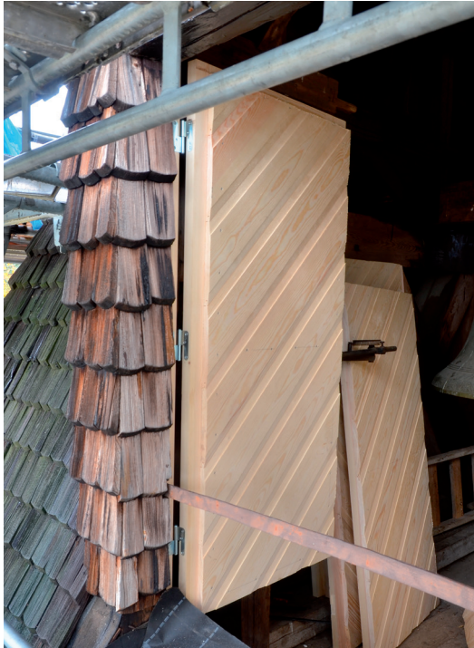
Bild 22. Nya ljudluckor under pågående montering. Foto 2021-10-06. SLM D2022-0086.
