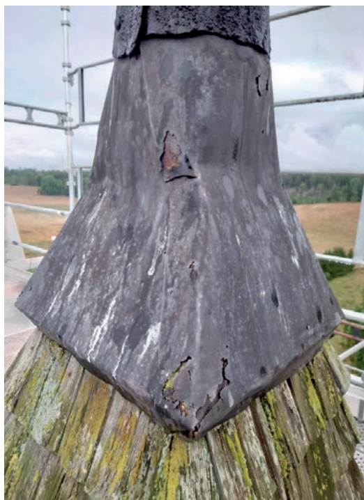
Bild 12. Tornspirans plåt över infästningen innan påbörjade arbeten. Foto av Annika Hugsén. SLM D2022-0076.
