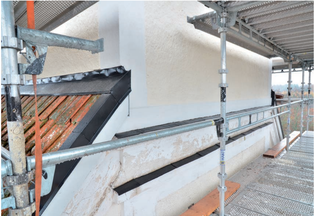
Bild 34. Efter avslutad renovering. Notera de något bredare ståndskivorna som ger bättre skydd över tegelpannorna, samt vindskivorna som är något smalare och mindre klumpiga än de föregående. Foto 2021-11-03. SLM D2022-0098.
