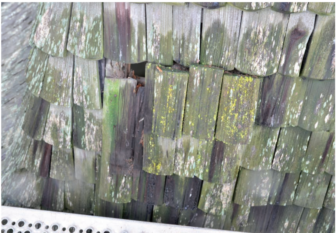
Bild 5. Tornhuvens övre del (fasad mot öster) innan renovering. Foto 2021-08-18. SLM D2022-0069.
