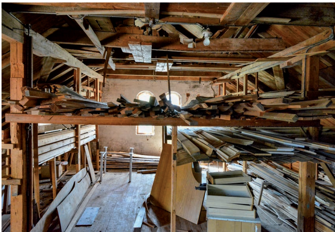
Fig 27. Vindsutrymmet på tegelbyggnaden sett mot den södra gaveln. Här sägs Zig-Zag-byggglådorna ursprungligen ha plockats ihop då de tillverkades i fabriken. (SLM D2019-0290)
