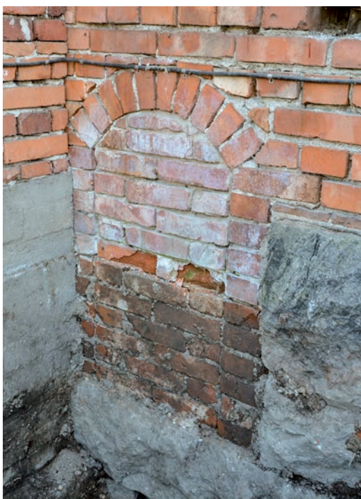
Fig 24. Igenmurad öppning i tegelbyggnadens västra mur. Möjligen har en av vattenrännorna gått in här till turbiner eller någon annan form av kraftöverföring som varit placerade inne i tegelbyggnaden. (SLM D2019-0287)
