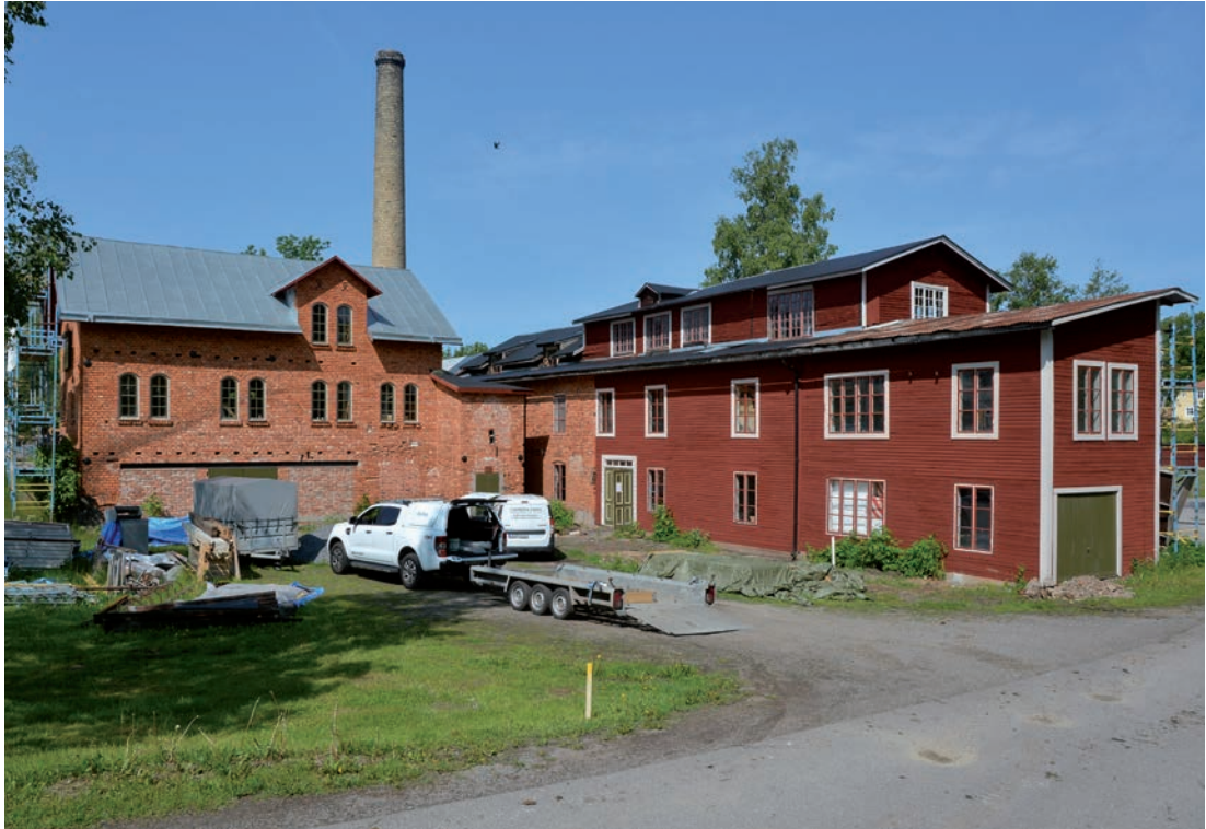
Fig 1. Foto av snickerifabriken i juni 2019 sedd från öster. Tegelbyggnaden syns till vänster och den röda byggnadslängan till höger. Bakom den senare löper Skebokvarnsån tätt intill husfasaden. (SLM D2019-0272)
