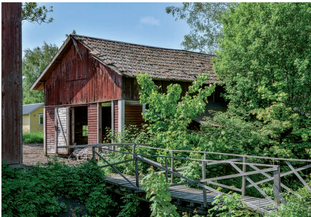
Fig 6. Den mindre fristående byggnaden väster om fabrikslängan sedd från norr. En gångbro av trä löper över ån. Det norra takfallet är täckt med tegel. Bakom vegetationen skymtar en tillbyggnad längs husets norra långsida. (SLM D2019-0277)
