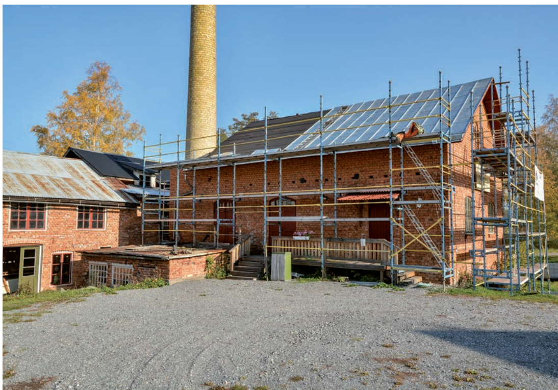
Fig 7. Tegelbyggnaden sedd från sydväst i oktober 2018. Till vänster syns den röda byggnadslängans tegelfasad och framför den, tegelbyggnadens lägre tillbyggnad som sannolikt inrymt en verkstad. (SLM D2019-0278)
