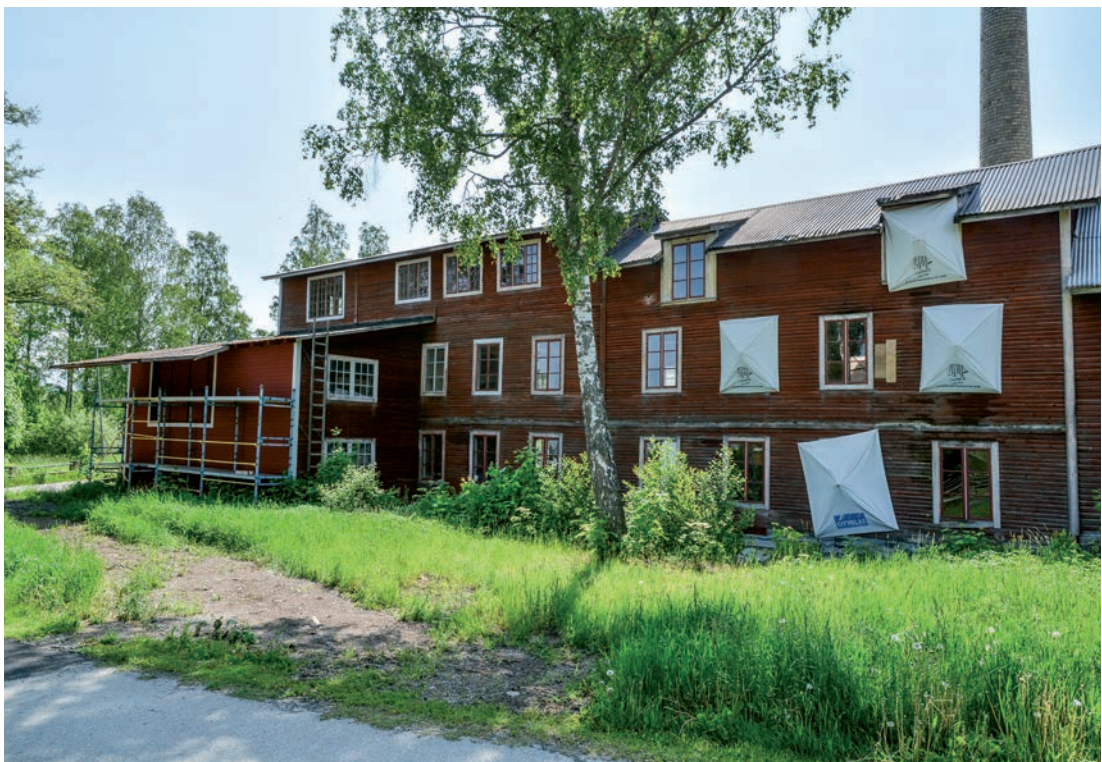
Fig 2. Röda byggnadslängans östra del sedd från norr. Ån löper längs med husfasaden och under den utskjutande tillbyggnaden till vänster. Den äldsta delen av fabriken är sannolikt den till vänster i bild. Denna del har byggts på med ytterligare en våning samt byggts till med den utskjutande delen. (SLM D2019-0273)
