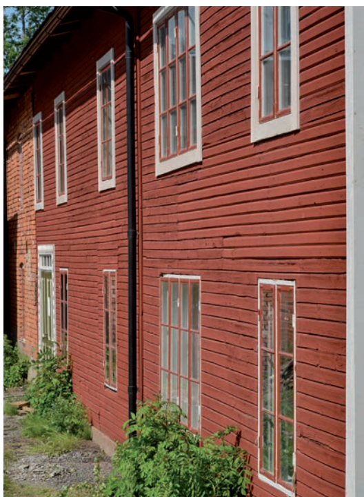
Fig 23. Fönster på röda byggnadslängans södra sida. Bottenvåningens fönster saknar här fönsteromfattningar vilket de tidigare haft. Notera att fönstren ligger i liv med fasaden. (SLM D2019-0286)
