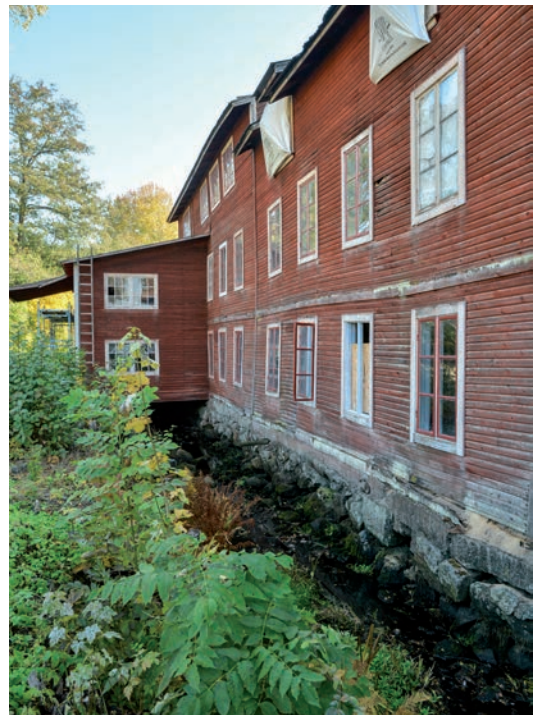
Fig 20. Skebokvarnsån vid röda byggnadslängans norra fasad i oktober 2018. (SLM D2019-0283)
