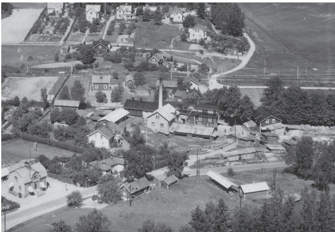
Fig 16. Flygfoto av Skebokvarn taget 1930 söderifrån där snickerifabriken syns i bildens mitt. Till höger om tegelbyggnaden med skorstenen syns sågverket med grått tak. Det revs omkring år 2000. Vid fototillfället har ännu inte hela röda byggnadslängan vid ån färdigställts. Byggnaden till höger i bild på andra sidan vägen tillhörde snickerifabriken och användes som lager. Denna är också riven. (SLM M008782)
