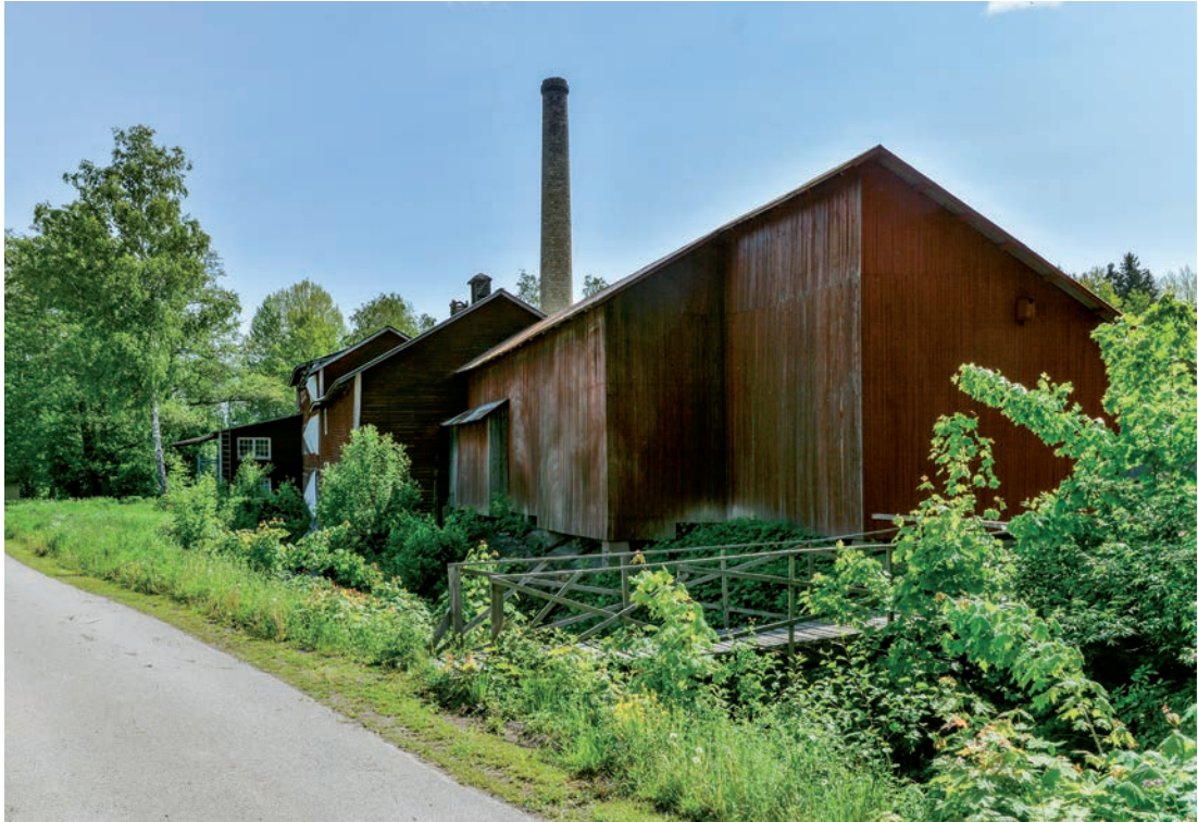
Fig 4. Röda byggnadslängans västra del sedd från nordväst. Här framträder byggnadernas industrikaraktär, där volymernas takform tillsammans med skorstenen utgör en tydlig siluett. (SLM D2019-0275)
