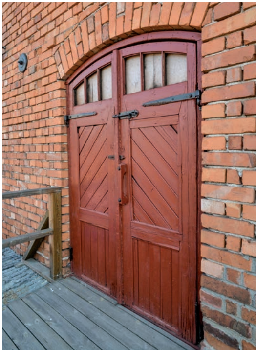
Fig 19. En port på tegelbyggnadens västra fasad. (SLM D2019-0282)
