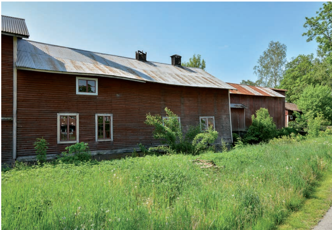
Fig 3. Röda byggnadslängans västra del sedd från norr. (SLM D2019-0274)
