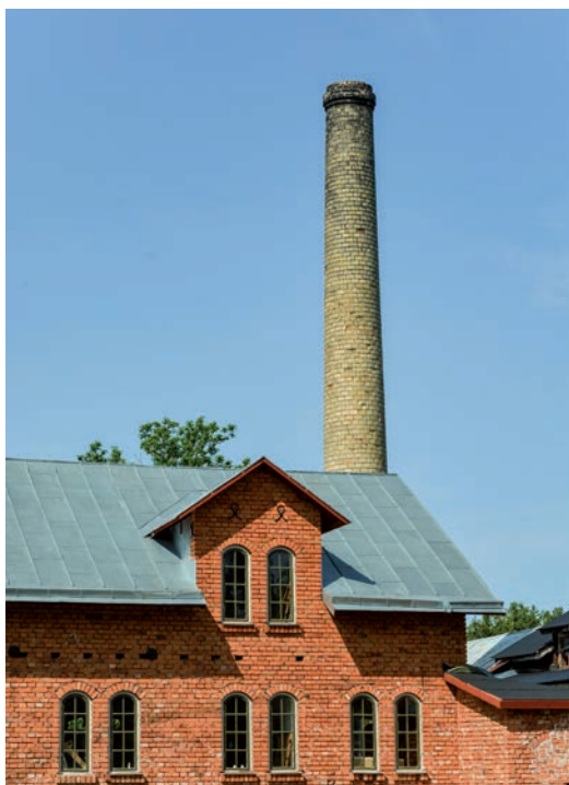
Fig 22. Skorstenen är till skillnad från tegelbyggnaden murad med gult tegel. Det kan bero på att den murats om vid något tillfälle. (SLM D2019-0285)
