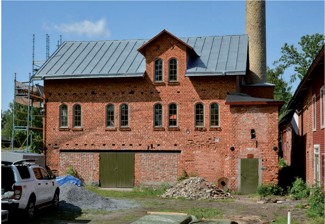
Fig 18. Tegelbyggnaden sedd från öster. Genom spår i fasaden kan man urskilja sågverkets takform vilket tidigare var byggt mot tegelbyggnaden. Den lägre utskjutande byggnadsdelen till höger innehåller ångpannan. Notera tegelväggen på röda byggnadslängan till höger, byggd som brandskydd mitt emot ångpannan. (SLM D2019-0281)
