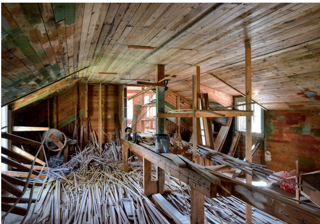
Fig 26. Interiörbild av röda byggnadslängans tredje våning sett mot öster. (SLM D2019-0289)
