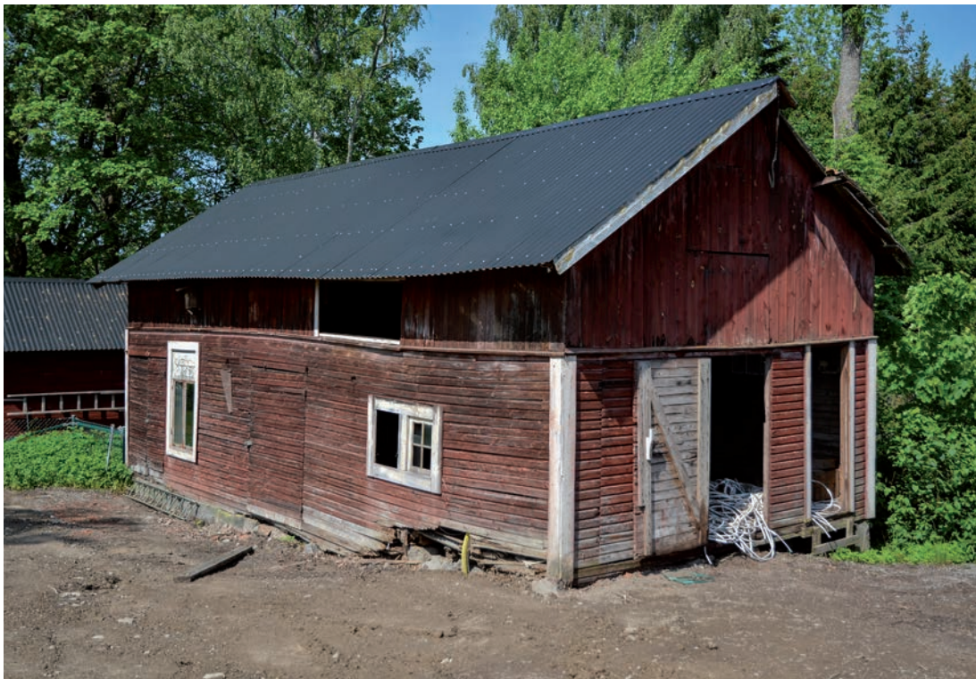
Fig 29. Den mindre friliggande byggnaden sedd från sydost. Tegeltaket har på denna sida ersatts av plåt. (SLM D2019-0292)
