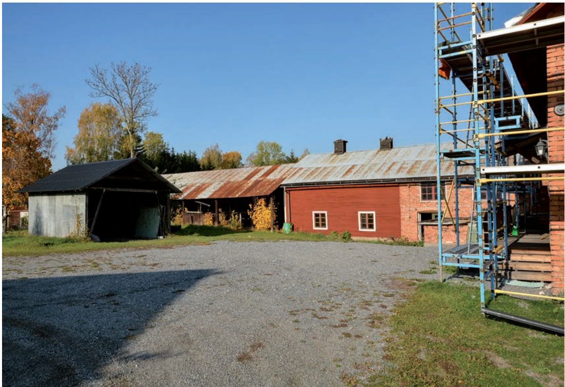
Fig 5. Snickerifabriken sedd söderifrån i oktober 2018 där tegelbyggnaden med byggnadsställningar skymtar till höger i bild. Till vänster är det plåtskjul som sannolikt är tillkommet under fabriken sista verksamhetsår. Bakom det syns den öppna delen som troligen fungerat som virkesupplag. Den rödfärgade delen i bildens mitt har två ventilationshuvor på taket. Till höger ansluter den murade väggen mitt emot tegelbyggnaden. (SLM D2019-0276)
