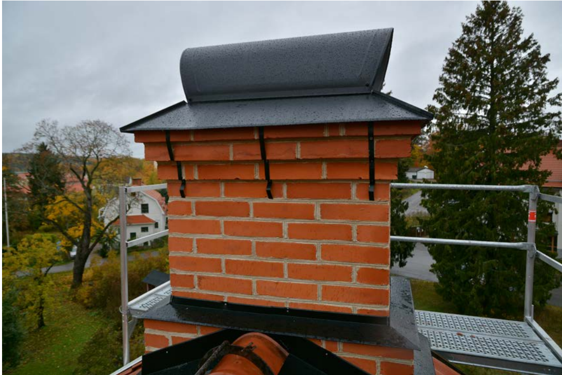
Västra skorstenen efter avslutat arbete. Förutom plåthuven har vattplåt och nederbeslag monterats och målats med anvisad färg. Foto 2019-10-15. SLM D2019-0496.
