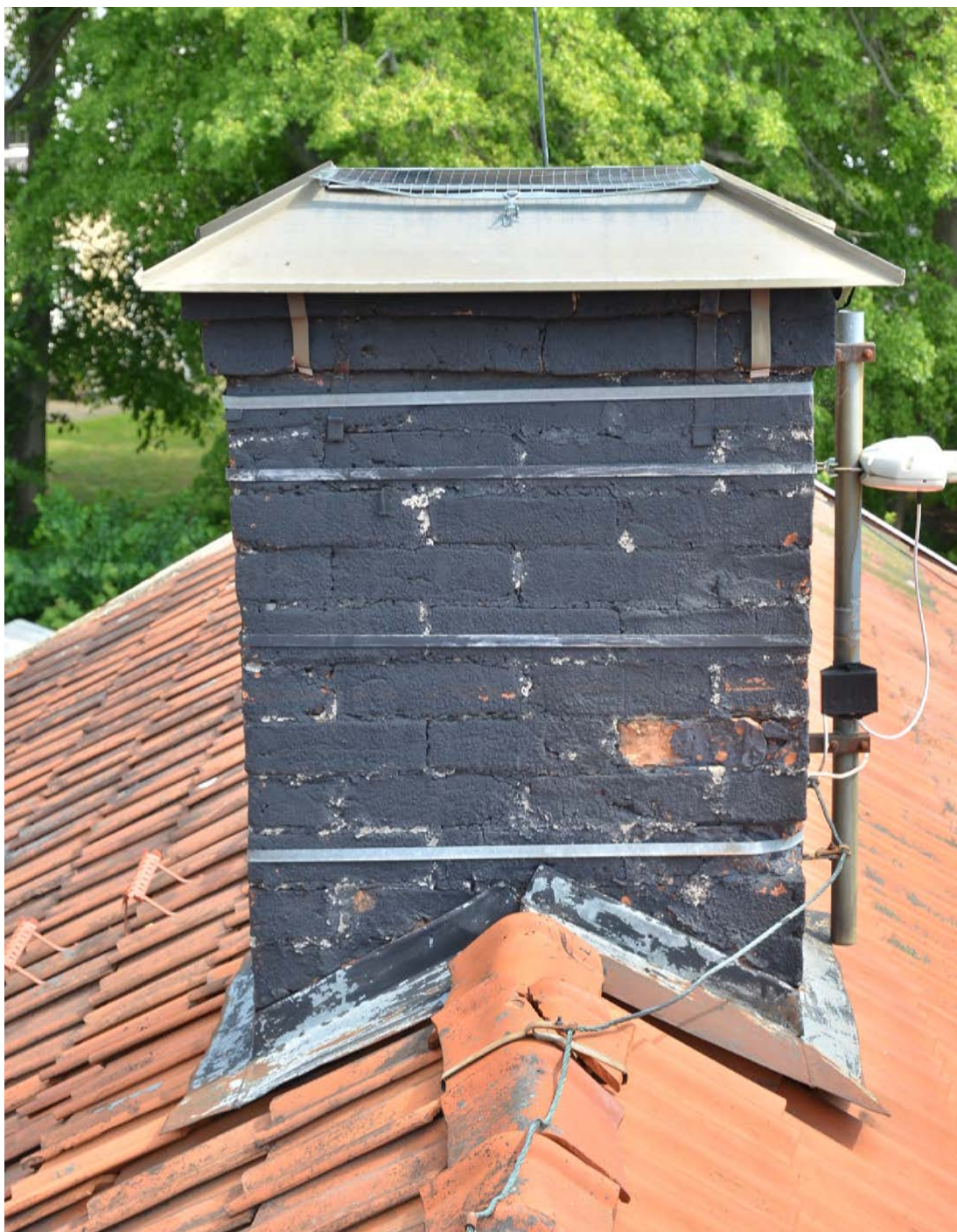
Östra skorstenen, vy mot öster. Foto 2019-06-03. SLM D2019-0493.
