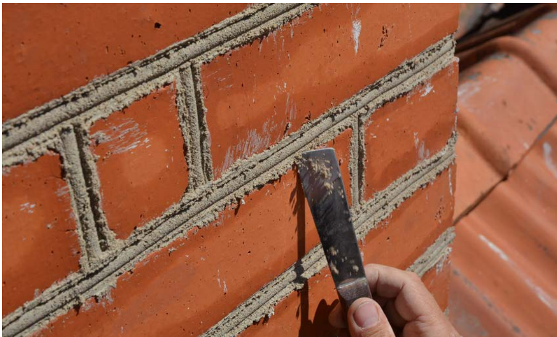
Mellersta skorstenen under pågående arbete. Foto 2019-07-03. SLM D2019-0494.
