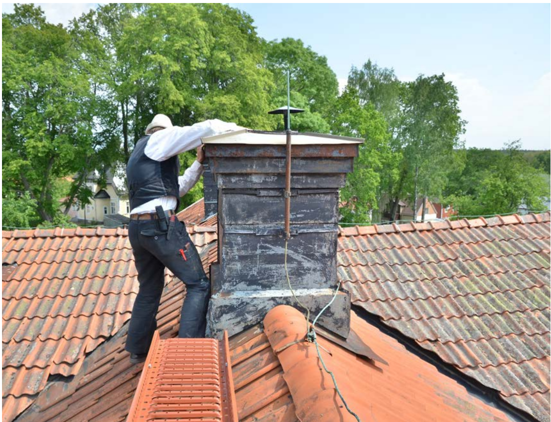
Mellersta skorstenen, vy mot öster. På bilden syns murare Johan Nordskott. Foto 2019-06-03. SLM D2019-0492.
