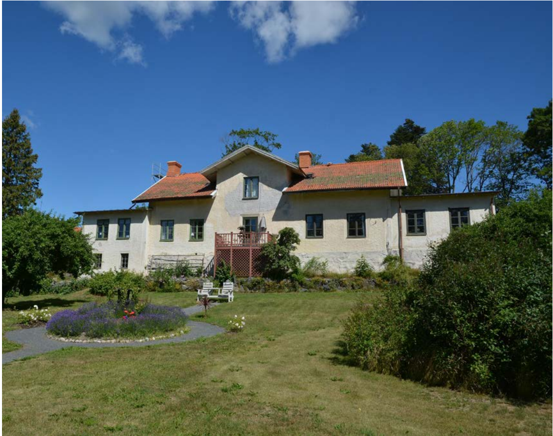
Huvudbyggnadens gårdsfasad, vy mot norr. Foto 2019-07-03. SLM D2019-0489.
