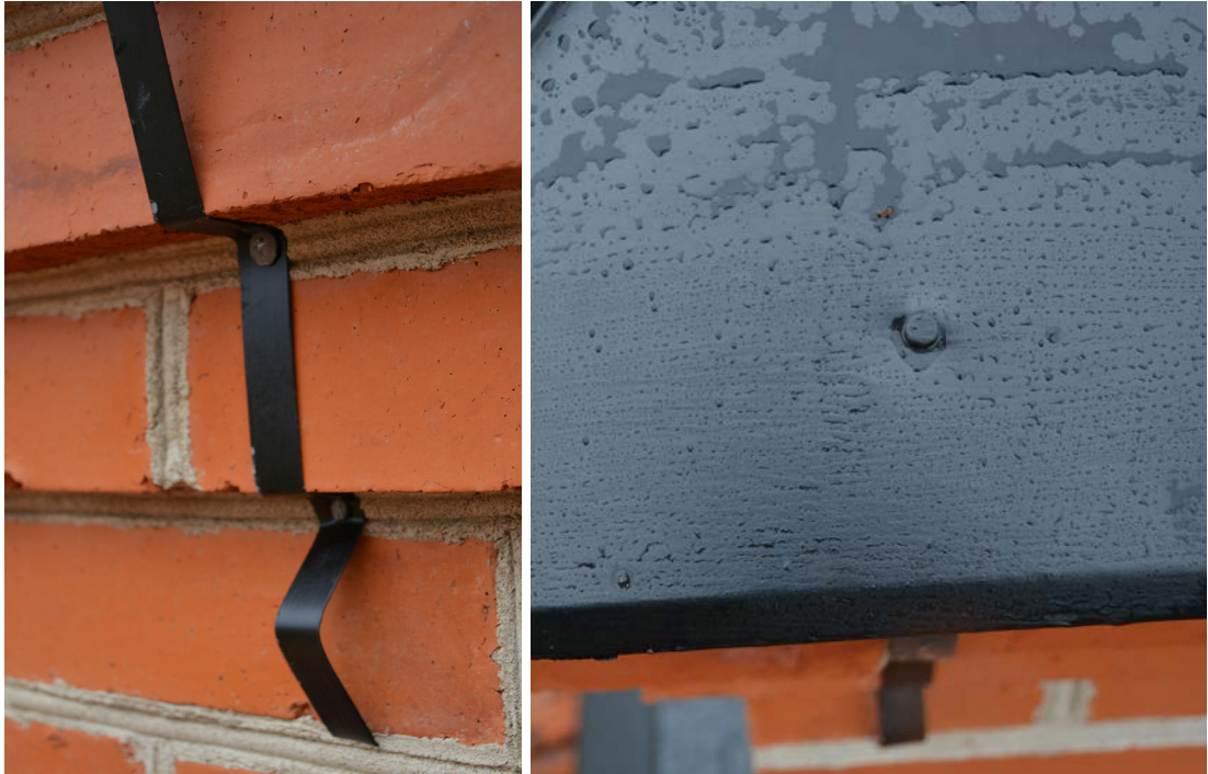
Plåtbeslagen fästes med klippspik i fogarna. Notera även penselstrukturen i den målade ytan. Foto 2019-10-15. SLM D2019-0498 och SLM D2019-503.
