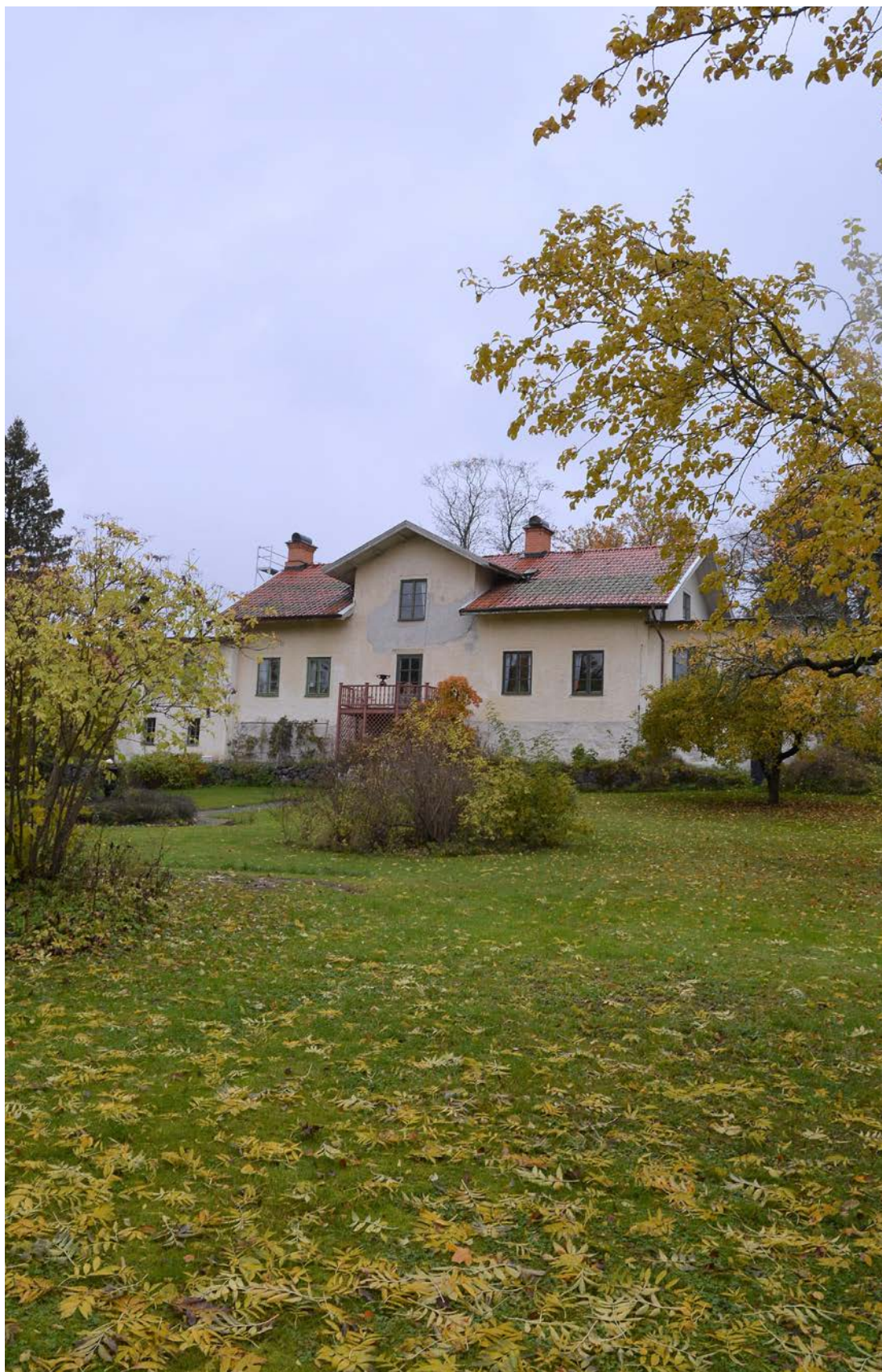
Huvudbyggnadens gårdsfasad, efter avslutade arbeten. Foto 2019-10-15. SLM D2019-0502.
