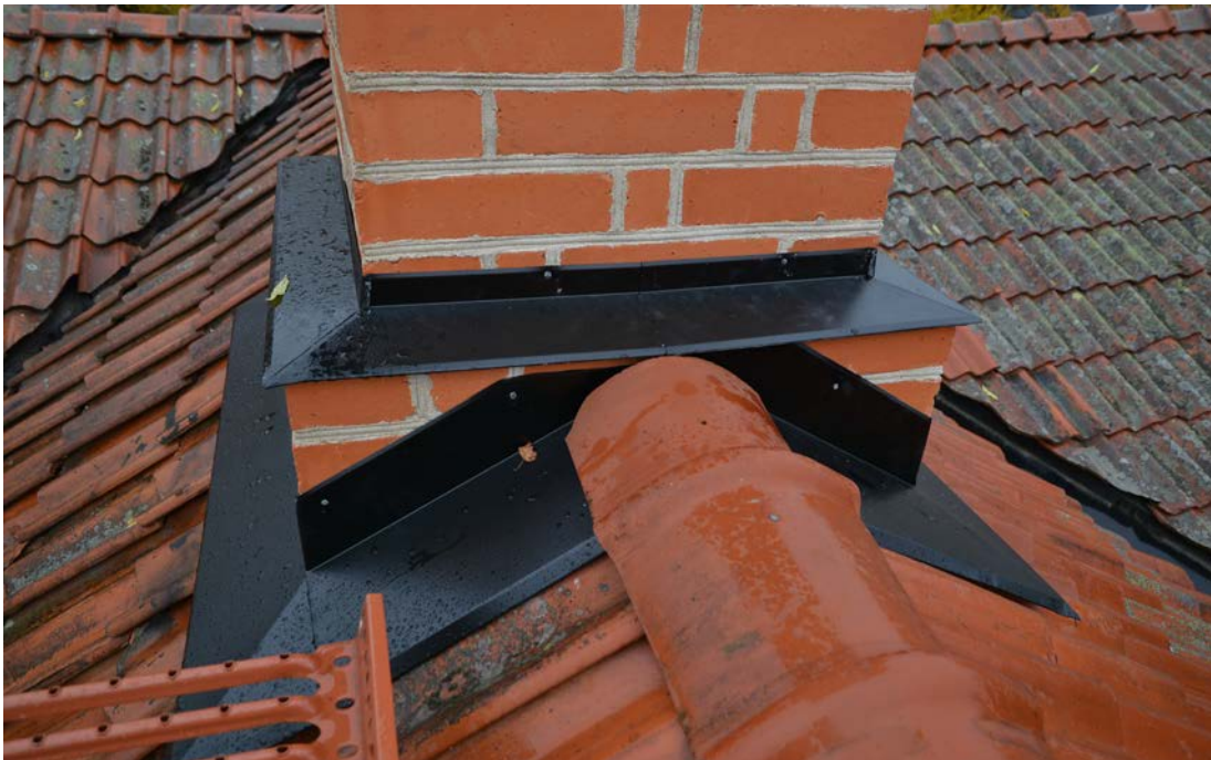
Mellersta skorstenen med nya plåtbeslag efter avslutat arbete. Foto 2019-10-15. SLM D2019-0497.
