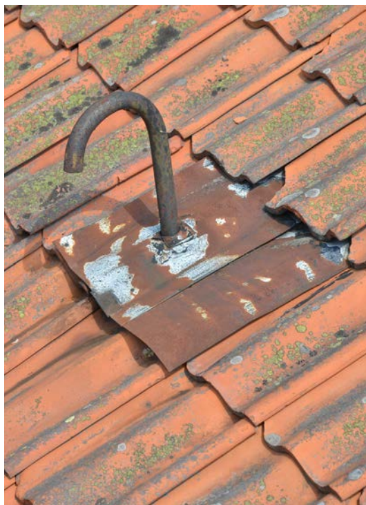
Bilden till vänster (SLM D2019-0500, foto 2019-06-03) visar luftningsröret som avlägsnades och ersattes med tegelpannor lika befintliga. Bilden till höger (SLM D2019-0501, foto 2019-10-15) visar mellersta skorstenen efter avslutat arbete.
