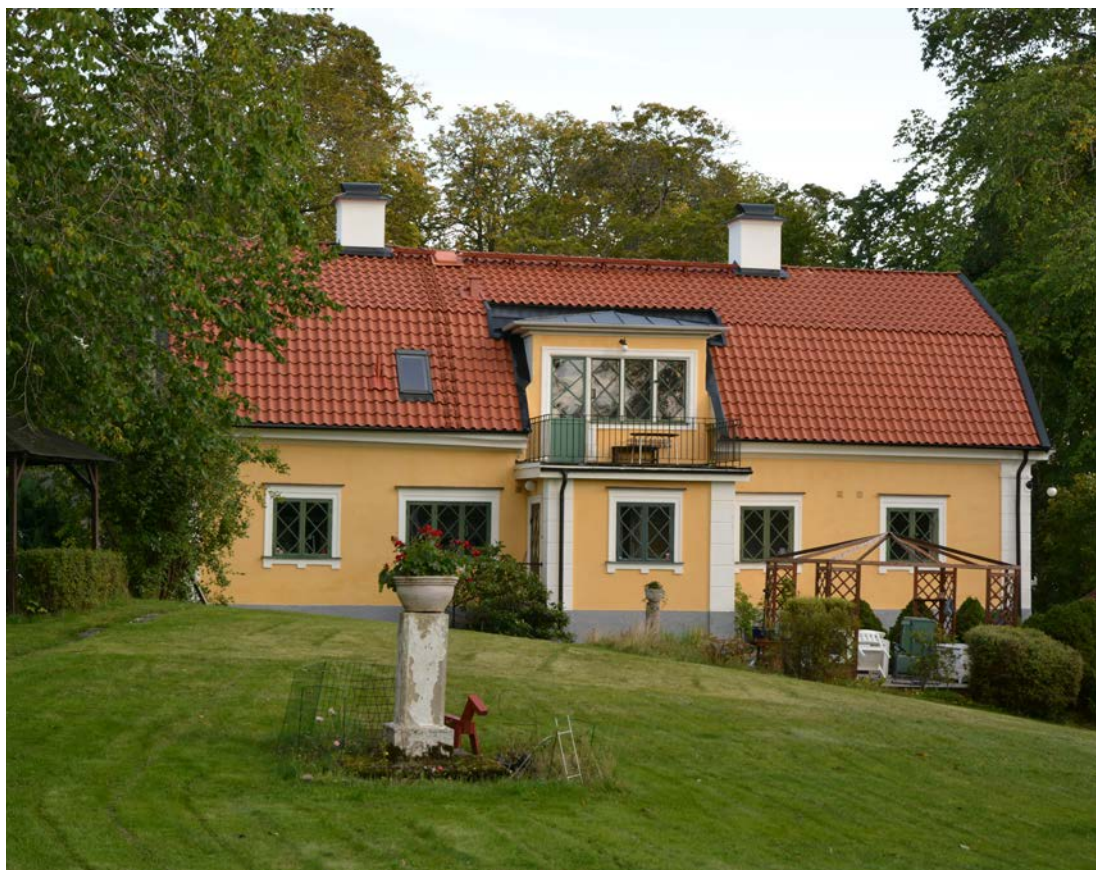
Norra takfallet efter avslutade arbeten. Mellan skorstenarna syns den nya gångbron och den rödmålade takluckan som tidigare var svart. Foto 2019-09-17 (SLM D2019-0443).
