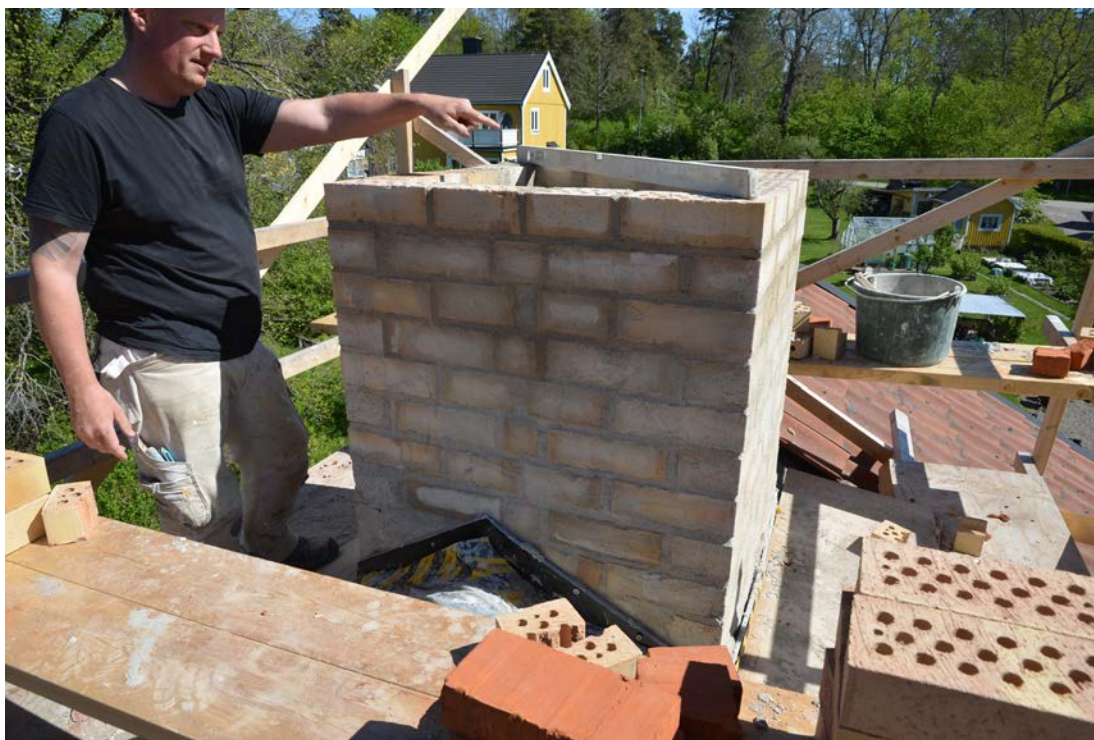
Östra skorstenen under pågående ommurning. Foto 2019-05-16 (SLM D2019-0460).
