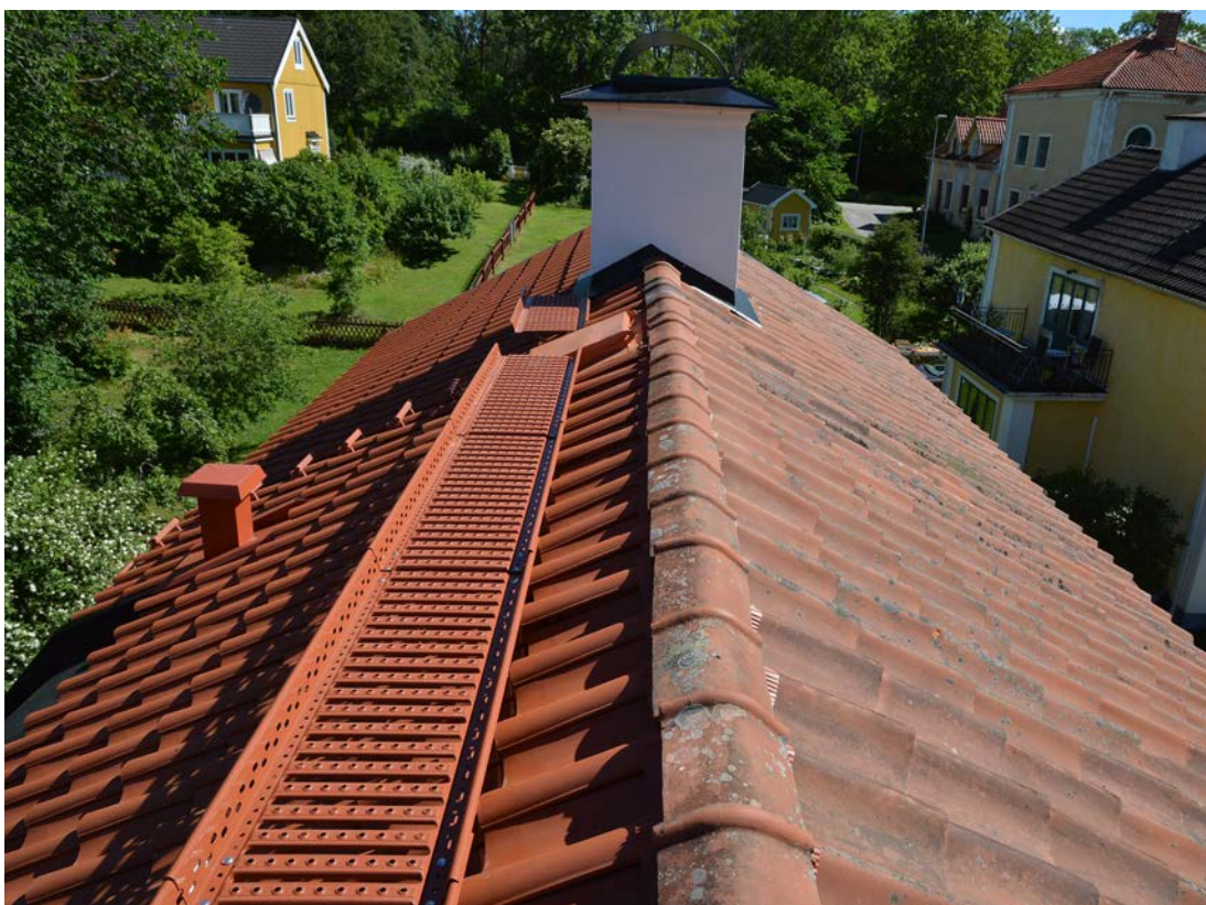
Norra takfallet (vänster i bild) med nytt tegel samt ny gångbro i röd plåt. På det södra takfallet ligger äldre enkupigt tegel. De äldre nockpannorna bevarades. Foto 2019-07-03 (SLM D2019-0440).
