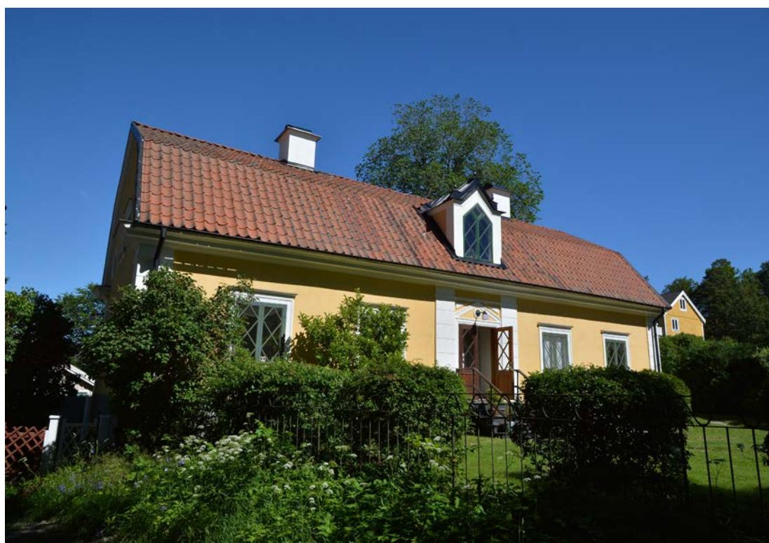
Södra takfallet efter avslutade arbeten. Foto 2019-07-03 (SLM D2019-0444).
