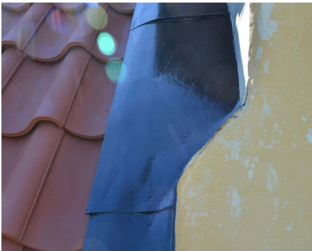
Rostiga plåtar (här kringtäckning vid norra takkupan) borstades och penselmålades med svart rostskyddsfärg. Foto 2019-07-03 (SLM D2019-0451).
