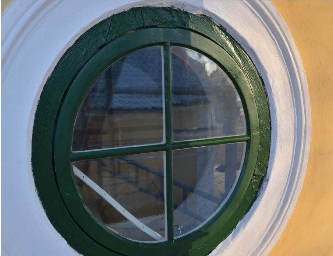
Södra rundfönstret på västra gaveln efter renovering. Foto 2018-11-28 (SLM D2019-0454).
