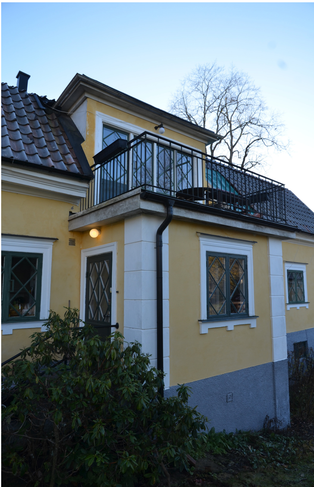
Östra flygelns norra fasad med entréutbyggnaden och balkong innan renovering. Foto Kjell Taawo 2018-11-08 (SLM D2019-0425).
