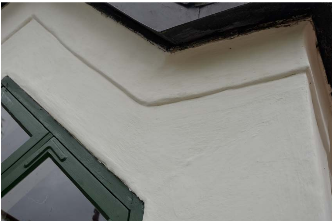
Närbild av putsens ytstruktur på södra takkupan efter avslutad avfärgning med silikatfärg. Foto 2019-05-27 (SLM D2019-0465).
