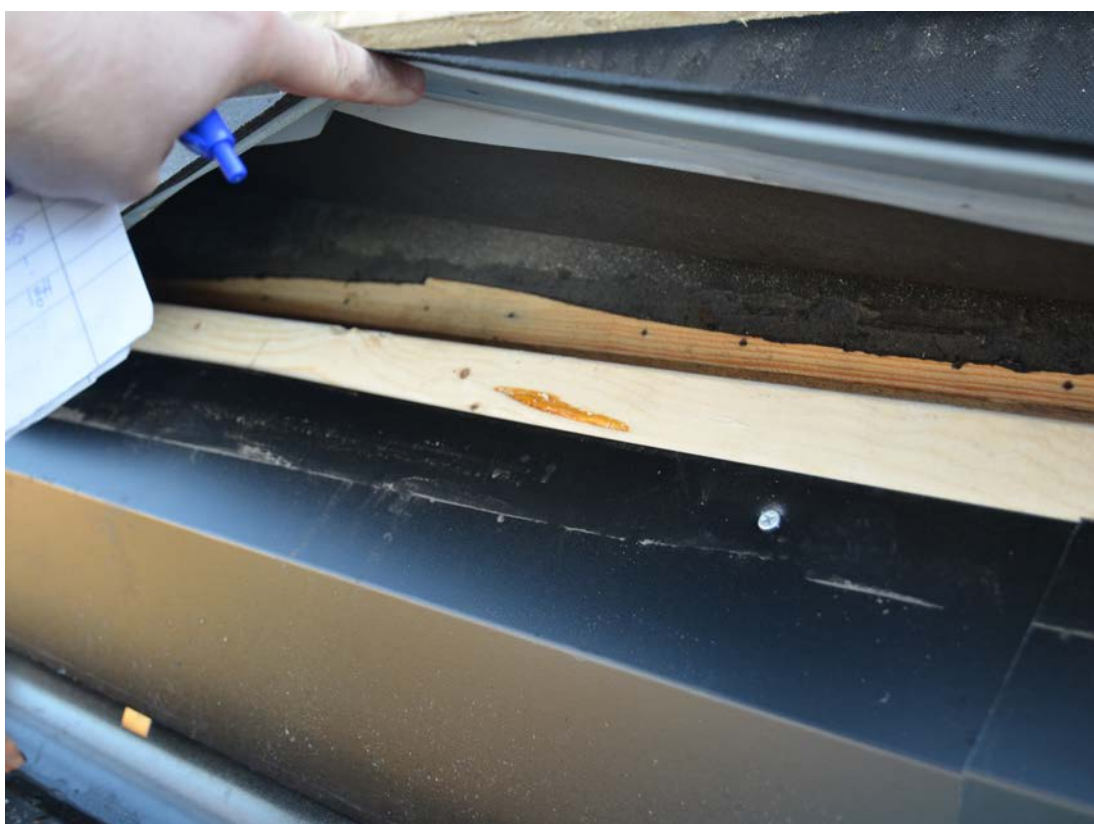
Nedan i bild syns den nya fotplåten i fabrikslackerad svart plåt. Under takduken syns tjärpappen. Foto 2018-11-01 (SLM D2019-0447).
