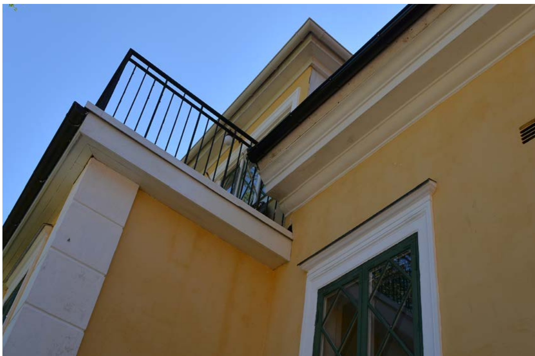
Takgesims och takfotsinbrädning efter avslutade putsilagningar och ommålning, jämför med bild på sidan 14. Foto 2019-07-03 (SLM D2019-0468).
