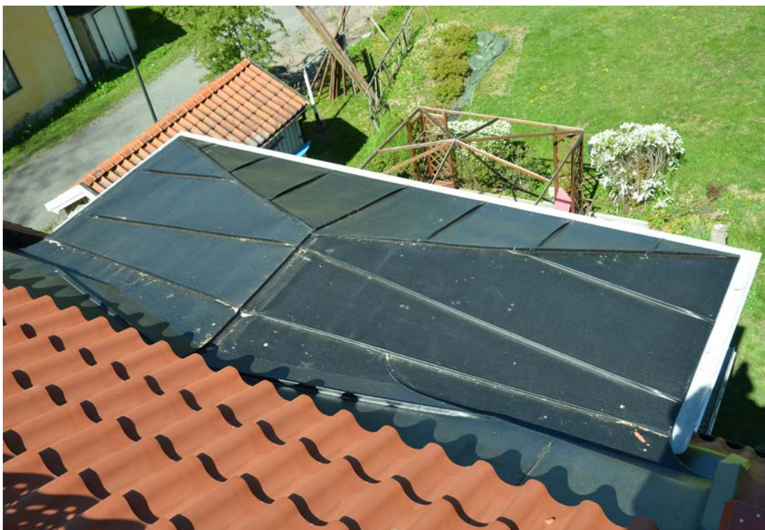
Norra takkupan efter avslutat arbete. Foto 2019-05-16 (SLM D2019-0452).
