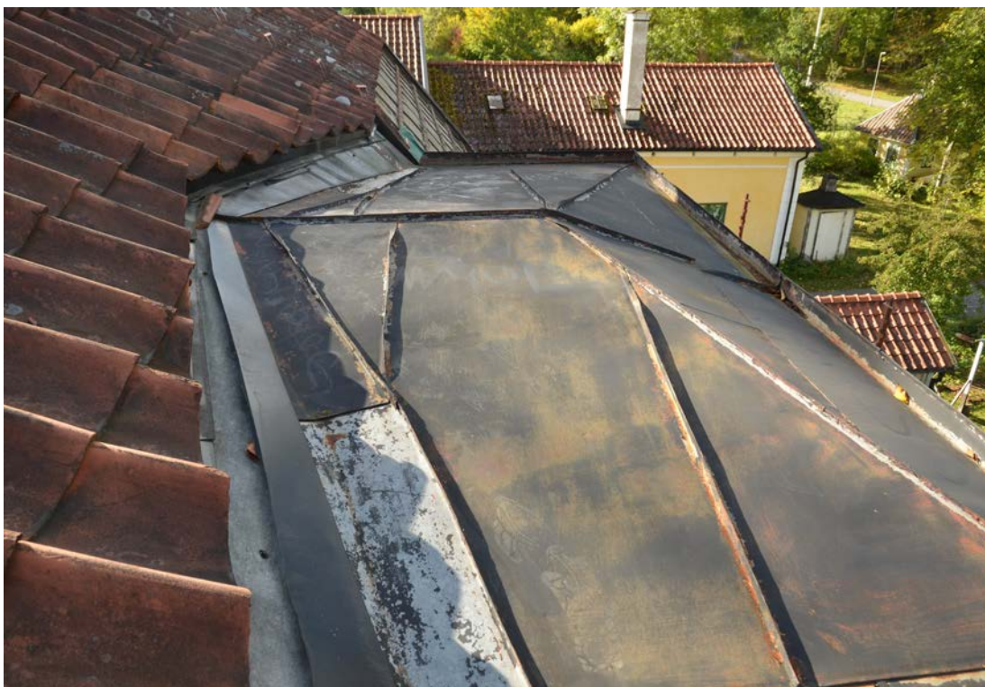
Norra takkupan. Foto 2018-10-03 (SLM D2019-0432).
