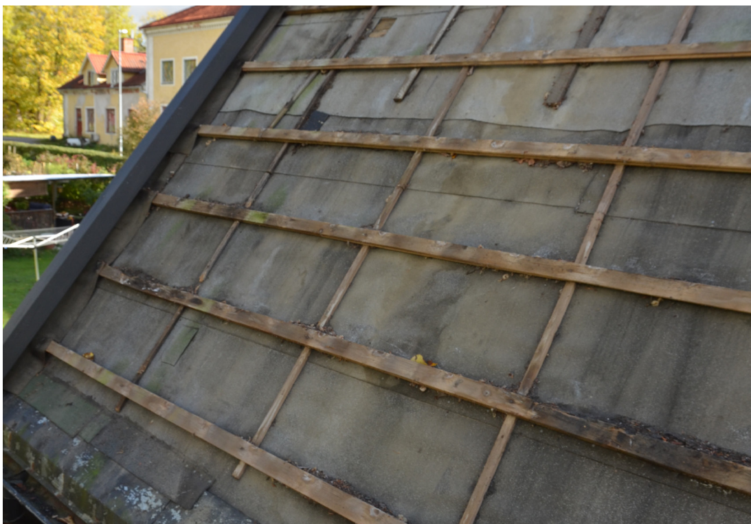
Norra takfallets östra del efter att tegelpannorna plockats ned. Foto 2018-10-03 (SLM D2019-0427).
