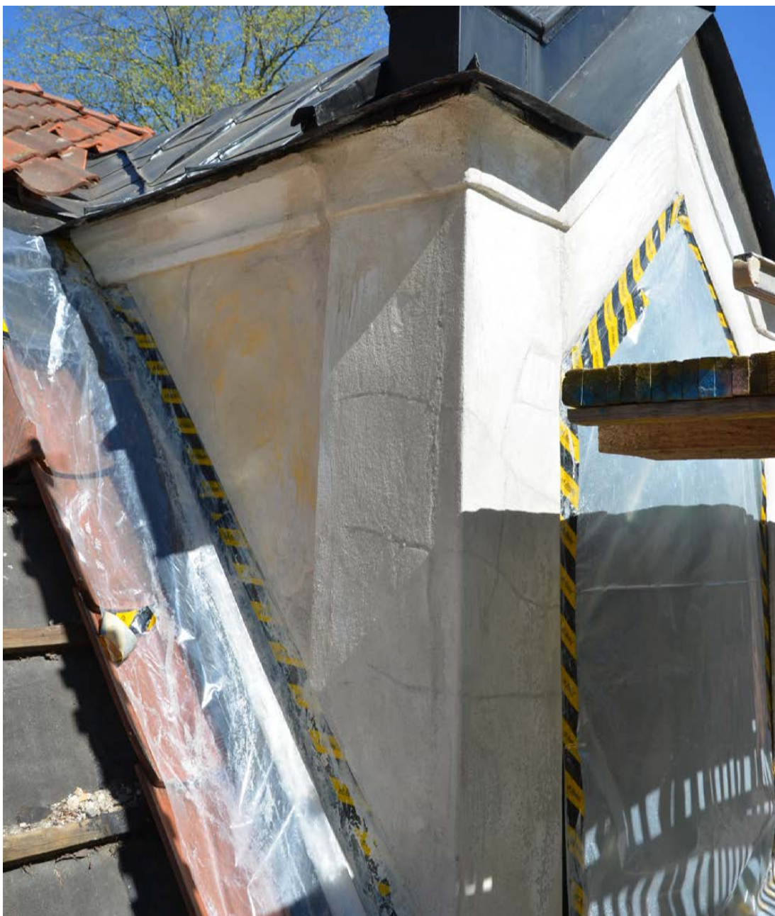
Södra takkupan under pågående renovering. Sprickor högs upp och fogades med nytt bruk innan avfärgning med kalkfärg. Foto 2019-05-15 (SLM D2019-0464).
