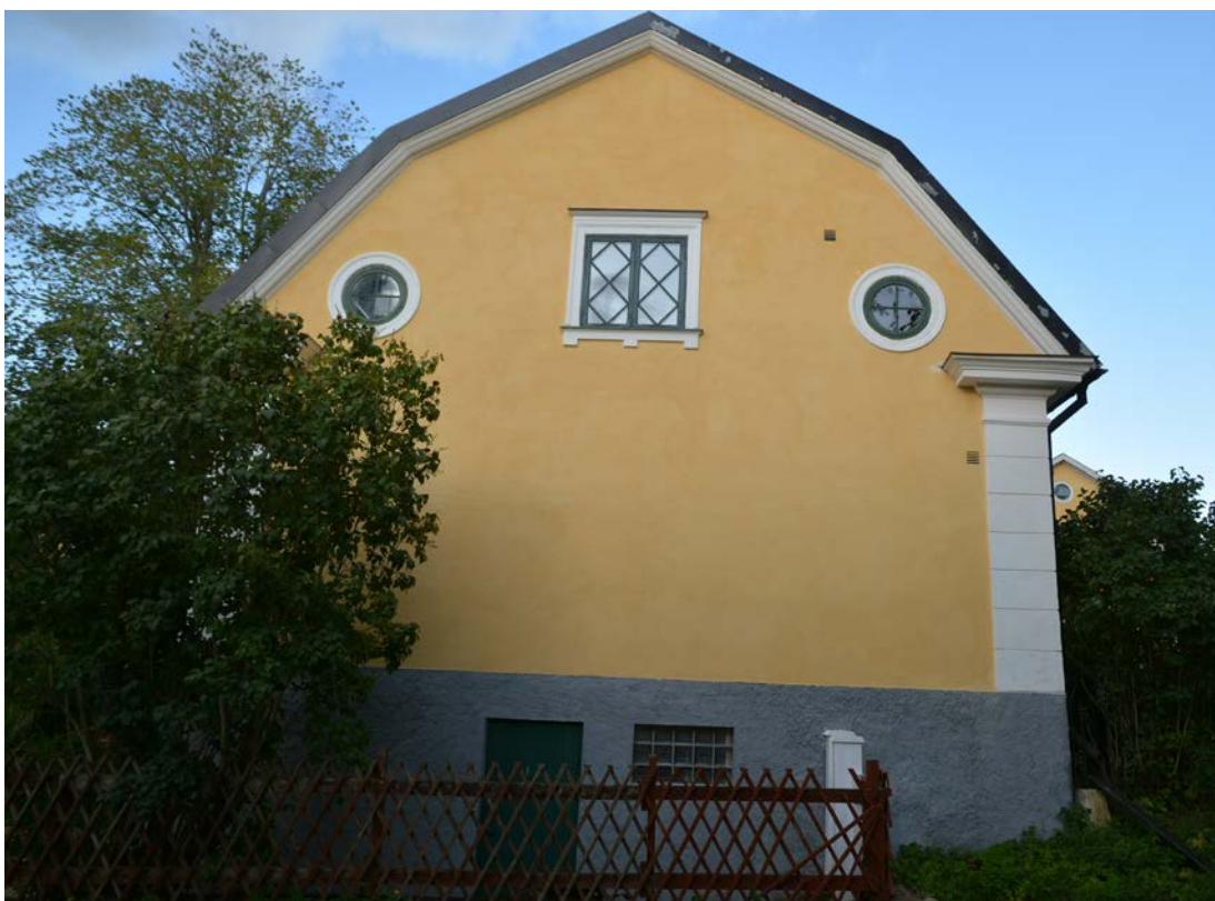
Östra flygelns västra gavel efter avslutade arbeten. Foto 2019-09-17 (SLM D2019-0422).
