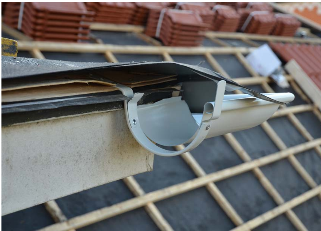
Den nya hänggrännan i vit plåt. Foto 2018-11-01 (SLM D2019-0446).
