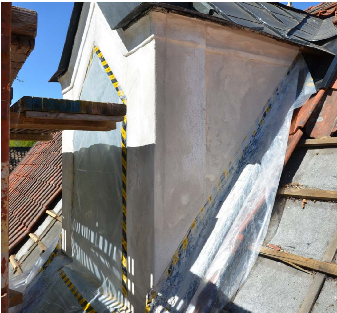
Södra takkupan under pågående renovering. Till höger i bilden syns rötskadad läkt och underlagstak som senare lagades. Foto 2019-05-15 (SLM D2019-0463).
