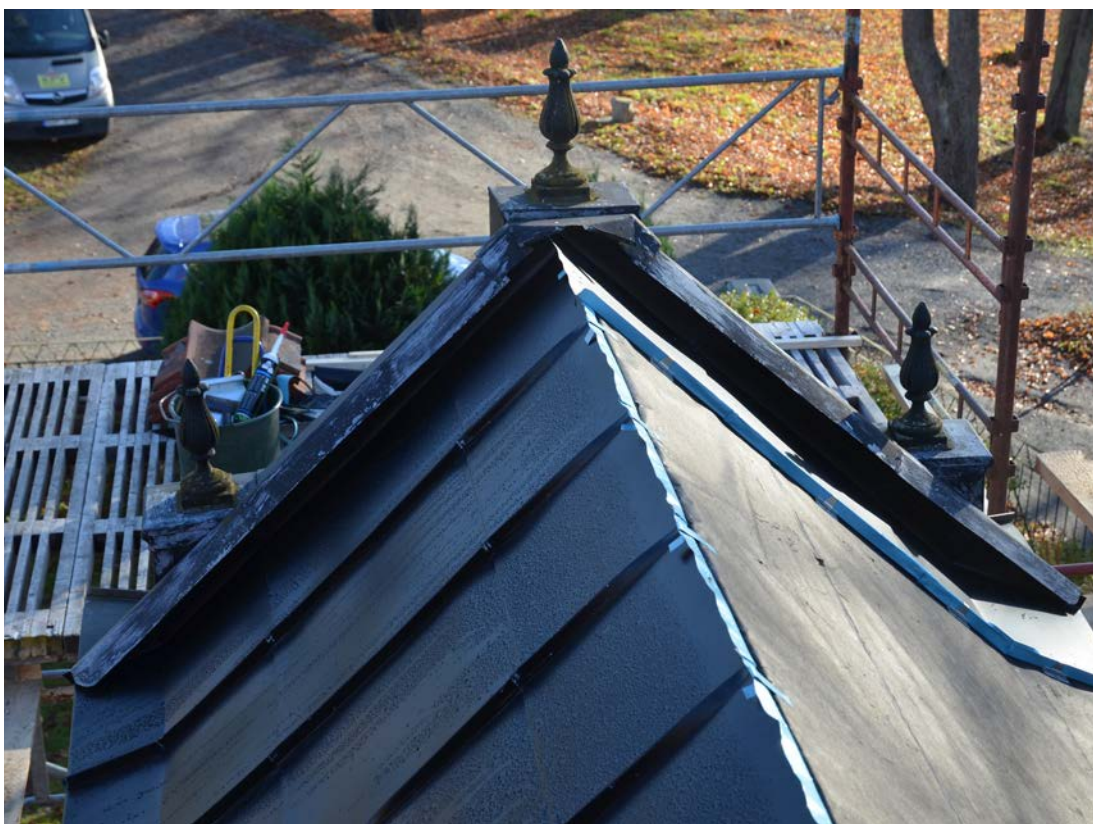
Södra takkupan under pågående renovering. Foto 2018-11-03 (SLM D2019-0449).
