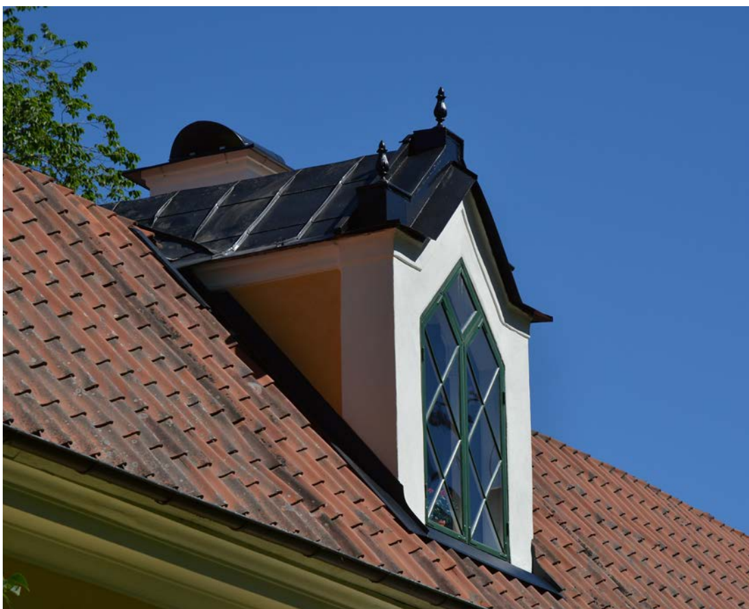
Södra takkupan efter avslutat arbete. Gavelkrönet och fialerna har målats med svart rostskyddsfärg. Foto 2019-07-03 (SLM D2019-0453).
