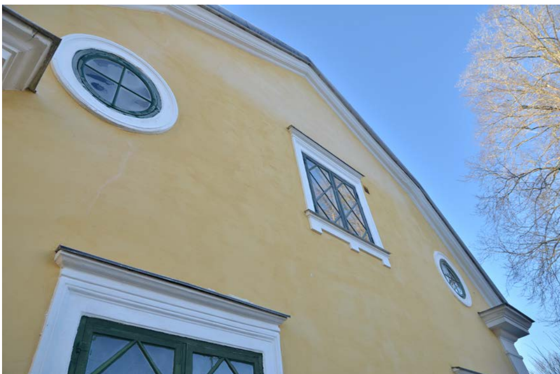
Östra gaveln efter renovering. Rimfrosten gör att de nymålade fönstren ser fläckiga ut. Foto 2018-11-28 (SLM D2019-0418).
