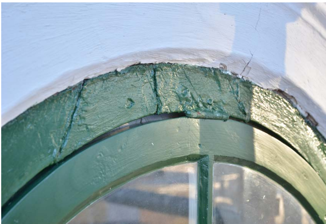
Södra rundfönstret på västra gaveln efter renovering. Foto 2018-11-28 (SLM D2019-0455).
