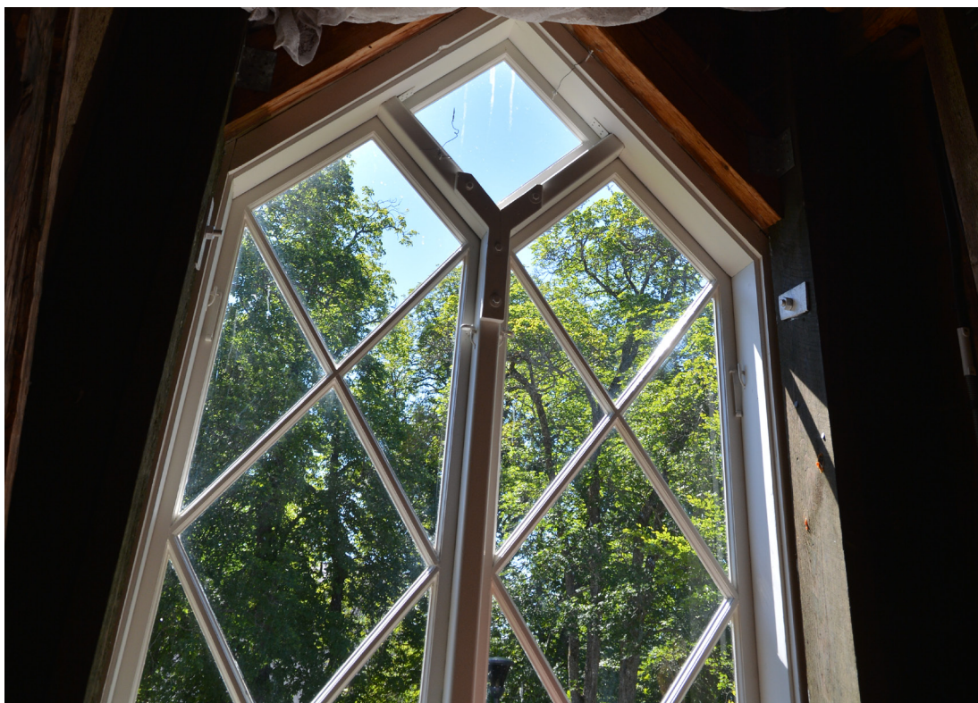
Insidan av fönster på södra takkupan efter renovering. Foto 2019-07-03 (SLM D2019-0458).
