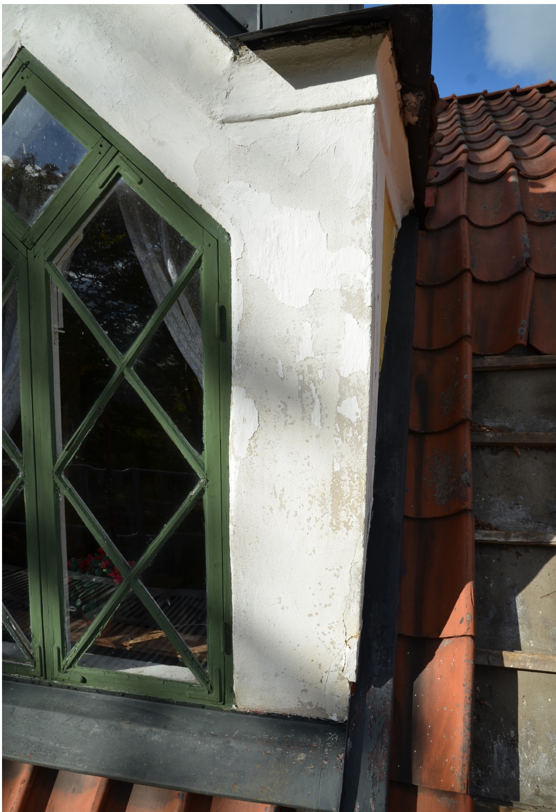
Takkupan mot söder. Plåtarna runt takkupan byttes ut till nya lika befintliga. Dessa målades dock inte. Foto 2018-10-03 (SLM D2019-0435).
