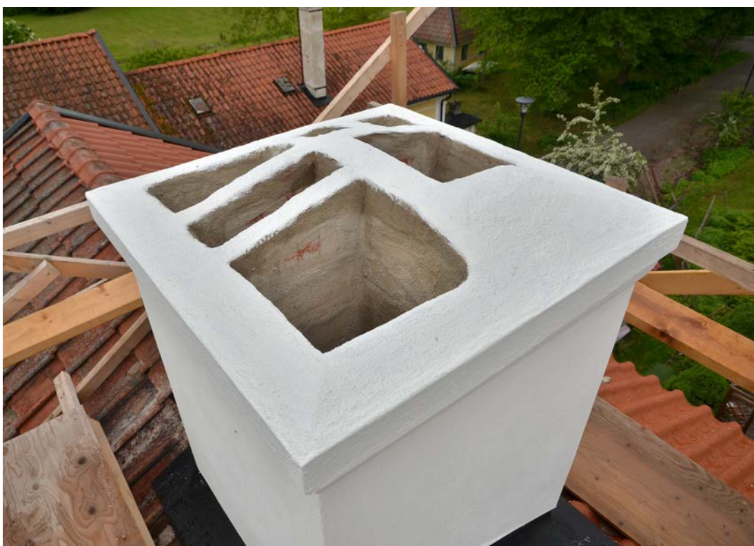
Östra skorstenen efter avslutad ommurning och avfärgning med silikatfärg. Foto 2019-05-27 (SLM D2019-0461).
