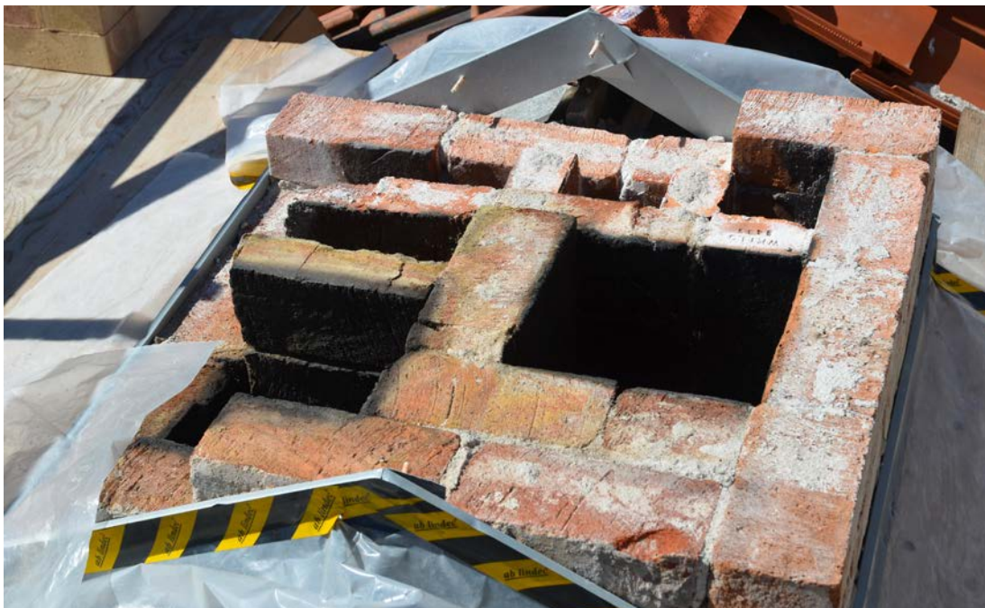
Västra skorstenen efter att befintligt tegel knackats ned. Foto 2019-05-16 (SLM D2019-0459).
