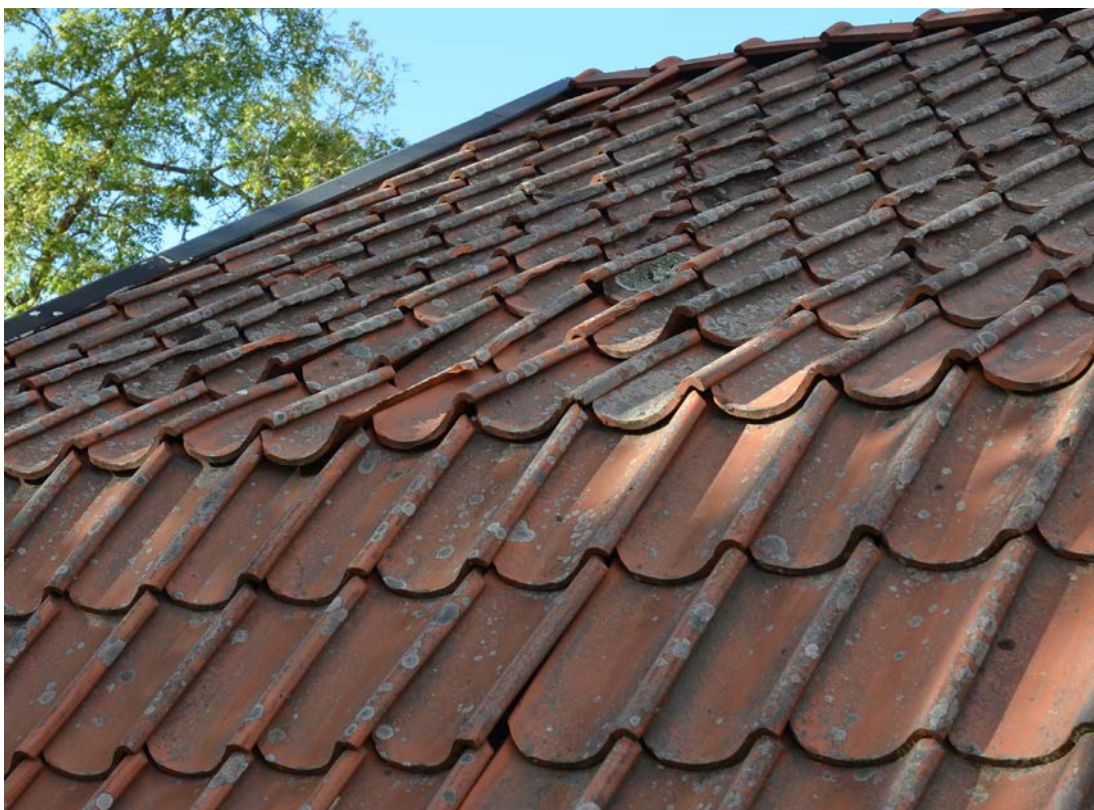
Västra delen av södra takfallet. Flertalet tegelpannor behövde justeras för att ge ett bättre regnskydd och ge ett mer vårdat intryck. Foto 2018-10-03 (SLM D2019-0436).
