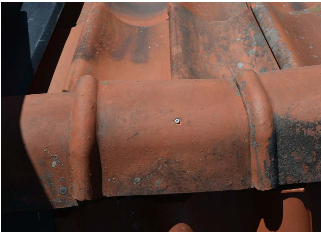
Nockpannorna har fästs inock med skruv. Foto 2019-07-03 (SLM D2019-0441).
