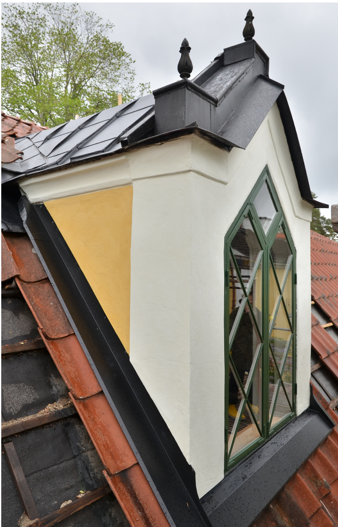
Södra takkupan efter putslagningar, avfärgning och plåtarbeten. Foto 2019-05-27 (SLM D2019-0467).
