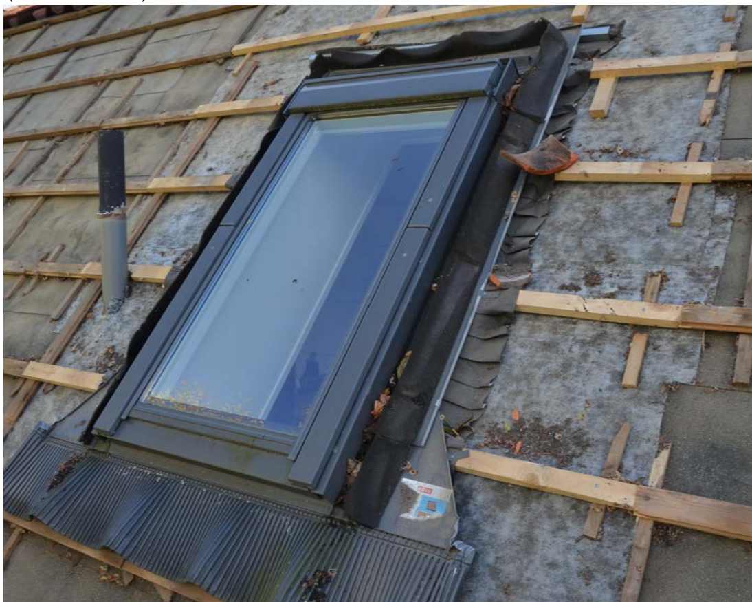
Tidigare lagad läkt vid fönstret på norra takfallet. Foto 2018-10-03 (SLM D2019-0431).
