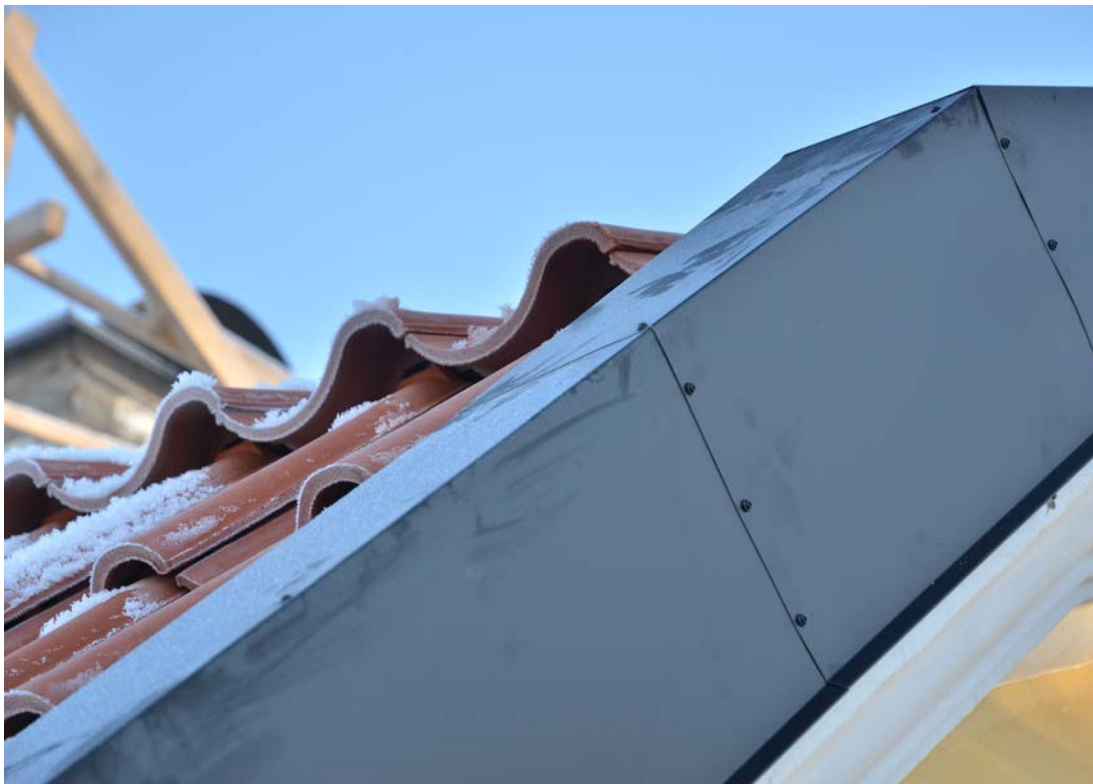
Delar av vindskivorna på gaveln mot väster ersattes med ny nitad plåt. Foto 2018-11-28 (SLM D2019-0448).
