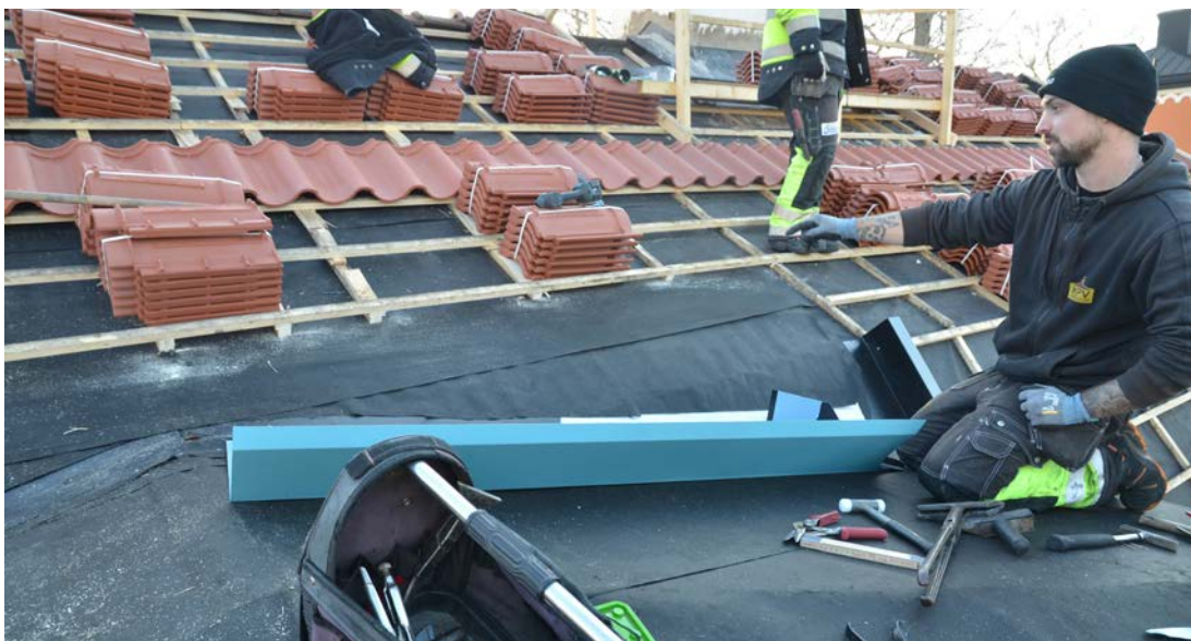
Pågående arbeten på norra takfallet. Foto 2018-11-01 (SLM D2019-0438).
