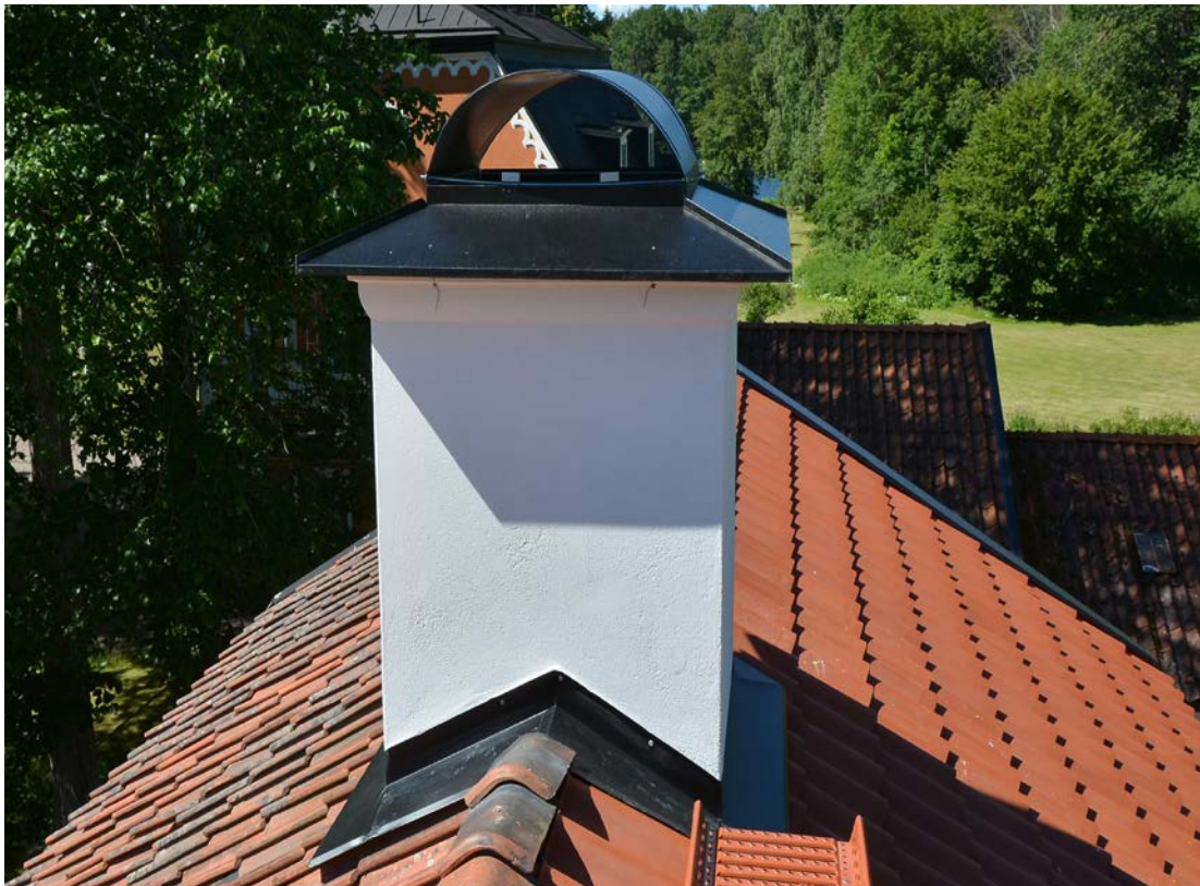
Västra skorstenen efter avslutad renovering. Foto 2019-07-03 (SLM D2019-0462).
