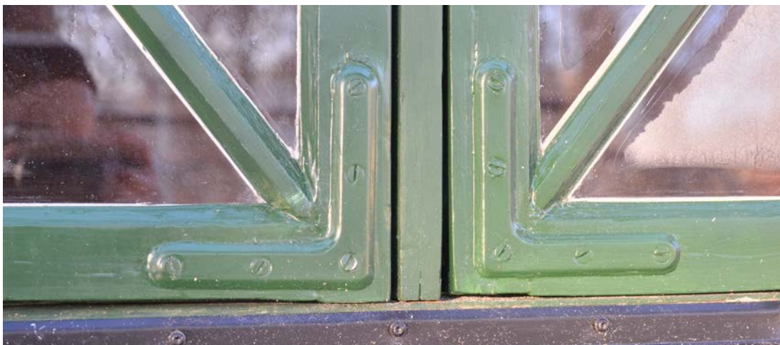
Hörnjärn och spröjs på södra takkupan efter renovering. Foto 2018-11-28 (SLM D2019-0456).
