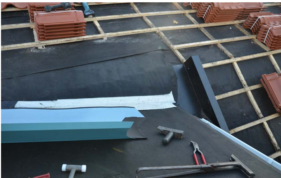
Pågående renovering av tak och plåtarbeten. Foto 2018-11-01 (SLM D2019-0445).
