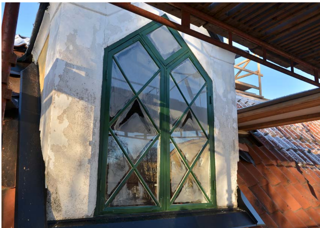
Fönster på södra takkupan efter renovering. Foto 2018-11-28 (SLM D2019-0457).
