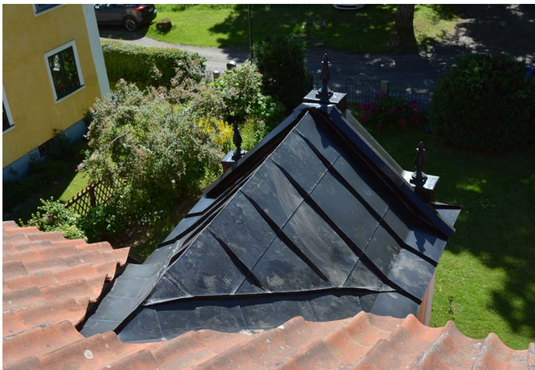
Södra takkupan efter avslutade arbeten. Vindskivorna och fialerna målades med svart rostskyddsfärg. Foto 2019-07-03 (SLM D2019-0450).
