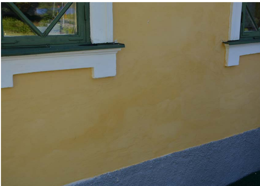
Bortflagnad färg har avfärgats med ny kalkfärg i kulör lika befintlig. Foto 2019-07-03 (SLM D2019-0469).
