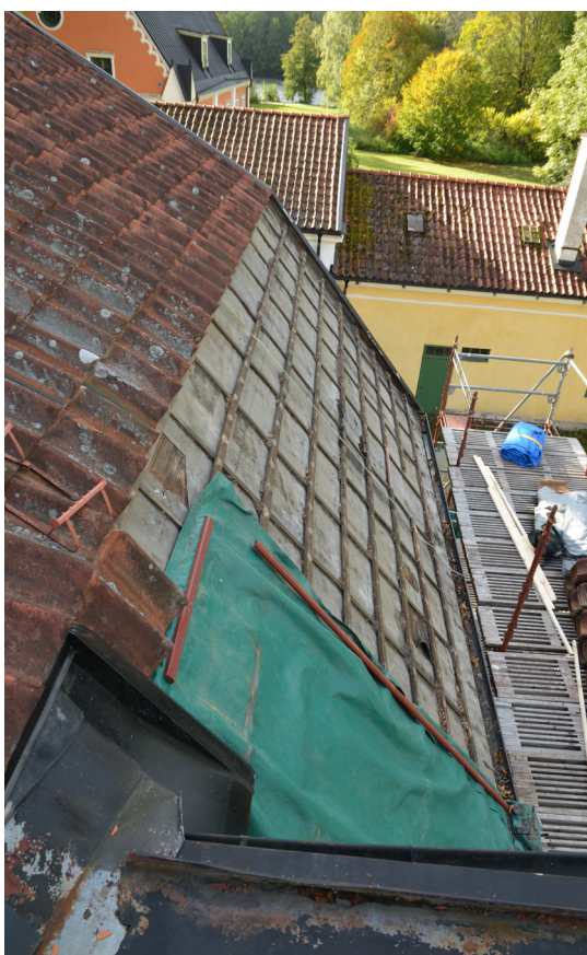
Västra delen av norra takfallet under pågående nedplockning av tegelpannor. Foto 2018-10-03 (SLM D2019-0428).
