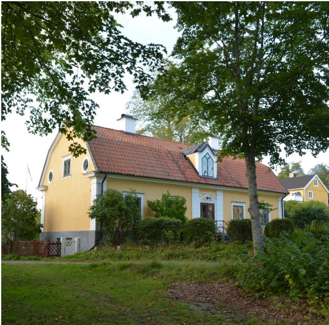
Östra flygelns södra och västra fasader efter avslutade arbeten. Foto 2019-09-17 (SLM D2019-0470).
