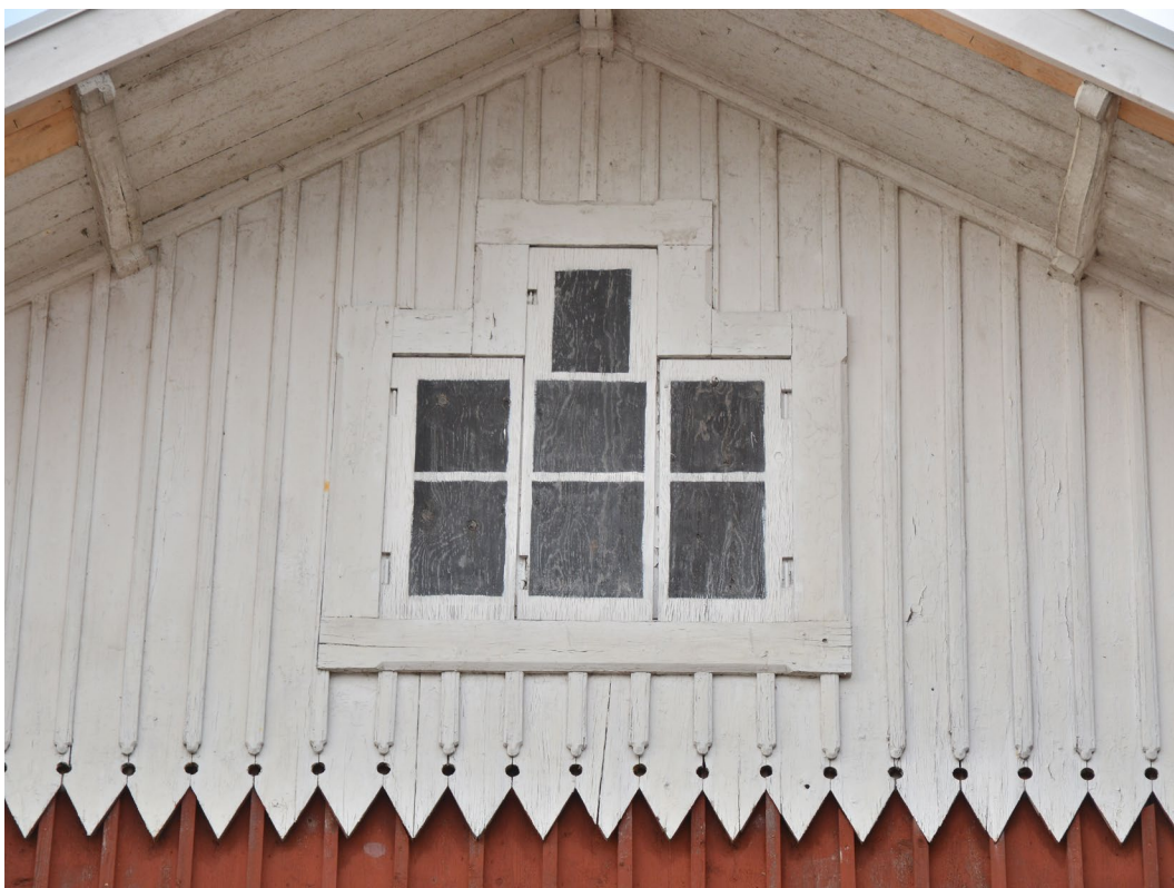
Gavelpartiet har profilerade locklister som är figursågade i nederkant samt ett blindfönster. Notera också det djupa taksprånget och de figursågade taksparrarna. SLM D2018-0008
