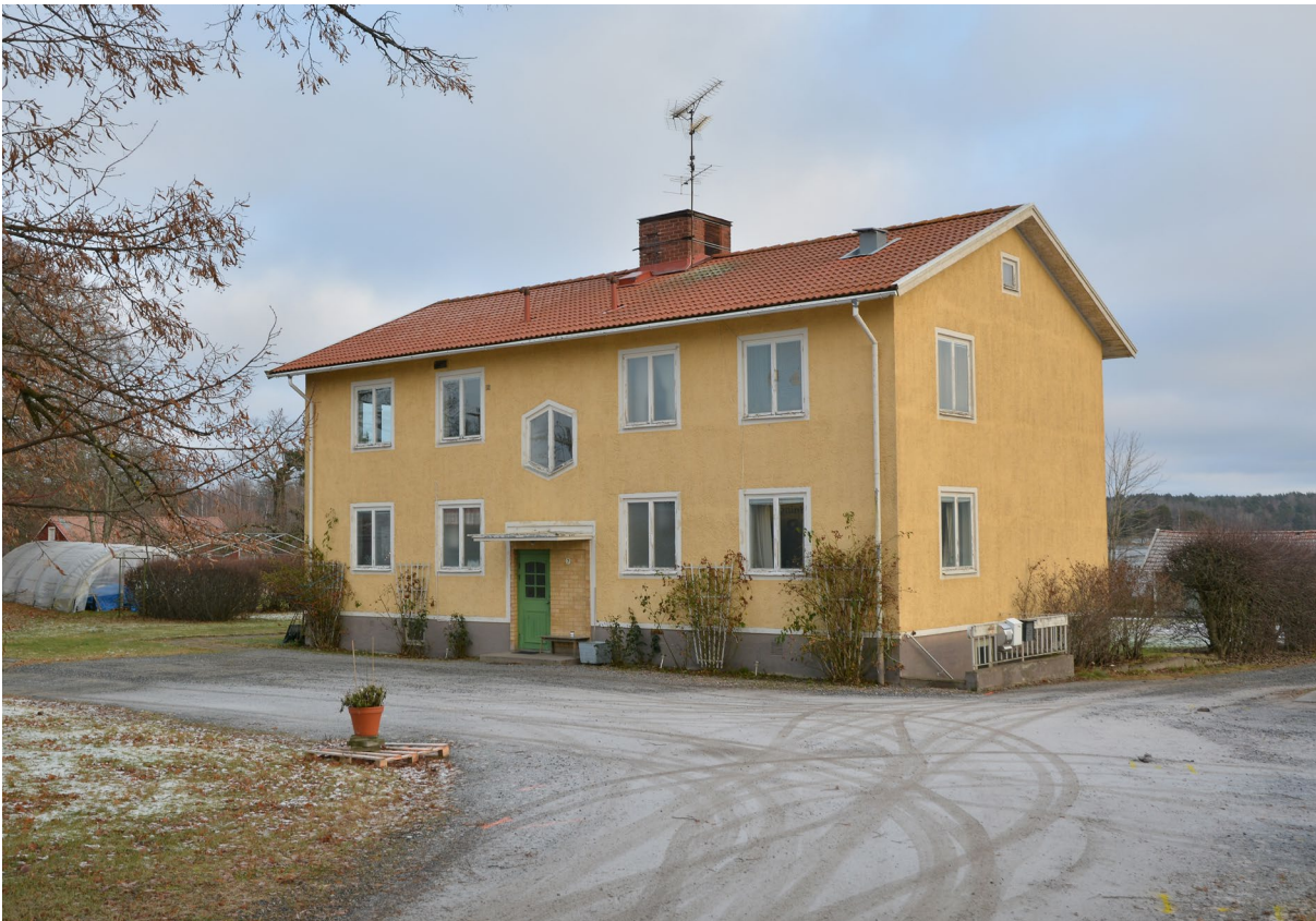
Bostadshuset Sparreholm 13:4 uppförd åt SJ 1953. Bortsett från entréparti och takmaterial är huset i så gott som ursprungligt skick. SLM D2018-0010
