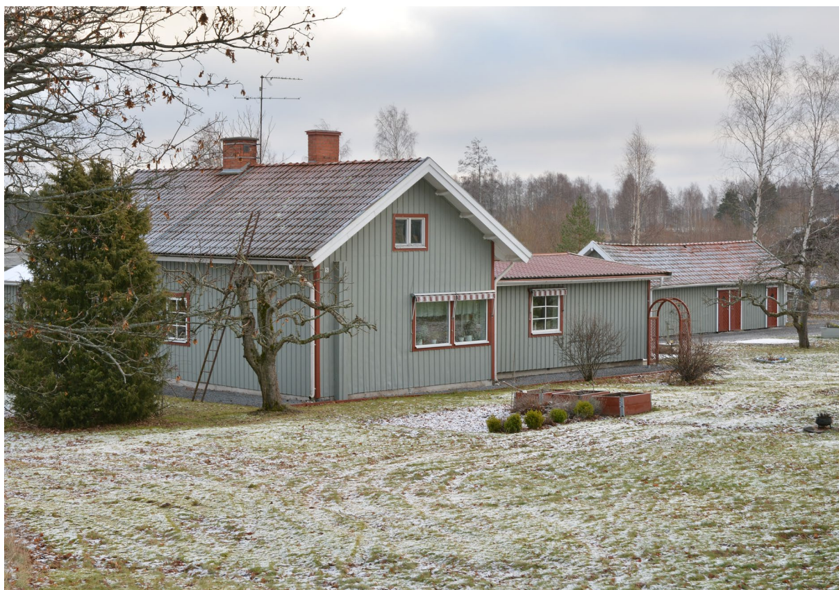
Den f.d. banmästarstugan Sparreholm 13:1 med uthuset i bakgrunden. Tillbyggnaden från 1961 syns till höger i bild. SLM D2018-0011
