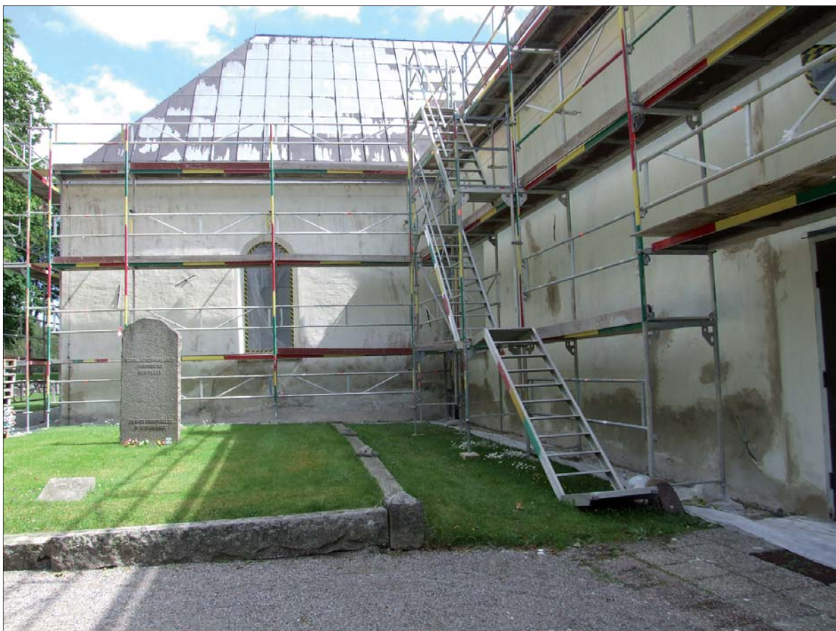
14 Nykyrkans västra fasad och del av norra långhusfasaden efter putslagningar i juli 2012 (Slm D13-0011).
