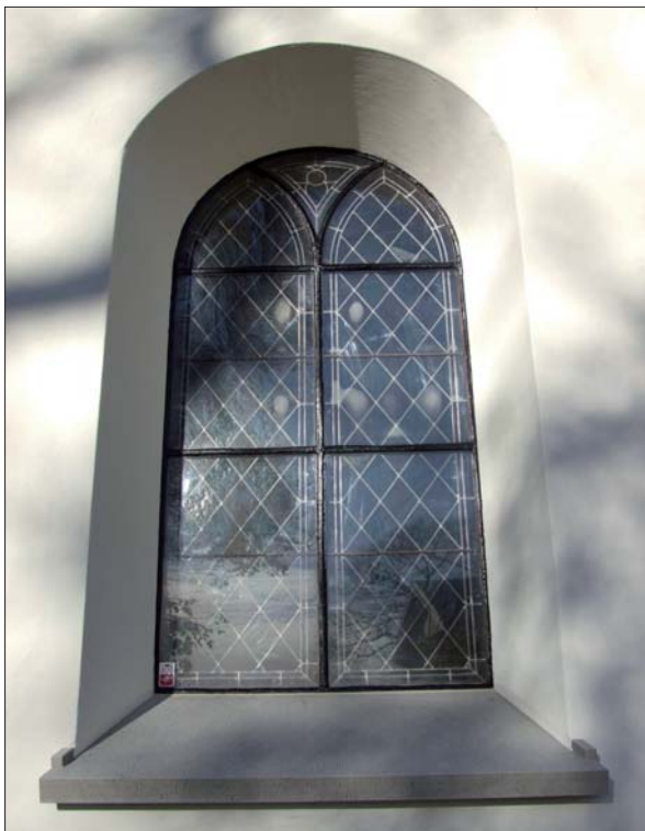
15 Fönsternisch i söder efter renovering. Den gjutna solbänken har ersatts med kalksten (Slm D13-0012).
