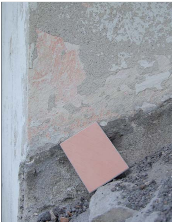
25 Under de vita kalkfärgslagren syns ljus gul kalkavfärgning och under det en rosa nyans. I bild syns färgprovet 44:4 (Slm D13-0020).
