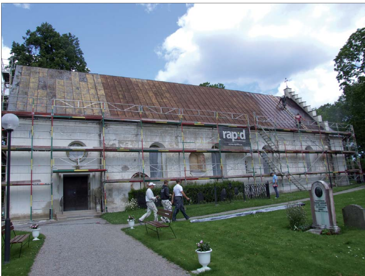
9 Södra fasaden vid byggmöte två då putslagning av fasaderna pågår och taket tvättas (Slm D13-0006).
