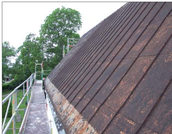
11 Södra takfallet före rengöringen. Närmast och upptill syns den äldre järnplåten. Vid takfoten ligger varmförzinkad plåt (Slm D13-0008).
