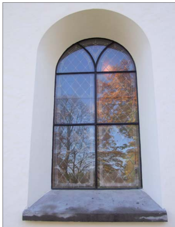
17 Fönsternisch i norr med gjuten solbänk efter tvätt och hydrofobering av solbänken, samt efter målning av fönsterbågen (Slm D13-0014).
