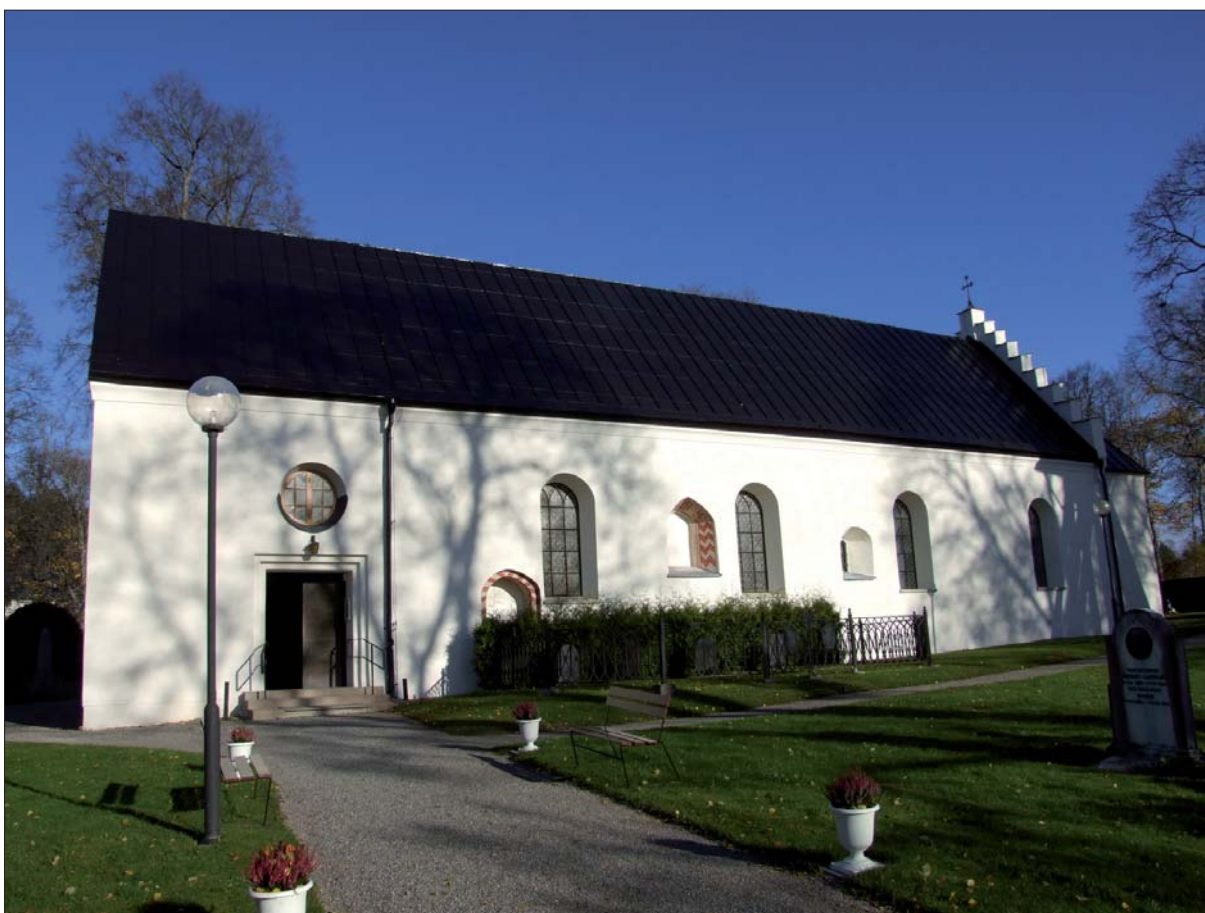
24 Kyrkan sedd från söder efter renoveringen. Bilden tagen den 25 oktober 2012 (Slm D13-0019).
