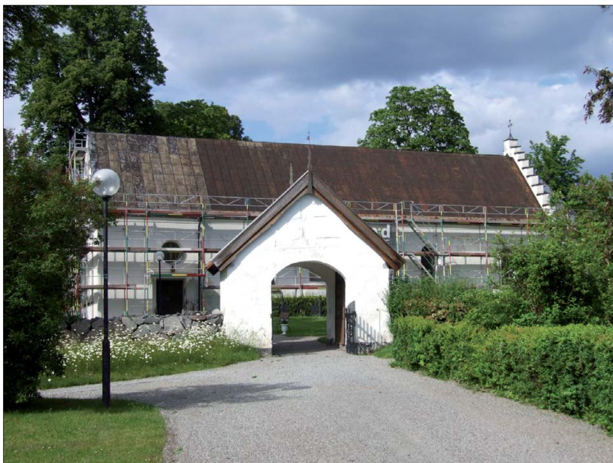
5 Kyrkan och stigluckan sedd från söder vid första byggmötet i juni 2012 (Slm D13-0003).
