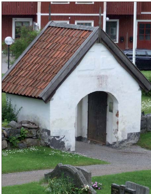
6 Stigluckan före åtgärd. Sockeln är gråmålad. Putssläpp vid mark och röda alger på putsen (Slm D13-0004).
