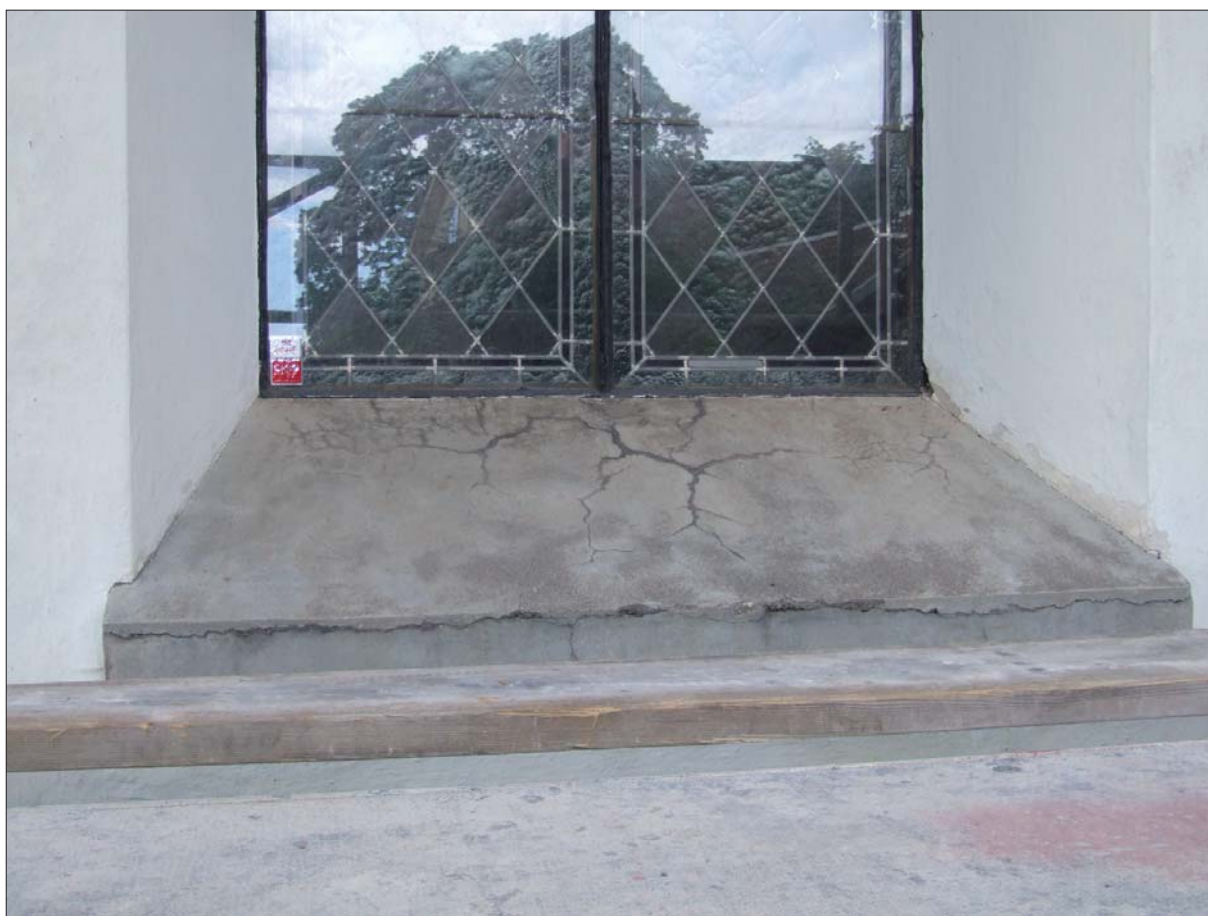
16 Vittrad solbänk av gjuten cement före byte till kalksten (Slm D13-0013).
