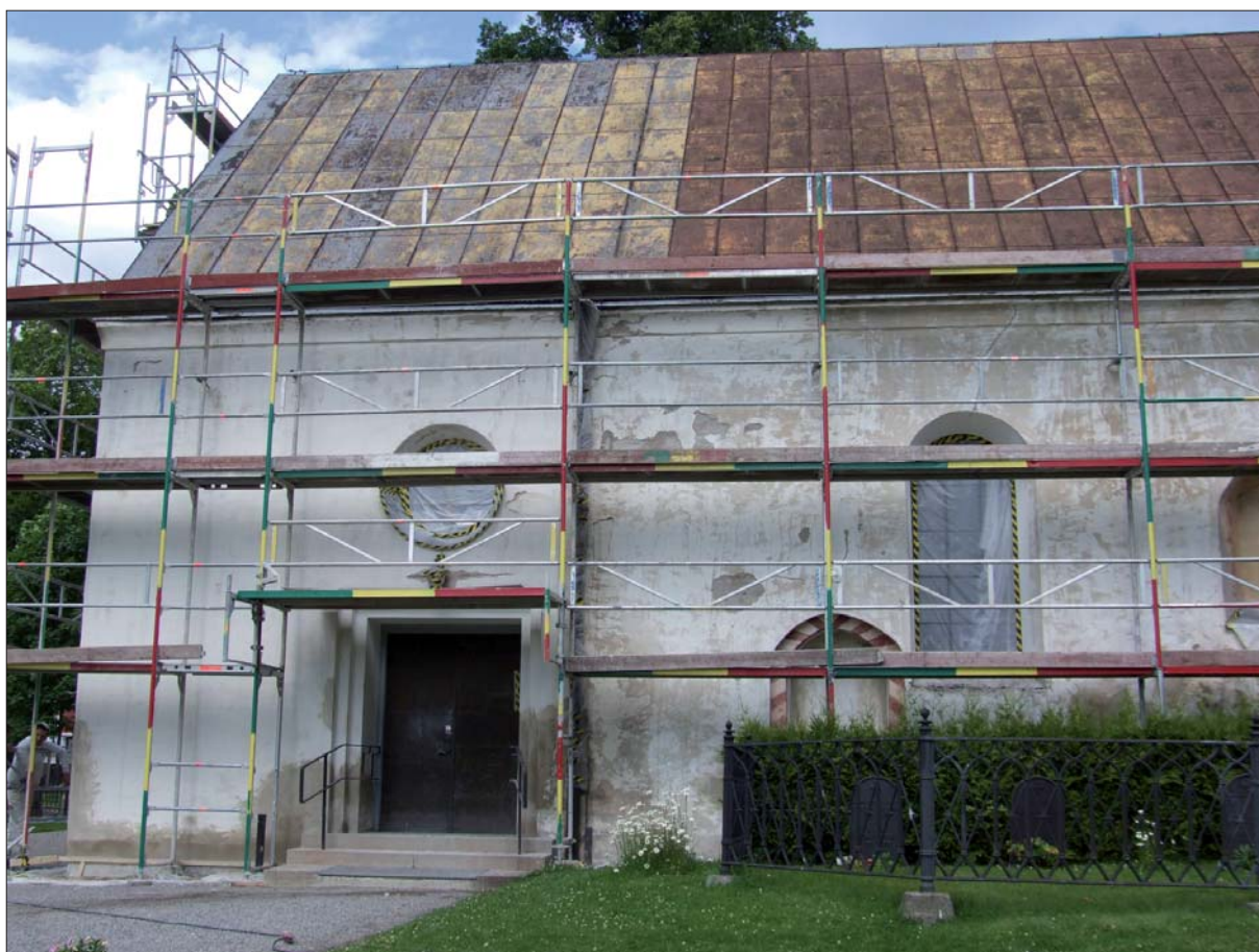
7 Del av södra fasaden före renoveringen (Slm D13-0001).
