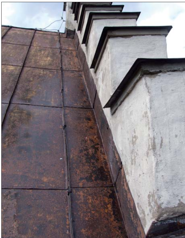
10 Plåtraden på södra takfallet närmast trappstegsgaveln var trasig och byttes ut (Slm D13-0007).
