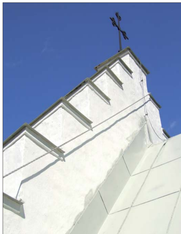
8 Södra trappstegsgaveln efter målning. Även kalkstensöverliggarna målades. Plåtens grundfärg har hamnat på putsen (Slm D13-0005).
