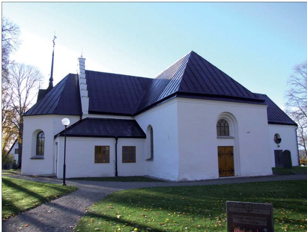
3 Lilla Malma kyrka sedd från nordost efter renoveringen, 25 oktober 2012 (Slm D13-0002).
