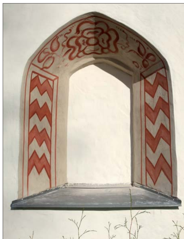
23 Fönsternischen efter utförda arbeten (Slm D13-0018).
