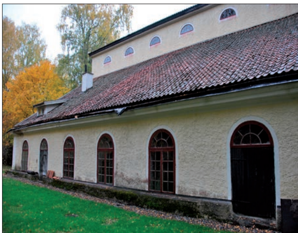
5 Detalj av det östra takfallet (SLM D2013-786).
