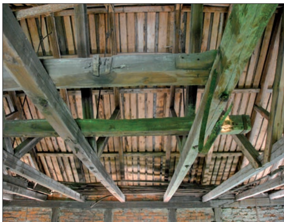
20 Lanterninvåningens takstolar. De tvärgående bjälkarna är rester från beskickningsutrustningen. Se bild 39 (SLM D2013-800).
