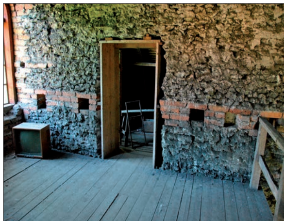
46 Utrymmet ovanför rostugnen Bjälklagshålen förmedlar information om byggnadens tidigare användning (SLM D2013-814).
