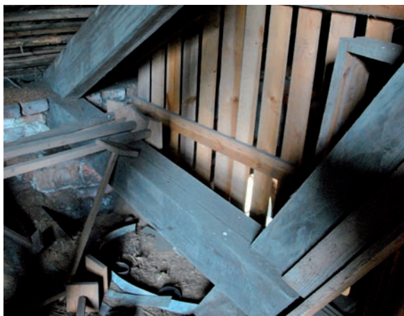
19 Detalj av takstolens tass och anliggning mot murverket (SLM D2013-799).
