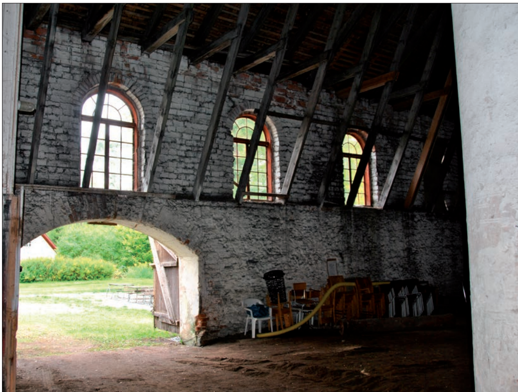
11 Interiör mot nordväst. Murarnas nederdel består av s.k gjutväggar. Vid fönstren mursten av masugnslagg och vid murkrönet tegel (SLM D2013-792).
