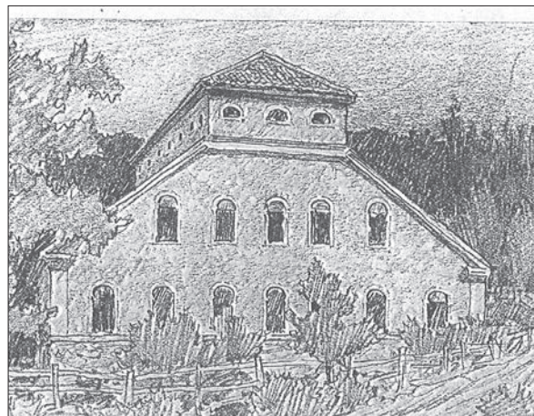
32 Masugnsbyggnaden avbildad av Ferdinand Boberg Carl Sahlins bergshistoriska arkiv Tekniska museet.
