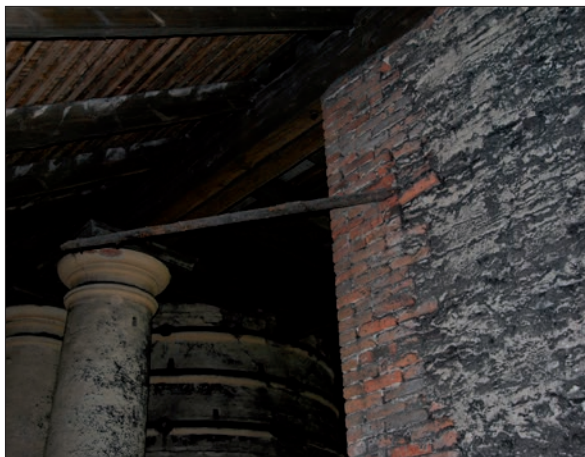
13 De bärande elementen till lanterninvåningens bjälklag. Närmast i bild en murförkroppning som ansluter mot den östra gaveln. (SLM D2013-793).
