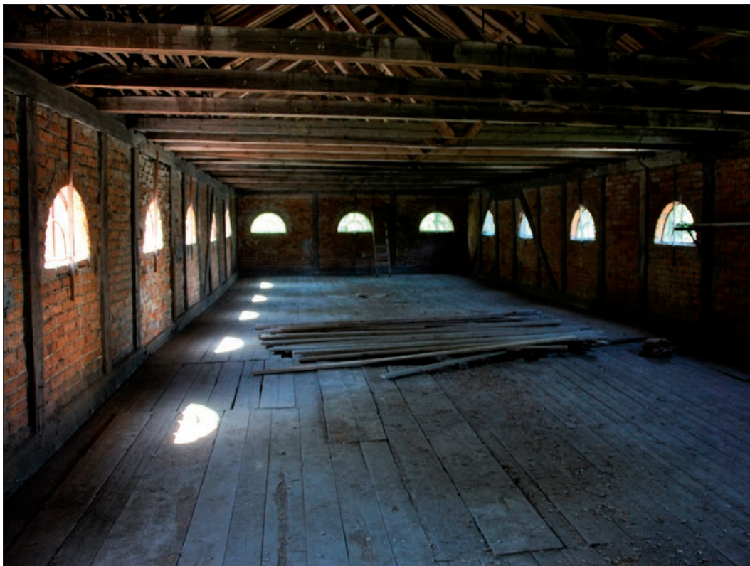
16 Interiör från lanterninvåningen. Brädorna täcker masugnsippan (SLM D2013-796).
