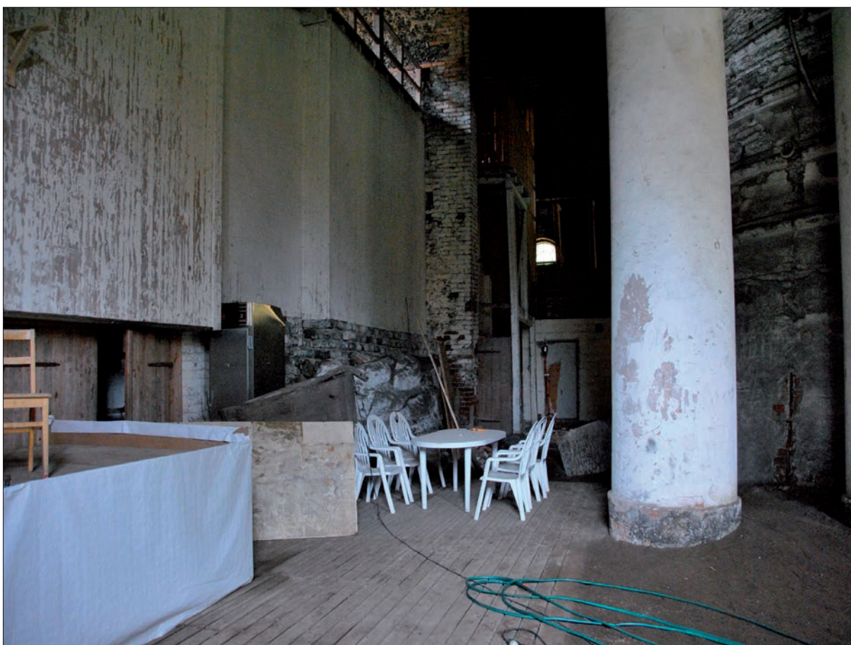
24 Interiör mot öster Närmast i bild utrymme Nr 1. Rostugnens fundament med påmurning av slaggsten syns lite längre bort, intill plastmöblerna. Trägolvet täcker hjulgraven Nr 2 (SLM D2013-803).
