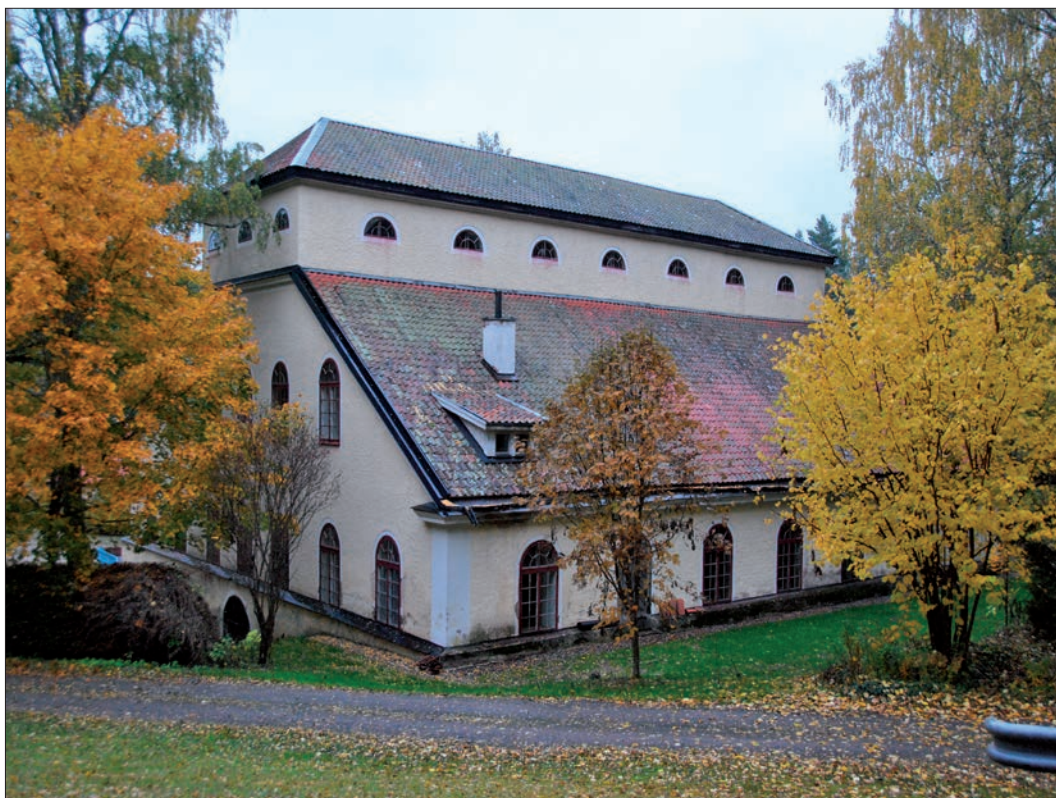
6 Byggnaden sedd från sydost. Gavelutsprångets listverk fungerar också som våningsavskiljare till lanterninvåningen (SLM D2013-787).
