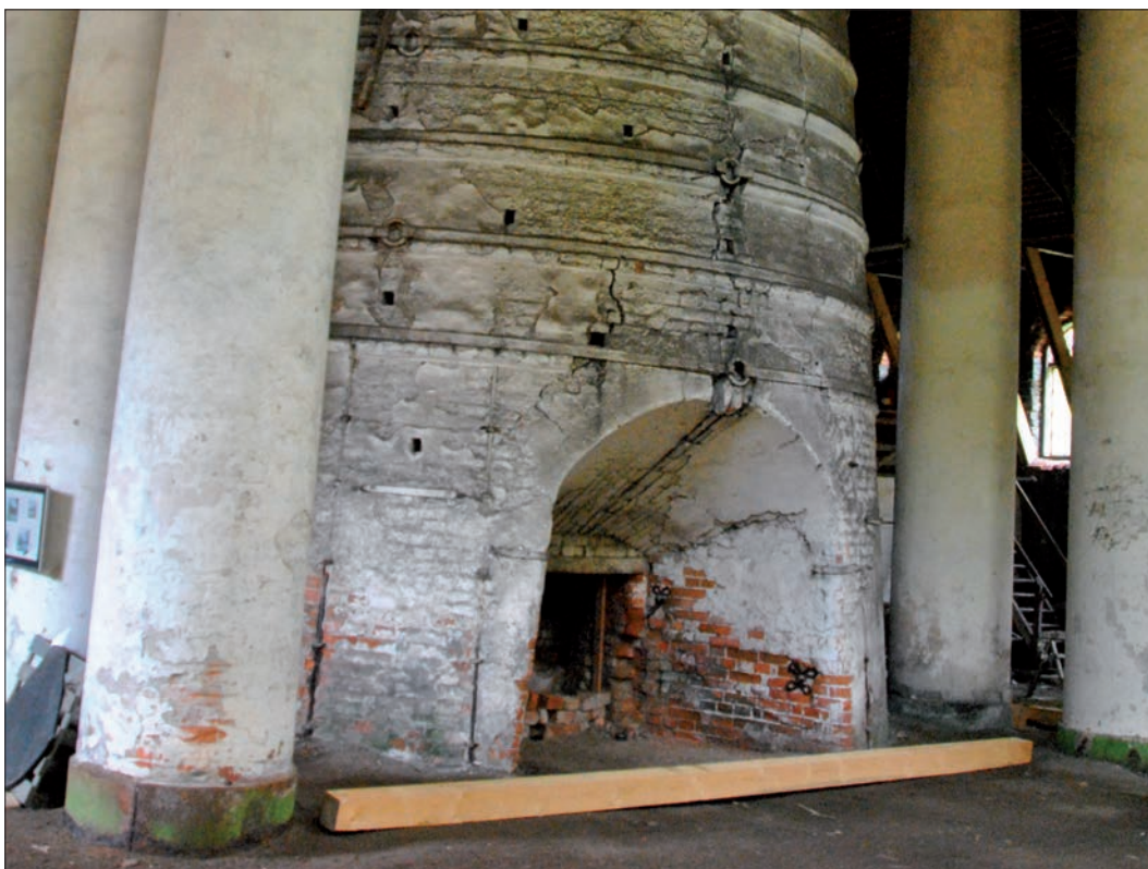
17 Masugnsipans utslagsbröst, rådstugan. Notera hållarna för spett samt kolonnernas järnförstärkning i basen (SLM D2013-797).
