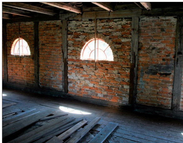
40 Lanterninvåningen med masugnskransen. Kolintaget har sannolikt varit mellan de järnskodda stolparna. Öppningen har sedan murats igen. Det går att se att denna murning har skett vid ett senare tillfälle (SLM D2013-809).
