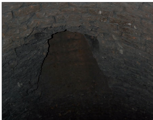
41 En dålig men tekniskt intressant bild som visar uttaget för masugnsgas. Då det inte finns några yttre tecken på gasuttag antogs det felaktigt att anläggningen saknade detta (SLM D2013-810).
