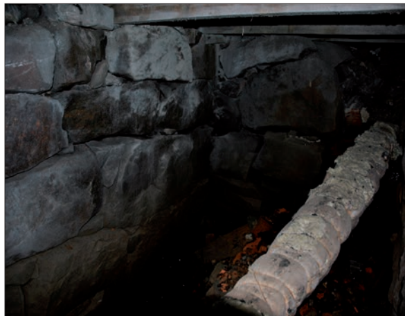
45 Hjulgraven, en rest från tiden då man drev masugnsens bläster med hjälp av vattenkraft (SLM D2013-813).
