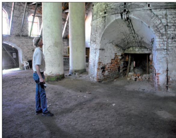
42 Rådstugan kallas det utrymme framför utslagsbröstet där järn och slagg har tappats ur masugnen. I bild, Björn Björck (SLM D2013-811).
