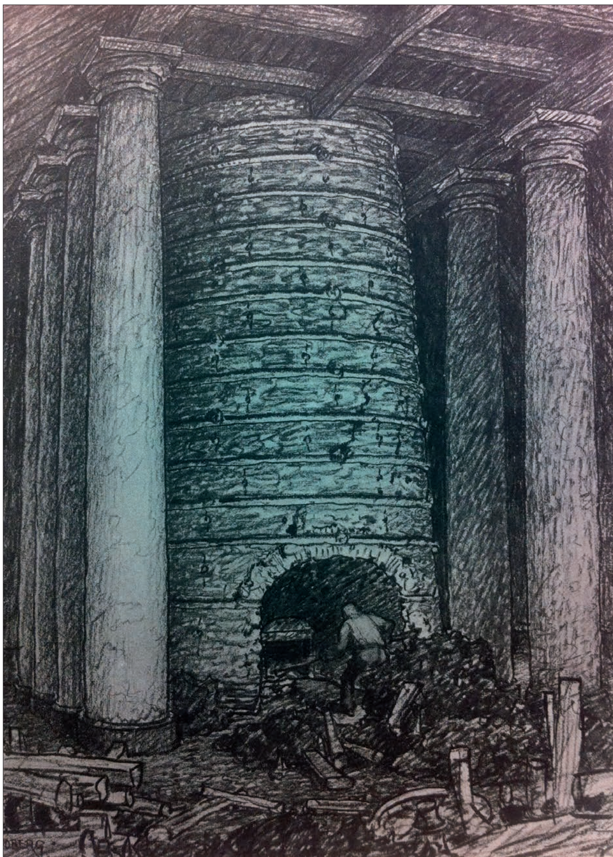
36 Masugnsippan avbildad av Ferdinand Boberg i början av 1900-talet. Det ser ut som personen i bild håller på att raka ur kol och malmrester ur ugnen. Mängden av skrot väcker nyfikenhet. Det är troligen delar av produktionsutrustningen som har demonterats i väntan på transport till skrotupplaget. Tekn. museet.
