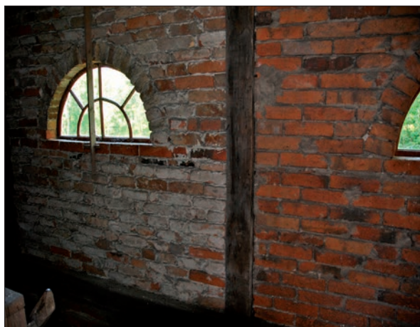
38 skillnaden i teglets utseende och även finishen på murningen indikerar att detta är en öppning som murats igen vid ett senare tillfälle. Intaget av maln har sannolikt varit här. (SLM D2013-808).
