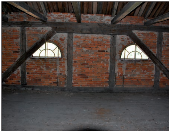
15 Bjälklagsförstärkningar i form av hängverk ovanför den fribärande delen. (SLM D2013-795).
