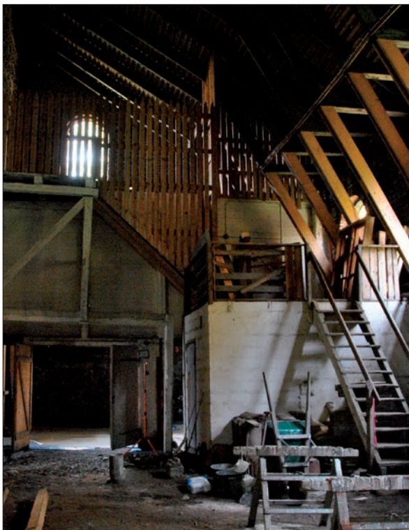
25 Utrymmen i det östra hörnet Nr 4. Här finns trappan upp till lanterninvåningen och masugnskransen (SLM D2013-804).
