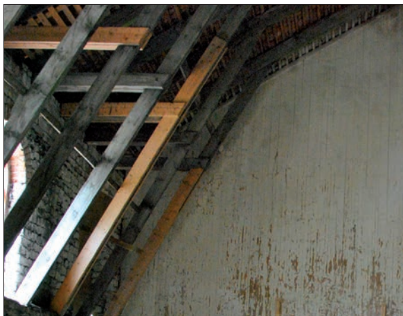
18 Takstolarnas stödben. Några har förstärkts. (SLM D2013-798).
