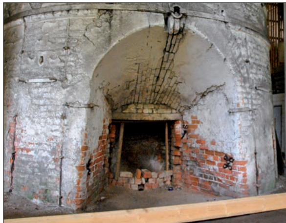
52 Utslagsbröset, slutstenarna i valvet hänger löst (SLM D2013-820).
