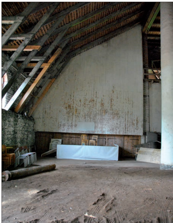
22 Det norra utrymmet, Nr 1 sett inifrån masugnsbyggnaden (SLM D2013-801).
