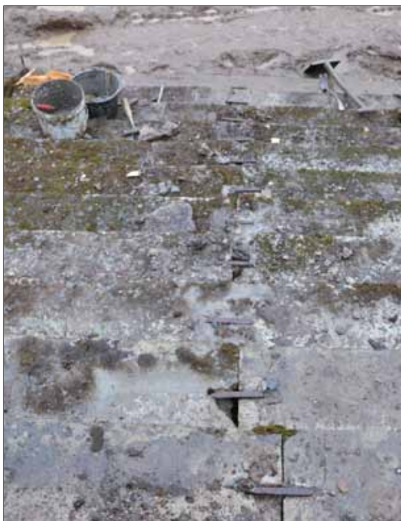
12 Trappans mitt efter omläggningen. Järnkramlorna har återanvänts och det mesta av mossen och lav är kvar (Slm D12-0960).
