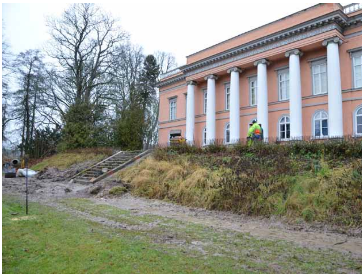
13 Väster om slänten och trappan lades dränering ned (Slm D12-0961).
