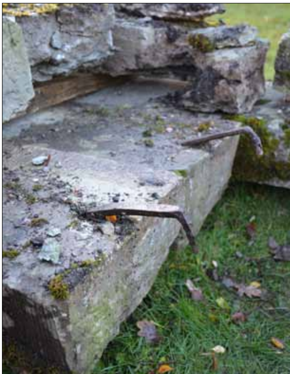
7 Järnkramlorna återanvändes. Kramlorna satt tidigare i bly, men sattes nu i bruk (Slm D12-0955).
