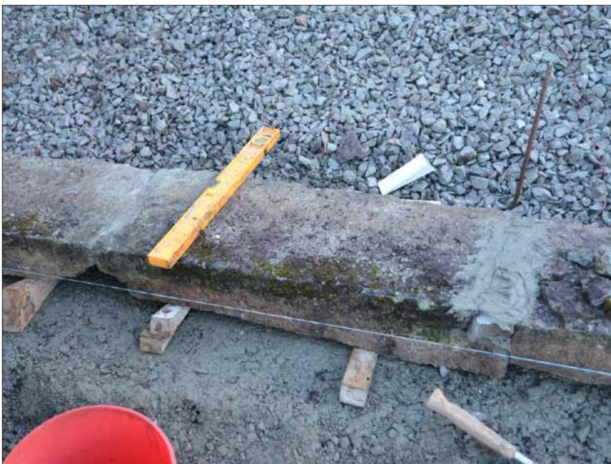
9 Sättstegen justerades i rätt läge med hjälp av tråkilar. Under sättstegen lades punktvis cementbruk blandat med makadam (Slm D12-0957).
