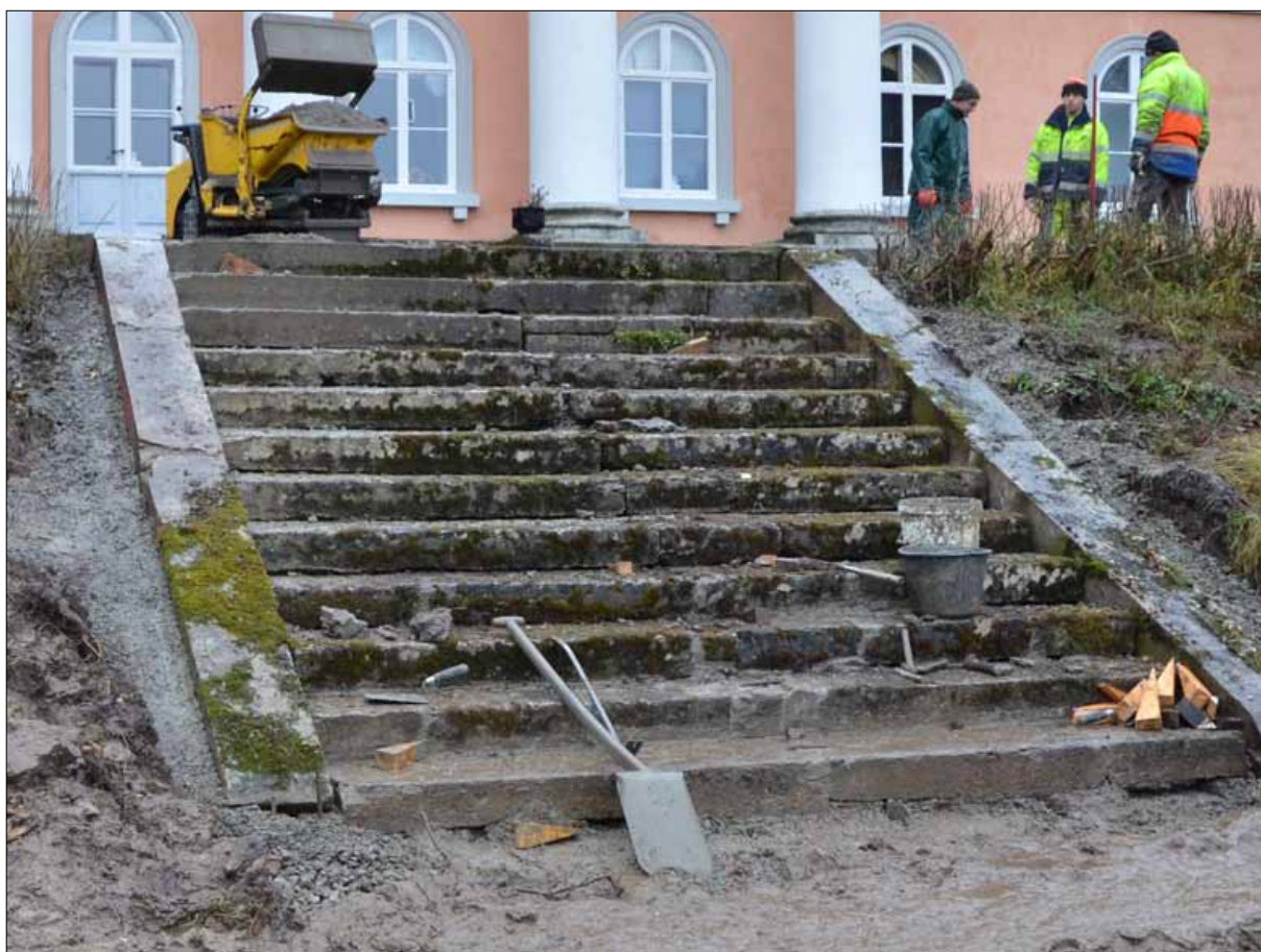
10 Kalkstentrappan vid slutbesiktningen den 28 november 2012 (Slm D12-0958).
