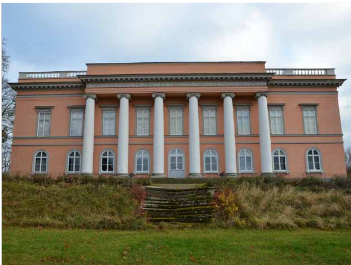
2 Ekensholms nyare huvudbyggnad från väster innan trappan lades om i november 2012 (Slm D12-0951).
