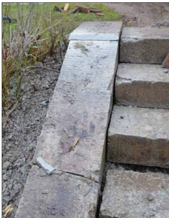
11 Övre norra överliggaren kapades för att den efter trappans lyft inte skulle "sticka" ut (Slm D12-0959).
