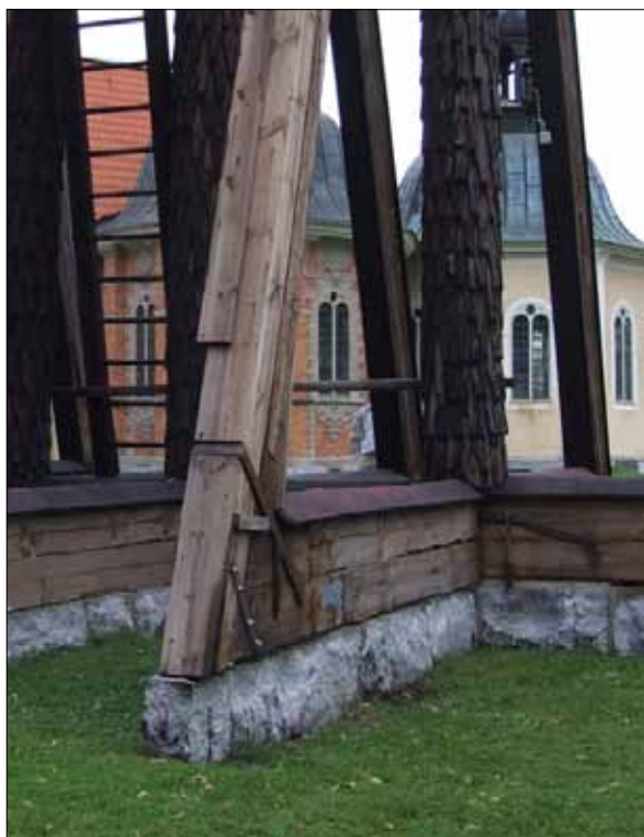
5 Klockstapelns nedre del från väster 2008. Sylldel V1, där snedsträvan går ned till fundamentet (Slm D11-724)
