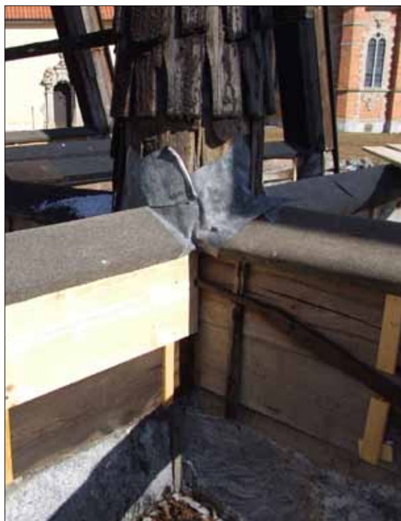
13 Under det nya "tak" lades papp som drogs upp på de yttre sidorna av södra och norra stolpen (Slm D11-731). Bilden beskuren.
