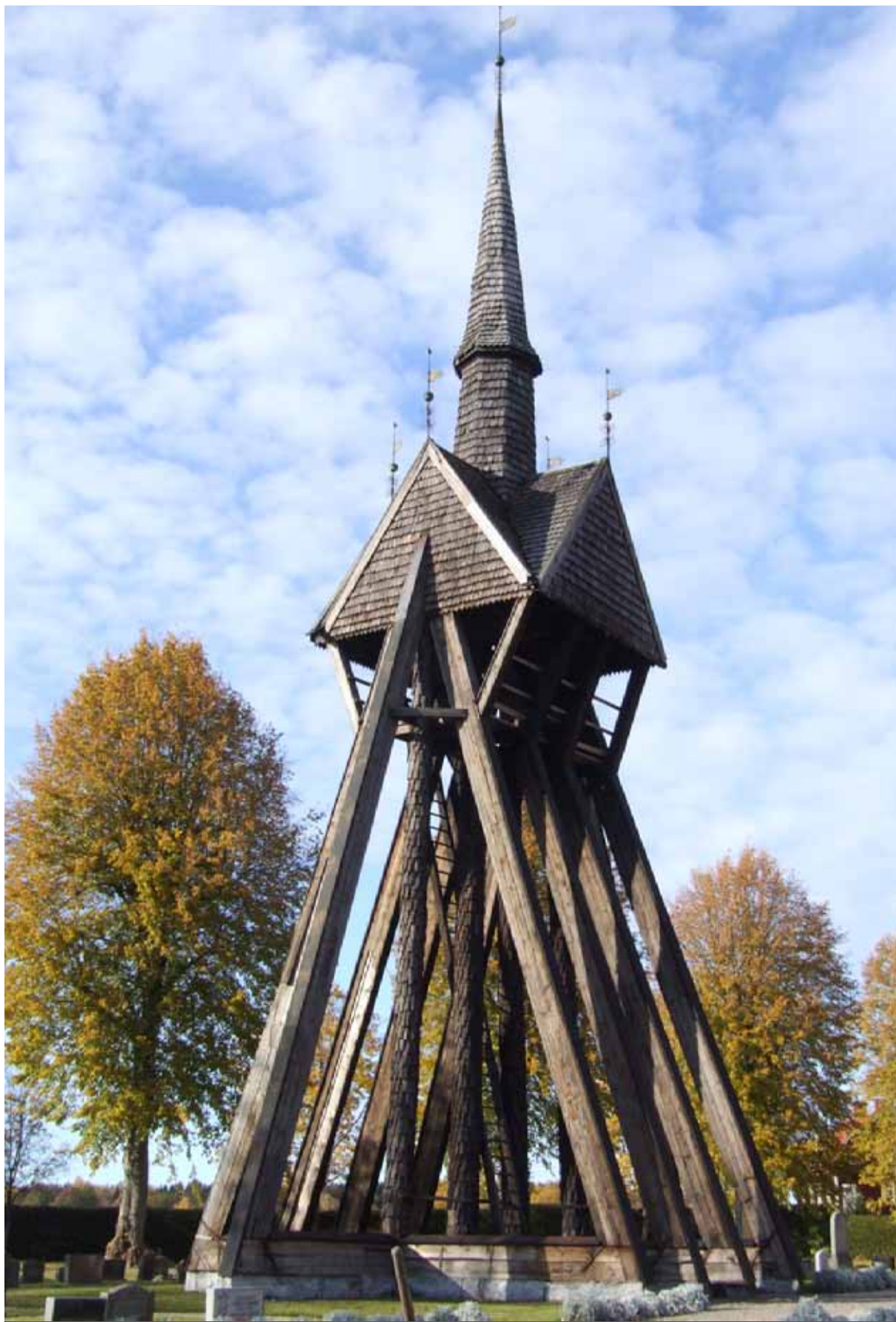
19 Vadsbro klockstapel med delvis borttagen panelinklädnad sedd från sydost före reparationen, oktober 2009 (Slm D11-722).
