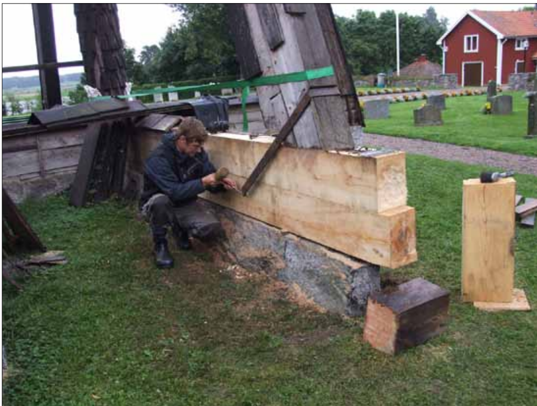
7 Arbeten med sylldel V1, entreprenör Emanuel Jakobsson i mars 2011. Äldre järn sätts tillbaks (Slm D11-725)
