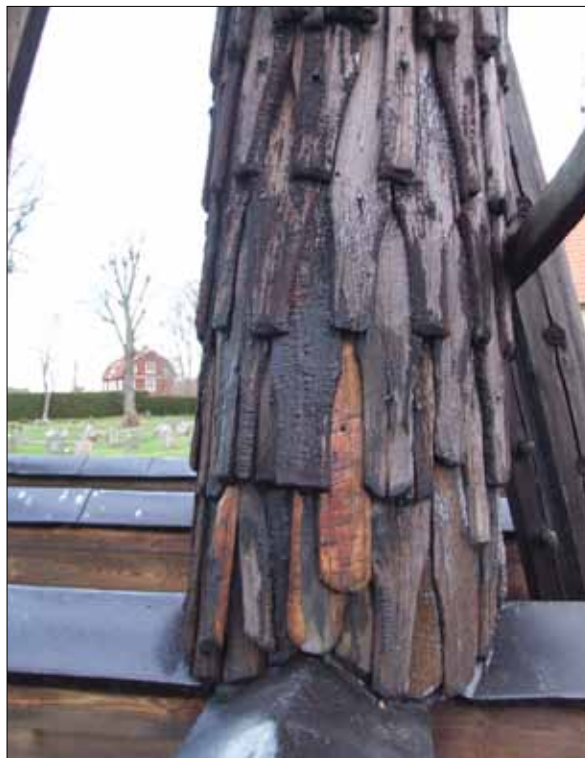
18 Andra stolpen från söder efter komplettering med nya spån (Slm D11-737).
