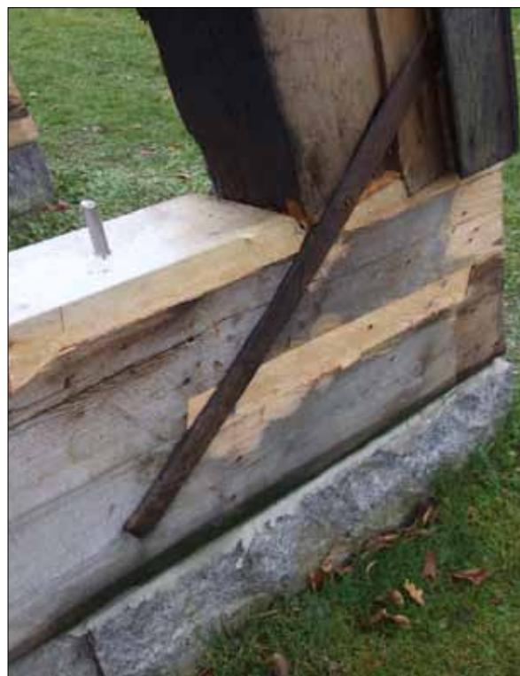
9 Styrdubben monterades innanför snedsträvan (Slm D11-727). Bilden beskuren.
