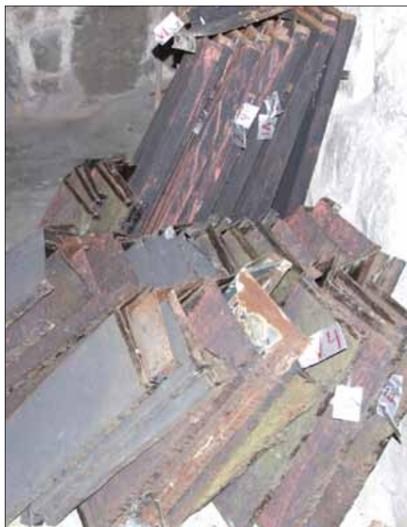
12 Plåtarna märktes upp och plockades ned (Slm D11-730). Bildens beskuren.
