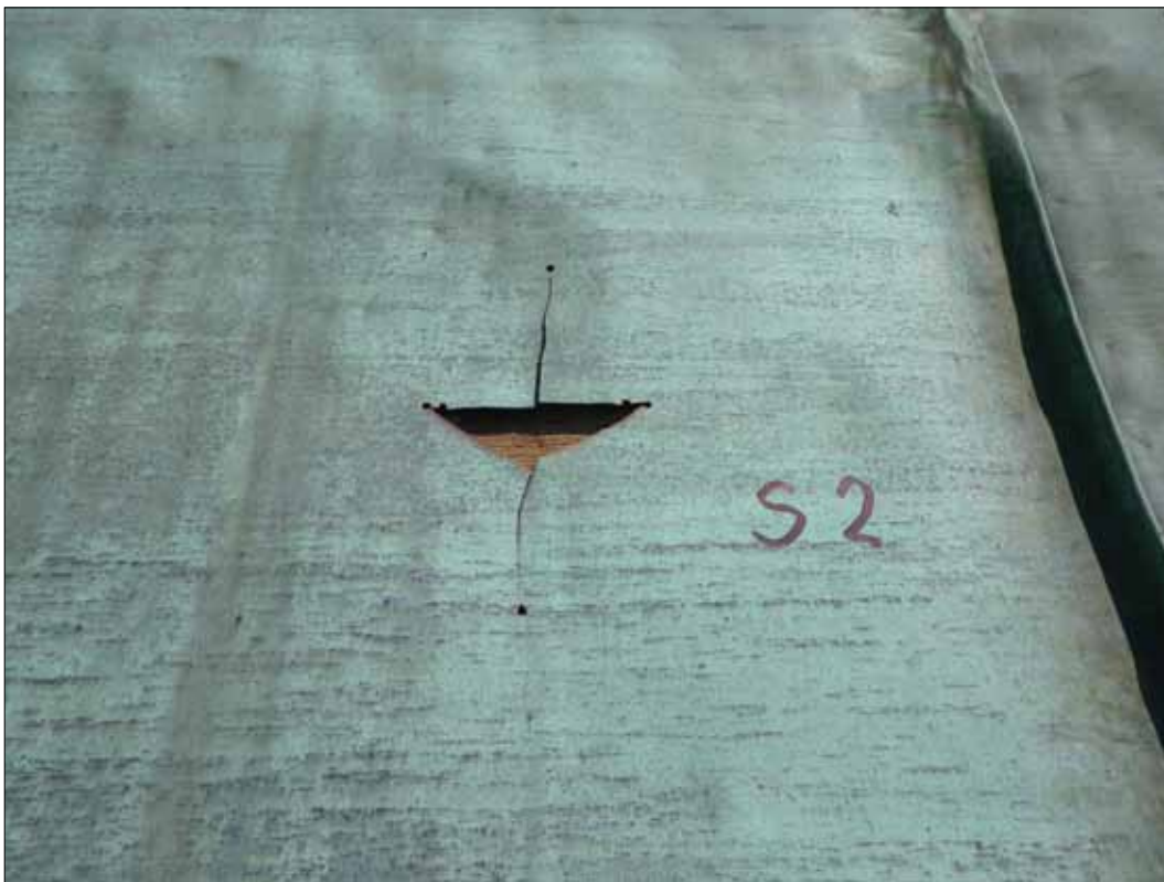
6 Den nedre delen av den horisontella sprickan klipptes förbereddades för insticksplåten. Foto: Ulf Posse, Bettna Byggplåt.
