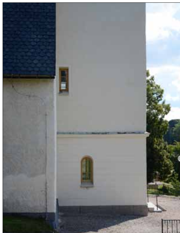
13 Tornets norra fasad efter slutförd renovering (Slm D11-746).
