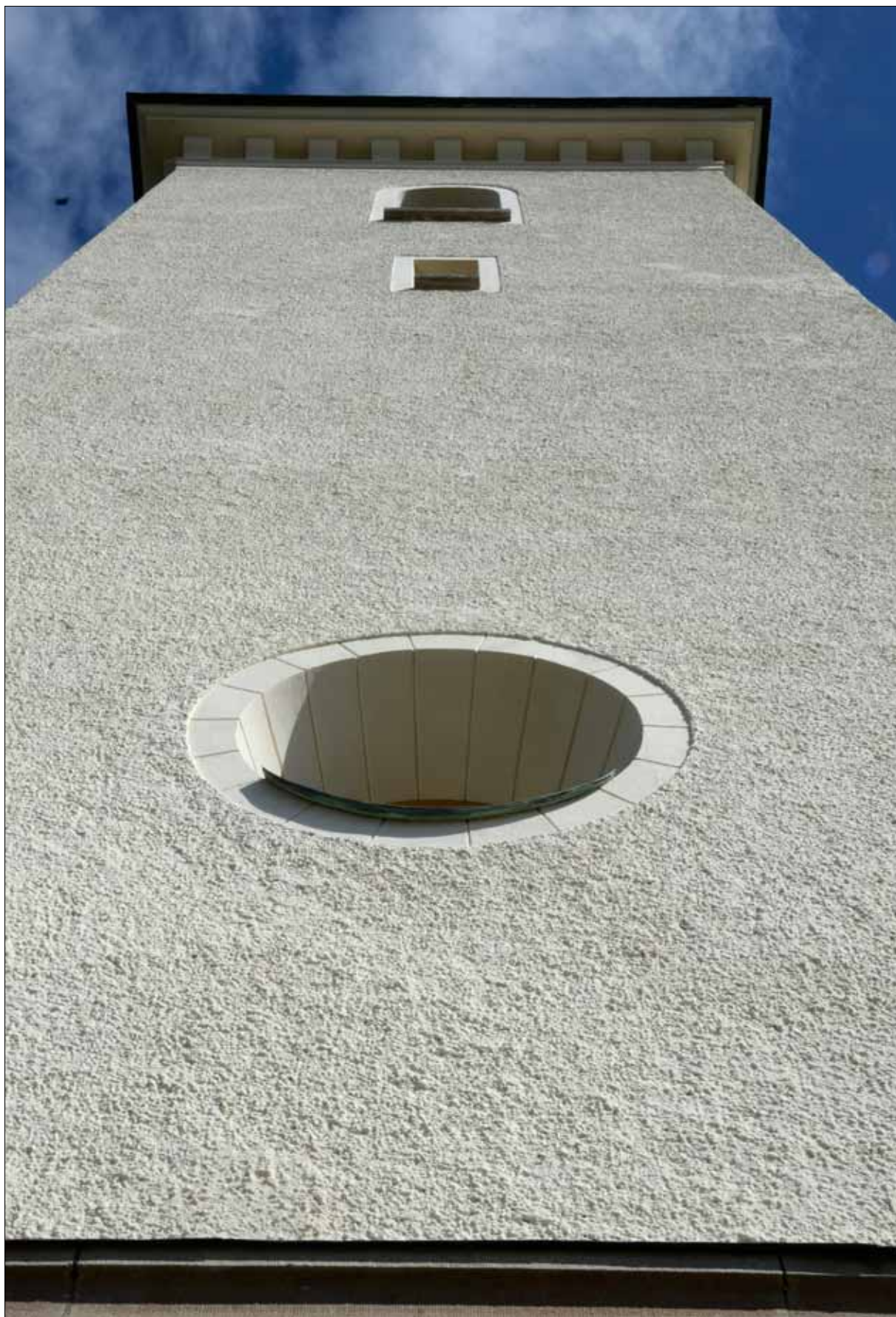
16 Tornets västra fasad efter avslutade arbeten (Slm D11-749).
