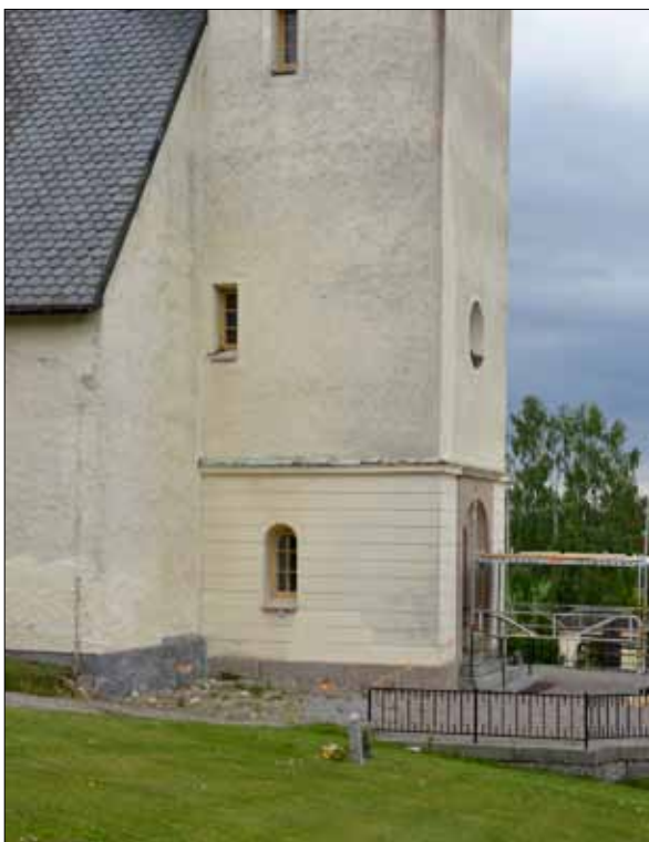
12 Tornets norra fasad före fasadrenoveringen (Slm D11-745).
