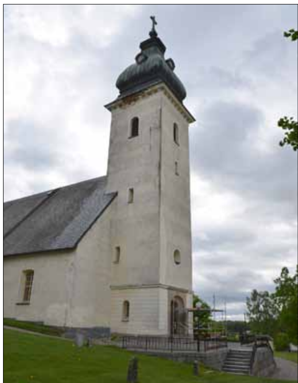
2 Bettna kyrka från nordväst före igångsättandet av arbetena (Slm D11-739).
