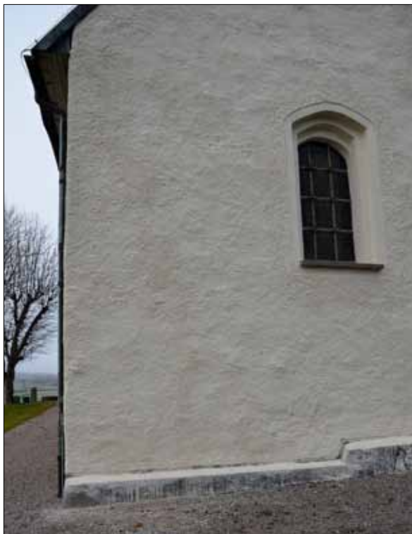
10 Korgavelns södra sida efter fasadrenoveringen (Slm D11-743).
