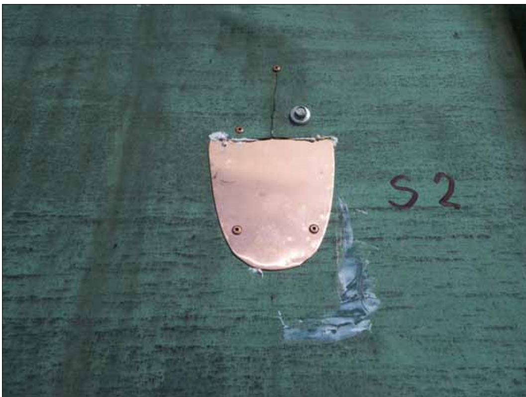
8 Färdigställd lagning. Foto: Ulf Posse, Bettna Byggplåt.
