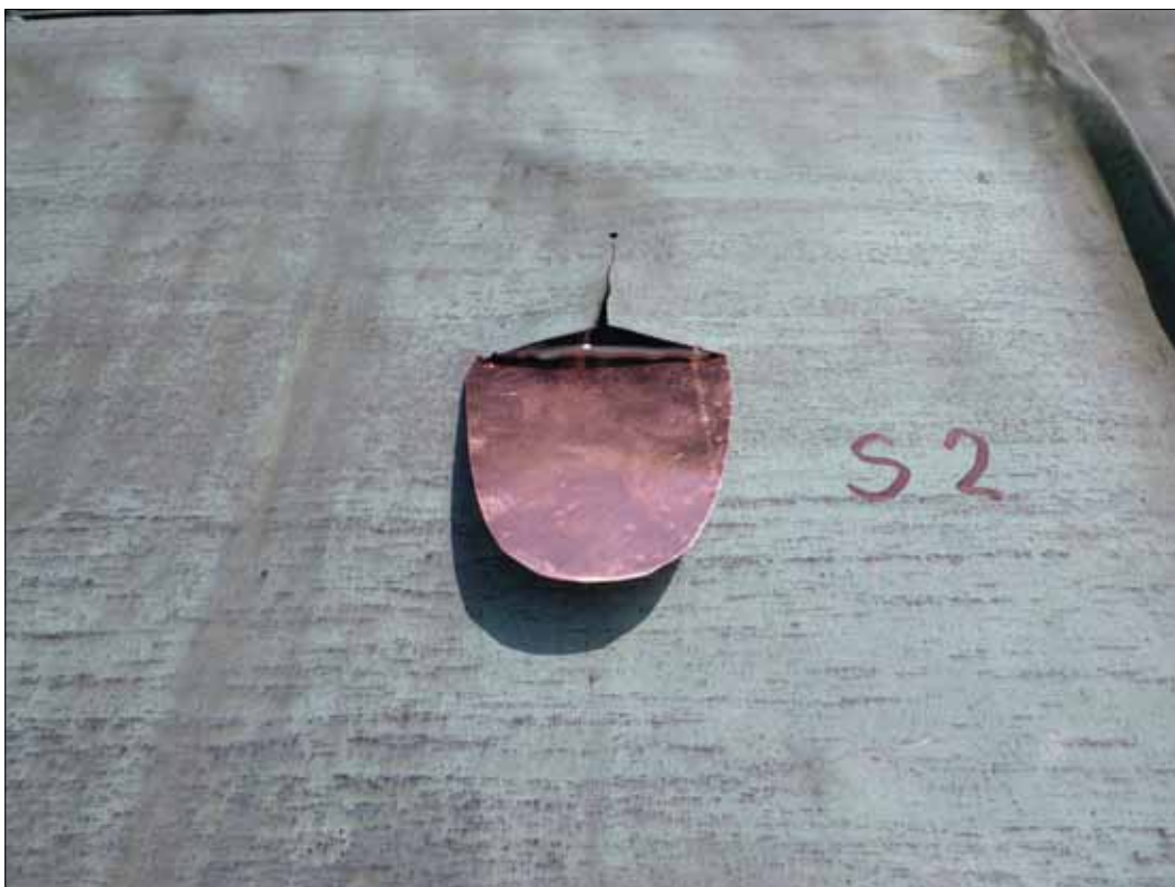
7 Insticksplåten på plats. Foto: Ulf Posse, Bettna Byggplåt.
