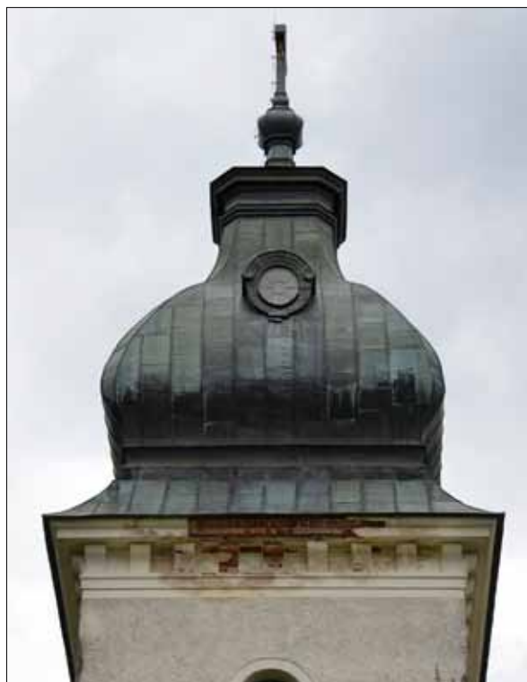
3 Omfattande putsador fanns vid taklist på tornets norra fasad (Slm D11-740).
