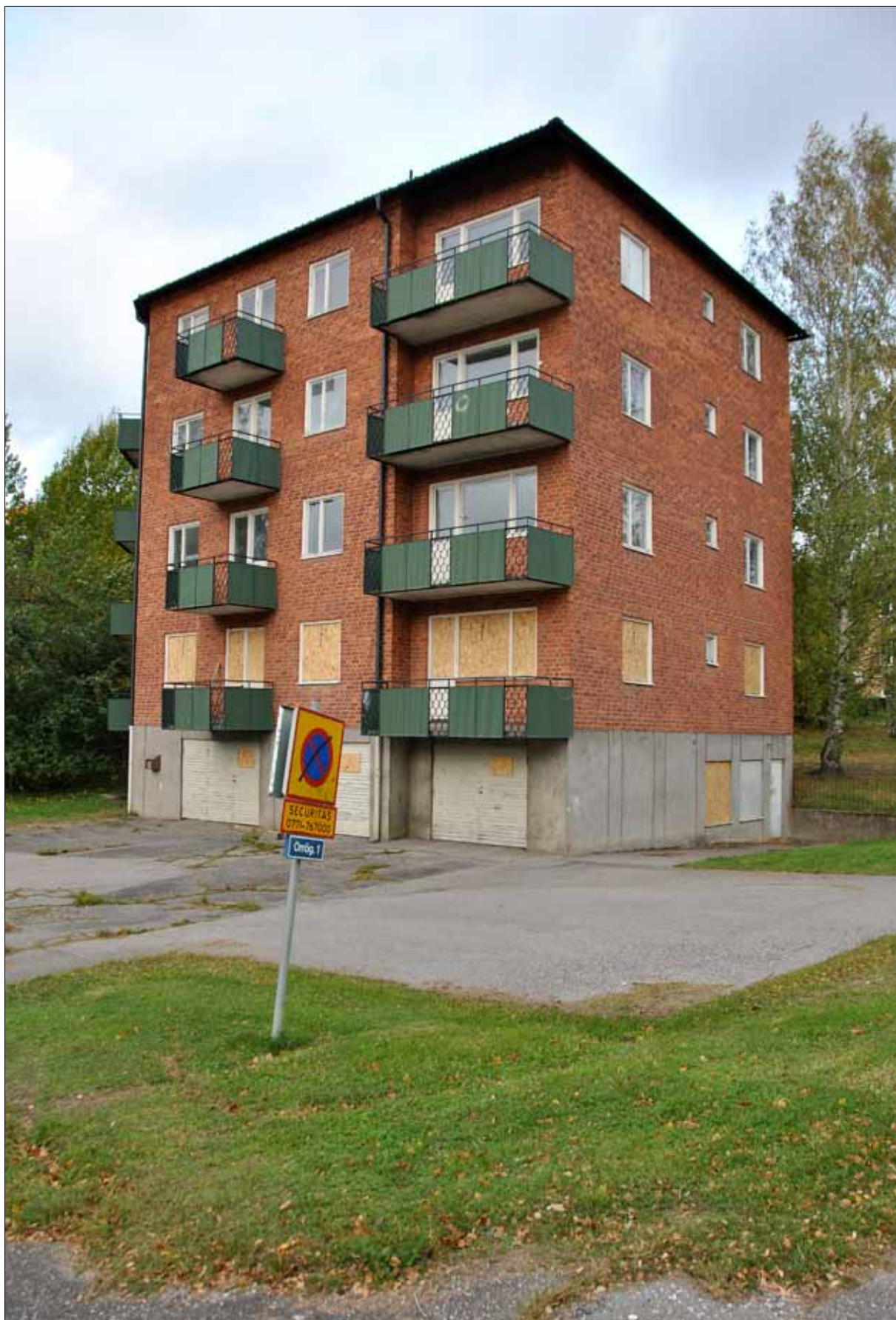
59 Fastigheten Vårlöken 7 i delområdet Orrö är ett av flera exempel på välbevarade flerbostadshus från mitten av 1900-talet. Framtida renoveringsinsatser bör göras med hänsyn och respekt till byggnadernas kulturhistoriska värden. Foto: Dag Forssblad, Sörmlands museum (Slm D11-082).
