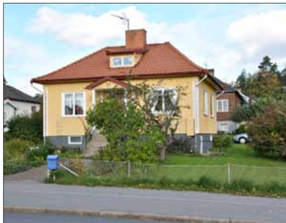
35 Fastigheten Kronan 10 (Slm D11-063).
