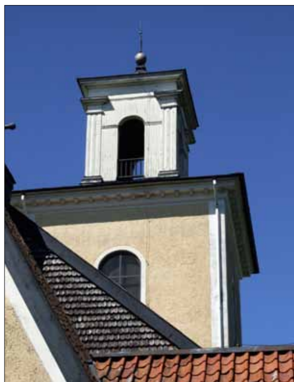
19 Tornet och tornlanterningen före restaureringen (Slm D11-188).
