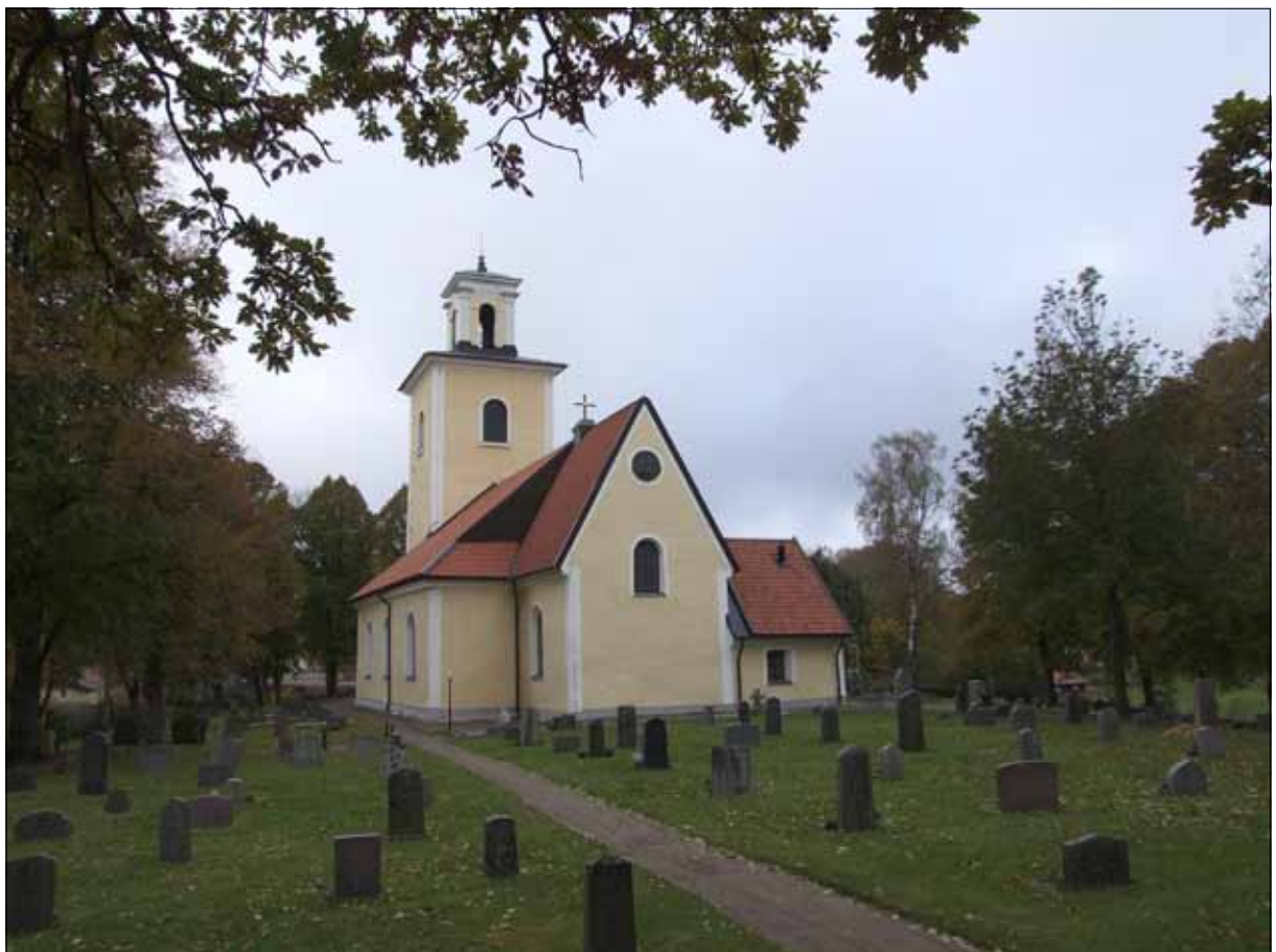
2 Dunkers kyrka från sydost efter avslutade arbeten i oktober 2009 (Slm D11-171).
