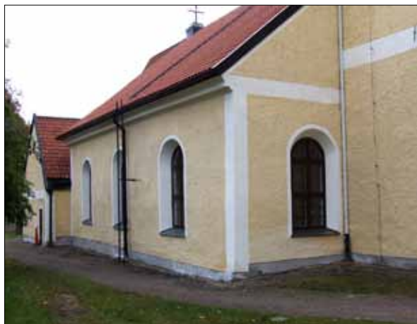
5 Kyrkans norra sida efter avslutade arbeten i oktober 2009 (SIm D11-174).
