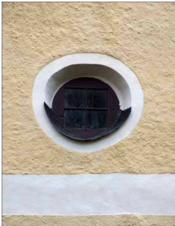
24 Fönstret på tornets östra fasad var tidigare vitmålat. Vid restaureringen målades det i samma kulör som övriga fönster (Slm D11-193).
