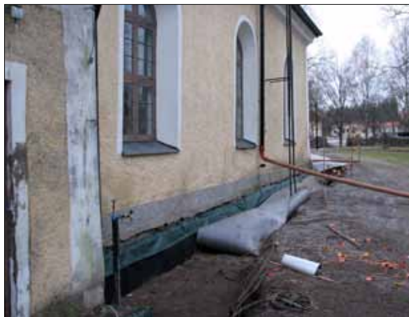
3 Långhusets norra fasad i samband med återställning av mark efter montering av nya tätskikt och markisolering (SIm D11-172).
