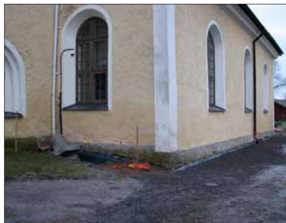
13 Återställt schakt längs med långhusets södra fasad i januari 2009 (Slm D11-182).
