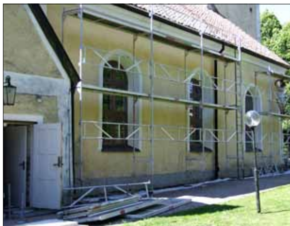
4 Pågående ställningsbyggande på kyrkans norra sida i samband med startmötet den 22 juni 2009 (SIm D11-173).
