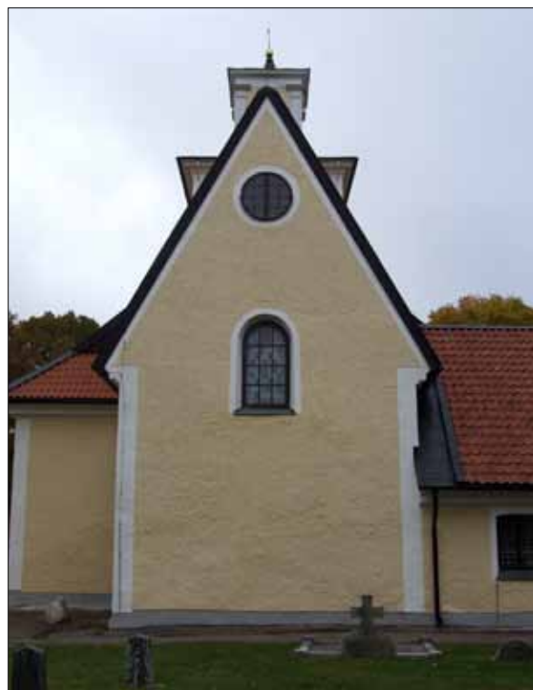
7 Dunkers kyrka från öster vid slutbesiktningen den 20 oktober 2009 (Slm D11-176).
