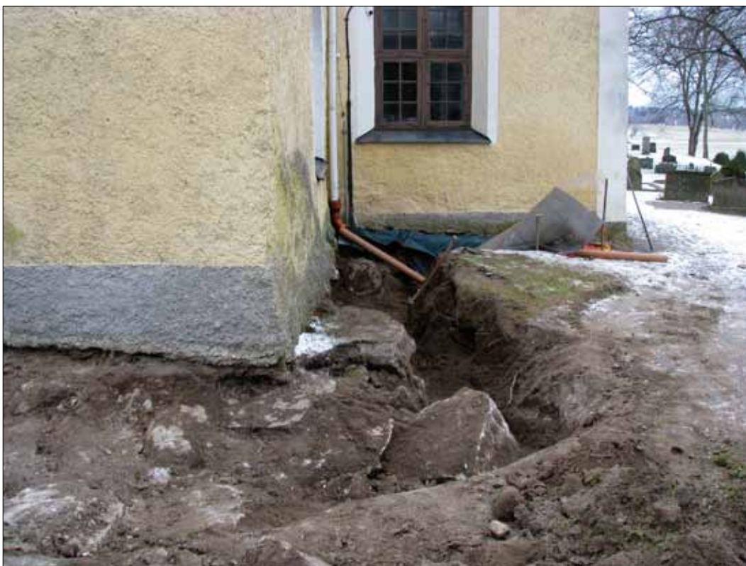
12 Schakt i anslutning till tornets sydvästra hörn i februari 2009. Stenpackningarna vid tornets sydvästra hörn samt längs med västra fasaden tolkades som hörande till tornets grundläggning (Slm D11-181).
