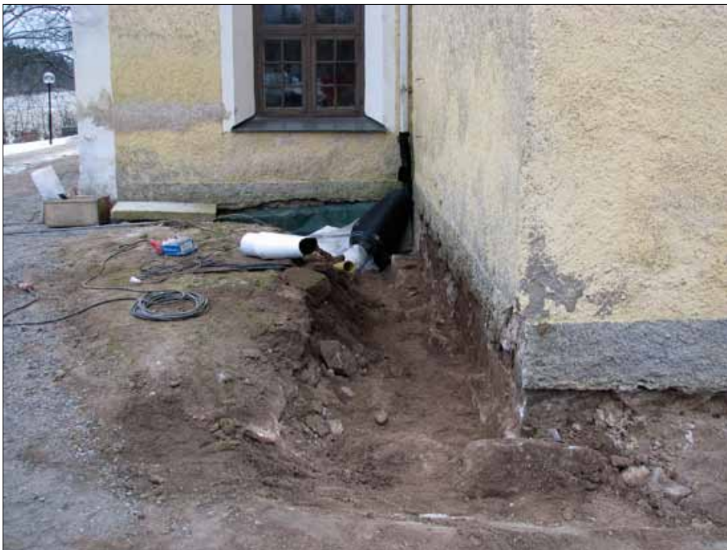
11 Schaktet utmed tornets norra fasad med utskjutande grundstenar synliga vid hörnet mot långhuset (Slm D11-180).
