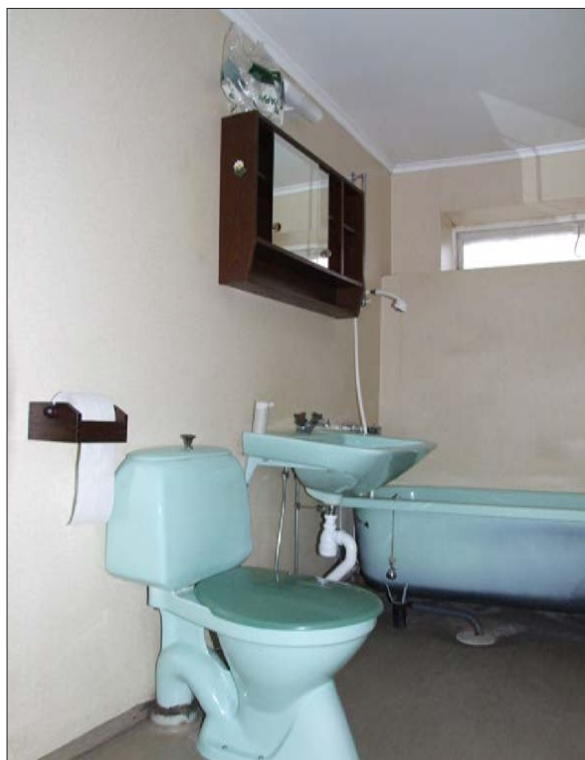
30 Badrummet, rum 02, sett från väster.
