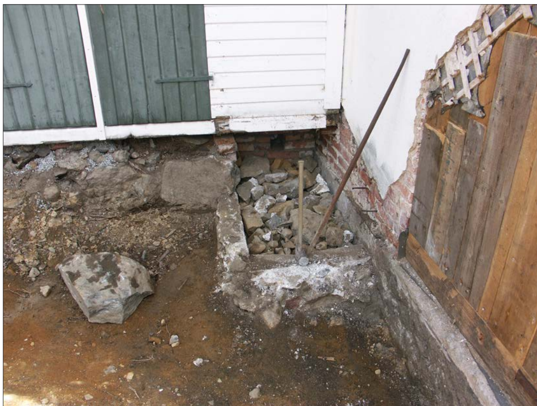
18 Öppningen fylldes med naturstenar och en gjutning gjordes som ett lock ovanpå. Fotografi Eva Wockatz, Sörmlands museum.
