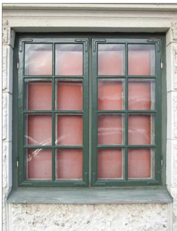
14 I sockelvåningen sitter de gamla fönsterbågarna kvar. Bågarna har nyligen renoverats.
