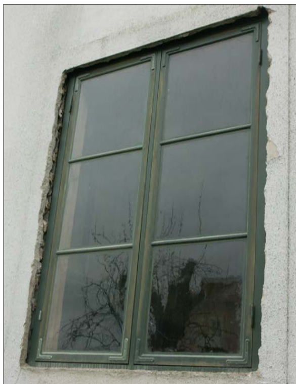
13 November 2008 byttes de kopplade fönstren till nyttillverkade spröjsade. Fotografi Kjell Taawo, Sörmlands museum.
