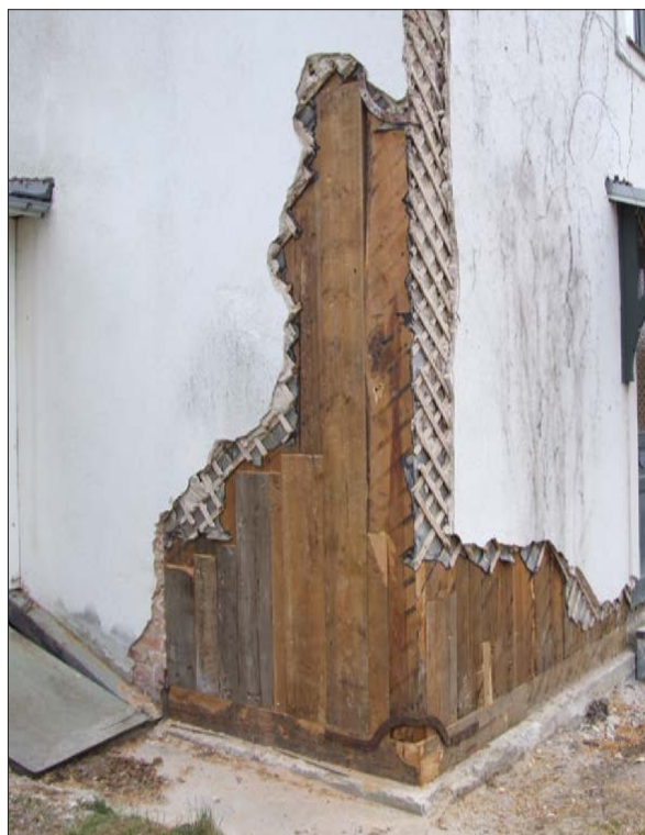
10 Nordvästra hörnet, efter arbeten med stommen våren 2008. Fotografi Eva Wockatz.
