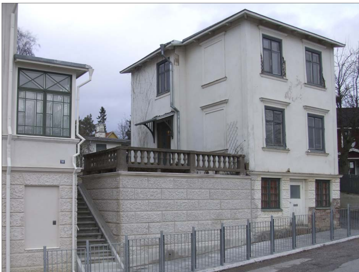
5 Samma vy 2008 (jmf. bild 3). Södra fasadens dörr är utbytt och blindfönstren är överslammade. Fönstren är utbytta till kopplade bågar.
