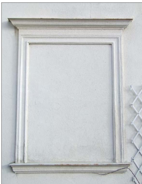
12 Detalj av blindfönster på västra fasaden.
