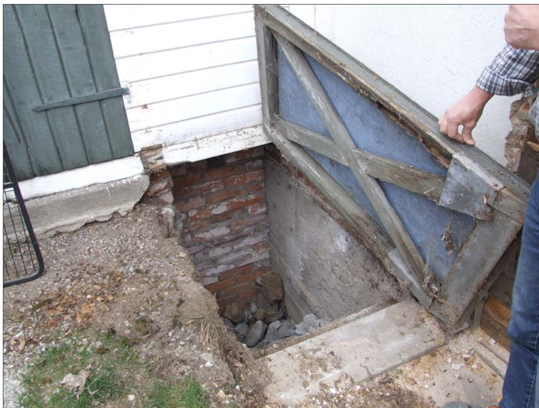
17 Nedgången till källaren vid tillbyggnadens västra fasad, där en lucka i mark dolde en gjuten betongtrappa. Själva öppningen är sedan 1971 igenmurad. Fotografi Eva Wockatz, Sörmlands museum.
