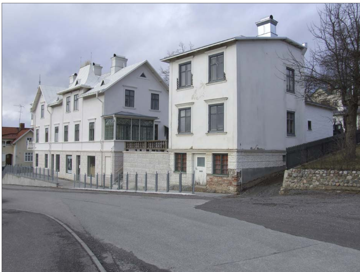
2 Vy av Storgatan 10 sett från öster i februari 2008. I förgrunden syns det senare byggda annexet och bakom den ligger det tidigare byggda huvudbyggnaden.
