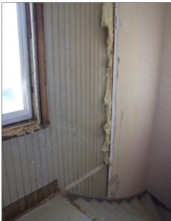
23 Del av trappan sett ned mot våning 1 efter det att skivorna tagits bort. Fotografi Eva Wockatz, Sörmlands museum.
