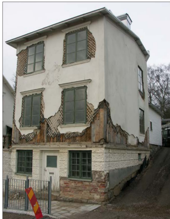
4 Annexet sett från sydost efter stomlagningar och insättning av nya fönster i december 2008. Fotografi Kjell Taawo.
