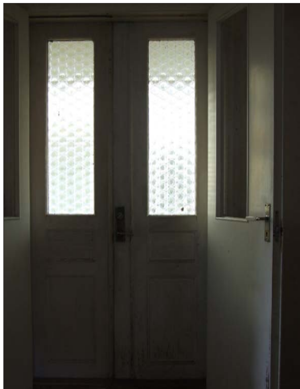
34 Ytterdörren består av en utåtgående pardörr, med inåtgående innerdörrar.
