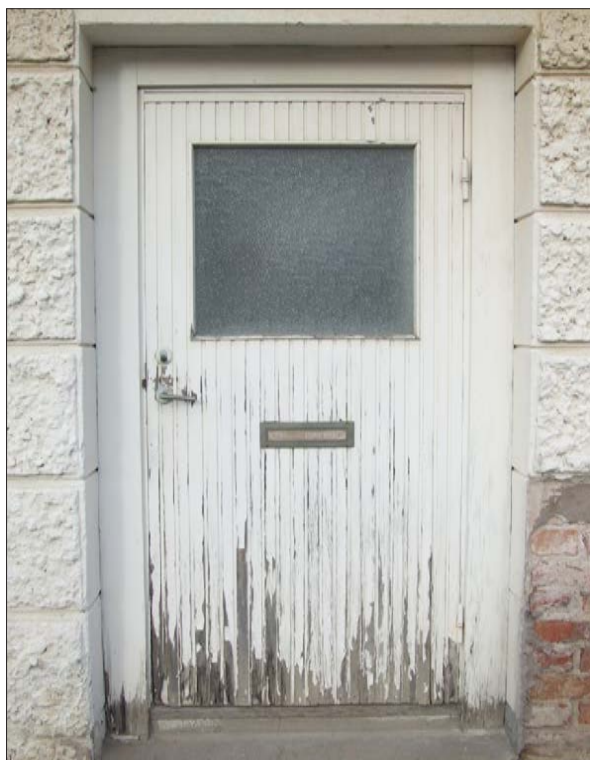
9 Ingången mot Storgatan, södra fasaden. Dörren är bytt vid renoveringen 1971.
