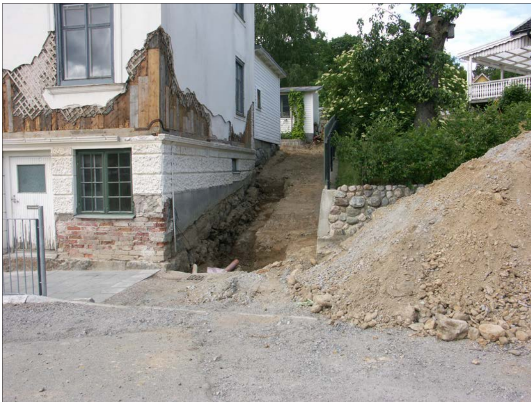
20 Grävningen för dräneringen utefter östra fasaden. Fotografi Eva Wockatz, Sörmlands museum.
