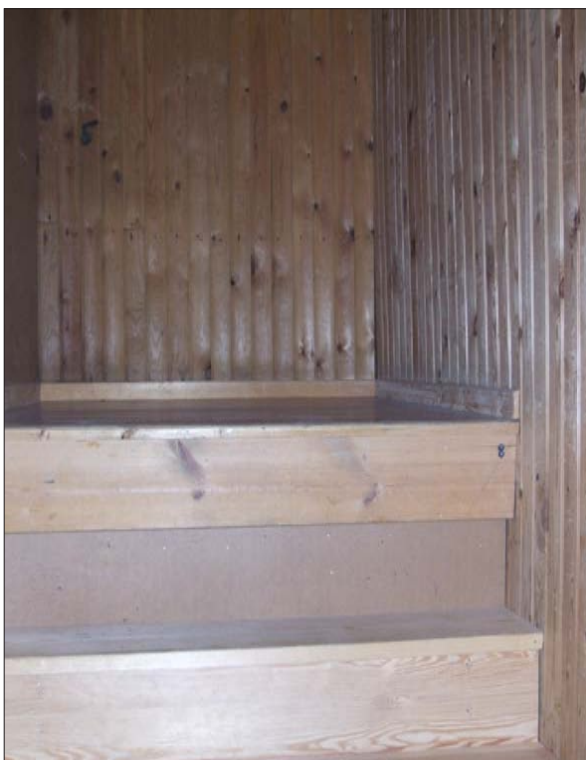
40 En ursprunglig klädkammare är byggd ovanför trapploppet, rum 201a.
