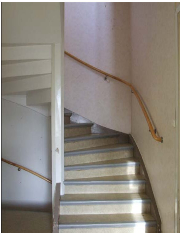
32 Rum 101 sett upp i trappan mot andra våningen.
