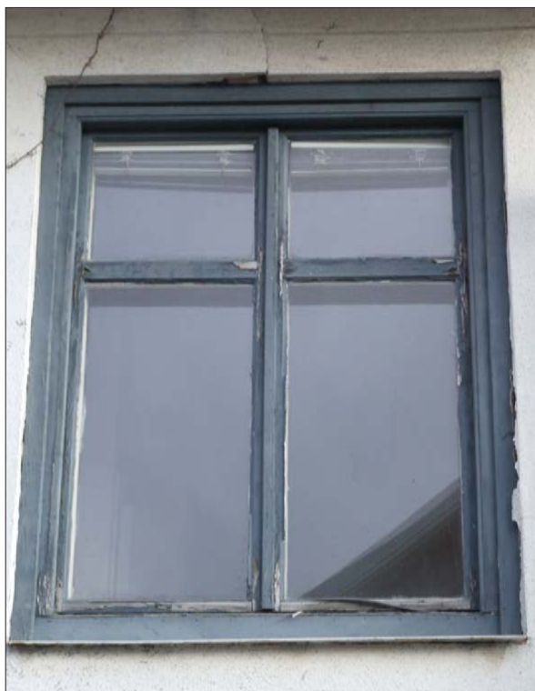
11 1971 sattes nya kopplade fönsterbågar in med instickskarm.
