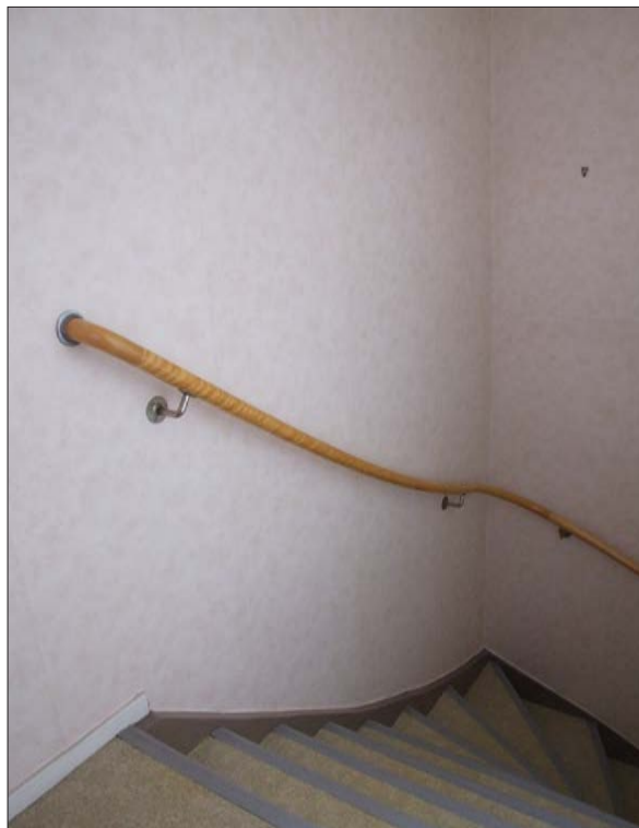
41 Rum 201 sett ner i trappan mot första våningen.
