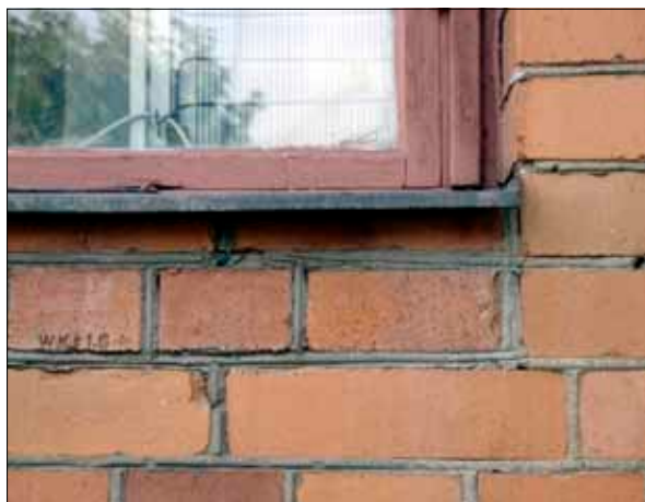
15 Hotellets fönsteröppningar förminskades vid renoveringen 1960.
