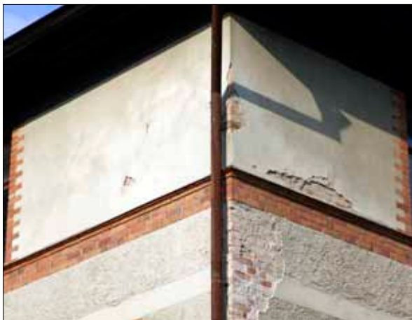
88 Partier med bortfallen puts på hotellets västra och södra fasader.
