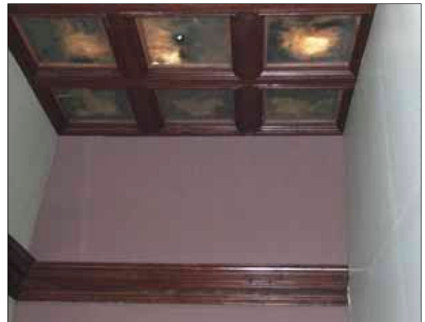
58 Glasat, värmeisolerat kassettkak i rum 301.
