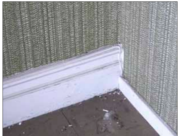
73 Möte mellan ursprunglig golvsöcket och golvsöcket uppsatt i samband med ombyggnaden 1960, rum 312.
