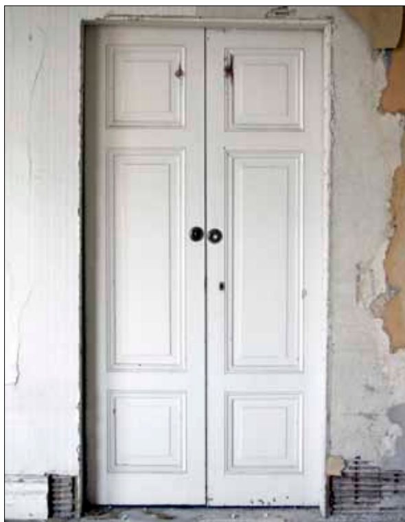
80 Originalpardörr mellan rum 205 och 206 på det första våningsplanet.
