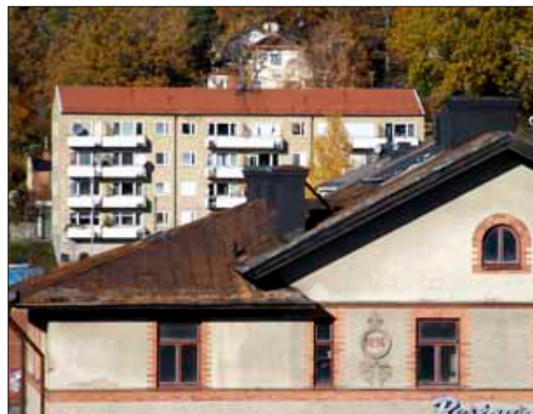
87 Yttertakets skivtäckning av svartplåt, här på hotellets sydvästra sida.
