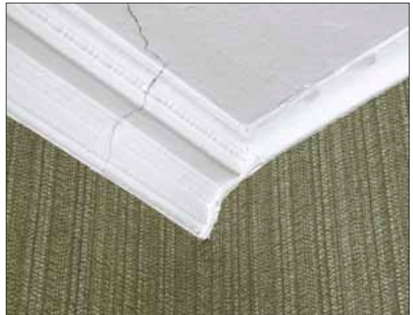
72 Möte mellan ursprunglig taklist och taklist uppsatt i samband med ombyggnaden 1960, rum 312.
