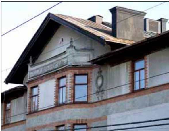
10 Burspråk och balustrad på hotellets norra fasad från nordväst.
