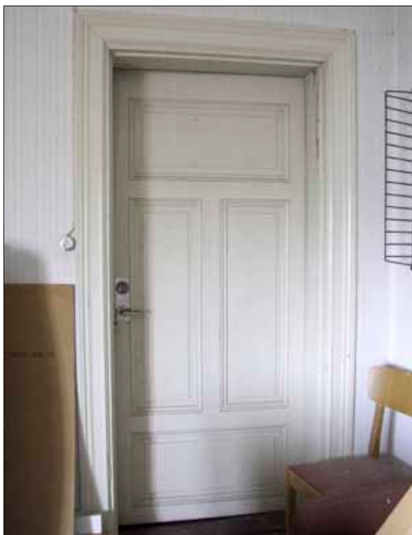
81 Originalenkeldörr i rum 402 i vindsvåningen.
