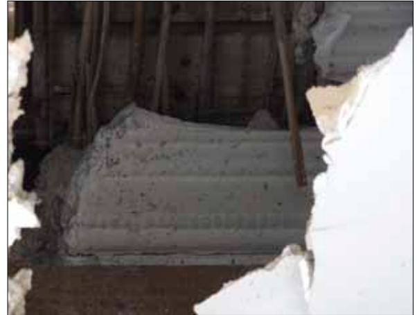
57 Bevarad taklist under sänkt tak i R314a, badrum från renoveringen 1960.
