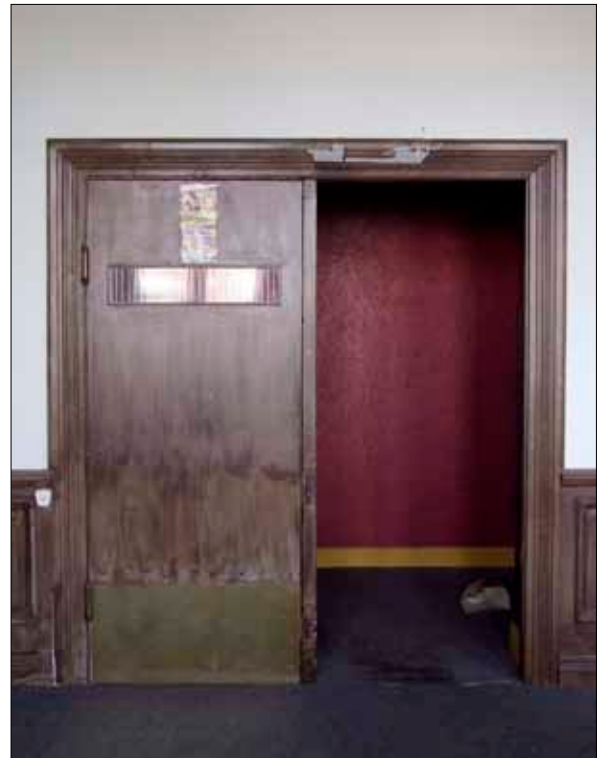
28 Dörr mellan rum 103 och 108.
