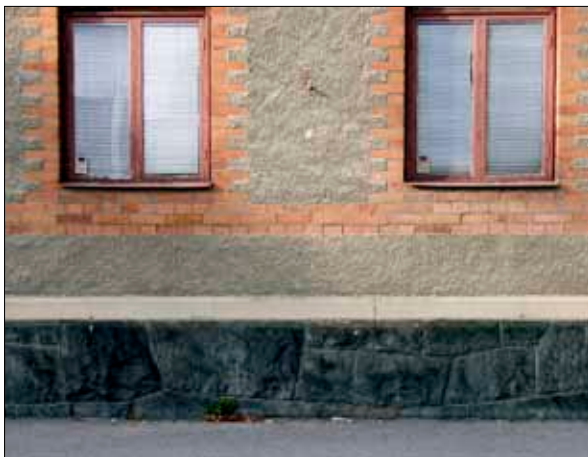
9 Sockel och sockellist på hotellets södra fasad.
