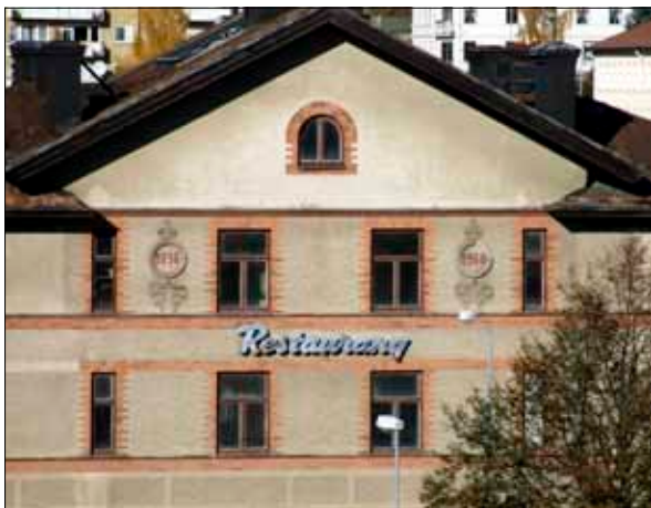
11 Hotellets södra fasad från sydväst.
