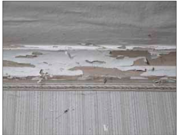
78 Rummets enkla taklist med hålkälsprofil.
