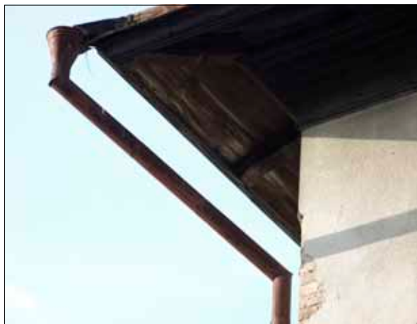
16 Äldre stuprör med raka knän i byggnadens sydvästra hörn.
