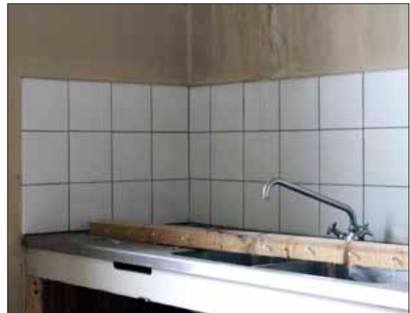
53 Kaklat väggparti vid diskbänken i rummets sydöstra hörn.
