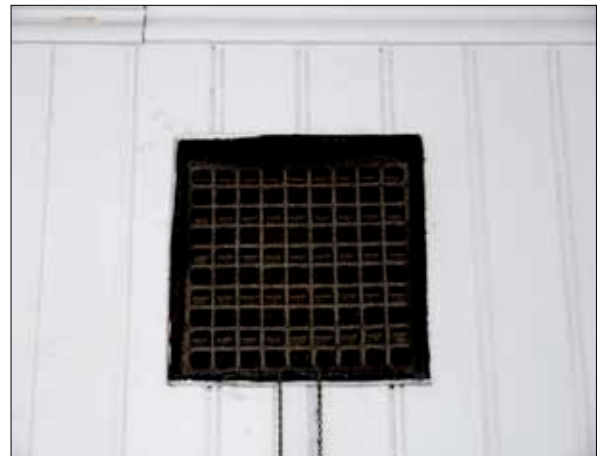
33 Ventilationsgaller i västra väggen.
