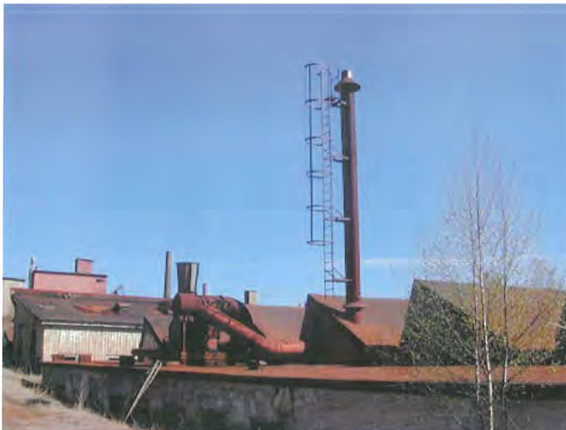
91. Under 1970-talet flyttades galveriet in i tidigare verkstadsutrymmen vilket bland annat resulterade i rörinstallationen på bilden. I bakgrunden syns den gamla galveribygnaden av trä. Båda utrymmena hotas av rivning.
