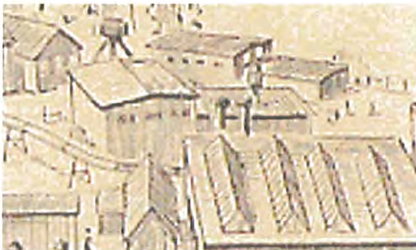
50. Sandblandningsbyggnaden uppfördes något tidigare än övriga byggnadsdelar i längan. I detta utsnitt av en avbildning från 1954 ligger byggnaden fortfarande ensam (fj. fig. 11 s. 9).
