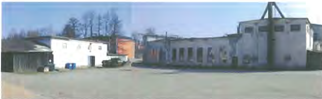
16. Panorama över planen framför vattenverket. Det finns en dynamisk samspel mellan vattenverksbyggnaden och den välvda byggnaden med dess uppskjutande partier på ömse sida om en lågdel. Detta är en av de platsbildningar på området som ur strikt arkitektonisk synpunkt fungerar bäst. Den välvda formen på byggnaden till höger i bild är tillkommen genom att byggnaden byggts ut i etapper utmed en spårkurva till ett befintligt stickspår på området. Såväl vattenverk som högdelen på byggnaden till höger hotas nu av rivning.
