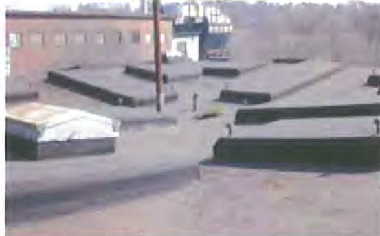
71. Igensatta takfönster på den äldsta verkstadsdelen (jfr. fig. 68, den plana takdelen på byggnadskroppen t.h i bild)
