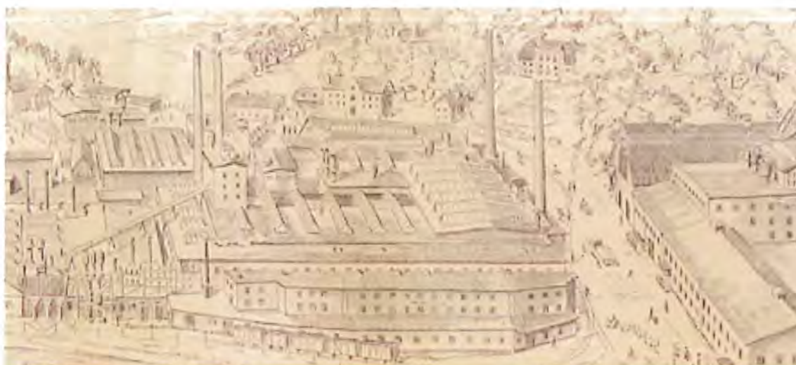
36. Gjuterikomplexet med rördelslagret i förgrunden o ch kupolsmältverket t.h. i bild. Sandfickorna till blästern nere t.v. i bild. Sanden tillfördes från sandberedningstornet (utsnitt från avb. 1954, jfr. fig 11 s. 9)
