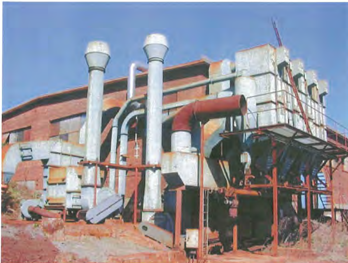
62. Det f.d lagret och avsyningsbyggnaden från söder. I förgrunden syns ett stoffilter för utsug från byggnaden i fråga.
