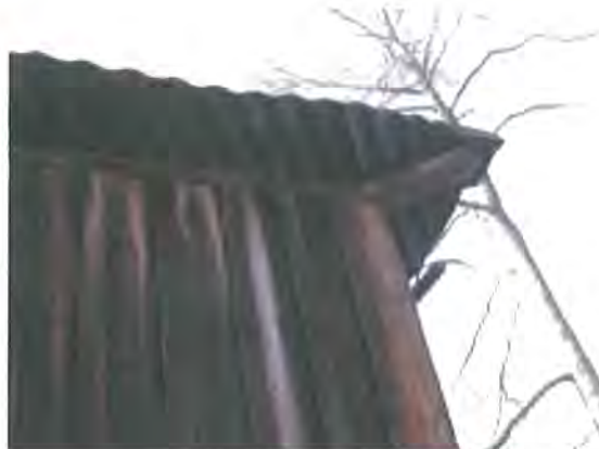
82. Det sinuskorrugerade plåttaket är monterat direkt på takstolarna.
