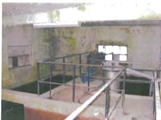
55. Vattenverket. Södra basängrummet.
