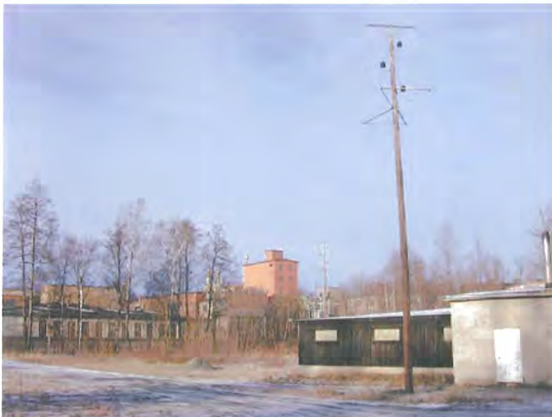
101 Den metod för marksanering som valts för tjärtippen innebär att marknivån höjs med ett antal meter samtidigt som byggnader och anläggningar på och i anslutning till tippen rivs eller begravs av massorna. De anläggningar som berörs är flaskboden bergrummens ingång från väster samt transformatorstationen.
