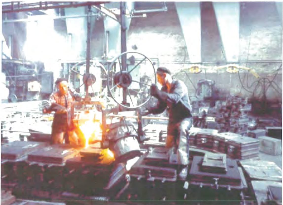
7. Interiör från gjuteriet, 1950-tal eller tidigt 1960-tal. Produktionslinjen på bilden levererades från USA 1949 och kom att få beteckningen Mek 49. (Foto: Hälleforsnäs bruksmuseum).
