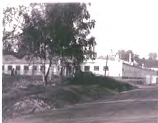
72. Den nordliga, äldsta delen av verkstadskomplexet uppfördes 1935 (Foto: Hälleforsnäs bruksmuseum)
