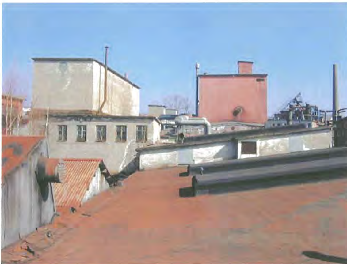
98. Gasverksbyggnaden (högdelen t.v. i bild), sandberedningstornet t.h. samt samtliga takytor hitom dessa byggnadsdelar är hotade av rivning. 2003 inlämnades till Flens kommun rivningslovsansökan på allt synligt i bild utom sandberedningstornet och kupolugnshusets rörinstallationer med skorsten längst bak t.h. i bild.respektive den tegelgavel som skymtar vid sidan om gasverket och bakom björkarna längst t.v. i bild
