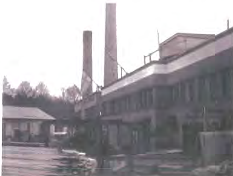
35. Den byggnadskropp som fortfarande är belägen där masugnsbyggnaden tidigare legat. stod färdig före branden år 1934. Fotot är taget 1934, sannolikt är det tillkommet i samband med invigning av byggnaden.. Ännu år 2002 finns rester kvar av 1800-talets masugn innanför den funktionalistiska fasaden. (Foto: Hälleforsnäs bruksmuseum).
