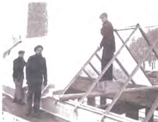
73. Takfönster under uppförande 1935 (Foto: Hälleforsnäs bruksmuseum)
