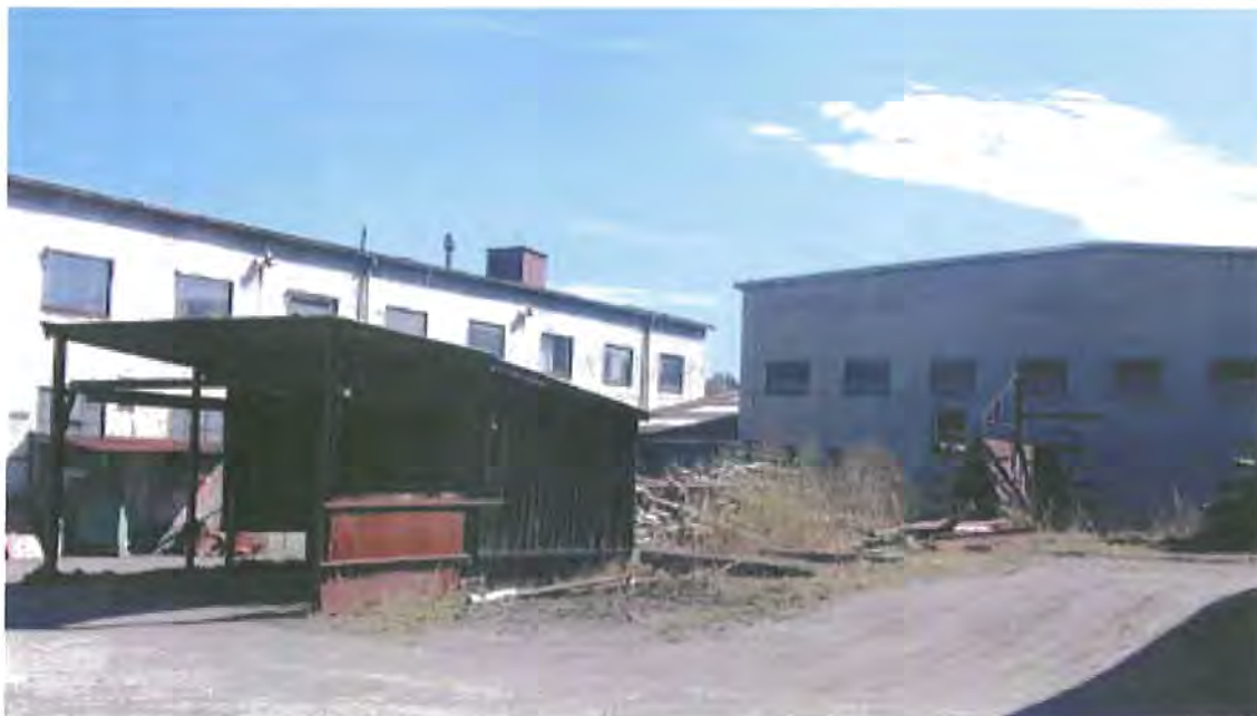
64. Skjul och metallupplag. I bakgrunden t.v ritkontoret samt t.h. byggnad innehållande aduceringsugnar och värmebehandling.
