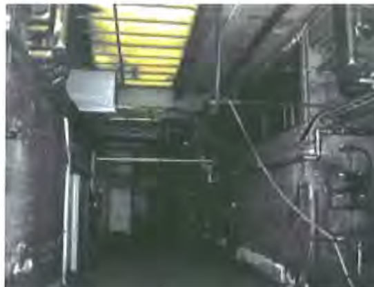
52. Ytterfasad har blivit innervägg. Väggen t.h. i bild har tidigare utgjort yttrevägg till den byggnad man ser det plana taket på i förgrunden t.h, fig. 50. Utrymmet innanför denna vägg har av arbetarna kallats Sibirien. Utrymmet är ljussatt genom nu igensatta takfönster samt får sekundärljus via fönstren på bilden.
