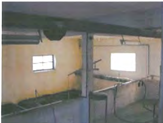
56. Vattenverket. Norra basängrummet.
