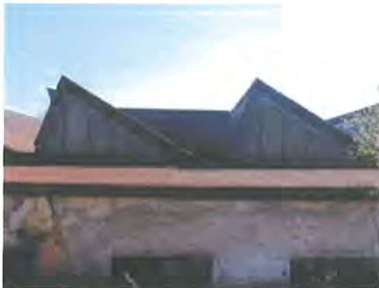
70. Sågtandstak på västra verkstadslängan.
