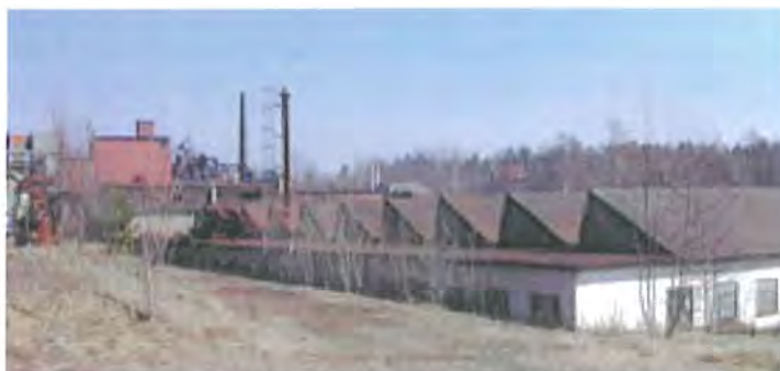
67. Verkstadskomplexet från sydväst. Sågtandstaken är karaktärsgivare för bruksområdet till sin helhet samt detta avsnitt av anläggningen i synnerhet.
