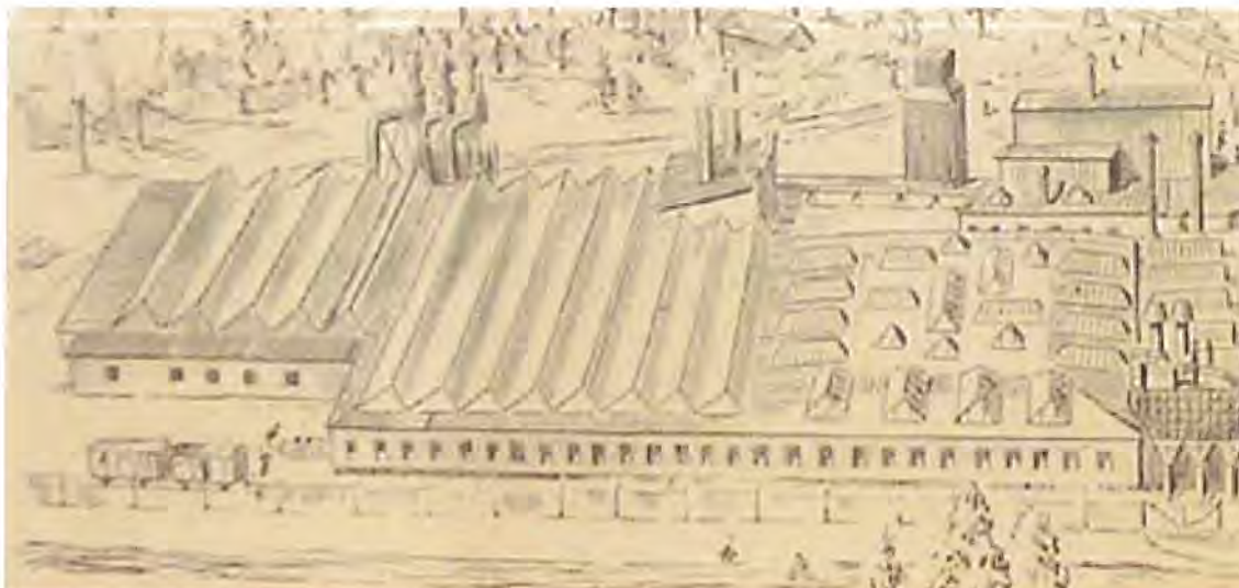
68. Verkstadskomplexet sett från öster 1954. Gårdsbildningen i sydost byggdes under 1960-talets mitt igen med en anpassad byggnadskropp vilken dock gavs ett sadeltak istället för sågtandstak (jfr fig 69 nedan resp. fig 11, s.9.)
