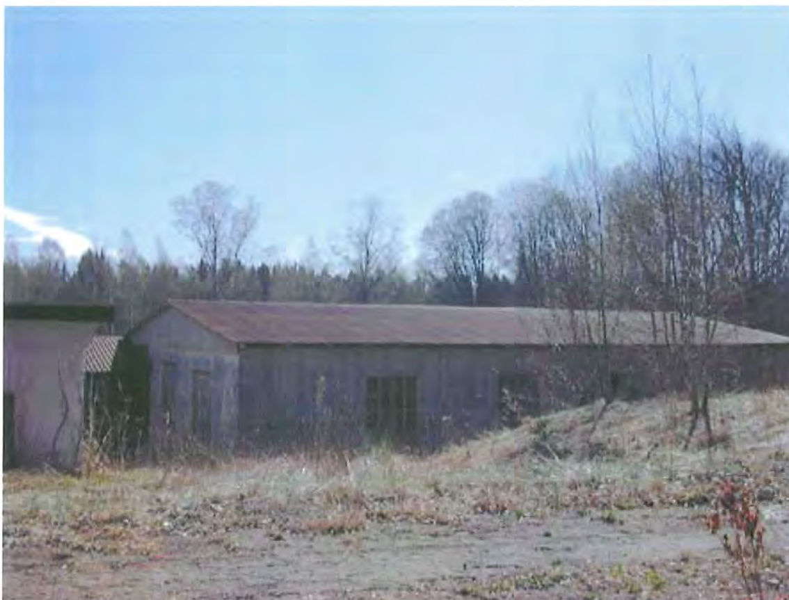
66. Förrådsbyggnad i anslutning till verkstadskomplexet
