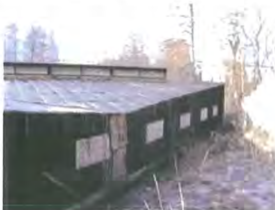
83. Den vinklade lanterninen rider på byggnadens takås vilket innebär att takfallen i motsvarande lägen åt sydväst respektive nordost faller frånnock respektive ner mot en rännadal. Fotot visar rännadalen åt nordost (jfr. motsvarande nock som syns på fig.81 ovan).
