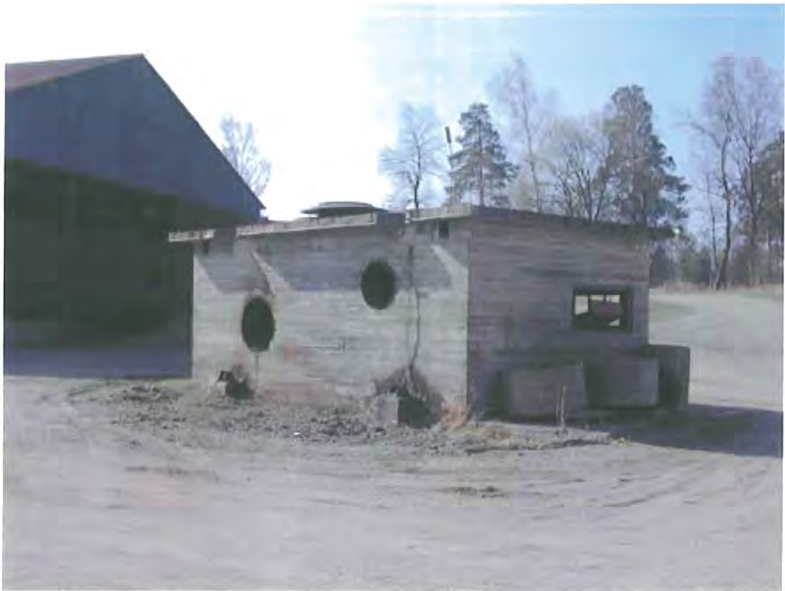
60. Damfilterbyggnaden är uppförd i ett brutalistiskt formspråk. Den råa formgjutna ytan var ett formgivningsideal under 1960-talet.
