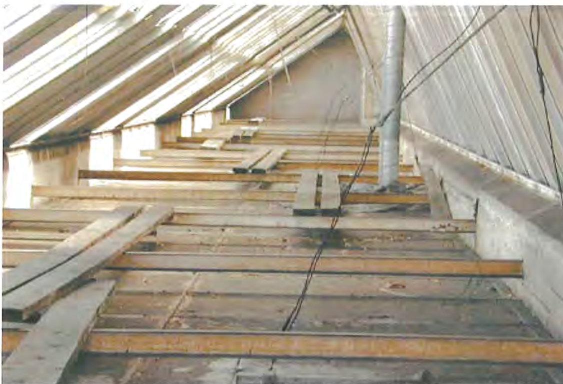
102. Sågtandstak av den typ som har ljussatt den del av anläggningen som hyst reparationsverkstad samt området benämmt Sibirien. Utförandet med horisontella innanbågar ger möjlighet till energihushållning genom monteringen av extra bågar. Konstruktionen är som synes lätt inspekterbar för reparationer och fönsterputs.
