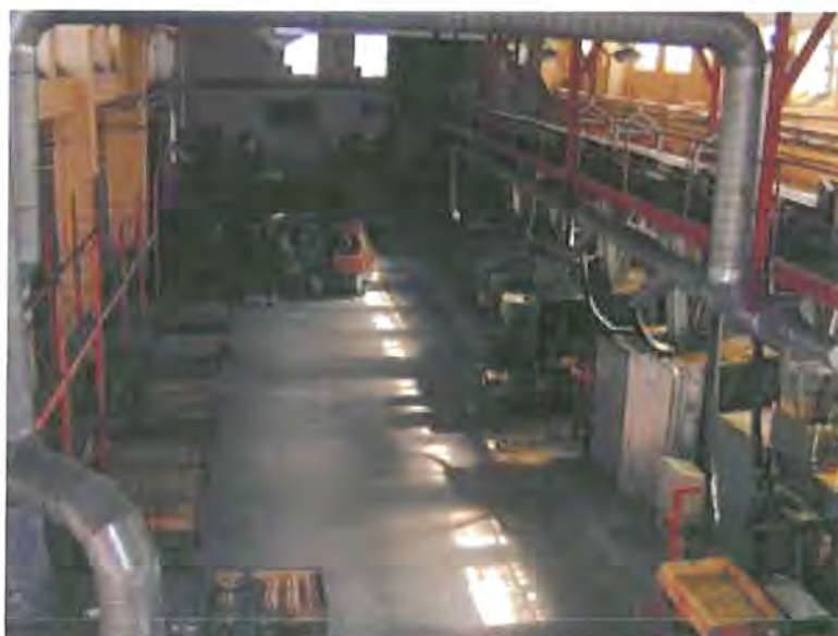
47. Kärnmakeriets produktionslokal år 2002. Lokalen fungerar fortfarande i ursprungligt syfte men maskinpark och produktionsvolym är kraftigt reducerad i jämförelse med tidigare.
