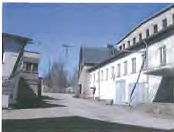
18. Huvudgatan. Ingång till matsal och omklädningsrum till höger i bild.
