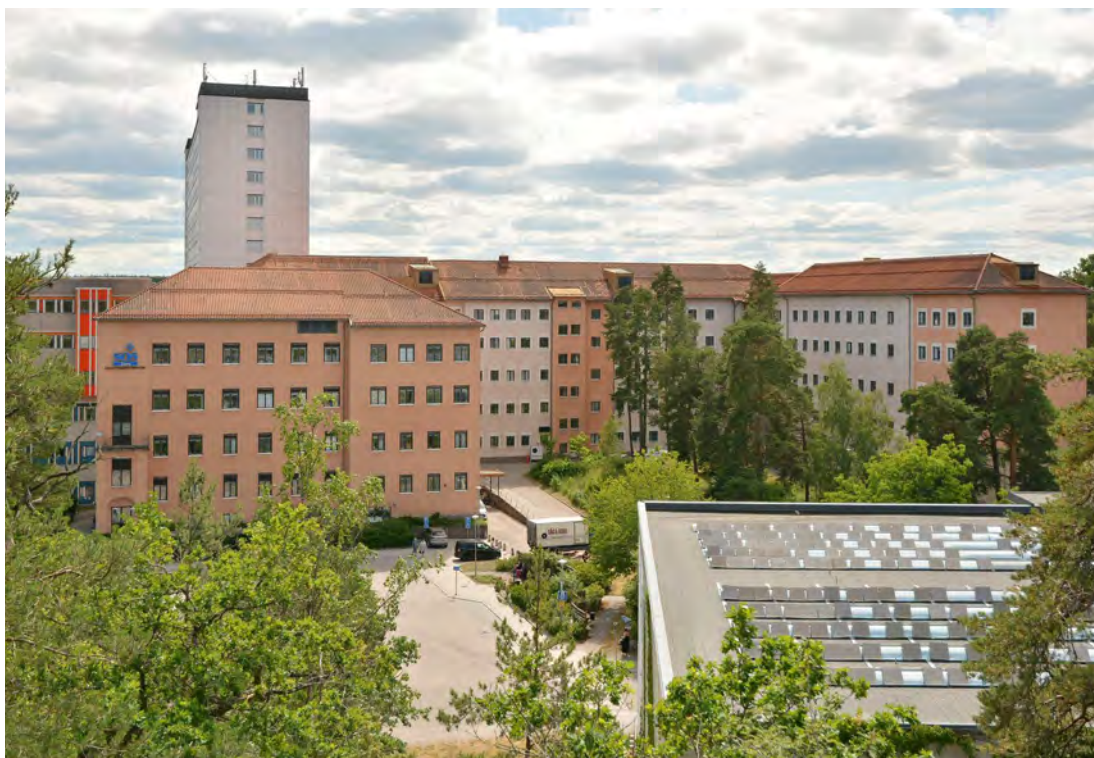
Norra flygeln (till vänster) och västra flygeln (till höger) sett från norr. Samtliga tak är valmade och täckta med enkupigt tegel. Bakom norra flygeln sticker höghuset upp som stod klart 1962. I förgrunden syns ett parkeringshus som ligger vid Kungsvägen. (SLM D2018-0462)
