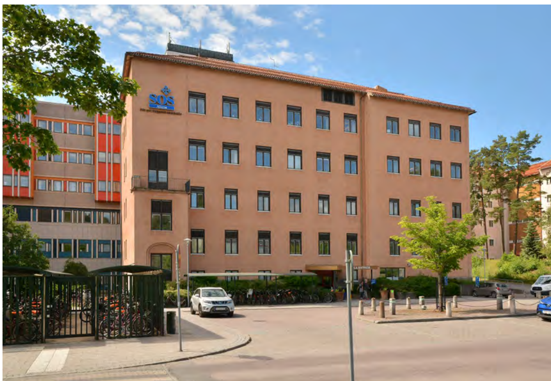
Den norra flygeln sett från norr. "Gamla entrén" syns i mitten av byggnaden, och till vänster ett burspråk med ovanliggande balkong vilket kom till i samband med att huset fick sin nuvarande höjd 1949. Till vänster i bild skymtar de avdelningar som tillkom i slutet av 1970-talet och ersatte östra flygeln. (SLM D2018-0463)
