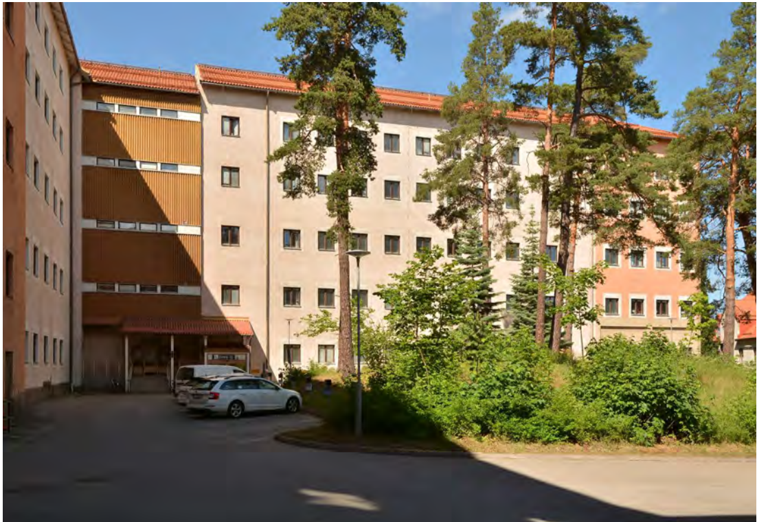
Den västra flygeln sett från öster. Vid den plåtklädda delen i hörnet fanns tidigare indragna balkonger. I förgrunden syns den grönyta som skulle vara möjlig att bebygga. (SLM D2018-0468)
