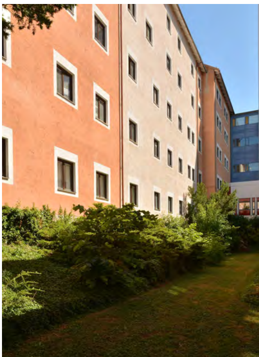
Västra flygelns södra sida, där den möter höghuset vilket skymtar till höger i bild. Lasarettets tidigare huvudentré byggdes för då höghuset uppfördes. (SLM D2018-0467)
