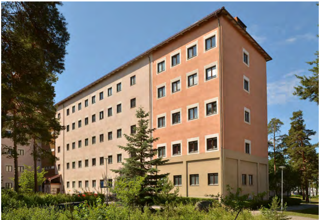
Västra flygeln sett från nordost. Den högra änden uppfördes först i en våning vilken sedan byggdes upp till sin fulla höjd i slutet av 1960-talet. (SLM D2018-0469)
