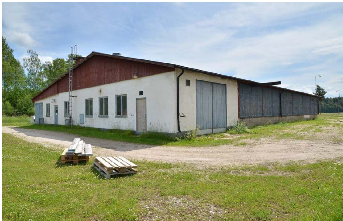
Personal- och verkstadsbyggnaden sett från nordväst. Innanför de tre närmaste fönstren ligger verkstaden med tillhörande ingång och port. Därefter syns längst till vänster fönster och ingång till personalutrymmen och omklädningsrum. Till höger är västra sidans portar till förrådet vilka inte når ner till marken. (SLM D2018-0713)
