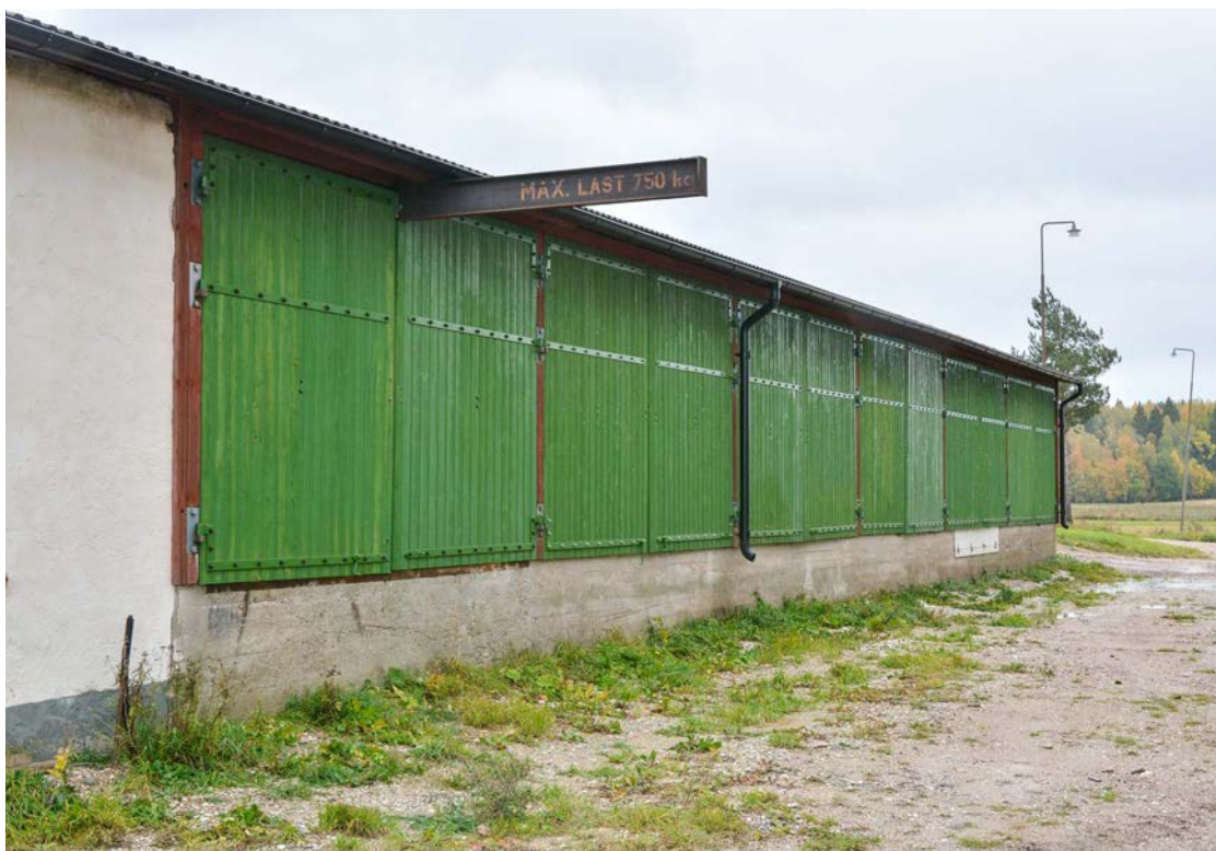
Västra sidans portar till förrådet efter åtgärd. All panel har bytts ut och portarna är målade i den nya färgsättningen. (SLM D2018-0720)
