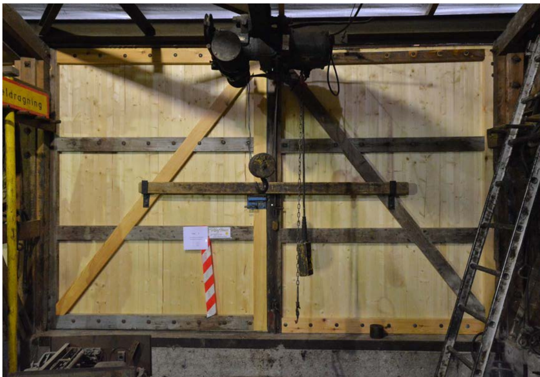
En av västra sidans portar efter åtgärd. Skadat virke i ramverk och panel har bytts ut och skiljer ut sig genom sin ljusa färg. De nya delarnas inpassning till de äldre delarna är omsorgsfullt utförd och utförandet är lika befintligt. (SLM D2018-0721)
