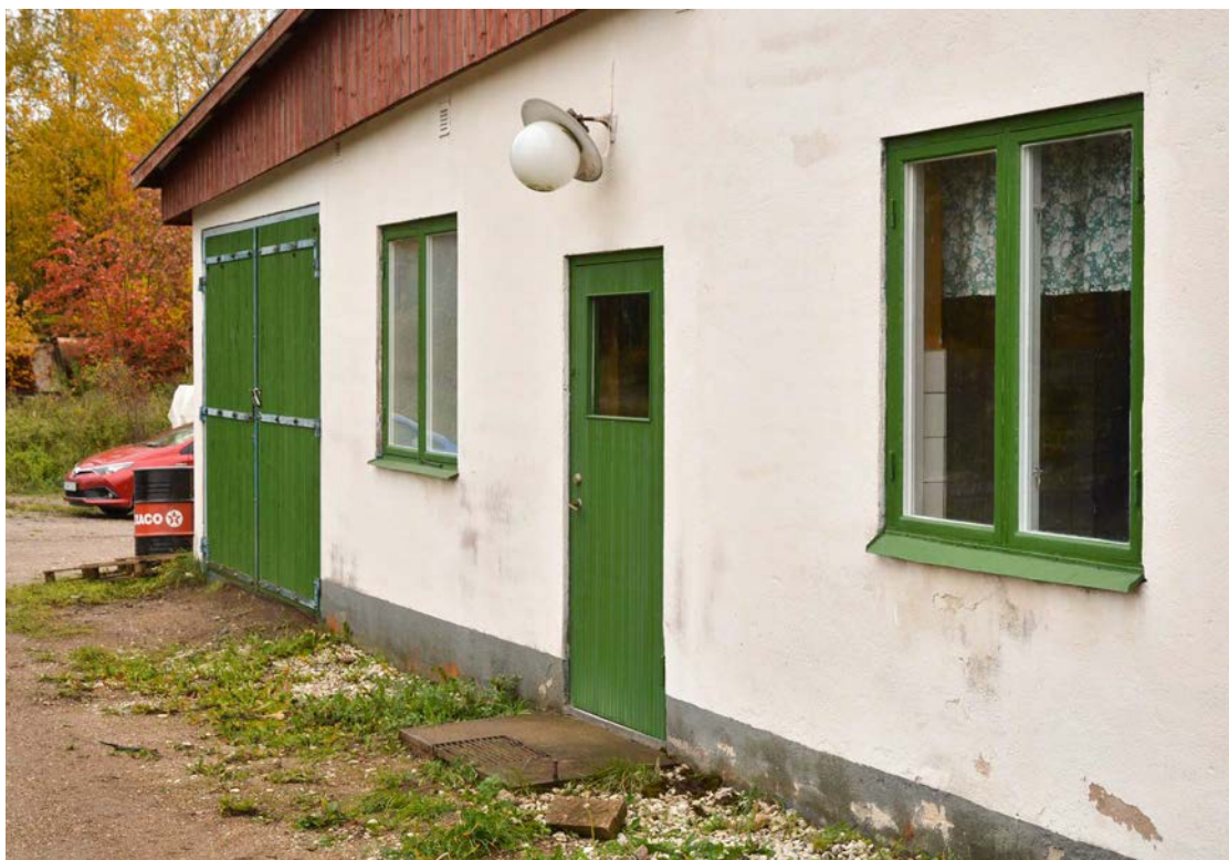
Personalutrymmenas dörr och fönster vid den norra sidan efter åtgärd. Dörren är en nytillverkad kopia av den ursprungliga. (SLM D2018-0724)
