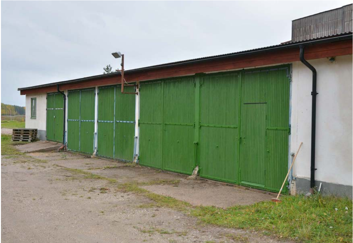
Östra sidans garageportar efter renovering. En del målningsarbeten återstår vilket kommer utföras under följande år. De tidigare ventilationsluckorna täcks nu för av den yttre panelen. (SLM D2018-0722)
