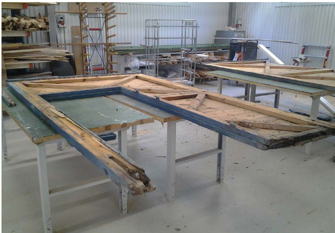
Portarna på snickeriet under renovering. Innerpanelen har plockats bort och konstruktionen är synlig. Foto: Anders Axelsson
