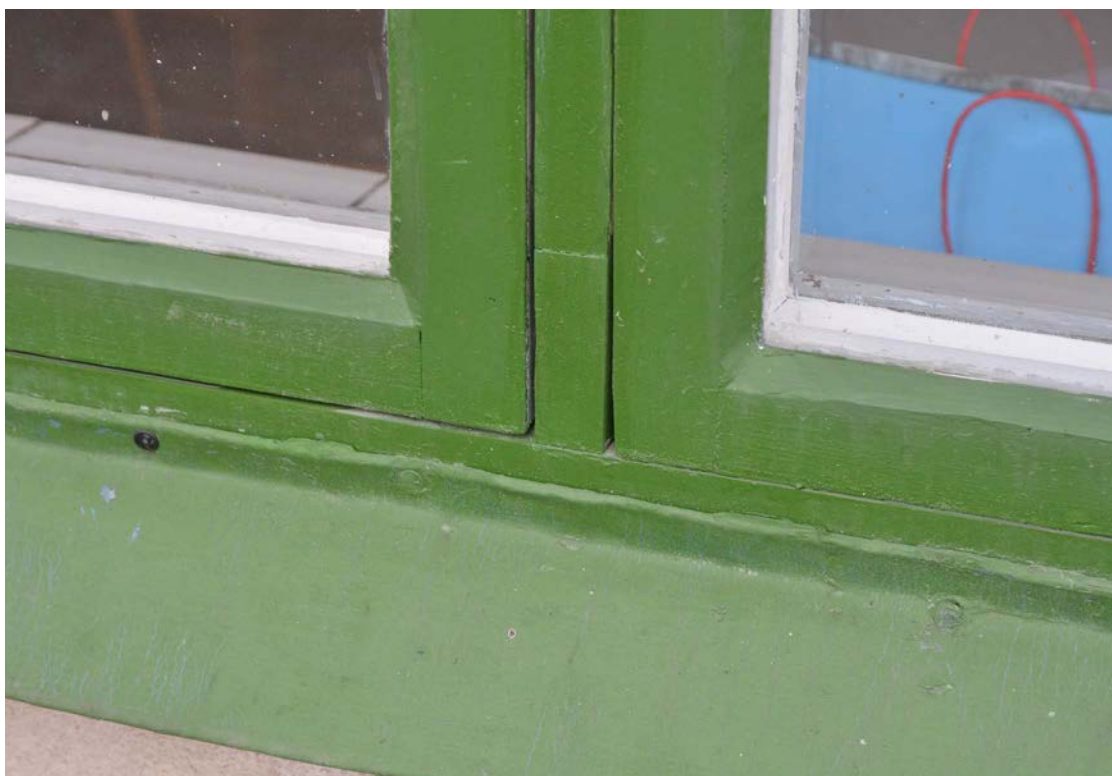
Detalj av ett av norra sidans fönster efter åtgärd. Karmunderstycket är utbytt och en del av mittposten. Fönstren är omkittade och målade utvändigt såväl som på insidan innan glasning. (SLM D2018-0725)
