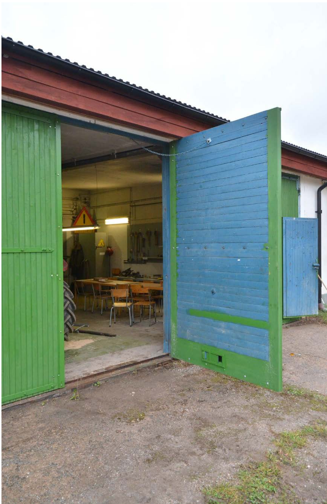
Insidan på en av garageportarna på östra sidan efter åtgärd. De delar av panelen som inte har bytts ut har fortfarande kvar sin blå färg. Nertill syns en av ventilationsluckorna som återmonterats men som idag saknar funktion då öppningen i ytterpanelen ej tagits upp. (SLM D2018-0726)
