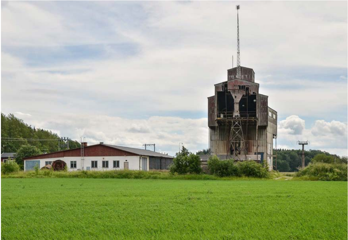
Personal- och verkstadsbyggnaden till vänster och driftstationen till höger. Bilden är tagen före rivningen av bockarna varav en är synlig längst till höger i bild. (SLM D2018-0714)
