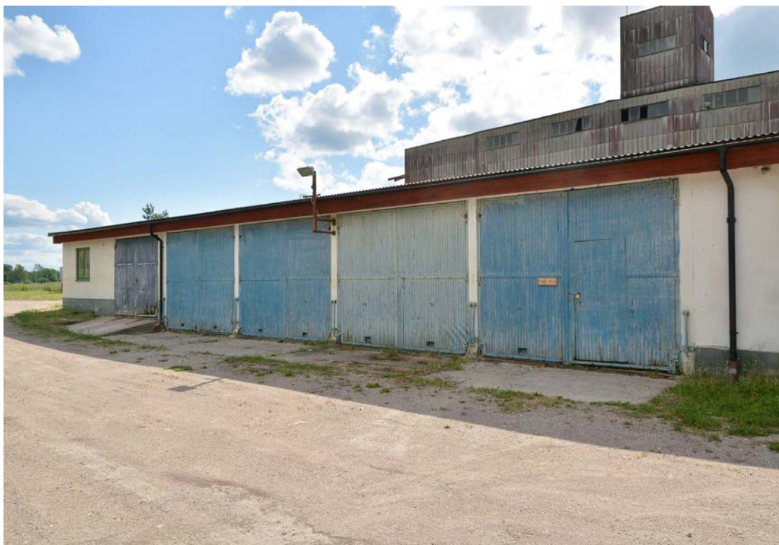
Garageportarna på östra sidan före åtgärd. I bakgrunden syns driftstationen. (SLM D2018-0716)
