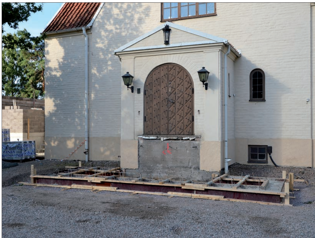
18 Gjutning av den nya trappan till kyrkans huvudingång i augusti 2011 (Slm D13-0077).
