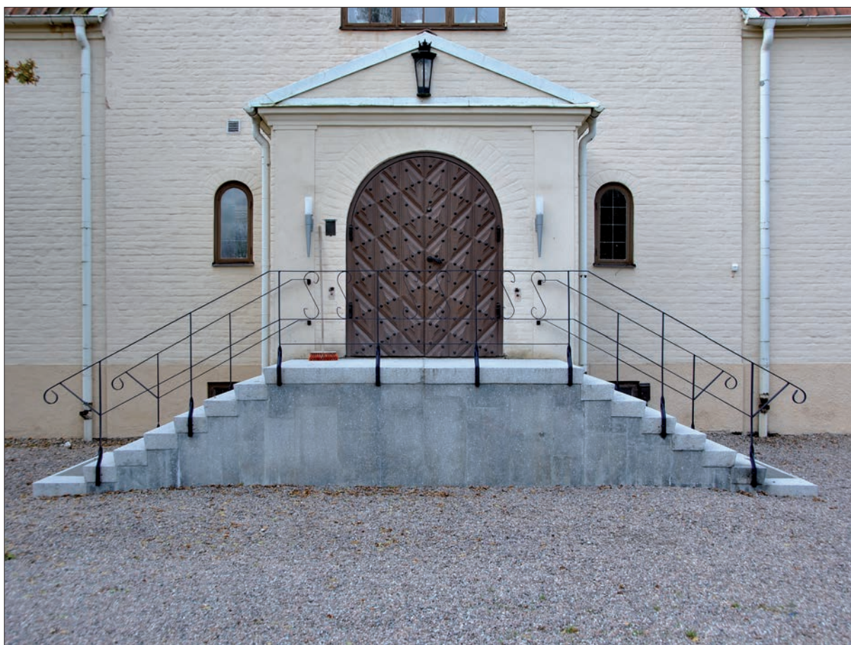
20 Huvudentréns nya trappa vid den antikvariska slutbesiktningen (Slm D13-0079).
