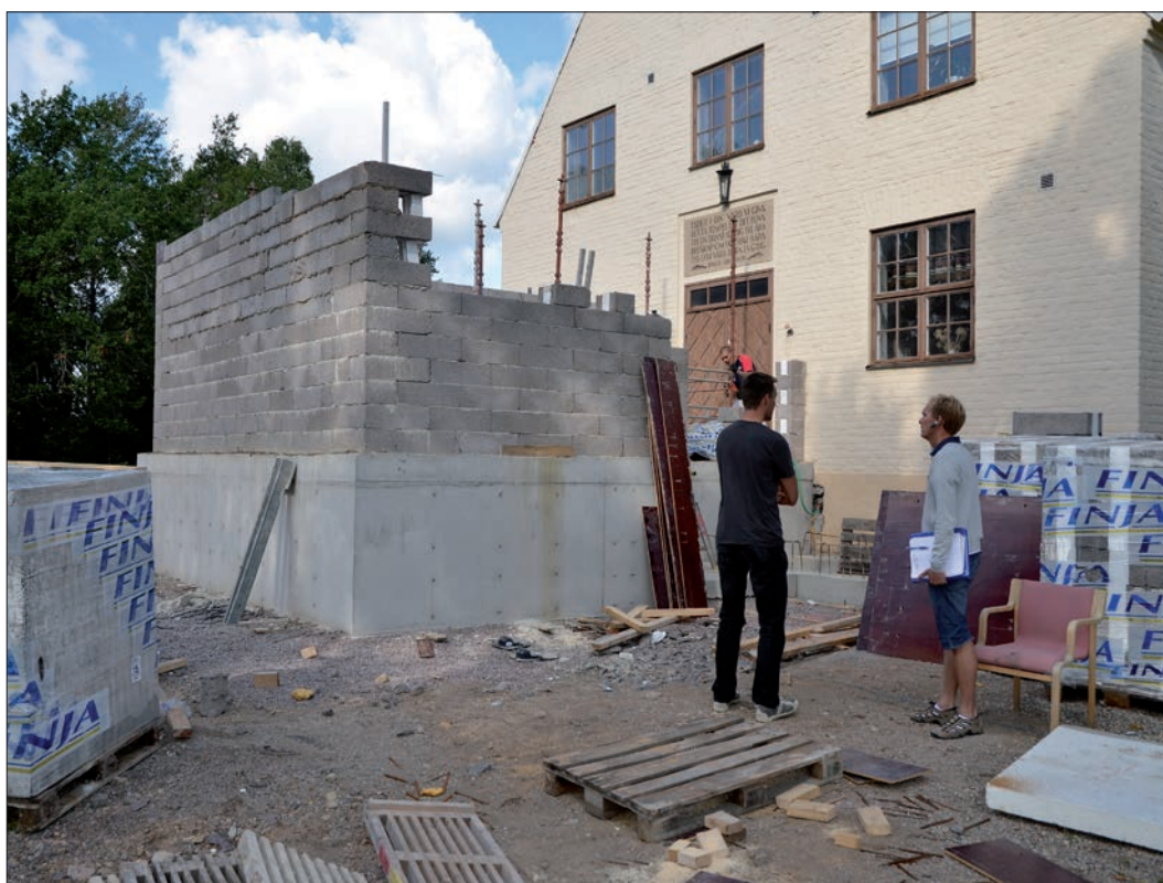
9 Fasadernas stommar uppmurades av Lecablock (Slm D13-0068).
