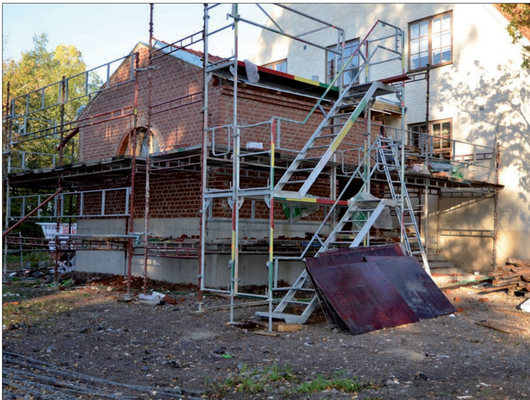
10 I oktober 2011 var tillbyggnadens fasadmurverk färdigmurat (Slm D13-0069).
