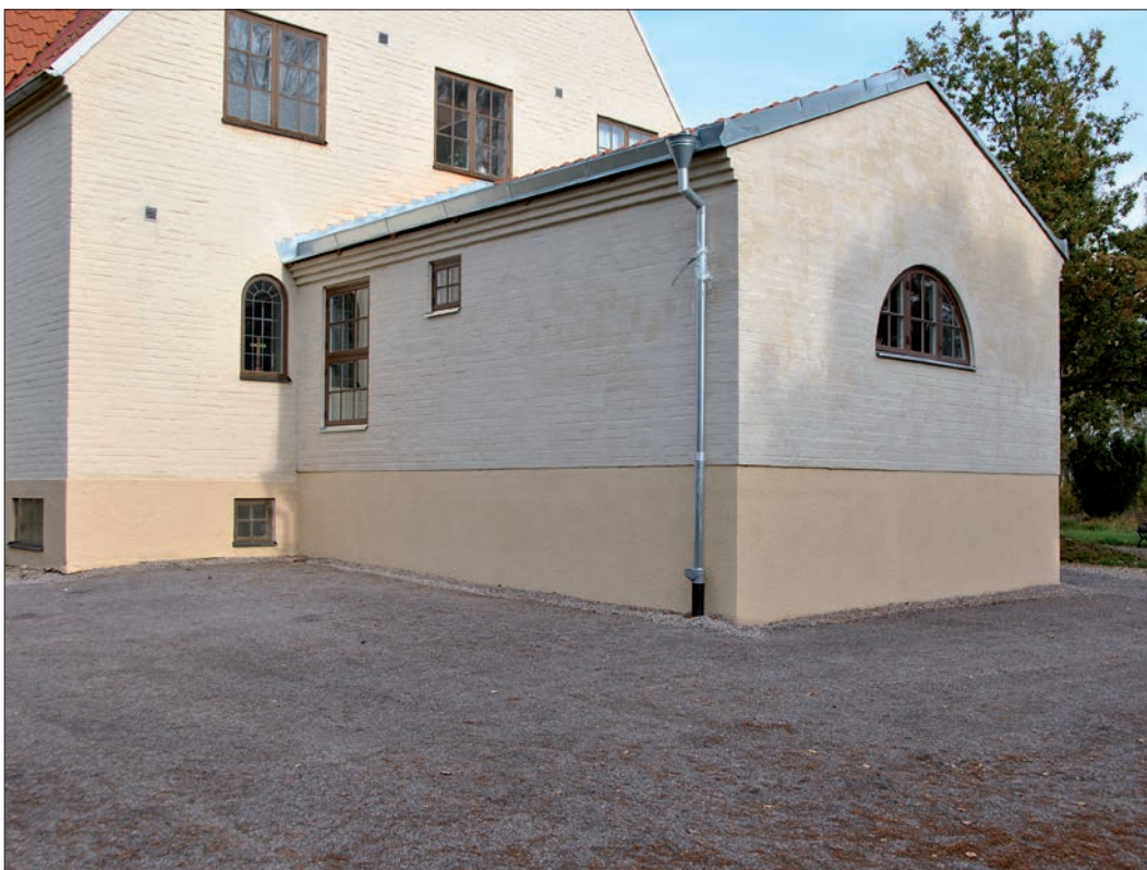
30 Tillbyggnadens fasadliv rår ut 10-15 mm över sockeln, vilket är motsatt utförandet på kyrkobyggnaden (Slm D13-0089).
