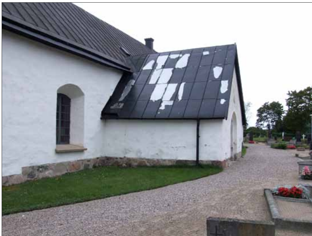
6 Gräsytan mellan långhuset och vapenhusets västra fasad var en av två gräsytor som togs bort i samband med återställandet efter avslutade markarbeten (Slm D11-453).
