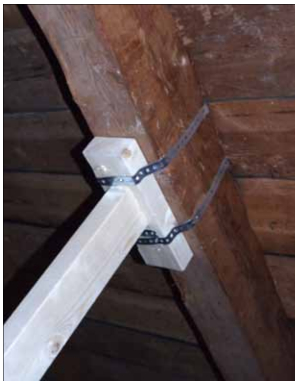
11 Gångbanornas infästningar i takstolarna gjordes oförstörande för minska ingreppen i taklagets äldre delar (Slm D11-458).
