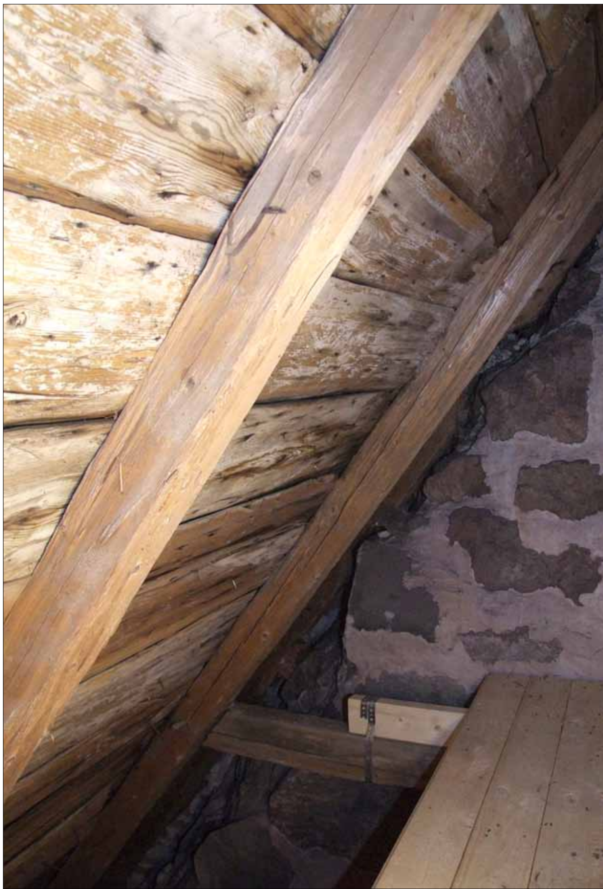
16 Vapenhusets välbevarade takstol och underlagstak är av hög ålder. Hela konstruktionen kan möjligen till och med vara medeltida (Slm D11-463).
