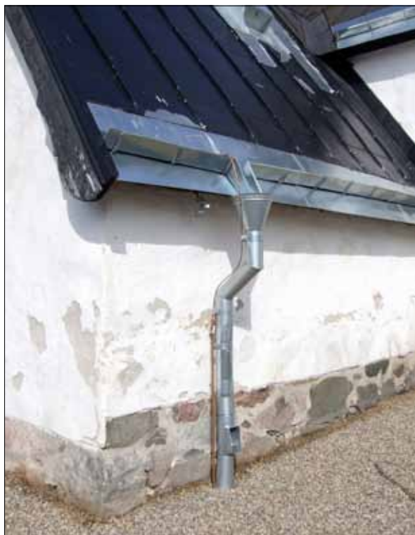
10 Nytt stuprör och nya fotrännor på vapenhusets östra takfall (Slm D11-457).
