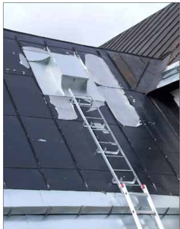
14 Närbild av den nya takluckan på vapenhusets östra takfall (Slm D11-461).
