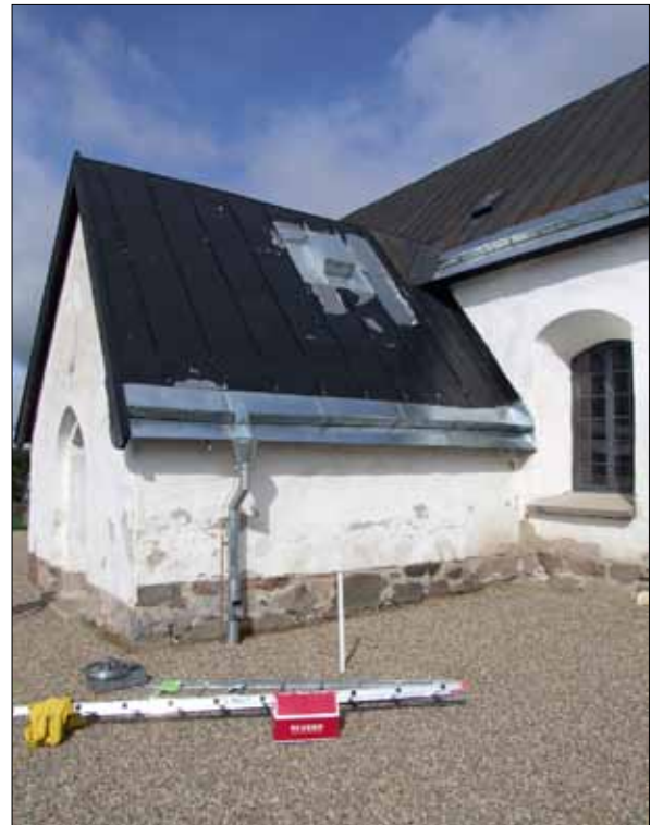
13 Nya plåtarbeten på vapenhusets östra takfall. Till höger anas den taklucka som skulle vara förlagda till den nya takluckan (Slm D11-460).
