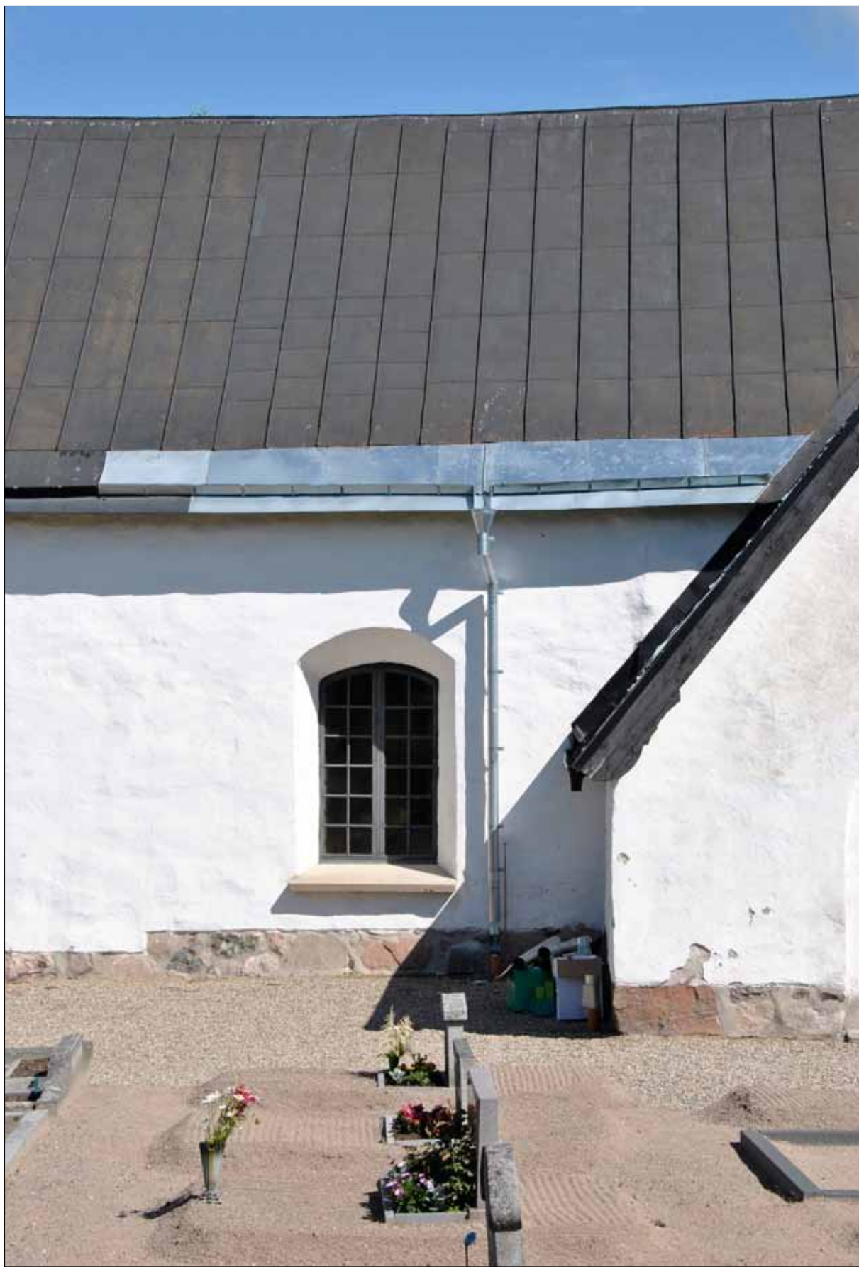
15 Nytt stuprör och nya fotrännor på långhuset södra takfall (Slm D11-462).
