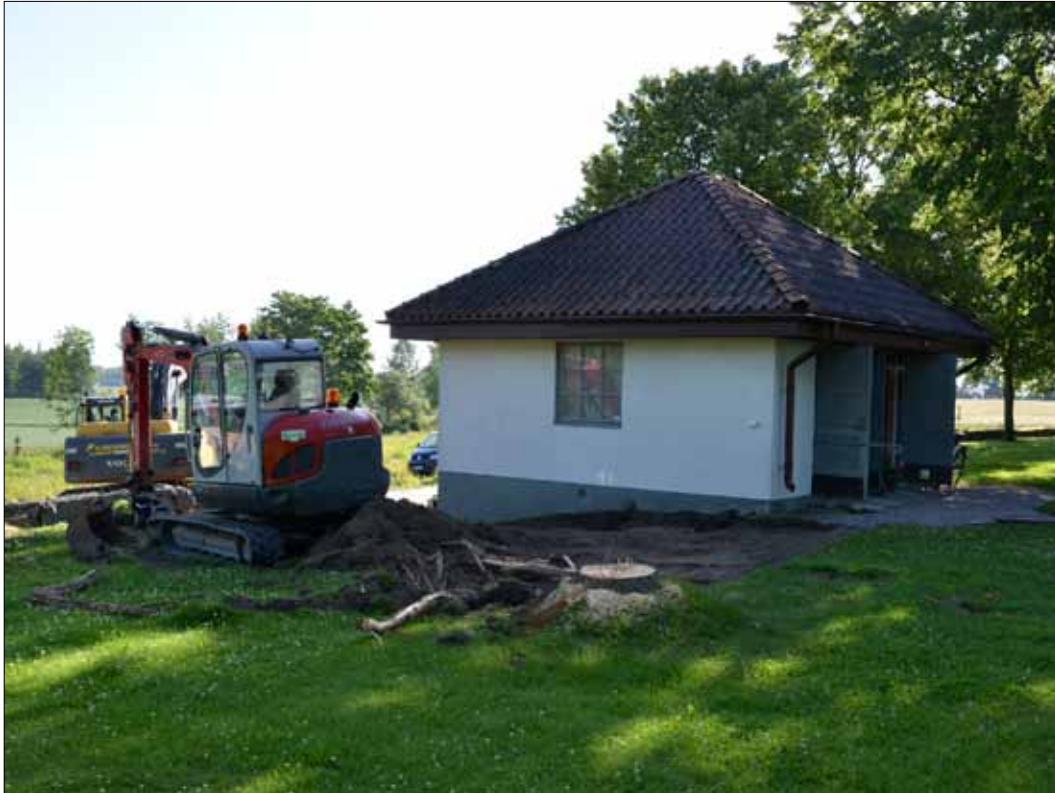
2 Schaktytan från sydväst efter borttagning av grästorven (Slm D11-760).
