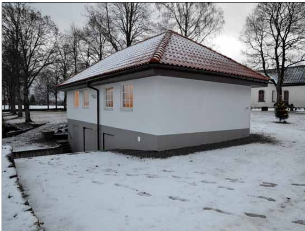
10 Förrådsbyggnaden från nordväst efter tillbyggnaden (SIm D11-768).
