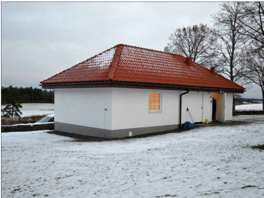
8 Förrådsbyggnaden från sydväst efter tillbyggnaden (Slm D11-766).
