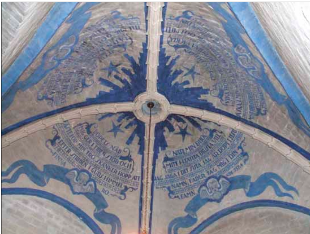
27 Dopkappellets valv före rengöringen. (D10-890)
