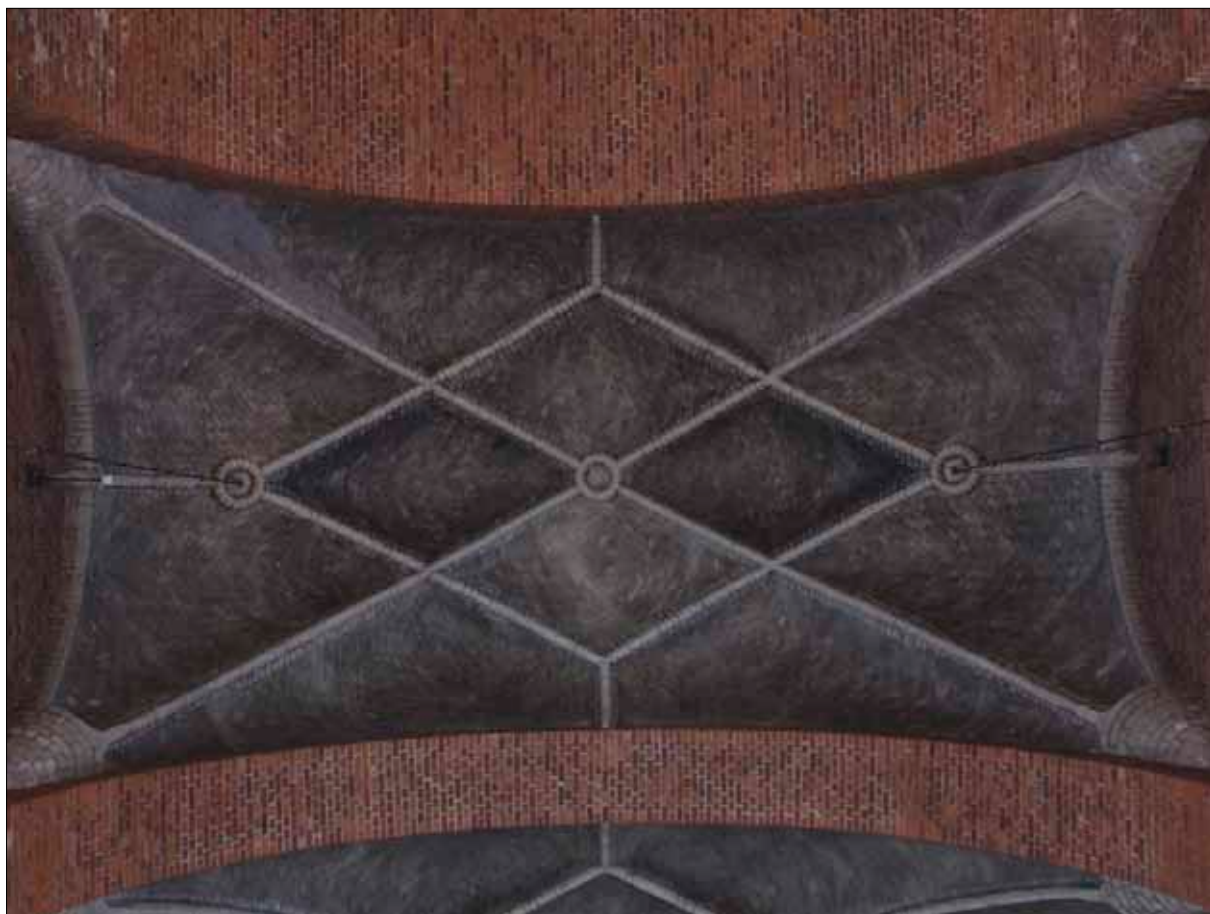
6 Valvtravé 5 före åtgärder. I övre vänstra hörnet syns lagningen som utfördes 2007, valvkappa 5:2. Nedåt i bild är söder. (D10-871)
