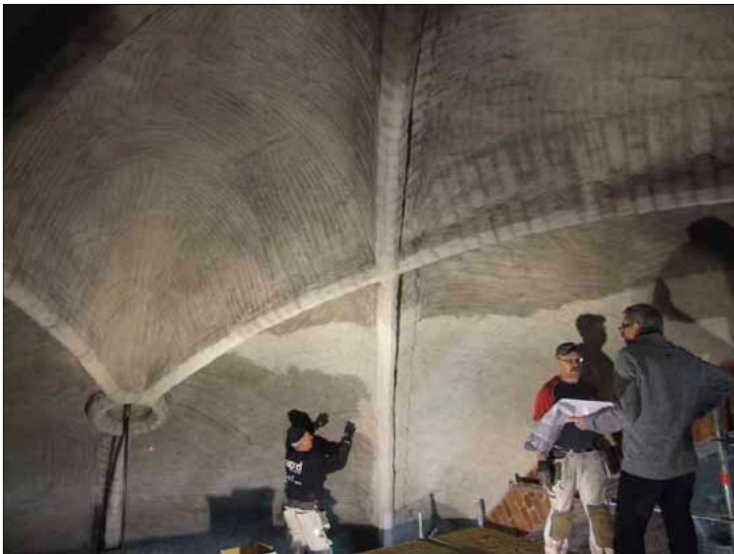
17 Pågående rengöring av valv 4. I bild syns murare Achmed, Heikki Herves och arkitekt Björn Norman. Övre ytorna har dammsugits. (D10-880)
