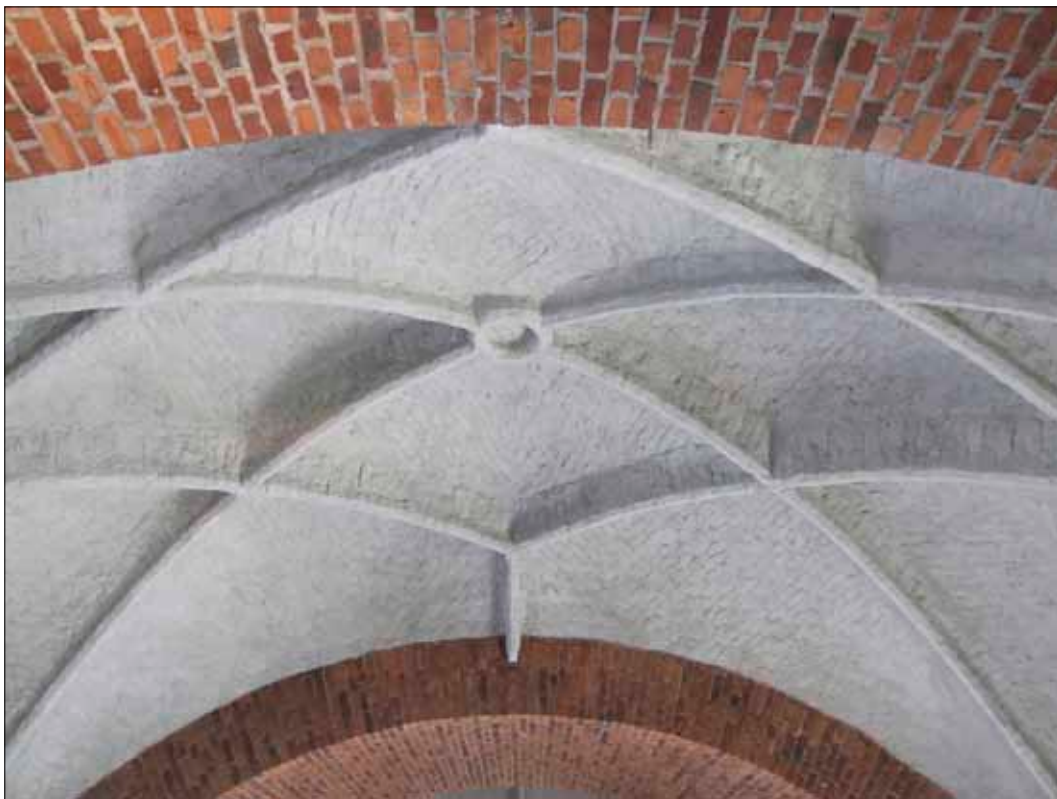
18 Valv efter rengöring och retuschering. (D10-881)
