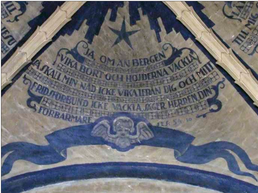
31 Dopkappellets östra valvkappa före rengöringen. (D10-889)
