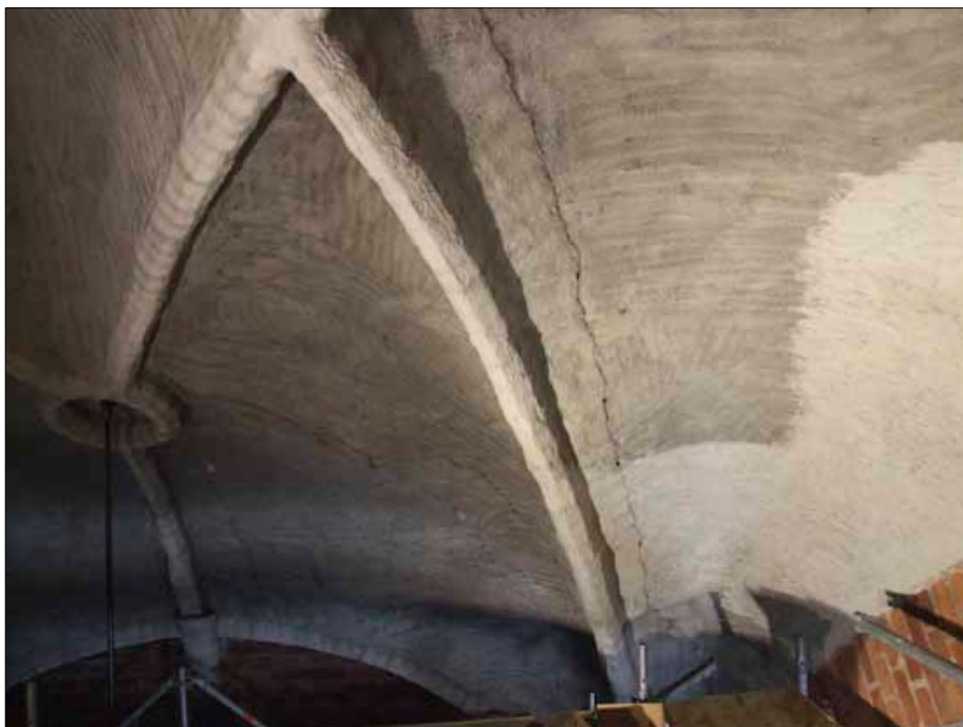
16 Vänstra valvkappan har dammsugits från sot och högra har påbörjats att rengöras med "Akapad"svamp. (D10-879)
