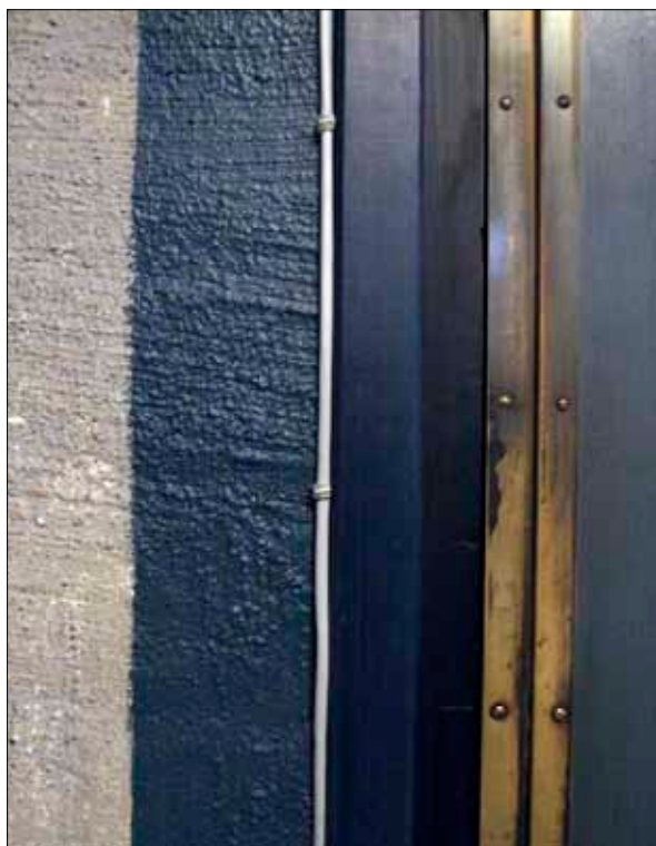
33 Detalj av sakristieingångens dörromfattning före arbeten, som var målad med en modern blank färg i avvikande kulör. (D10-899)
