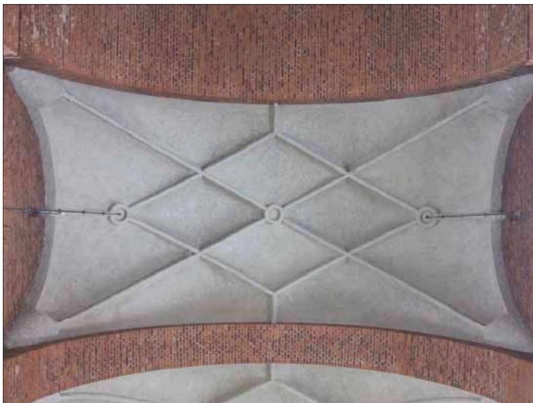
26 Samma valv efter rengöring, valv 5, putslagning och retuschering. Lagningen från 2007 kan anas till vänster upp i bild. (D10-895)
