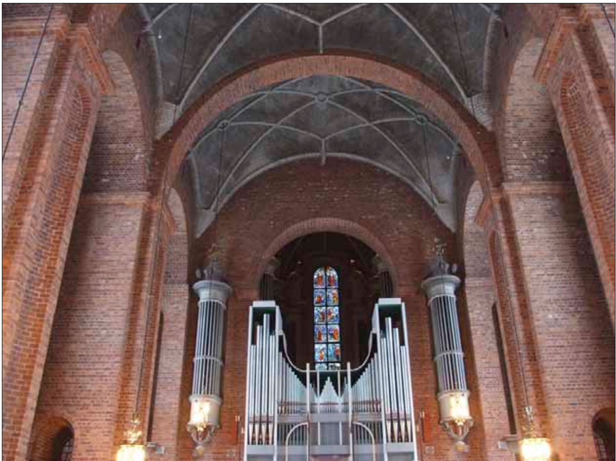
4 Långhusens södra valv före rengöringen. (D10-872)
