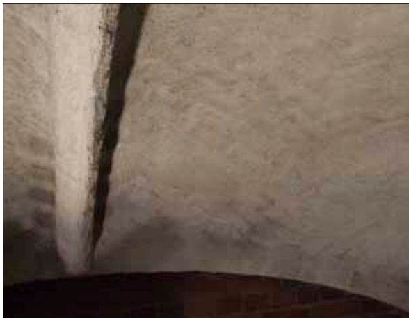
21 Spricklagningen efter retuschering. (D10-876)
