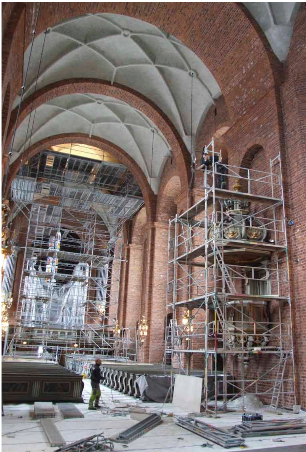
41 Entreprenaden är snart avslutad och ställningen plockas ned. (D10-892)
