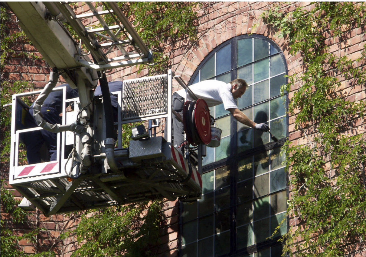
Bild 15. Från skylift skärs överflödigt tryckkitt bort och fönsterkarmar bättringsmålas.
