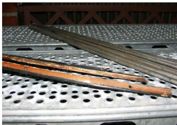
Bild 10. Borttagna eklister som höll det inre glaset och som återanvändes.
