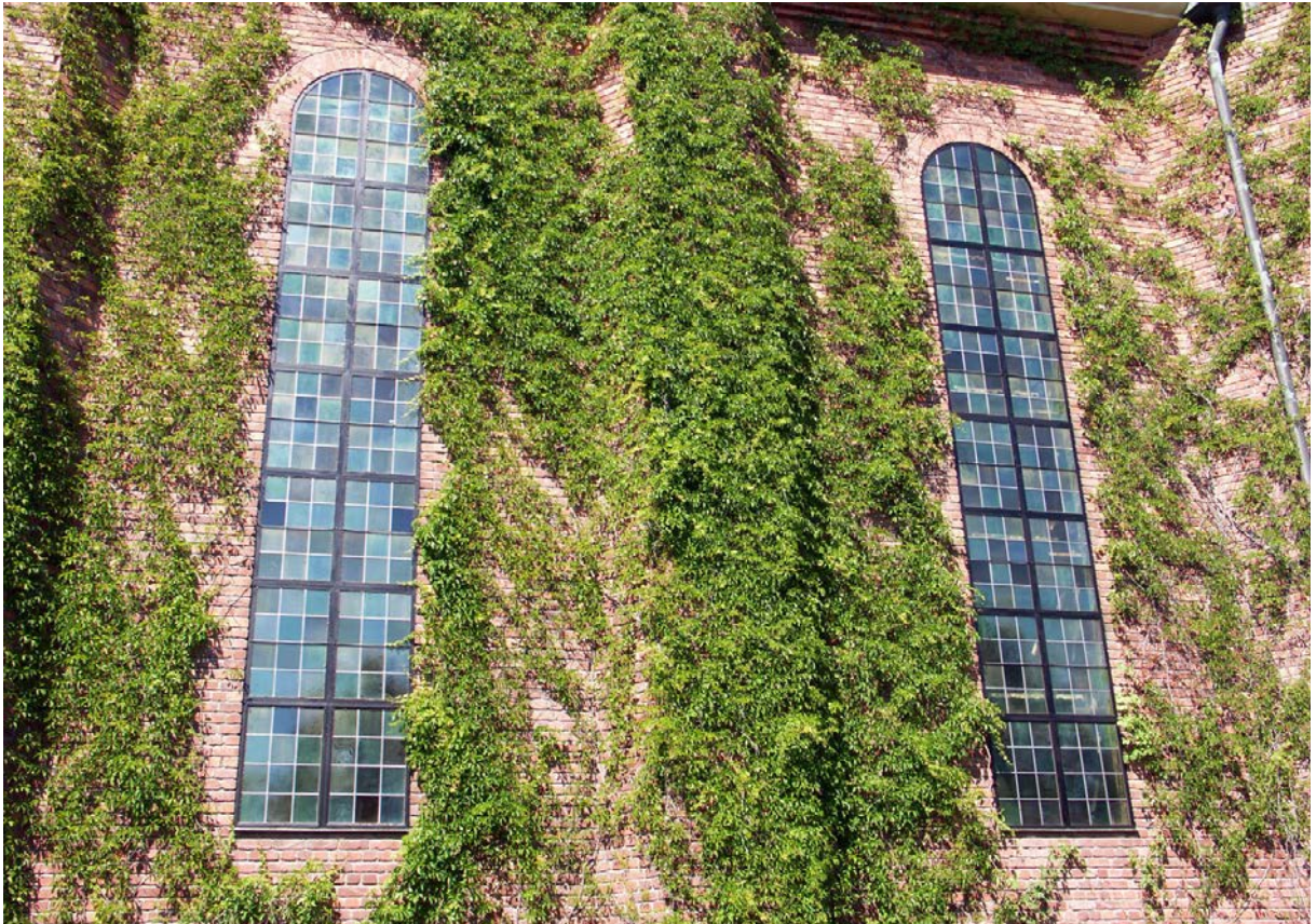
Bild 16. Fönster nr 11 och nr 12 efter renovering.
