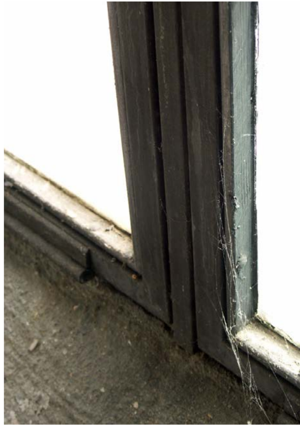
Bild 8. Detalj av fönsterkarm före renovering.
