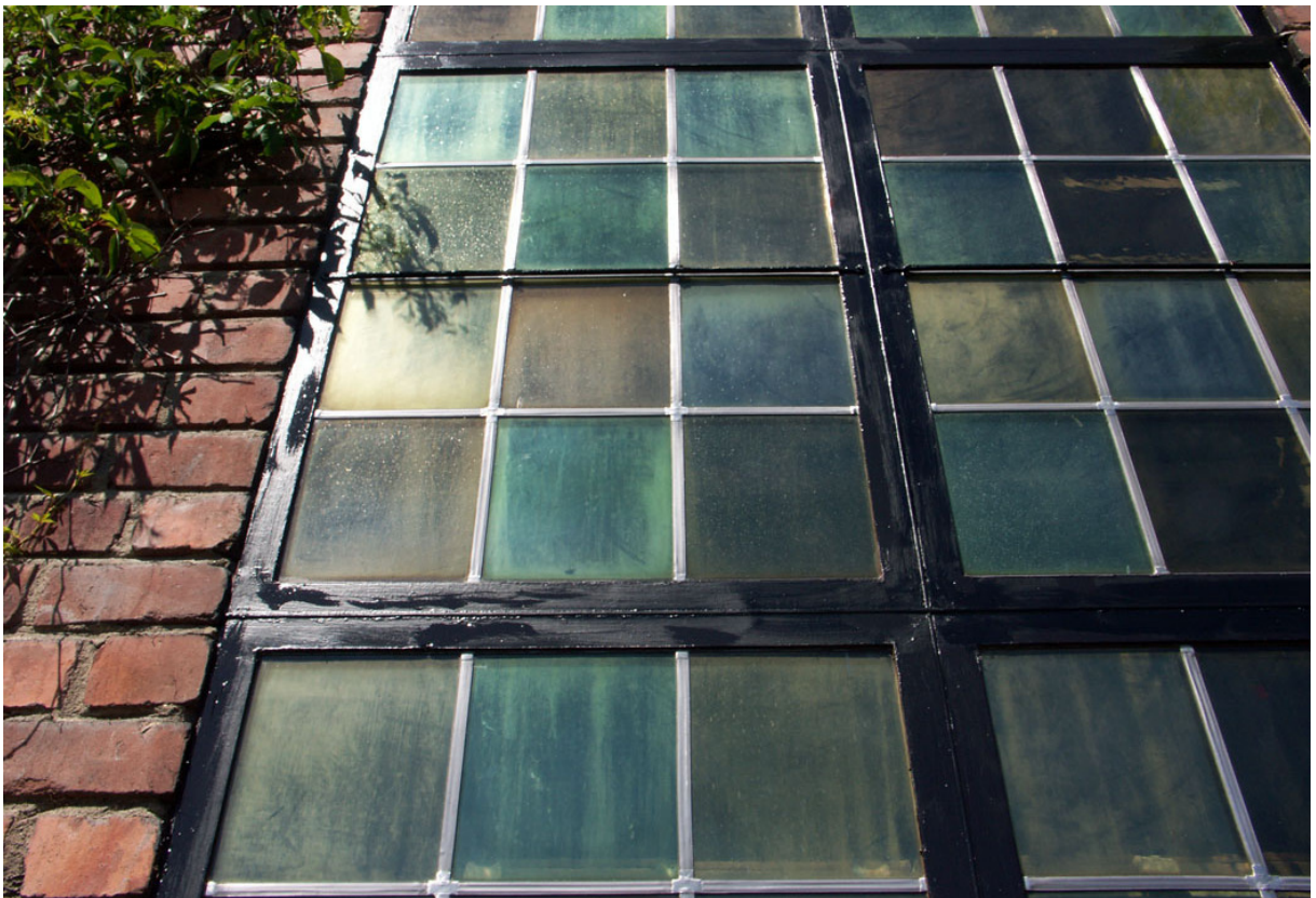
Bild 17. Detalj av fönster efter bättringsmålningen.
