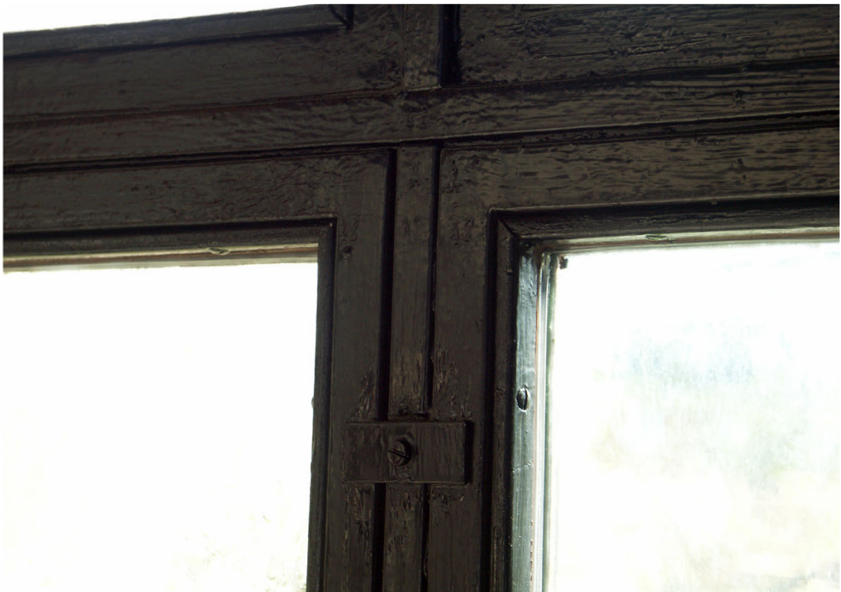
Bild 13. Detalj av fönsterkarm efter renovering och målning.
