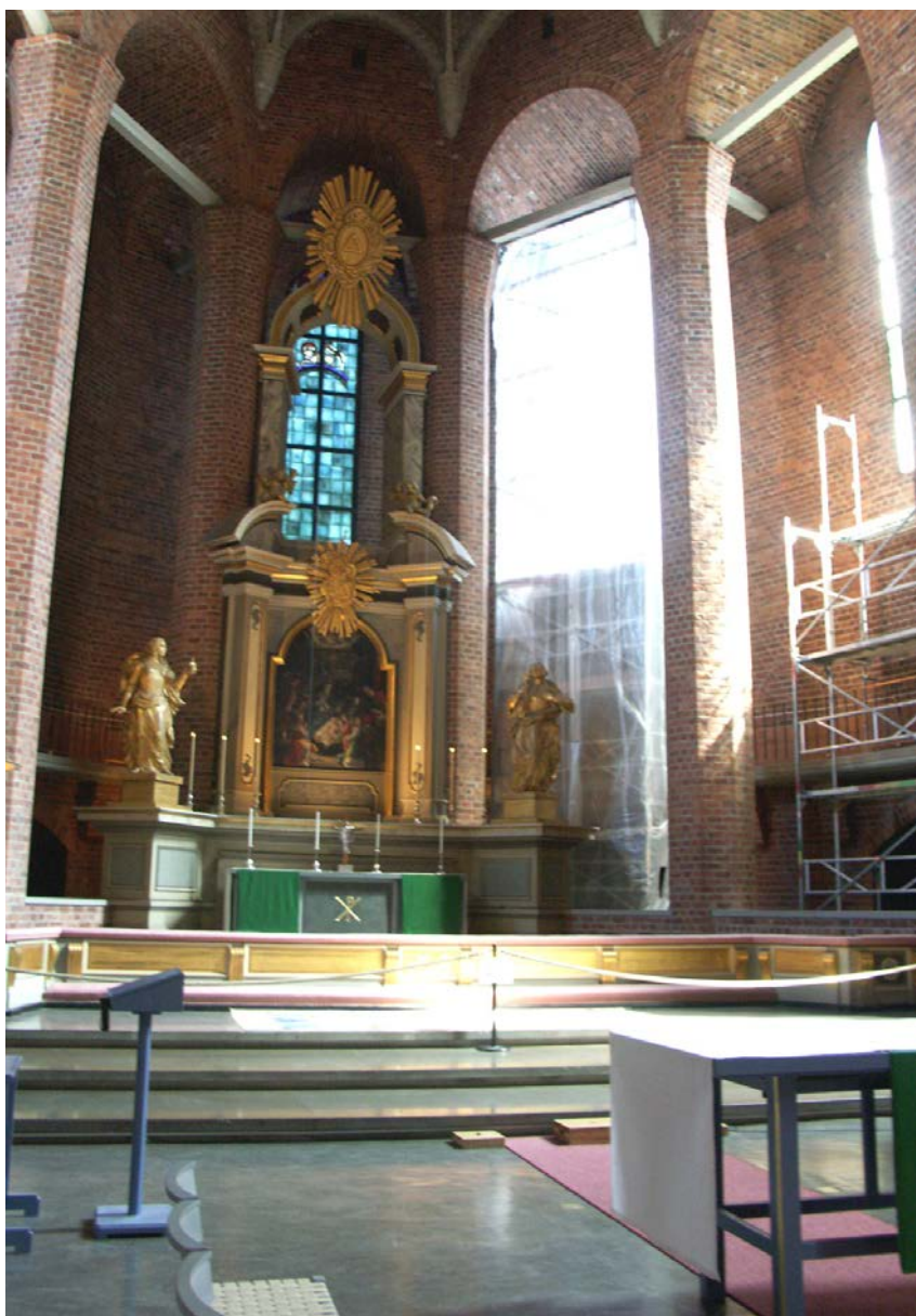
Bild 6. Koret under fönsterrenoveringen, juni 2006.
