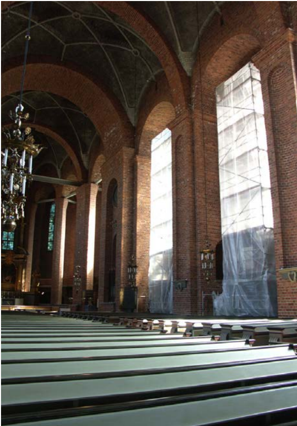
Bild 7. Östra fasadens fönster under renovering.
