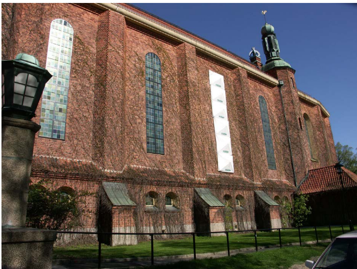
Bild 1. Klosters kyrkas östra fasad under pågående fönsterrenovering, fönster 9 - 13, se bilaga 1.
