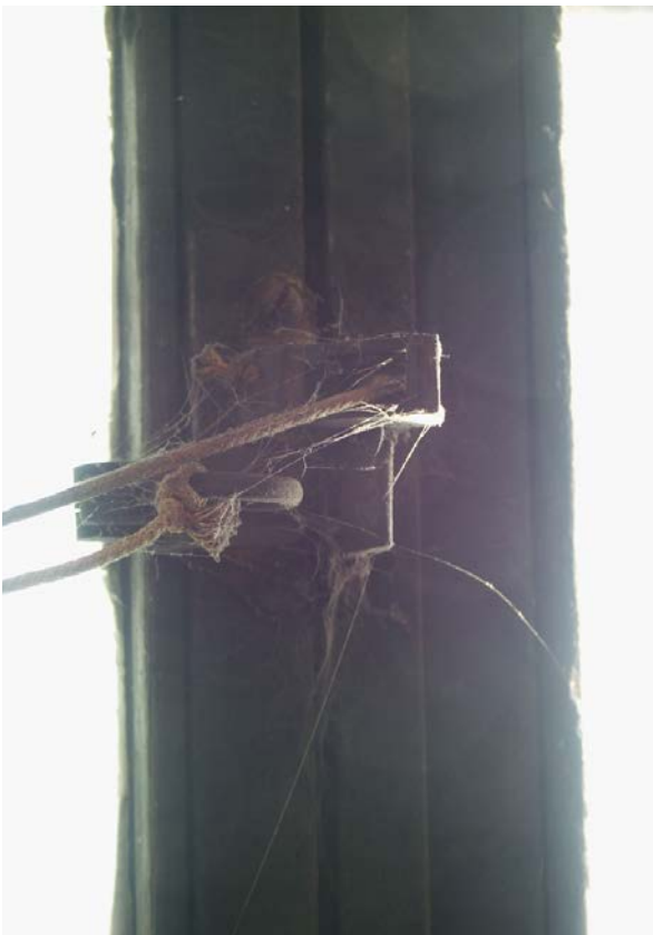
Bild 9. Detalj av fönstrets reglage före åtgärd.
