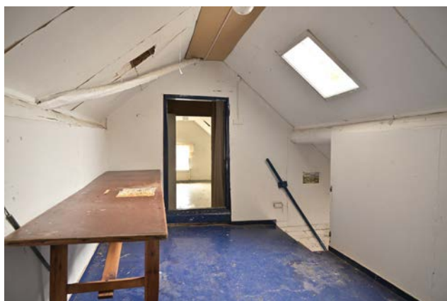
Bild 31. Hallen på vindsvåningen sett mot öster med trappan till höger i bild. Väggen bakom trappan utgjorde tidigare husets östra gavel. (SLM D2024-0255)
