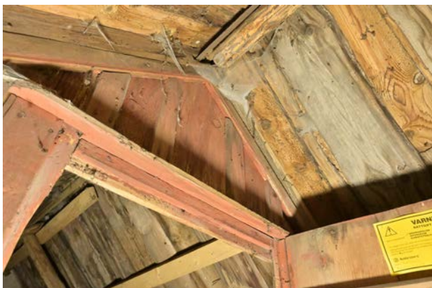
Bild 38. Bild av den tidigare östra gavelväggen med äldre rödfärgad panel. (SLM D2024-0262)
