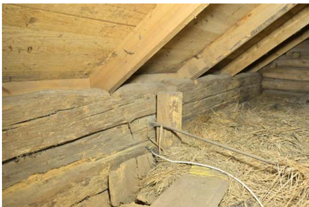
Bild 70. Bild av dragjärn på vinden till den lägre delen av södra ekonomibyggnaden. (SLM D2024-0294)
