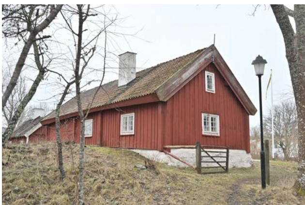
Bild 22. Stora bostadshuset sett från nordväst. Notera de kraftiga vindskivorna som är ett resultat av att taket riktades vid den senaste omläggningen. (SLM D2024-0246)
