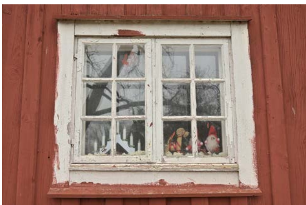
Bild 18. Fönster på stora bostadshusets västra gavel. Den vänstra fönsterbågen har spikade beslag av 1700-talsmodell. (SLM D2024-0242)
