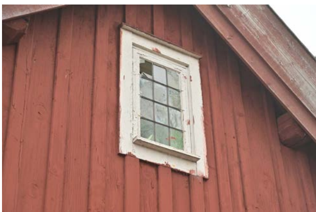
Bild 19. Det blyspröjsade fönstret på stora bostadshusets västra gavel. En ruta har gått sönder. (SLM D2024-0243)
