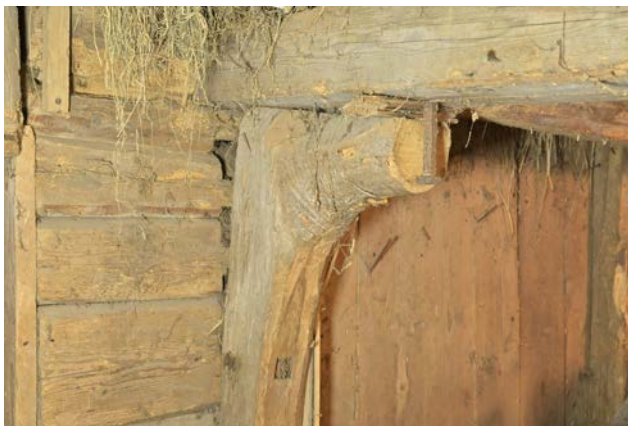
Bild 68. Konsol bestående av ett naturligt vinkelknän, vilket ser ut att ha kapats i änden. (SLM D2024-0292)
