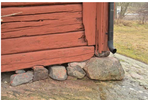
Bild 50. Norra ekonomibyggnadens nordvästra hörn sett från norr. Syllstocken ser ut att vara kapad i änden och ersatt av ytterligare en grundsten. (SLM D2024-0274)
