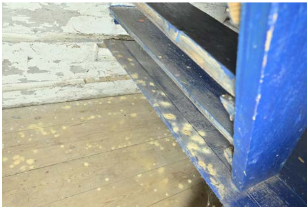
Bild 25. Borrmjöl efter trägnagare. (SLM D2024-0249)
