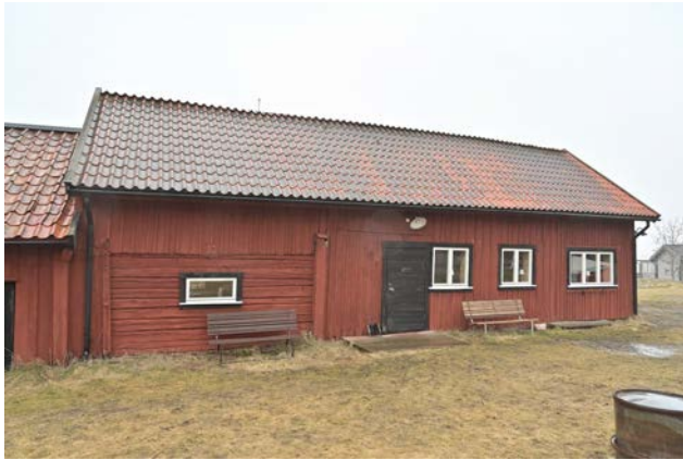
Bild 63. Södra ekonomibyggningen från söder. Köket finns vid det liggande fönstret till vänster i bild, och en samlingsisal innanför övriga fönster.(SLM D2024-0287)
