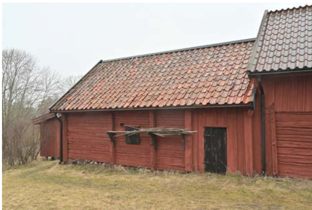
Bild 65. Södra ekonomibyggningens södra del sett från söder. (SLM D2024-0289)
