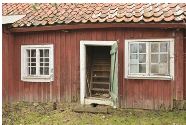
Bild 39. Ingången till vindsvåningen som finns i husets förlängda del. (SLM D2024-0263)
