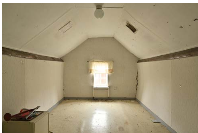
Bild 33. Det östra gavelrummet. (SLM D2024-0257)
