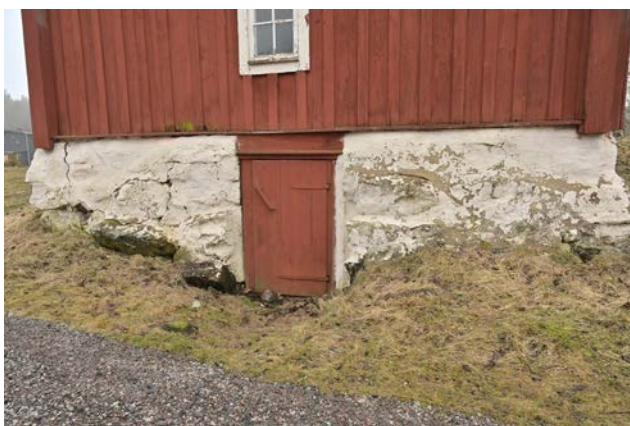
Bild 15. Stora bostadshusets östra gavel med jordkällaren under den förlängda delen av huset. (SLM D2024-0239)
