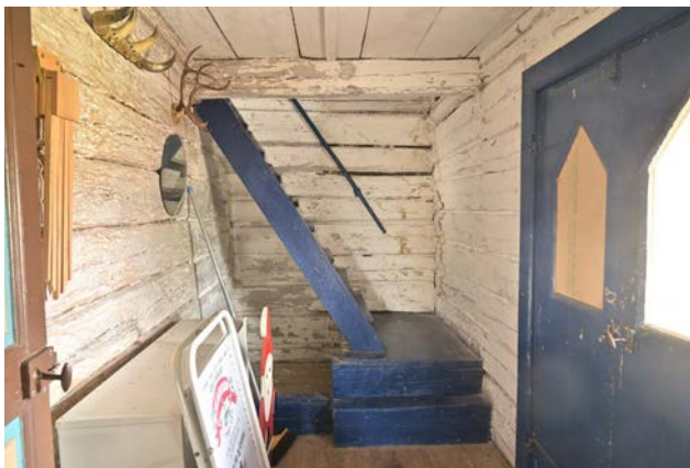
Bild 24. Stora bostadshusets farstu. Trappan till andra våningen har tidigare varit omålad. (SLM D2024-0248)
