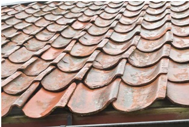
Bild 64. Det enkupiga handslagna teglet på den södra ekonomibyggningens lägre del är troligen tillverkat vid Tureholm. (SLM D2024-0288)
