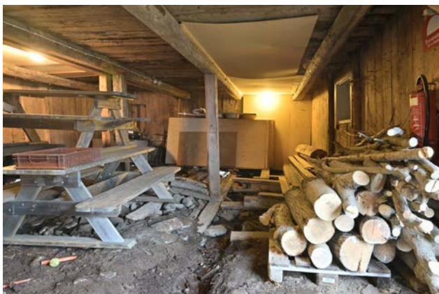
Bild 66. Den lägre delens oinredda del sett mot väster. (SLM D2024-0290)
