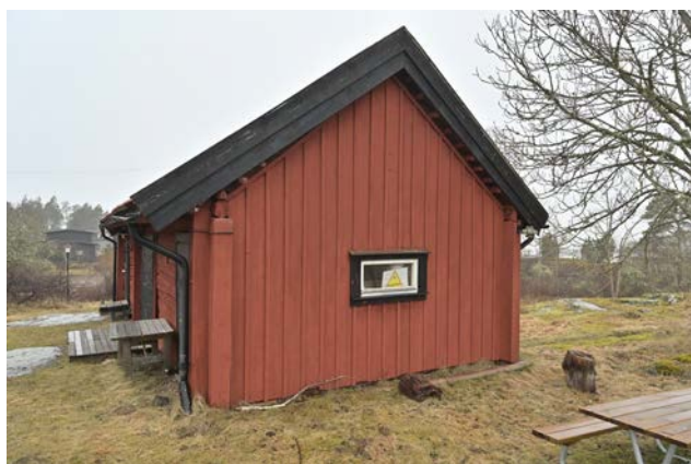
Bild 53. Norra ekonomibyggnadens östra gavel. (SLM D2024-0277)
