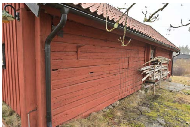
Bild 54. Norra ekonomibyggnadens norra vägg sett österifrån. (SLM D2024-0278)
