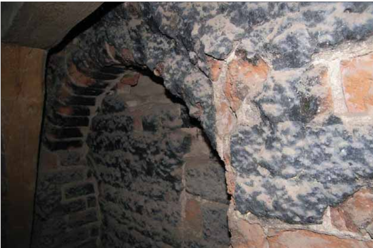
Figur 9. Kyrktornets insida. De mörka partierna som syns på bilden utgörs av tegel som har sintrat i samband med bränder i kyrkan. Foto: Peter Berg 2013, Sörmlands museum.
