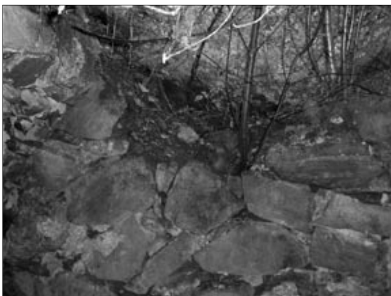
Figur 9. Detalj av källarmuren i grästen inom fornlämningen Strängnäs 374. I det vänstra hörnet syns det slagna valvet och stötfogen mot muren. Lämningen utgörs troligen resterna efter Larslunda säteri. Foto: Lars Norberg 2005, Sörmlands museum.
