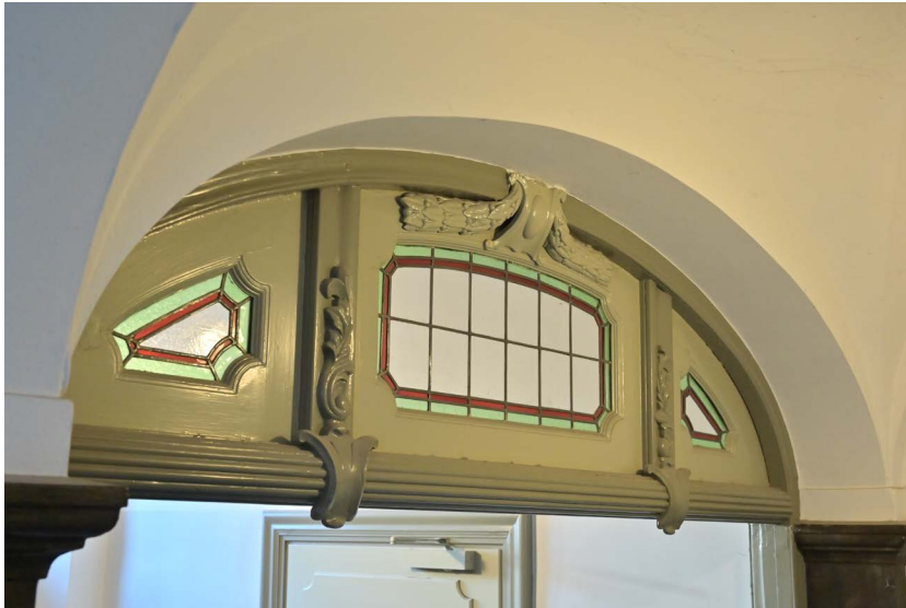
Detaljer i trapphuset bär tydliga drag av jugend som var populärt kring sekelskiftet 1900. Här syns ett bevarat överljus som sannolikt satt över en port som skilde butiksentréerna från bostadslägenheternas trapphus. (SLM D2025-0109)
