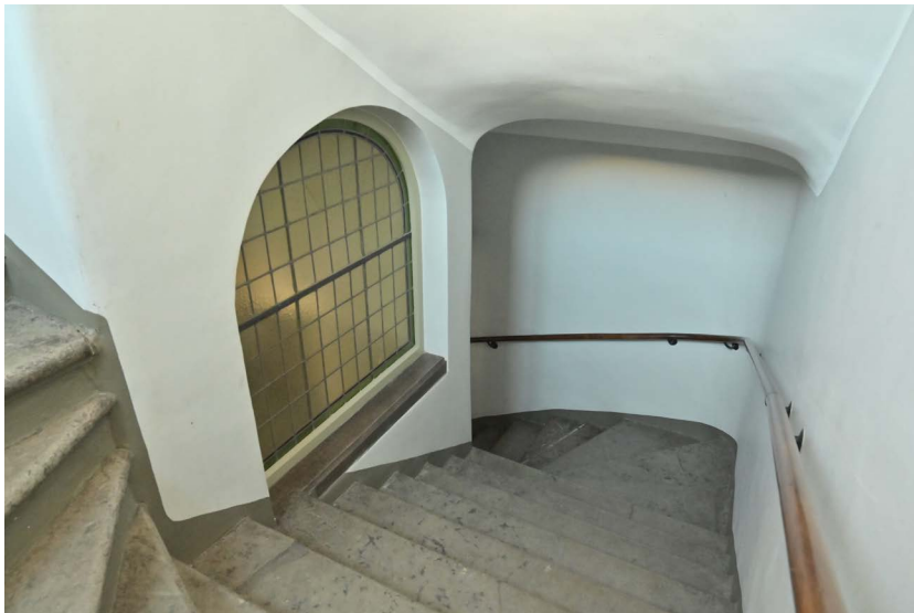
Ett fönster i trapphuset med blyspröjsade rutor. (SLM D2025-0110)
