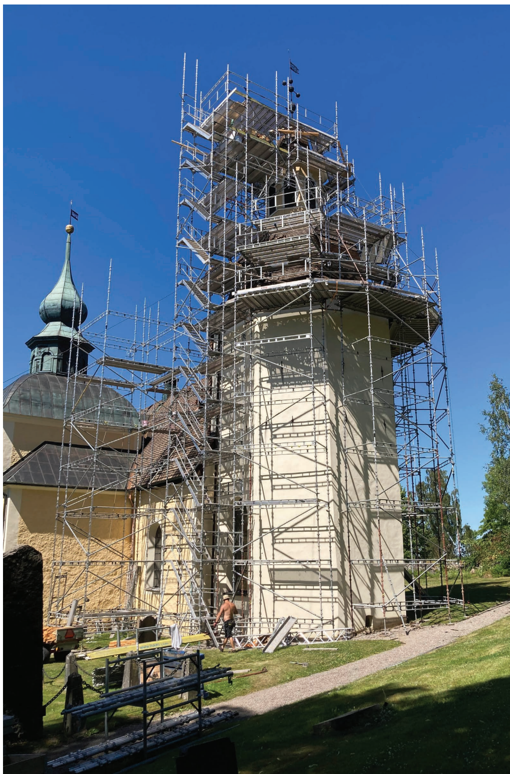
Bild 17. Byggnadsställningen runt Nynästornet förankrades i fasaden strax under takfoten och i nivå med de n lägre raden av ankarjärn, samt i lanterninens brädfasad. Foto 2024-06-25. (SLM D2024-0463)
