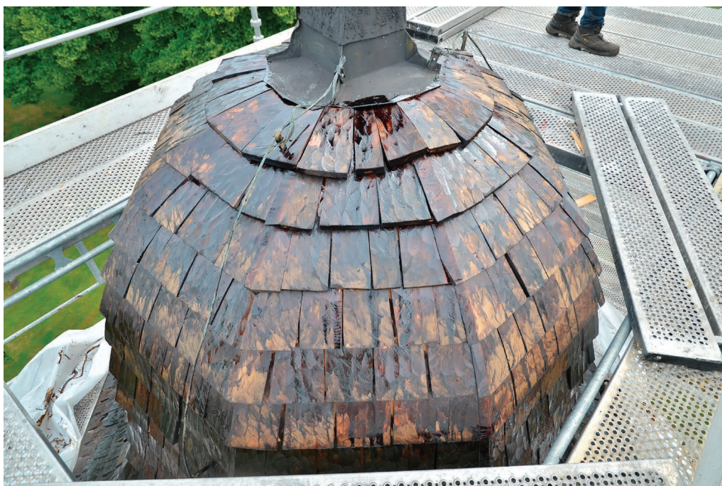
Bild 27. Nyss avslutad tjärnstrykning på kupolen. Foto 2024-07-04. (SLM D2024-0473)
