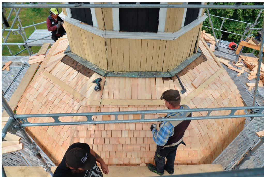
Bild 24. Nästan färdiglagt spåntak på Nynästornet. Foto 2024-07-04. (SLM D2024-0470)
