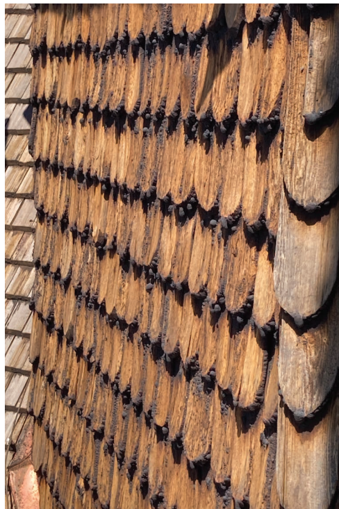
Bild 15. Tornfasadens äldre spånbeklädnad innan renovering. Foto 2024-06-25. (SLM D2024-0462)
