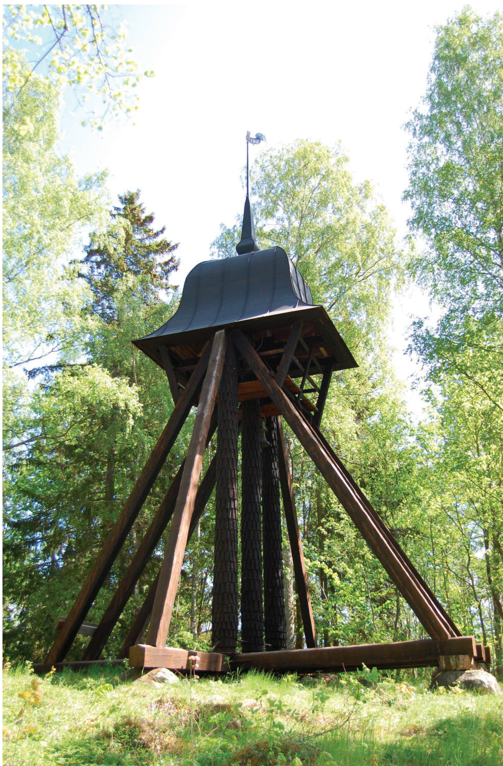
Bild 16. Klockstapeln hann inte dokumenteras innan 2024 års tjärstrykning. Bilden ovan är från 2010. Trots att det passerat 14 år sedan bilden togs var klockstapeln i ett likvärdigt skick, med väl skyddande och tjocka lager tjära uppbyggda av flera strykningar på relativt korta tidsintervall. Foto av Peder Gustavsson 2010-06-07. (SLM D11-011)
