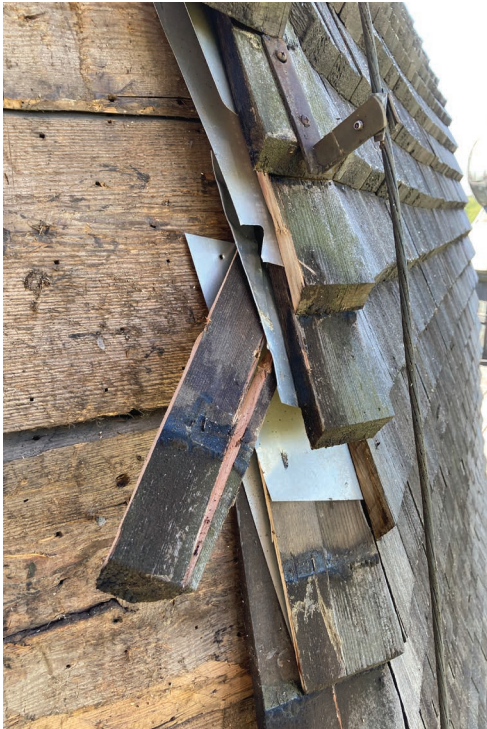
Bild 18. Pågående borttagning av takspån på tornets kupol. Notera konstruktionen med aluminiumplåtarna. Foto 2024-06-25. (SLM D2024-0464)
