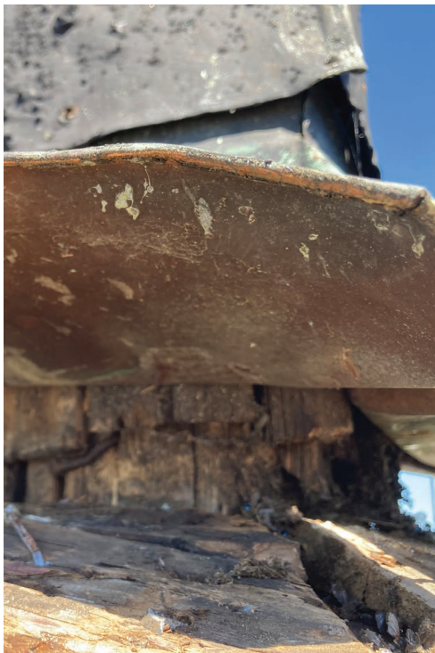
Bild 14. Spirans hjärstock och täckplåt. Foto 2024-06-25. (SLM D2024-0461)
