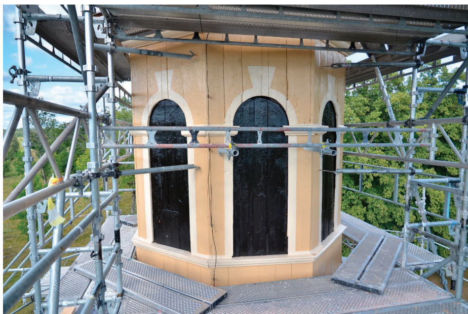
Bild 40. Lanterninen efter avslutade arbeten. Foto 2024-08-12. (SLM D2024-0486)
