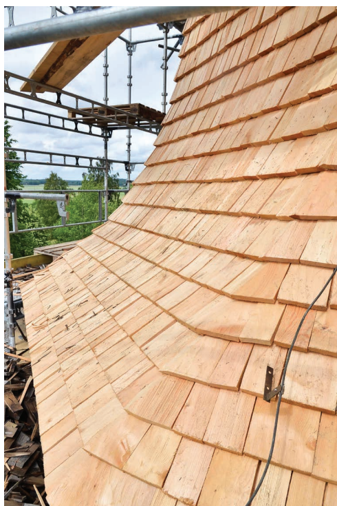
Bild 25. Färdiglagt spåntak, vy mot norr. Foto 2024-07-04. (SLM D2024-0471)
