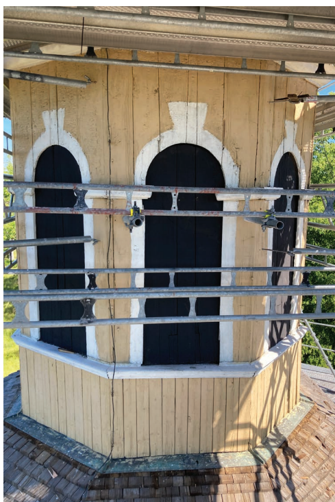
Bild 8. Lanterninen innan renovering. Foto 2024-07-04. (SLM D2024-0455)
