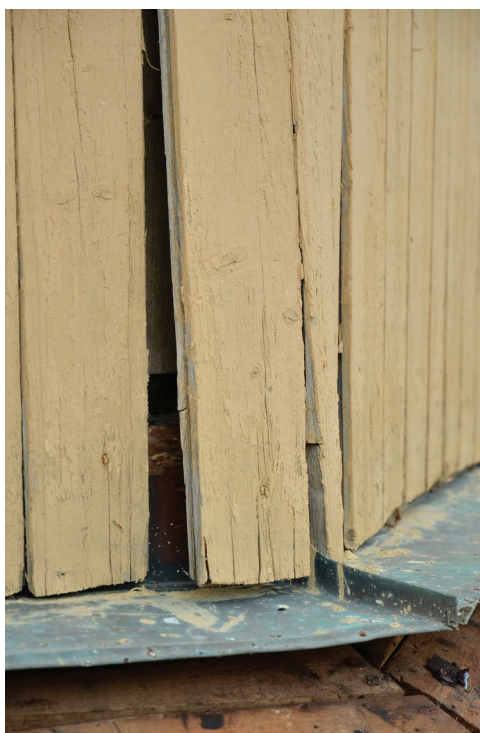
Bild 9. Brädpanel på lanterninens nederdel innan renovering, Foto 2024-07-04. (SLM D2024-0456)
