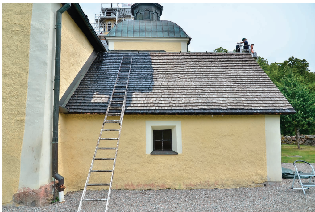
Bild 29. Pågående tjärning på vapenhuset (västra takfallet). Foto 2024-07-04. (SLM D2024-0475)
