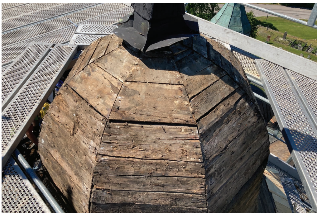
Bild 22. Kupolens underlagstak. Foto 2024-06-25. (SLM D2024-0468)
