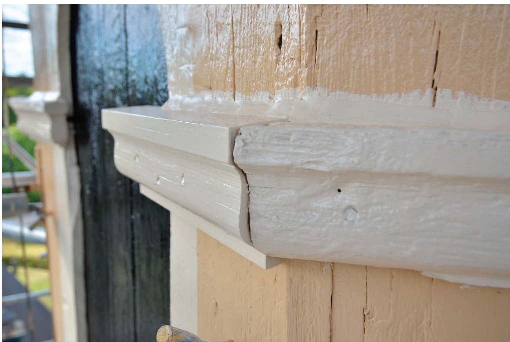
Bild 33. Lanterninens fasad och kransgesims efter avslutad renovering. Foto 2024-08-12. (SLM D2024-0479)
