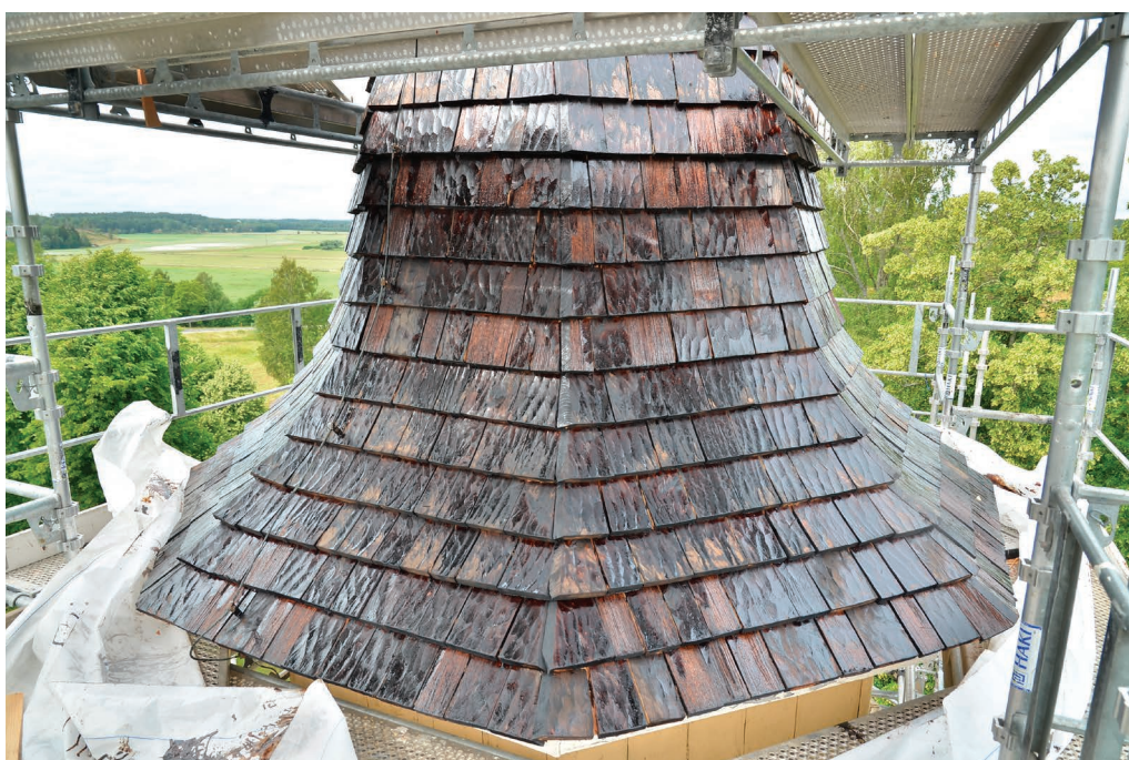
Bild 28. Nyss avslutad tjärnstrykning på torntaket. Foto 2024-07-04. (SLM D2024-0474)
