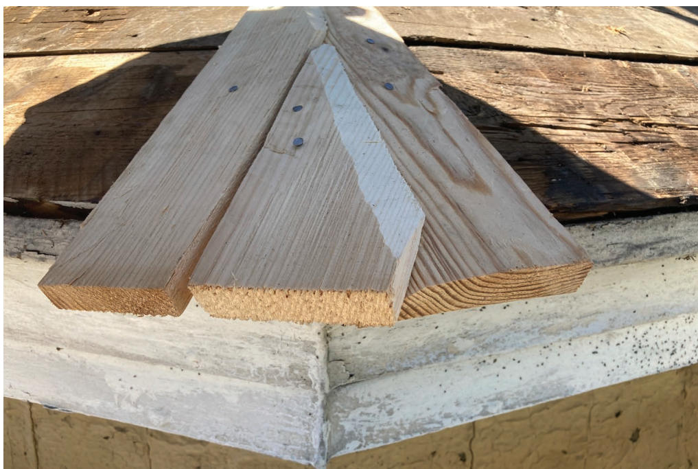
Bild 23. Nya takspån vid takvalm. Notera det högra spånets årsringar som är liggande, istället för stående som förundersökningen angav. Foto 2024-06-25. (SLM D2024-0469)
