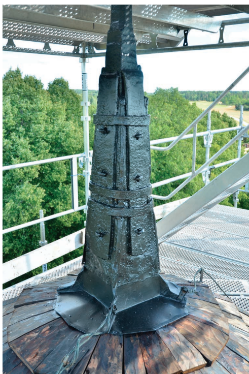
Bild 31. Spirans infästning efter avslutad renovering. Foto 2024-08-12. (SLM D2024-0477)
