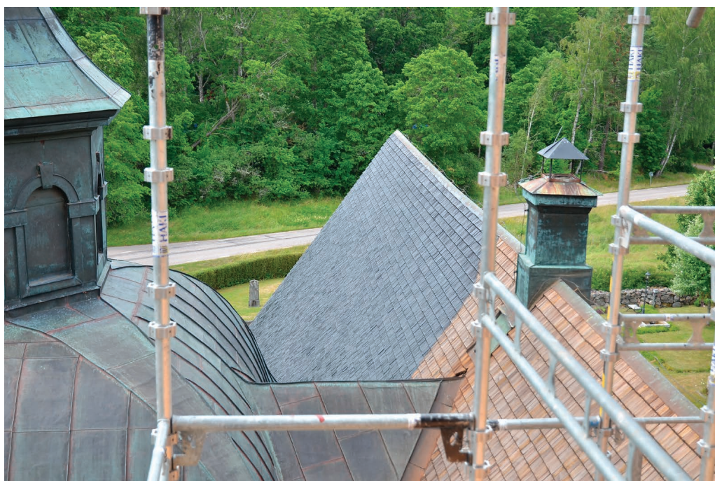
Bild 30. Pågående tjästrykning av långhusets södra takfall. Foto 2024-07-04. (SLM D2024-0476)
