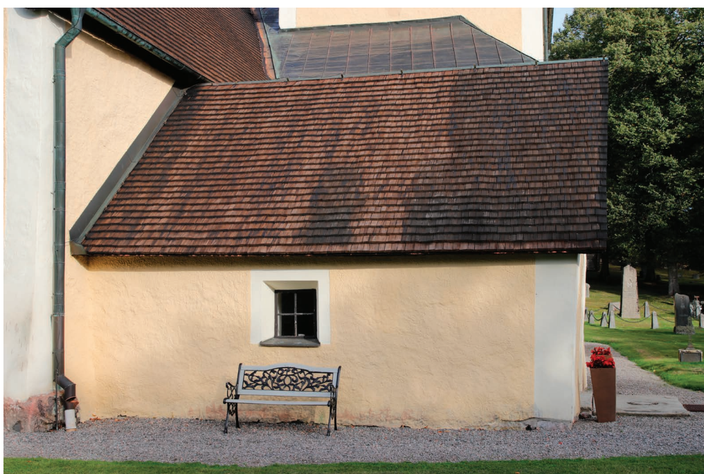
Bild 39. Vapenhusets spåntak efter avslutade arbeten. Den påstrukna tjäran är i princip helt borta, trots att det bara gått lite drygt två månader efter att tjärningen avslutades. Foto 2024-09-25. (SLM D2024-0485)
