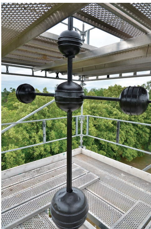
Bild 32. Spiran och kloten efter avslutad renovering. Foto 2024-07-18. (SLM D2024-0478)
