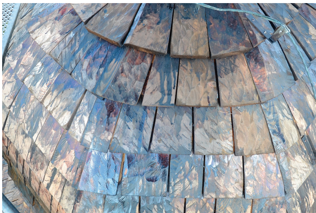
Bild 37. Nynästornets kupol ca en månad efter avslutad tjärning. Foto 2024-08-12. (SLM D2024-0483)
