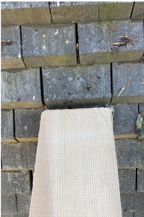
Bild 20. Nytt takspån. Spånet hålls upp mot Nynäs-tornets gamla spån. Bilden är tagen strax innan spånen demonteras. Foto 2024-06-25. (SLM D2024-0466)
