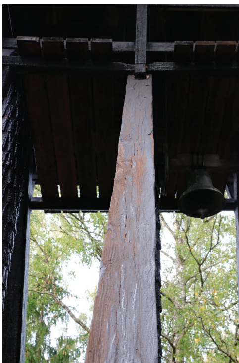
Bild 35. Klockstapeln efter avslutad tjärning. Stödbenens ovansidor har redan börjat gulna, troligtvis till följd av det uttorkade virket som absorberat all tjära. Foto 2024-09-25. (SLM D2024-0481)
