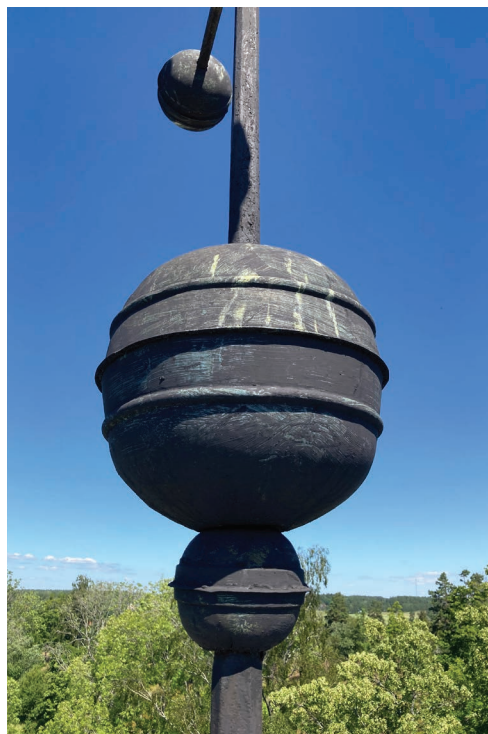
Bild 13. Spirans gjutjärn och nedre klot innan renovering. Foto 2024-06-25. (SLM D2024-0460)
