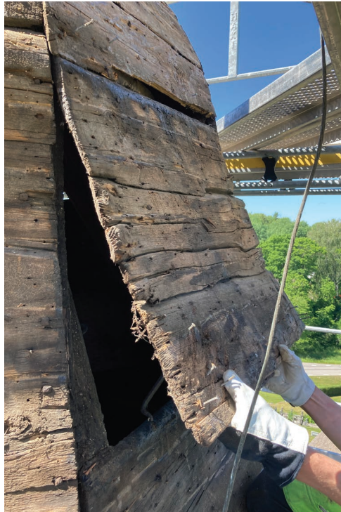
Bild 19. Inspektionslucka i kupolens norra sida. Foto 2024-06-25. (SLM D2024-0465)
