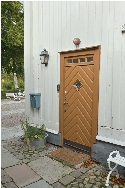
Dörren till köket vid huvudbyggnadens södra gaveln. (SLM D2025-0006)
