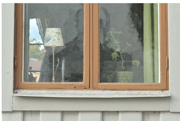
Det är i första hand bågarnas bottenstycken som är mest utsatta. (SLM D2025-0077)
