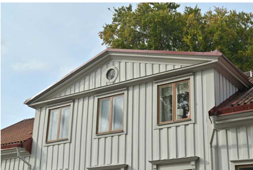
Frontespisen mot torget med frontonfält och oxögefönster. (SLM D2025-0005)
