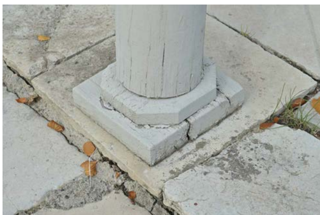
Sprickor finns i lusthusets pelare och bas. (SLM D2025-0092)
