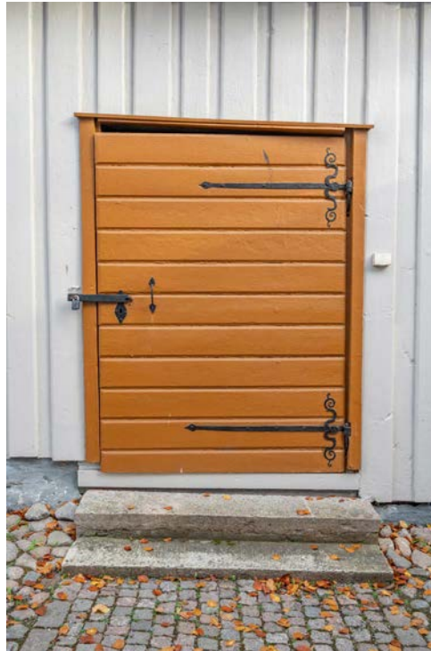
En av de bevarade portarna på stallflygeln med sirliga 1700-talsgångjärn. (SLM D2025-0022)
