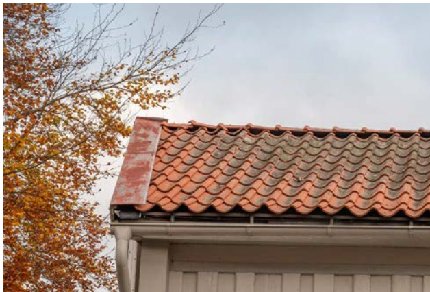
Bostadsflygelns vattplåtar har tappat mycket av sin färg. (SLM D2025-0084)
