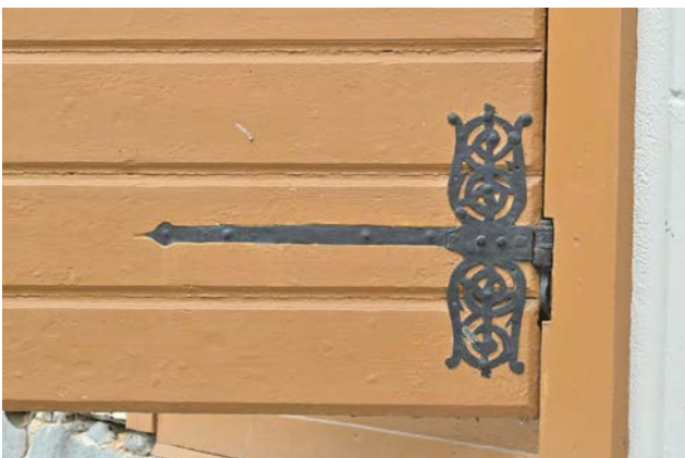
En av stallflygelns portar har gångjärn som genom sitt större och bearbetade utseende mycket väl kan härstamma från 1600-talet. Tillsammans med den underliggande källaren och husets korsvirkeskon- struktion, kan detta tyda på att huset fanns redan innan den övriga gården uppfördes. Den kan i så fall ha klarat rysshärjningarnas bränder 1719. (SLM D2025-0024)
