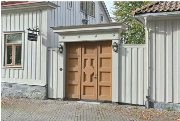
Den norra portgången med plank mellan huvudbyggnad och stallflygel tillkom. (SLM D2025-0008)
