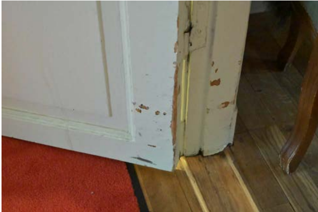
Slitna ytskikt finns på en del ställen i bottenvåningen, här vid dörren mellan passage (2) och sal (7). (SLM D2025-0078)
