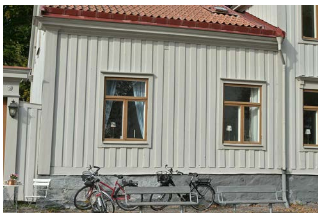
Locken som slagit sig ger en skugga i underkant, som påverkar fasadens arkitektoniska helhetsuttryck. (SLM D2025-0068)
