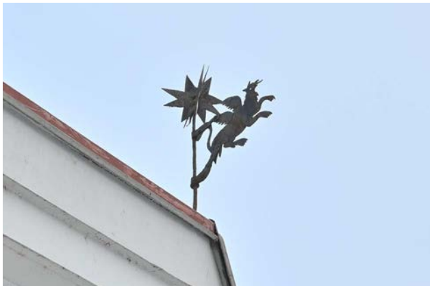
Vindflöjeln på bostadsflygelns har slitna färgskikt och rostgenomslag. (SLM D2025-0086)
