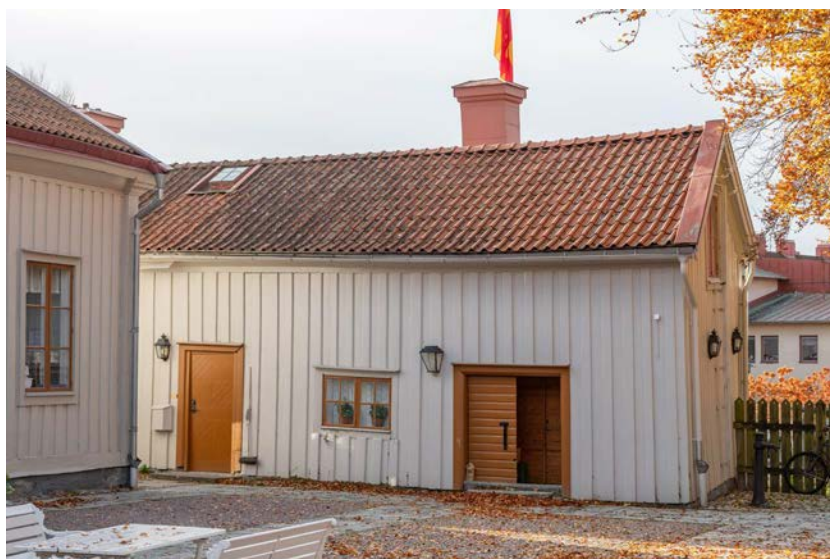
Bostadsflygeln sedd från träd- gården. Den äldre dörren till höger har delat dörrblad vilket tyder på att det funnits stall i denna del. (SLM D2025-0012)
