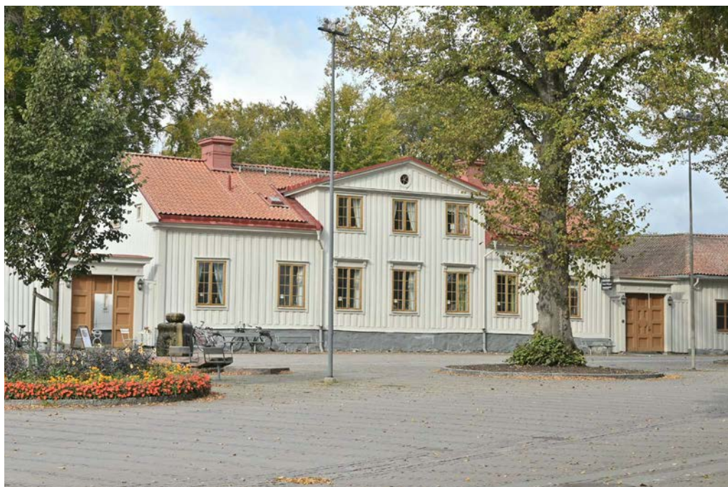
Manipulerad bild med småspröjsade bågar utan tvärpostindelning, efter bevarad förlaga. Den äldre spröjsade fönstermodellen ger större harmoni till fasaden och gör att fönstren blir mindre framträdande. Skuggverkan minskar och ögat dras snarare till fasadutsmyckningarna i omfattningar och det lilla oxögat i frontonfältet. En återgång till denna fönstertyp skulle ge byggnaden ett mer traditionellt uttryck och skapa större förståelse för byggnadens ålder och arkitektoniska gestaltning. (SLM D2025-0096)
