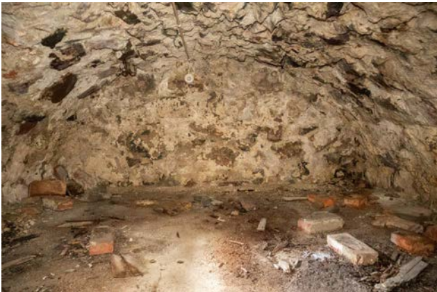
Källaren har ett valv av natursten med järnkrokar i taket för upphängning av matvaror. (SLM D2025-0023)
