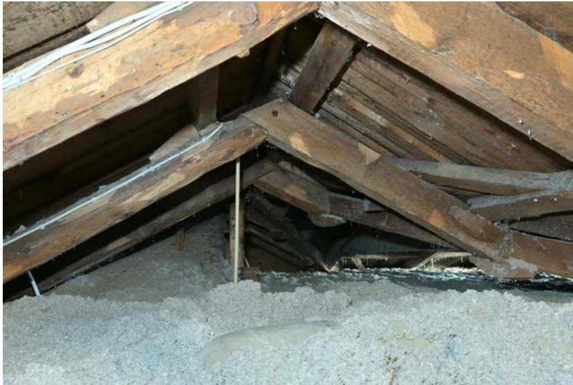
Vindsutrymmet är trångt och fyllt med lösullsisolering. (SLM D2025-0063)
