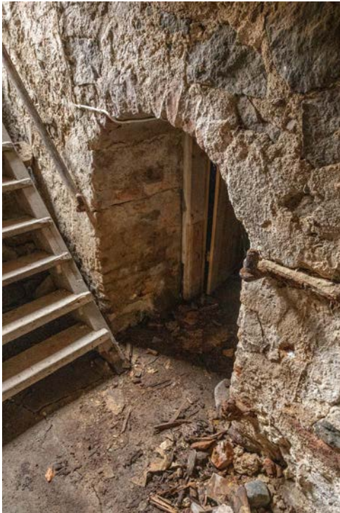
Ingången till källaren under sydvästra längan. (SLM D2025-0021)
