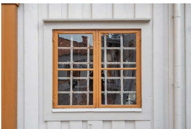
Ett av stallflygelns bevarade fönster med typiska 1700-talsbeslag. Alla rutor är handblåsta glas med mycket ojämnheter. Notera det troligen under 1800-talet utbytta hörnjärnet på högerbågens nedre vänstra hörn. (SLM D2025-0026)
