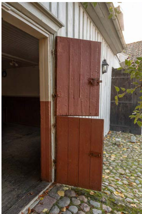
Stallportarnas dörrblad är delade vilket är typiskt för dörrar till stallbyggnader. (SLM D2025-0027)
