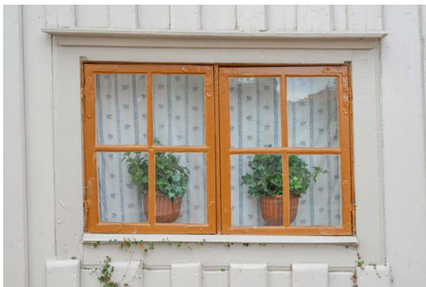
Ett bevarat äldre fönster på bostadsflygeln med typiska 1700-tals- beslag. (SLM D2025-0013)
