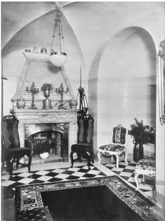
Nedre trapphall fotograferad någon gång då Kullbergska huset ännu var bostad. Notera nischen i väggen till höger i bild, denna sattes igen i samband med att en panna installerades i källaren 1962. Lägg också märke till väggarnas målade ränder. Detta är sannolikt samma marmorering i olika kulörer som ännu finns kvar i entréerna. Katrineholms kommunarkiv.
