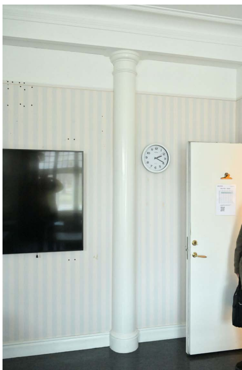
En av de bärande pelarna som idag syns i det sydöstra hörnrummet på bottenvåningen. Den avdelande väggen tillkom 1990. (SLM D2025-0354)
