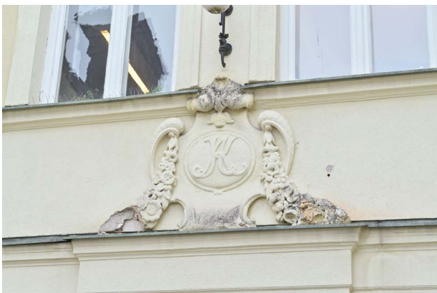
Över terrassens glasparti finns ett utsmyckande ornament med August Kullbergs initialer. En bit av festongen har lossnat. (SLM D2025-0366)
