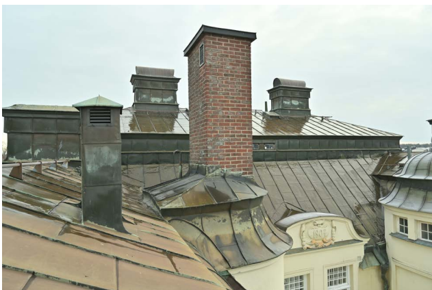
Utsikt över taket på huvudbyggnaden sett från en taklucka i den norra flygelarmens södra takfall. Den murade skorstenens rökkanal drogs genom det norra flygelarmens halvcirkelformade schakt från värmepannan källaren. (SLM D2025-0364)
