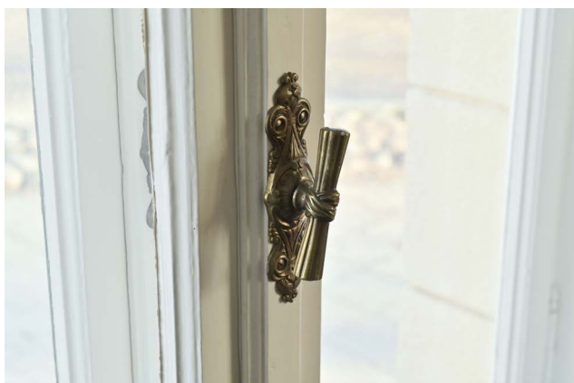
Samtliga fönster i huset har spanjletter med fönstervred i form av en kärve. Vreden finns på ytterbågar såväl som på innerbågar. (SLM D2025-0371)
