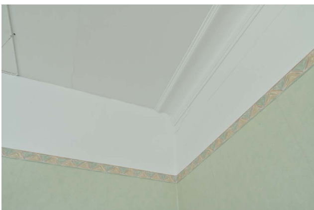
Taklister har skurits av på flera ställen när planlösningen ändrats. De fortsätter i vissa fall bakom den nya mellanväggen. (SLM D2025-0356)
