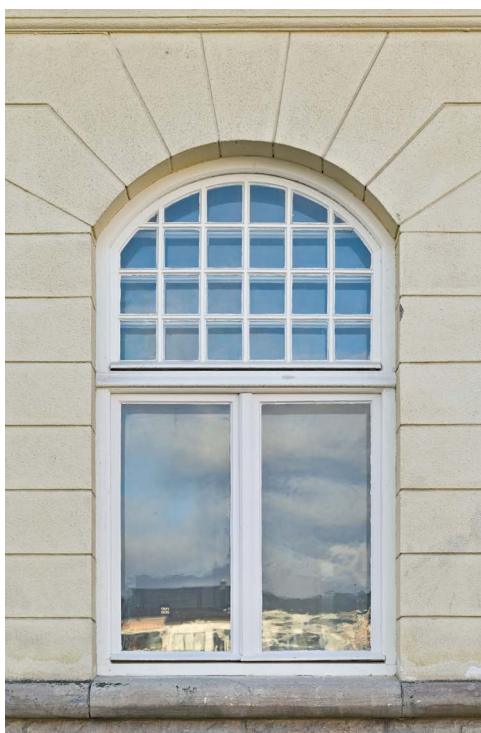
Ett av fönstren på norra flygelarmen med nuvarande vita kulör på bågar. (SLM D2025-0372)
