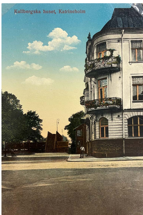
Äldre kolorerat vykort på Kullbergska huset där fönstren färglagts i en ockragul kulör. (SLM M025331)
