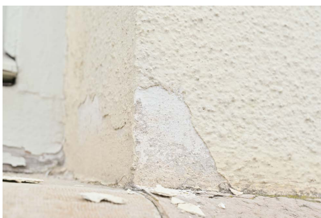
På ett parti närmare marken där nuvarande ytputs har fallit bort kunde den underliggande färgnyansen bestämmas. (SLM D2025-0369)
