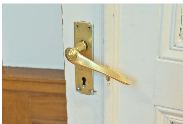
Bevarat dörrtrycke i mässing sannolikt från byggnadstiden. Notera nyckelplåtens form. (SLM D2025-0375)
