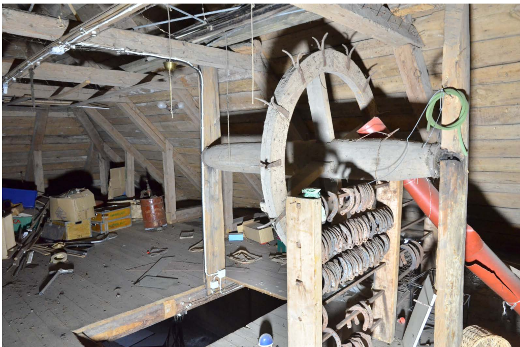
Bild 14. Våning 2 sedd mot norr. Till höger axeln med hjul, avsedd att användas för transport av spannmålsäckar. (SLM D2024-214)
