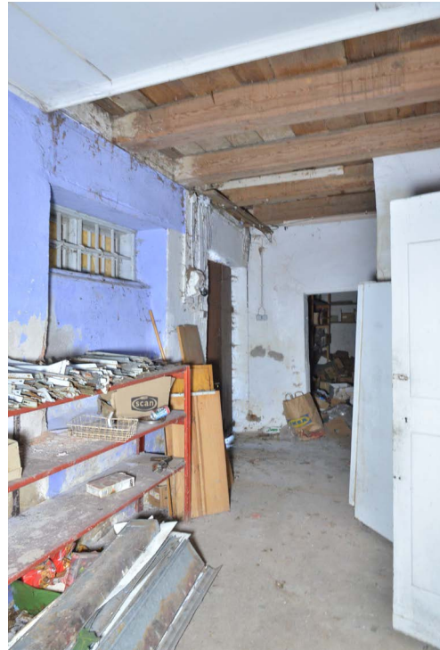
Bild 13. Del av bottenvåningens nordvästra rum sett mot ingången. Väggen är målad med ljus blå limfärg. (SLM D2024-213)
