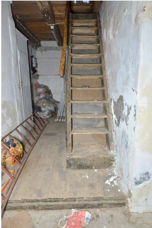
Bild 12. Bottenvåningen, innanför ytterdörren, sett mot söder. En rak och smal trätrappa leder upp till våning 1. (SLM D2024-212)
