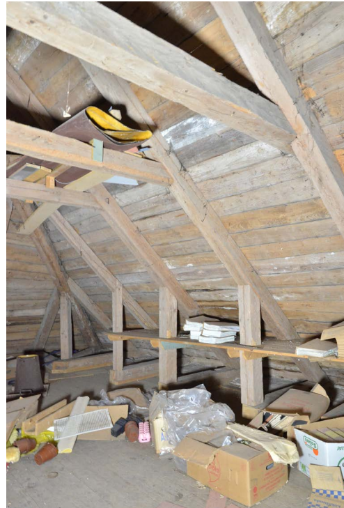
Bild 24. Takstolsverket ser generellt ut att vara i gott skick. (SLM D2024-224)
