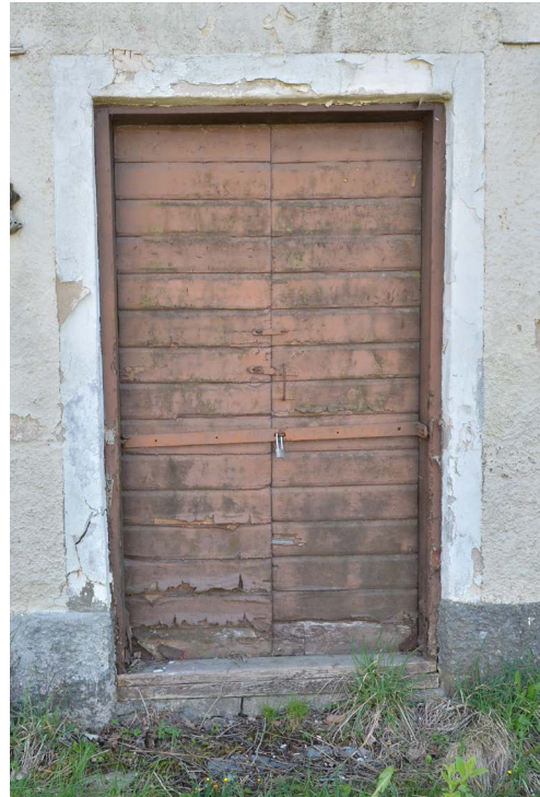
Bild 16. Magasinets ytterdörr. Målarfärgen flagar. (SLM D2024-216)
