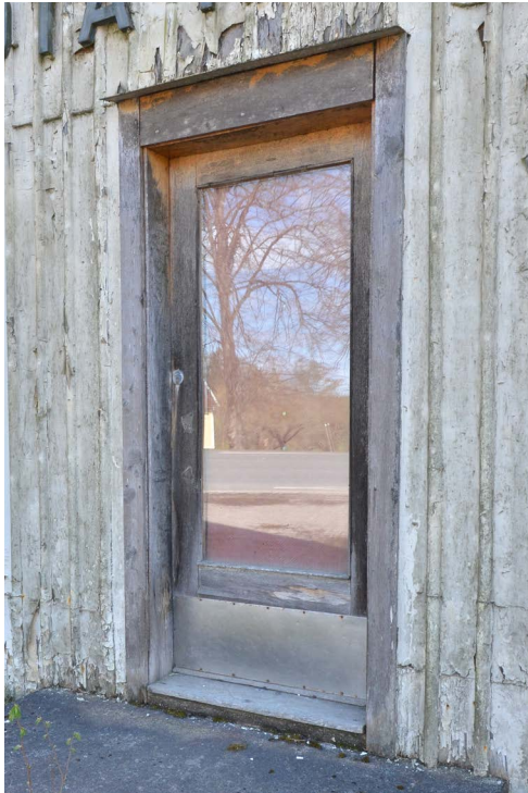
Bild 30. Ytterdörren mot norr. (SLM D2024-230)
