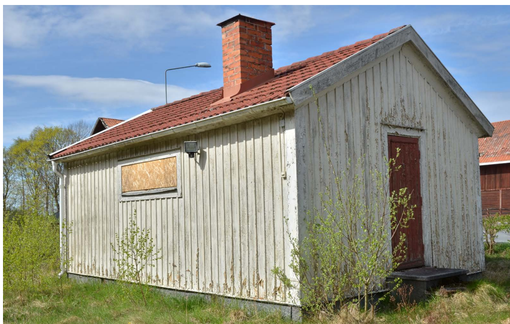
Bild 35. Sommarcafeet sett från sydväst i maj 2024. (SLM D2024-235)
