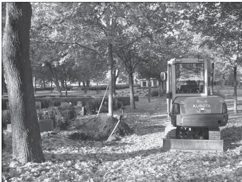
Figur 3. Översiktsbild mot väster. Strax till vänster om grävmaskinen syns schakt 1. Foto: Lars Norberg, Sörmlands museum, 2004.
