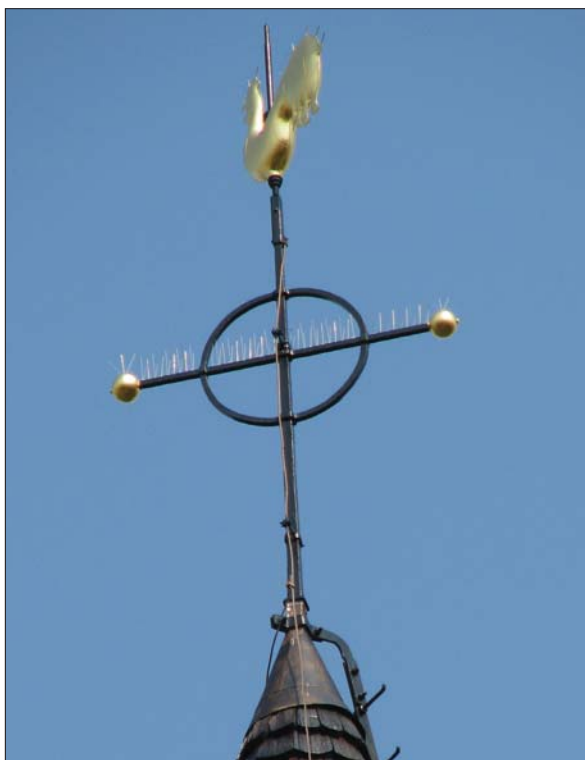
31 Tornspirans utseende efter renoveringen. Även järnstången försågs med fågelskydd. Fotografi Emelie Mattsson (SLM D2015-1101).
