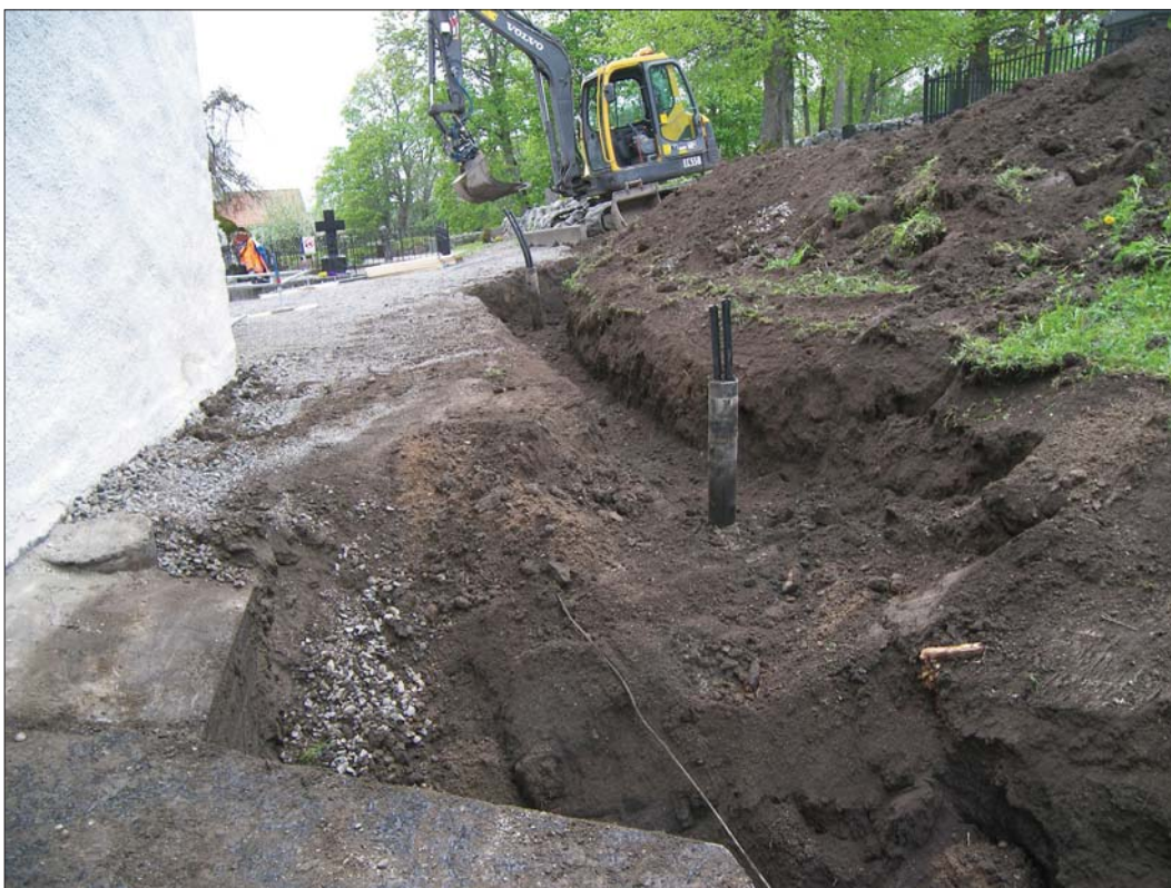
8 Schaktet som togs upp norr om kyrkan. Till vänster i bild syns den gjutna kulverten (SLM D2015-1079).
