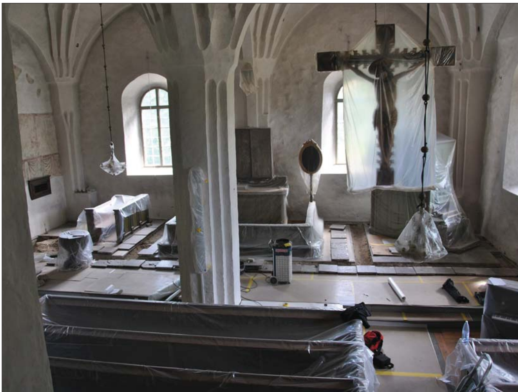
7 En del av korgolvets kalkstensplattor demonterades för att kunna förlägga installationerna under golvet (SLM D2015-1078).
