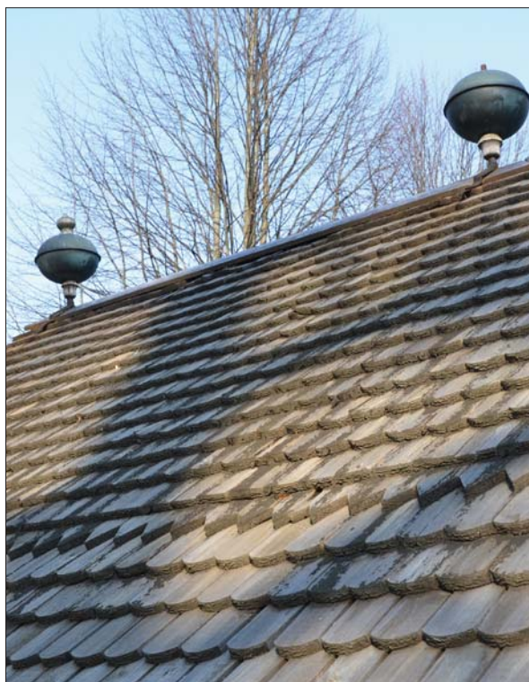
22 Detalj av gravkapellet's dekorationer. Trädetaljerna över och under kloten byttes ut mot nya (SLM D2015-1092).
