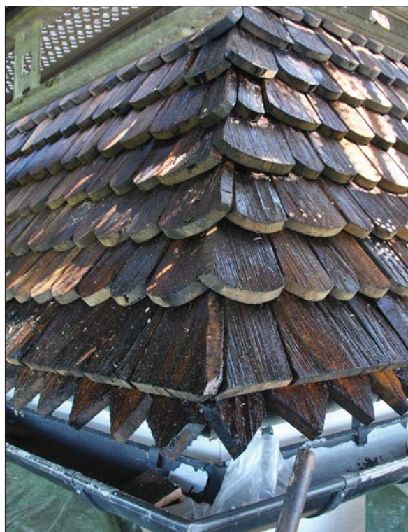
20 ...dock med "bättre" anpassning i hörnen så att spånen inte behövdes kapas i för små delar (SLM D2015-1090).
