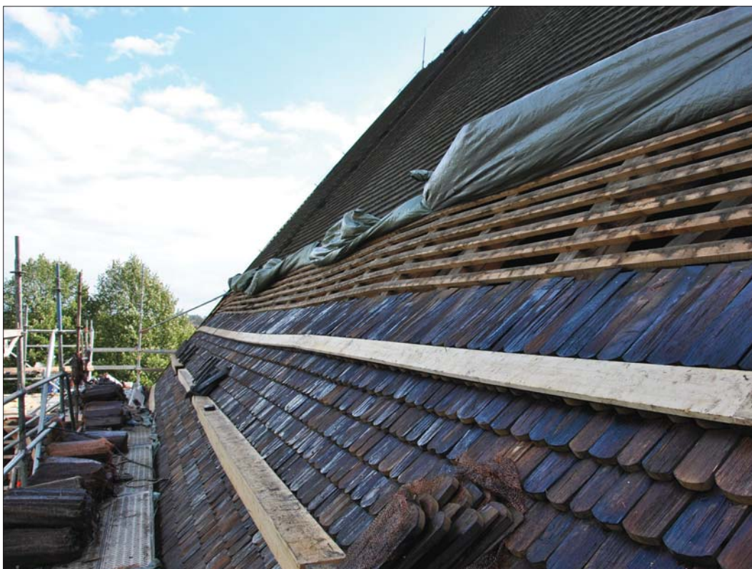
17 Takarbeten pågår med långhusets norra takfall (SLM D2015-1087).
