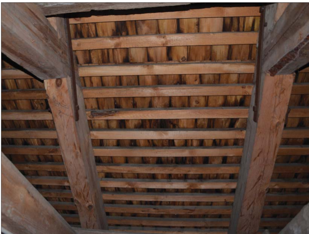
16 Takspånen över långhuset ligger på öppen läkt. Fotografi före omläggningen 2014 (SLM D2015-1086).
