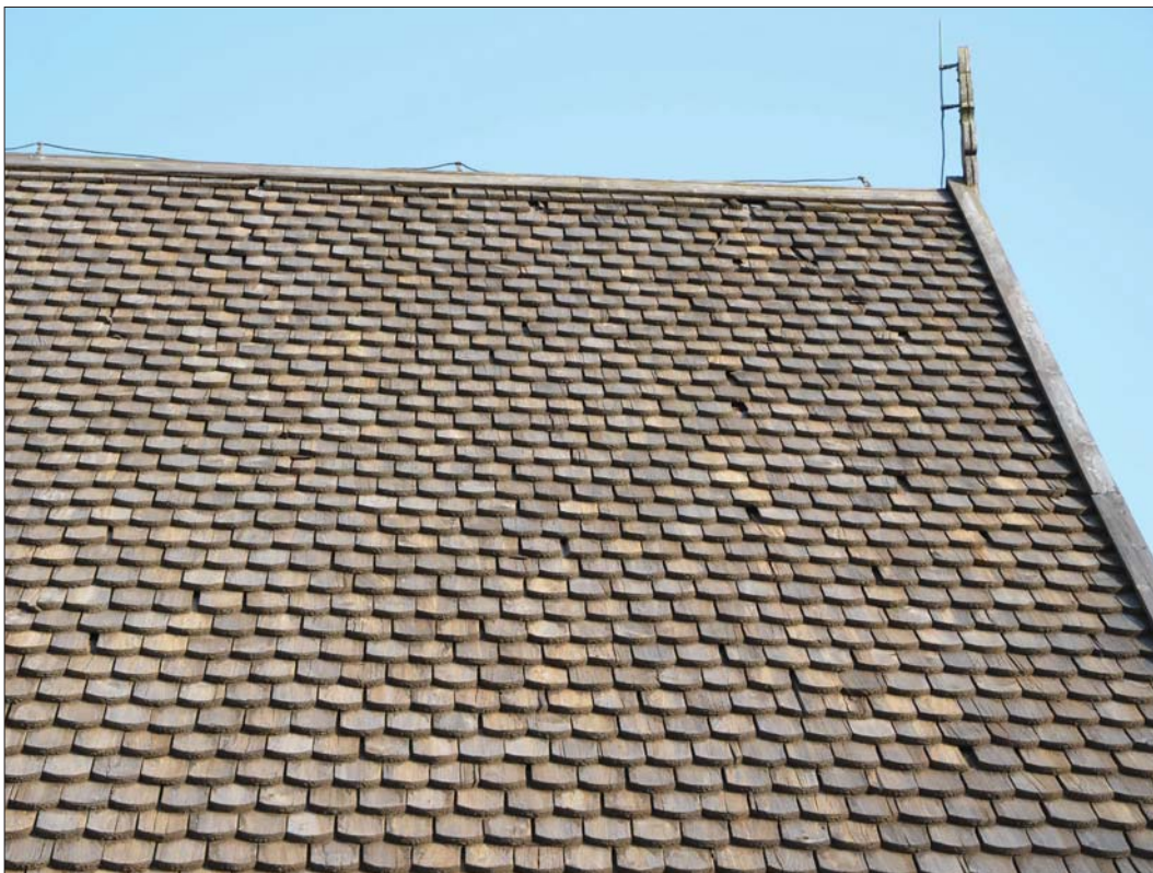
15 Del av södra takfallet före omläggningen. I nock ligger brädor (SLM D2015-1085).
