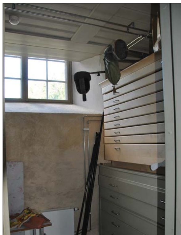
14 Utrymmet under läktaren som används för textilförvaringen. De nya rören förlades vid vägg och vid tak (SLM D2015-1084).
