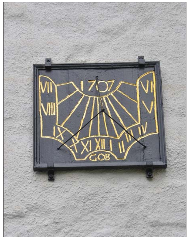
27 Soluret efter utförda arbeten (SLM D2015-1097).
