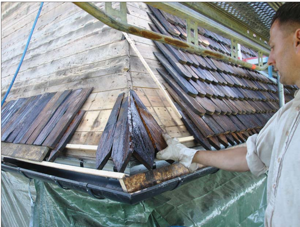
18 Spånläggning av tornet utfördes av hantverkare Kai Richter och Michaela Floree (SLM D2015-1088).
