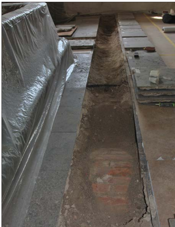
33 Mitt framför altarringen syntes hjässan på ett tegelvalv, sannolikt en gravkammare (SLM D2015-1103).
