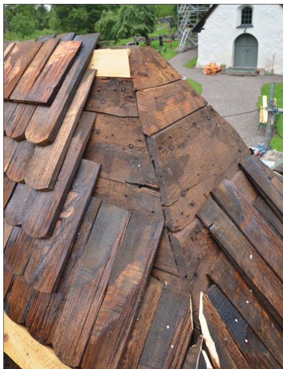
23 Arbeten med södra stigporten (SLM D2015-1093).
