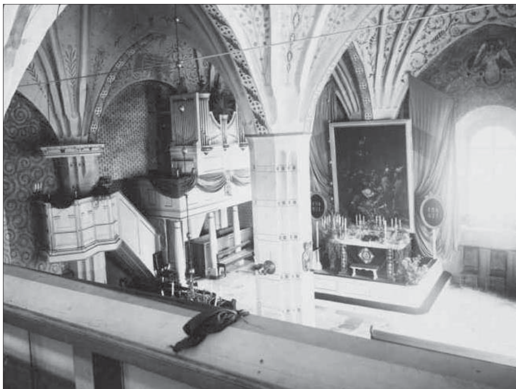
6 Koret före renoveringen 1918 med sekelskiftets målningar i medeltida stil. Notera orgelläktaren vid korets norra vägg. Okänd fotograf. Fotografi inlånat av RAÄ, Kulturmiljöbild.
