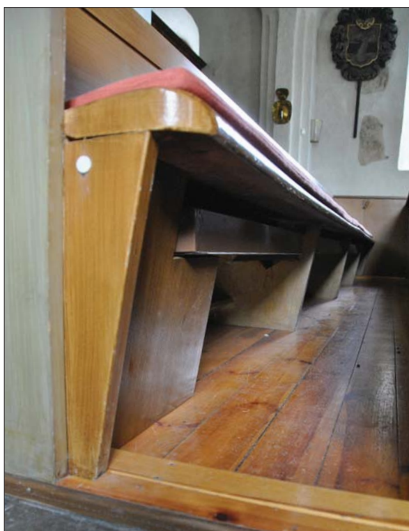
13 De nya bänkkonvektorer målades in i brun kulör (Slm D2015-1083).
