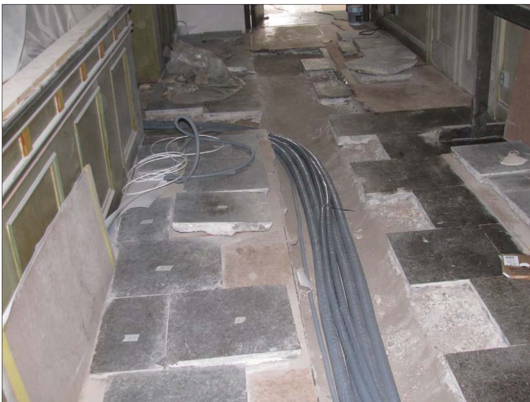
12 Rördragningarna som gjordes under orgelläktaren. Vy från långhusets västra del sett mot vapenhuset i söder (SLM D2015-1082).
