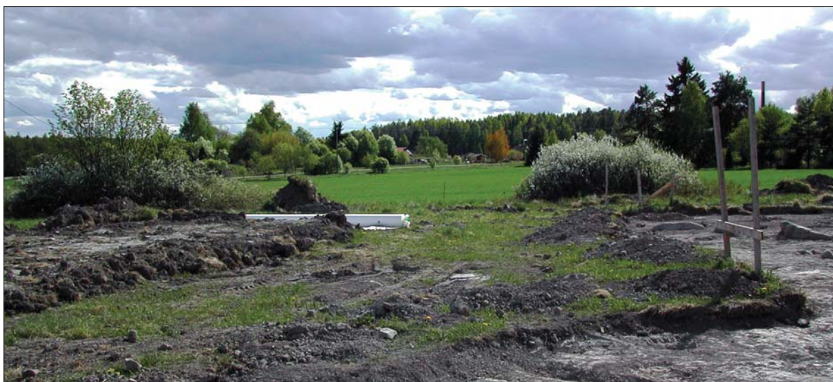
Figur 17. De sydöstra delarna av Yta 2 mot söder. Området strax utanför schaktet täcktes med geotextil inför byggnation och en planerad utfyllnad av området. Foto: Lars Norberg 2004, Sörmlands museum.
