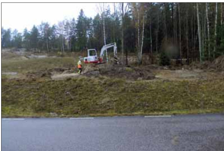
Figur 2. Schaktning inom den södra delen av undersökningsområdet. Närmast i bild syns berghällan med Helgona 322. Bilden är tagen från östsydöst. Foto: Ingeborg Svensson 2013, Sörmlands museum.
