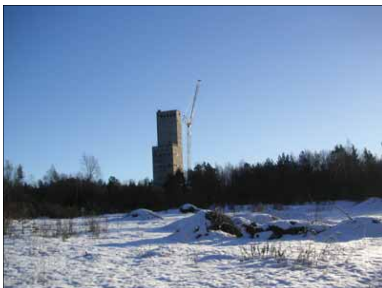
Figur 3. Laven började rivas i januari år 2010. Foto: Sören Filipsson 2010, Sköldinge skola.
