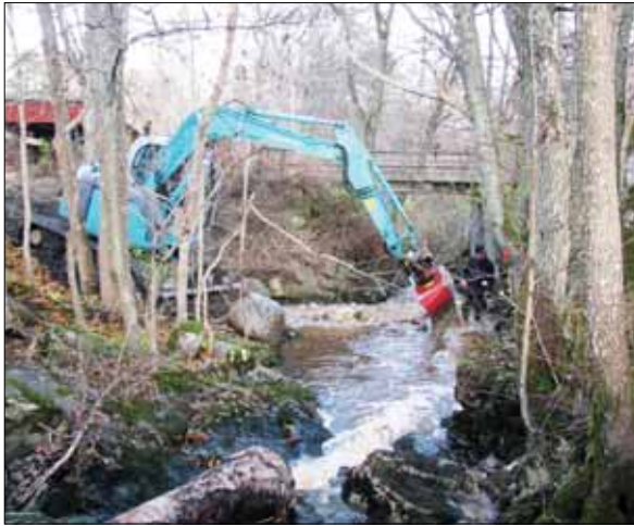
Figur 14. Trösklarna byggdes upp av tillfört stenmaterial i form av rundade stenar, grus och större stenblock. Bilden är tagen från sydväst. Foto: Ingeborg Svensson 2012, Sörmlands museum.
