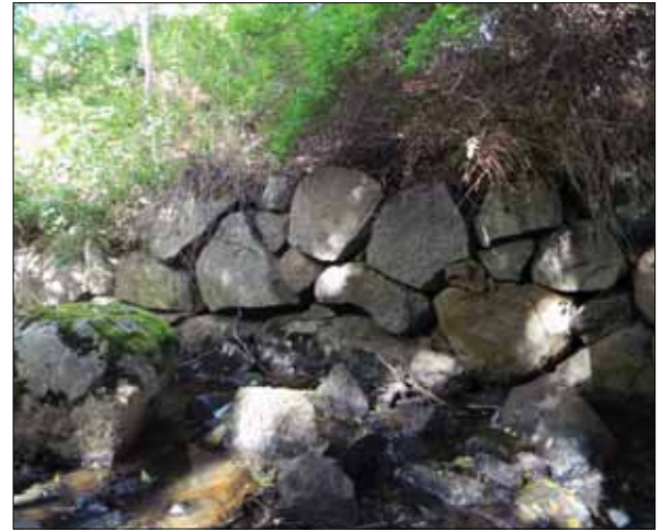
Figur 15. Längs med den nordvästra sidan av bäcken sträcker sig en kallmurad stenskoning. Stenpartiet fortsätter nordöst om bron. Bilden är tagen från sydöst. Foto: Ingeborg Svensson 2012, Sörmlands museum.
