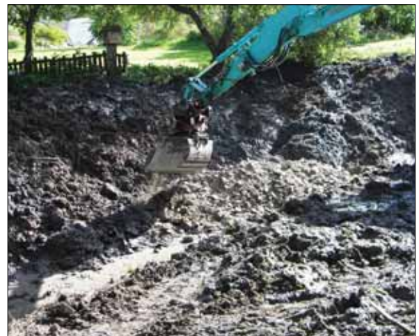
Figur 31. Ytterkurvan byggdes upp och fylldes ut med jordmassor för att sedan täckas med stenkross och större rundade stenar. Bilden är tagen från västnordväst Foto: Ingeborg Svensson 2012, Sörmlands museum.
