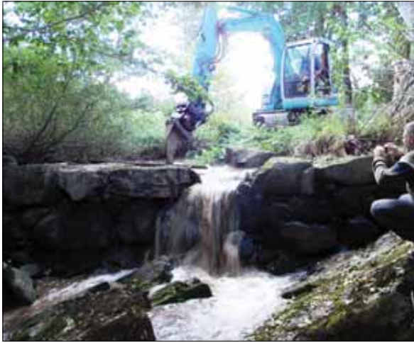
Figur 21. Stenblocken i dammvallen plockades till en början bort ett i taget. Bilden är tagen från nordöst och vid lågvatten. Foto: Ingeborg Svensson 2012, Sörmlands museum.
