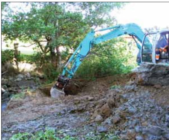
Figur 30. Alen som syns på bilden togs bort och innerkurvan grävdes ur. Massorna användes sedan för att bygga upp ytterkurvan. Bilden är tagen från västnordväst Foto: Ingeborg Svensson 2012, Sörmlands museum.
