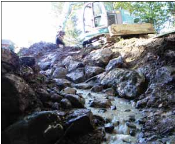
Figur 23. De borttagna stenblocken användes sedan som stensko- ning strax uppströms den rivna dammvallen. Bilden är tagen från nordöst och vid lågvatten. Foto: Ingeborg Svensson 2012, Sörmlands museum.
