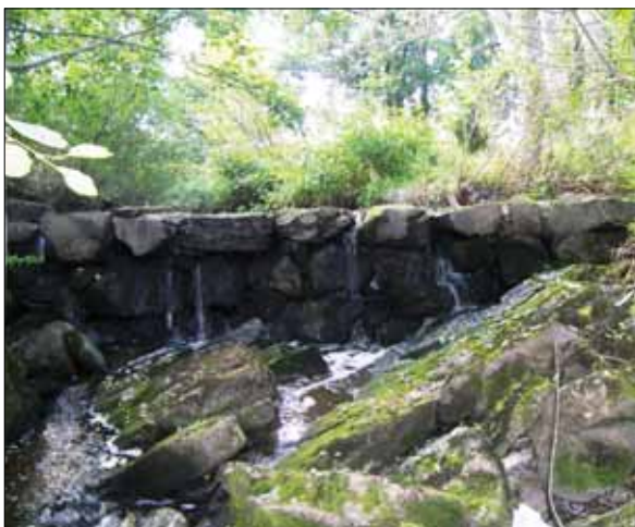
Figur 25. Objekt 3 innan åtgärden har genomförts. Bilden är tagen från nordöst och vid lågvatten. Foto: Ingeborg Svensson 2012, Sörmlands museum.
