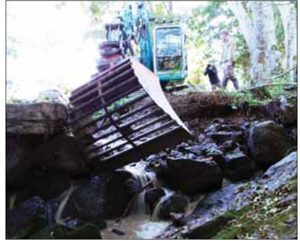
Figur 22. Mittpartiet av dammvallen revs medan murarna på båda sidor om bäcken sparades. Bilden är tagen från nordöst och vid lågvatten. Foto: Ingeborg Svensson 2012, Sörmlands museum.
