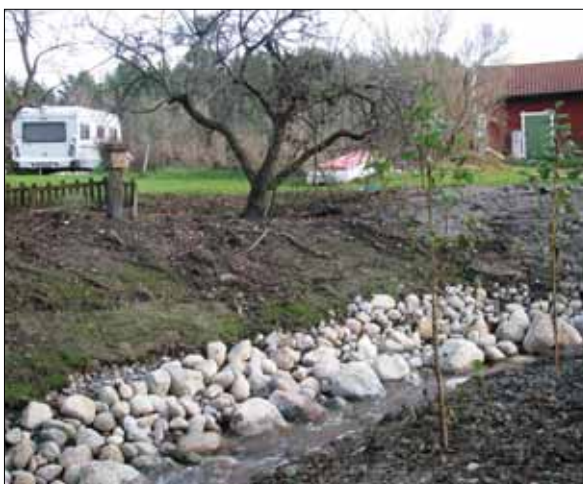
Figur 32. Ytterkurvan inom objekt 4 efter att åtgärden genomförts och gräset har börjat komma upp. Bilden är tagen från västnordväst Foto: Ingeborg Svensson 2012, Sörmlands museum.
