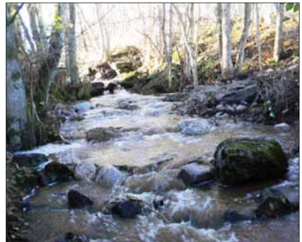
Figur 17. Objekt 2 efter att åtgärden genomförts. I bakgrunden skymtar dammvallen, objekt 3. Bilden är tagen från nordöst och vid högvatten. Foto: Ingeborg Svensson 2012, Sörmlands museum.
