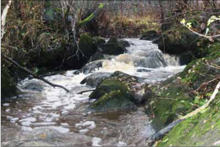
Figur 35. Vid det mindre vattenfallet sträcker sig en sedan tidigare raserad dammvall, Tunaberg 643, över bäcken. Stenblocken fick ligga kvar och istället reglerades vattennivån genom att stenmaterial lades inom vattenytan närmast i bild. Bilden är tagen från nordöst och vid högvatten. Foto: Ingeborg Svensson 2012, Sörmlands museum.
