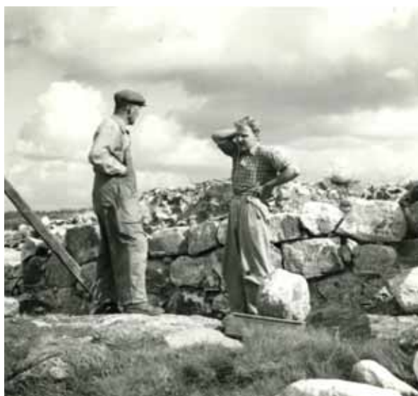
Figur 6. Restaurationsarbete och rekonstruktion av kastalens murverk. Personerna på bilden är okända. Foto: C-G Blomberg, år 1953. SMA, neg nr A12-174.
