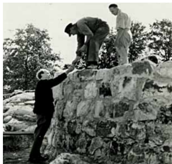
Figur 9. Ivar Schnell (t v.) inspekterar restaureringsarbetets fortskridande. Murverkets tre övre skift ger intryck av att vara rekonstruerade. Foto: C-G Blomberg år 1953. SMA, neg nr A12-177.
