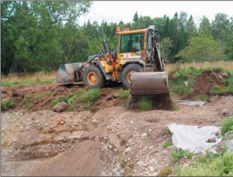
Figur 7. Efter att undersökningen av det öppna schaktet avslutats återställdes platsen genom att schaktet fylldes igen med maskin. Massor som grävts upp i samband med den tidigare obehövade schaktningen och lagts på schaktets västra och norra kanter lades nu tillbaks på den skadade ytan. Före igenfyllning lades fiberduk över de ytor där bevarade kulturlager sparats. Detta för att tydligt markera gränsen mellan bortgrävda och bevarade lager. Foto: Björn Pettersson 2005, Sörmlands museum.
