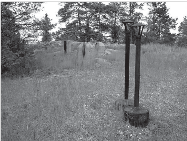
Figur 9. Betongfundament och skorstensrör på taket av bunkern. Bilden är tagen från söder. Foto: Patrik Gustafsson 2004, Sörmlands museum.
