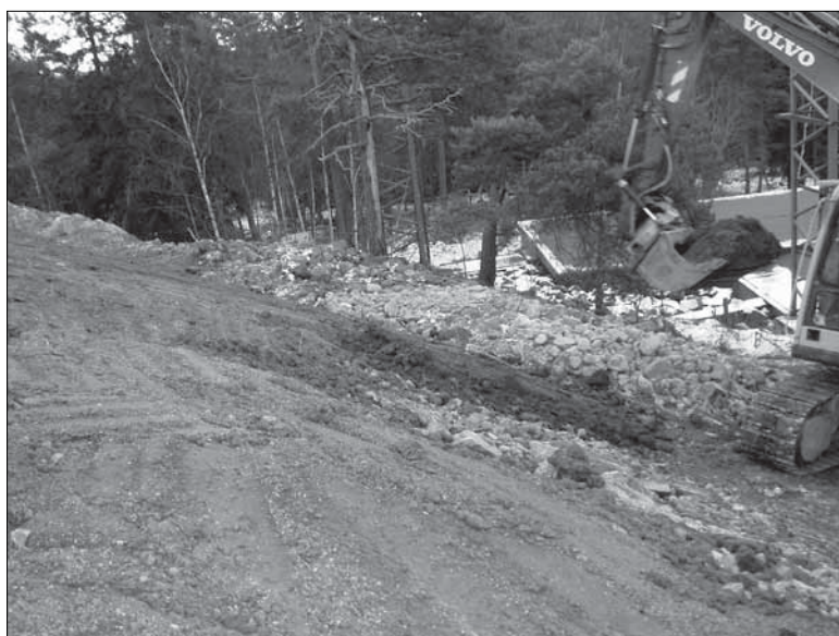
Figur 13. Återskapande av ny markyta inom de område där den tidigare bunkern var belägen. Till vänster om grävmaskinen syns dels den framrensade ursprungliga fornborgsvallen, dels en del av den återskapade fornborgsvallen. Bilden är tagen från nordväst. Foto: Ingeborg Svensson 2005, Sörmlands museum.
