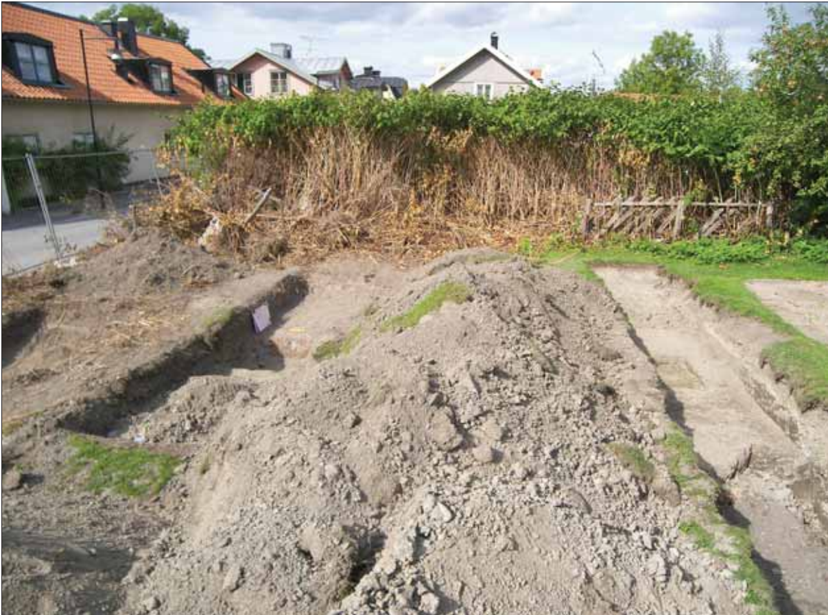
Figur 7. Översiktbild från söder av den undersökta ytan Marknaden 6 i Trosa, med de öppna långsträckta sökschakten och de undersökta rutorna. Foto: Björn Pettersson 2013, Sörmlands museum.
