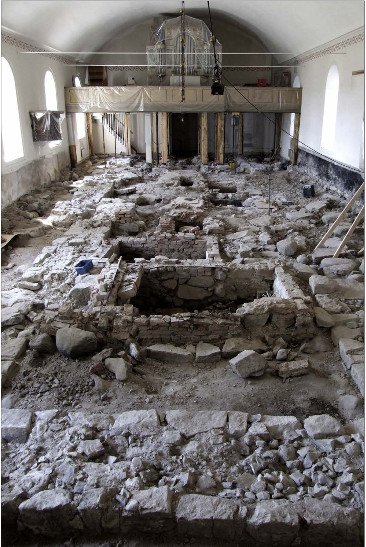
Figur 26. Översikt mot väster över frilagda murverk, Etapp 2. Foto: Dag Forssblad år 2009, Sörmlands museum (Slm D09-549).
