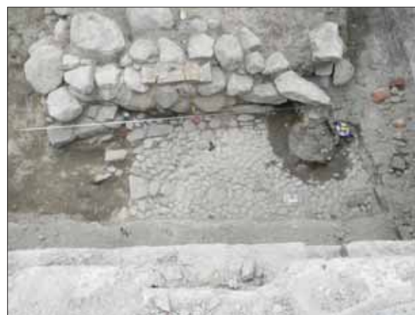
Figur 8. Stengolv i källaren med avloppstunnan till höger i bild. Centralt syns också stengrunden som den här borttagna tegelväggen vilade på. Foto: Peter Berg år 2011, Sörmlands museum.
