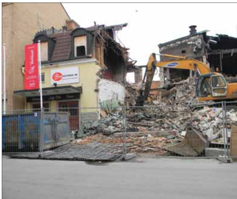
Figur 2. Gamla världshuset under rivning. Bilden är tagen mot sydsydväst. Foto: Patrik Gustafsson år 2011, Sörmlands museum.
