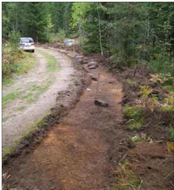
Figur 6. Schakt 3. Bilden är tagen från söder. Foto: Ingeborg Svensson 2011. Sörmlands museum.
