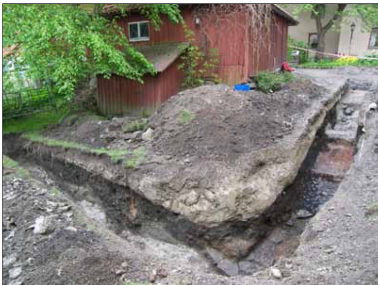
Figur 3. Det öppna förundersökningschaktet sett från nordväst. I den högra delen syns den frilagda stenläggningen (A1), det överlagrande brandlagret samt den sterila markytans branta stigning mot söder. I bakgrunden, den lilla boden uppförd på en valvslagen källare. Foto: Björn Pettersson 2009, Sörmlands museum.
