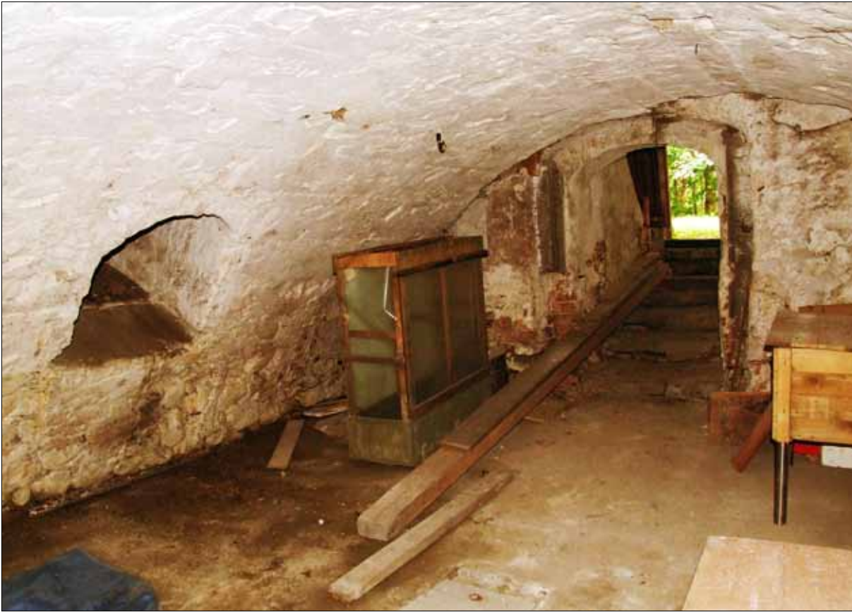
Figur 7. Den valvslagna källaren med fönsterglugg mot väster och dörröppning mot norr, åsidan. Lägg märke till de längsgående avtrycken från formbrädorna. Källarummets innermått var 5,1 x 5,3 meter. Foto: Björn Pettersson 2009, Sörmlands museum.
