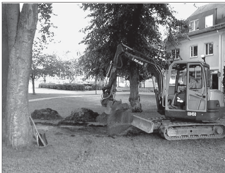
Figur 4. Grävning av sökschakt S2 i parken strax söder om Rådstugan i Trosa. Förundersökningens Etapp 1. Foto: Björn Pettersson 2001, Sörmlands museum.
