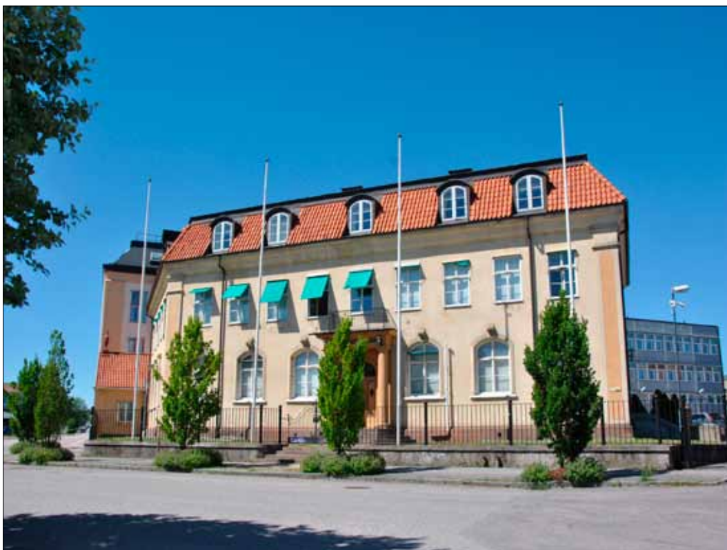
6. Byggnad 1, fasad mot söder 2015. (SLM 2015-977)
