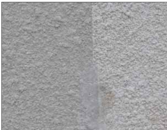
15. Detalj av fasaden på byggnad 3B. Fasaden har ädelputs med glimmer i. (SLM 2015-986)
