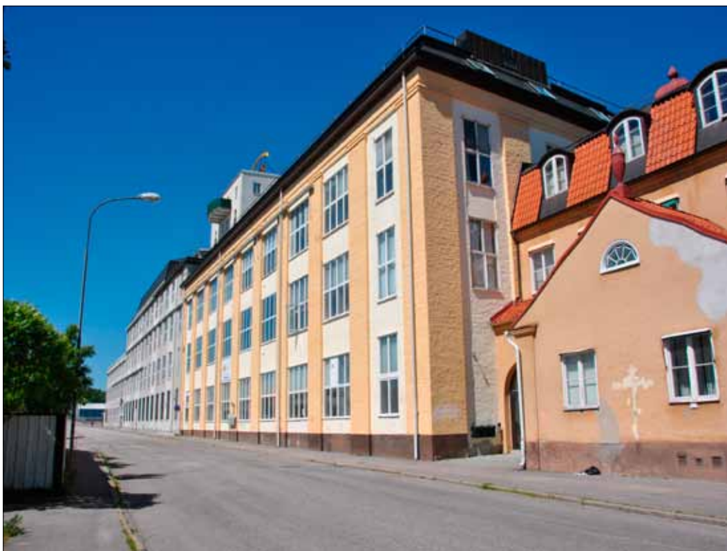
3. Sunlights långsträckt byggnadsvolymen sedd från Industrigatan. Längst till vänster i bild fabriksbyggnad 3C, därefter 3B och närmast 3A och Kontorshuset 1. Här tillverkades två produkter under åren 1925- 1992. (SLM 2015-974)
