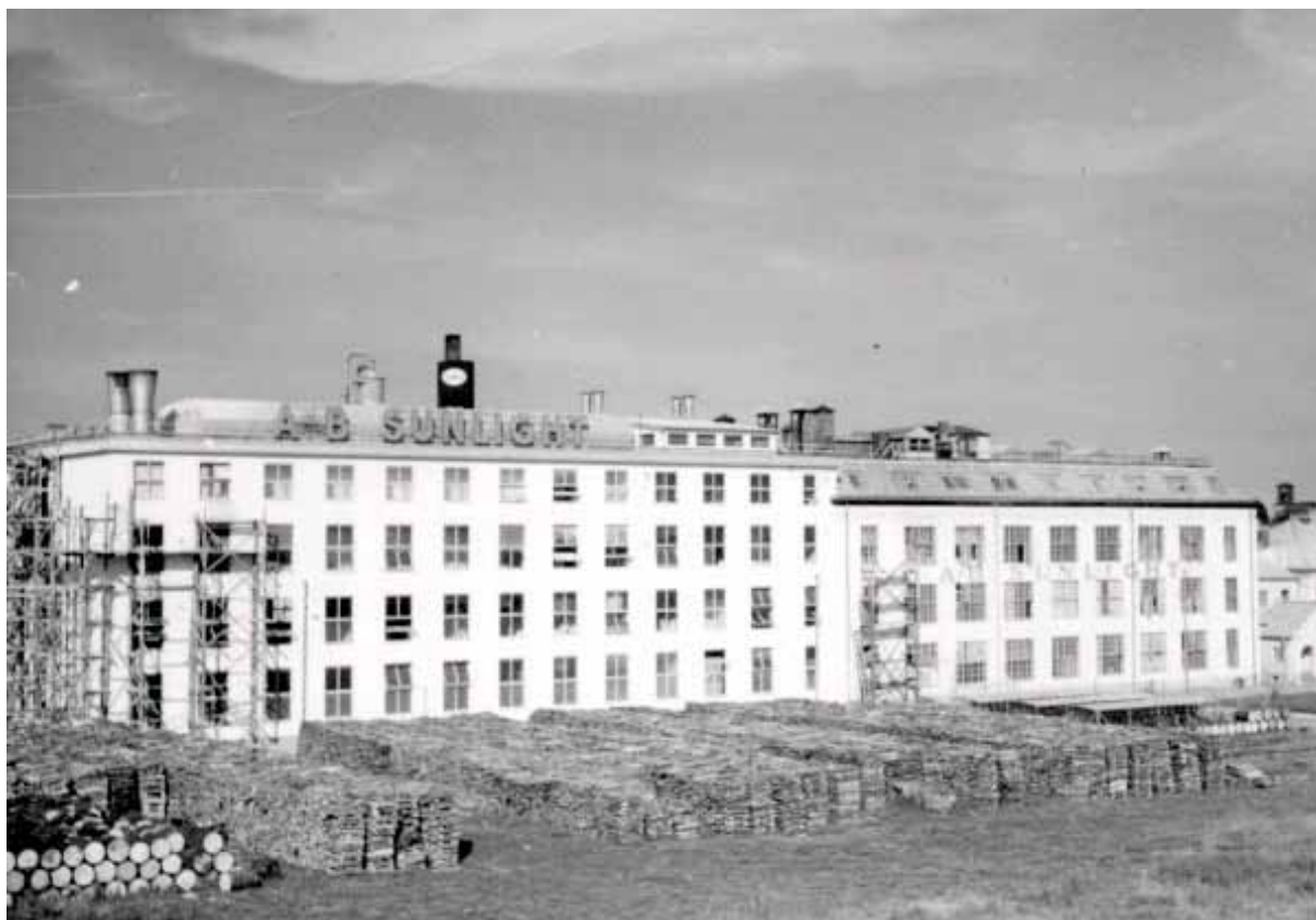
22. Äldre fotografi av Sunlight, någon gång på 1950-talet, hus 3B och 3A. Fotografiet är troligen tagit vid uppbyggnaden av 3C. Sörmlands museums bildarkiv SLM A30-230.
