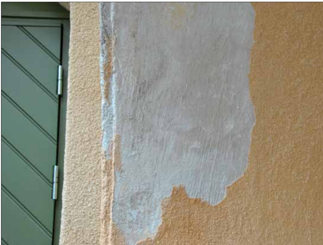
7. Detalj av portiken på hus 1, där tidigare släta och ljusare putslager är synliga. (SLM 2015-978)
