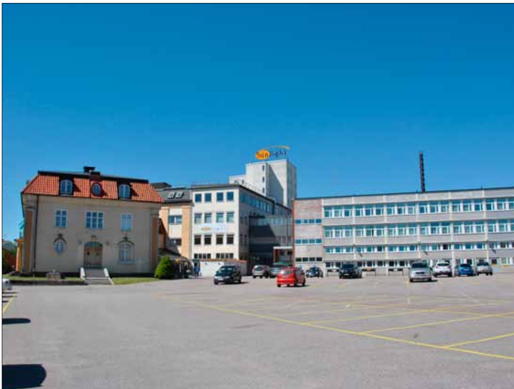
4. Byggnadskomplexet sett från Nytorget. Till höger i bild byggnadskropp 4. (SLM 2015-975)
