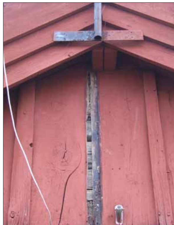
7 Locklisten på södra gaveln lyftes bort för att se om det under panelen möjligen fanns någon ingång/lucka till vind (Slm D12-0489).
