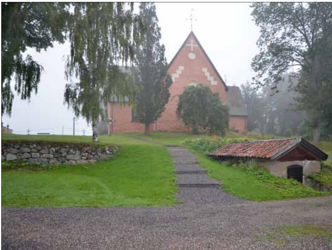
7 Den nya trappan och grusgången efter avslutade arbeten (Slm D11-263).
