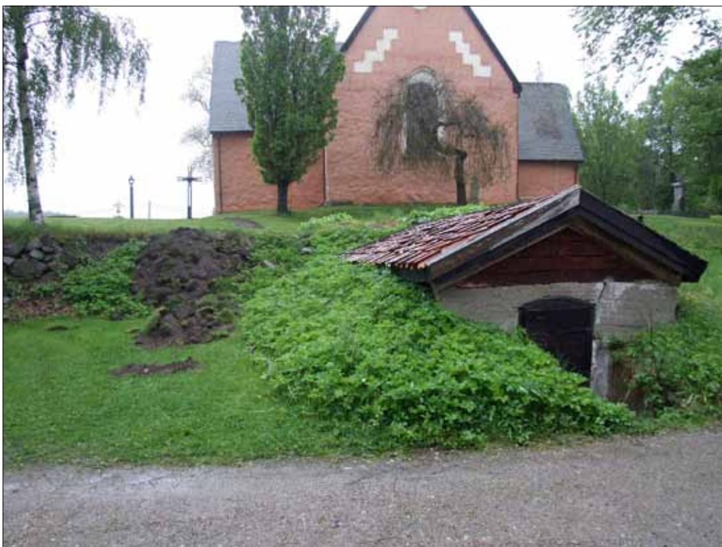
5 Aktuellt parti av kyrkogårdsmuren före anläggandet av den nya trappan (Slm D11-261).
