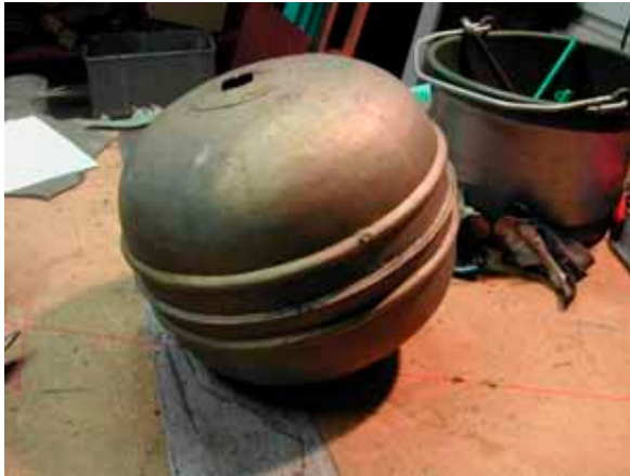
Klotet under tuppen från 1947 är av tunnare gods, ca 0,7 mm. Diameter 0,35 m. Innerhöjd 0,32. Det har liknande utformning som klotet under gravkorets kors.
