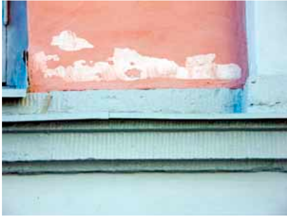
På den östra sidan av Ångakoret har det nya färgskiktet med kalklimfärg från 2005 börjat flaga i januari 2006.
