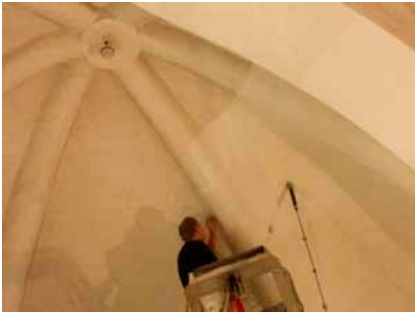
Murare Benny Karlsson arbetar från skylift i koret med putsrengöring. Stor skillnad syns mellan rent och smutsigt fält.
