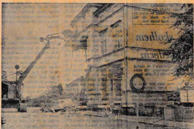
Den glupska grävmaskinen tar för sig av Rodénska huset vid Ankargatan.
