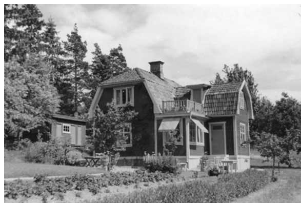
Mangårdsbyggnaden till Stora Danvik i mitten av 1900-talet. SLM M022385
