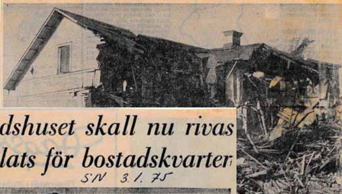
är trevningbyggnaden jämnad
