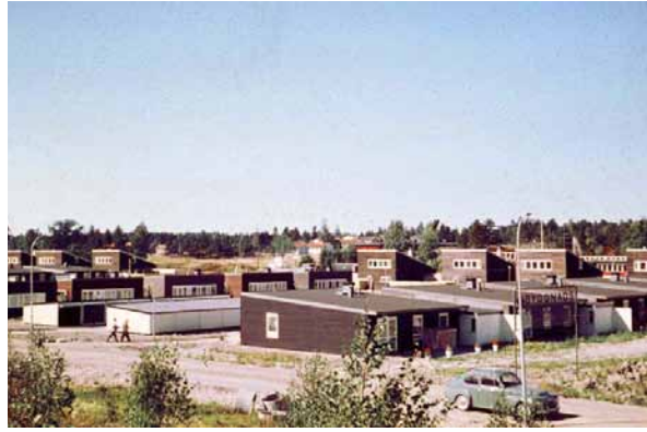
Kedjehusen vid Vallsundsvägen då de var nyuppförda i mitten av 1960-talet. Bilden tillhör Oxelösundsarkivet, Bild ID 010425
