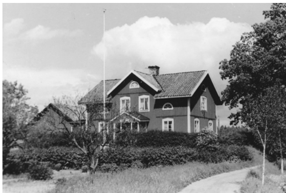
Gamla mangårdsbyggnaden till Sundsörs gård. SLM R338-94-4
